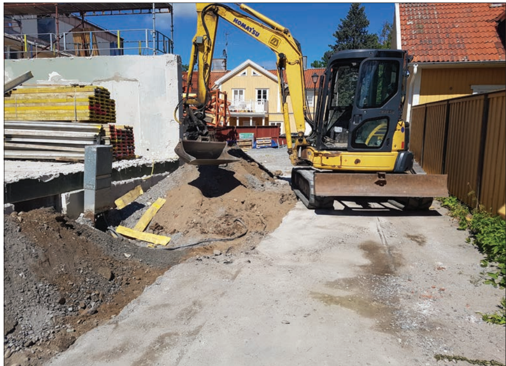
Figur 5. Norra delen av schakt 1 vid framgrävning av kablar. Foto från söder av Oskar Spjuth.
