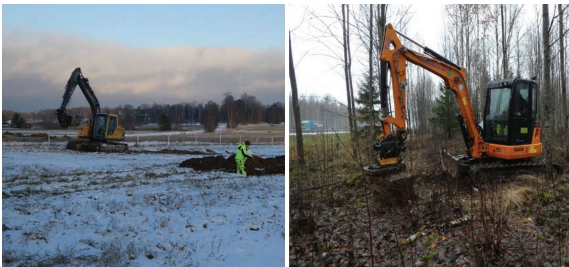
Figur 5. En större grävmaskin användes på de öppna ytorna men där det var tätare skog fick vi byta till en mindre. Strax norr om Södra Palmbobult till vänster och intill motorvägen E20 till höger. Foto Jenny Holm.
