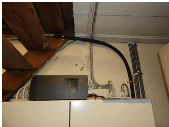
Figur 7. Eldragningar nytt styrsåp – flertalet sedan tidigare befintliga.
