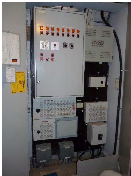
Figur 4. Befintlig styrutrustning placerad i ett skåp på plan 2 i tornet, under trappan. Har demonterats.
