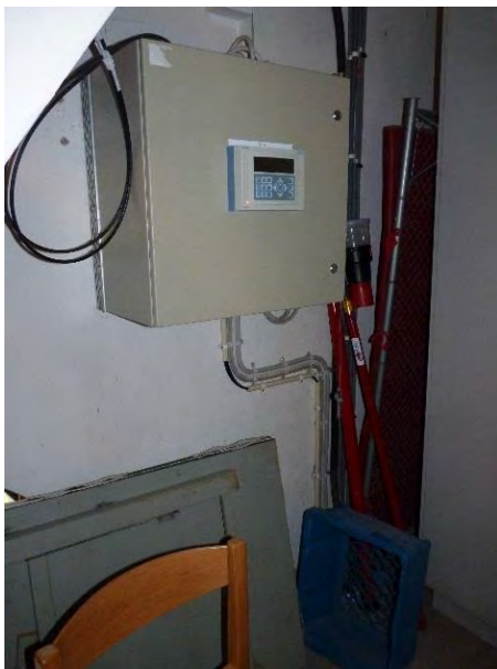
Figur 4. Befintlig styrutrustning placerad i ett skåp på plan 2 i tornet, under trappan. Har demonterats.
