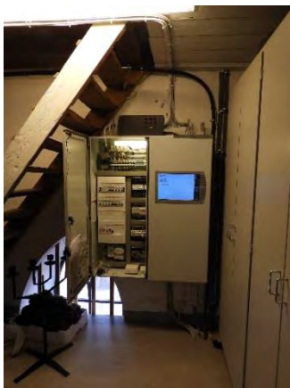
Figur 6. Nytt skåp för styrutrustning.
