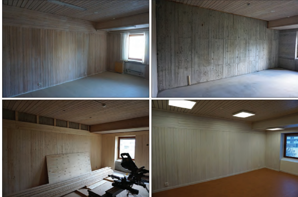
Figur 18 (övre, vänster). Vägg i rum 116 med befintlig panel innan åtgärd.
