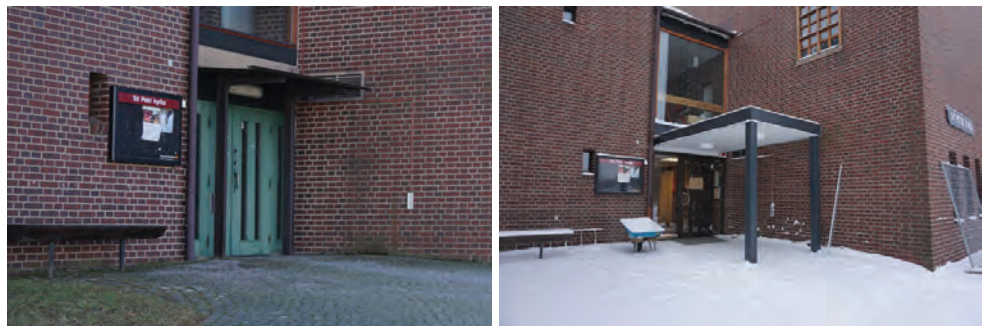
Figur 48. Den äldre entrén mot nordväst. Själva dörren tillkom 1986.
