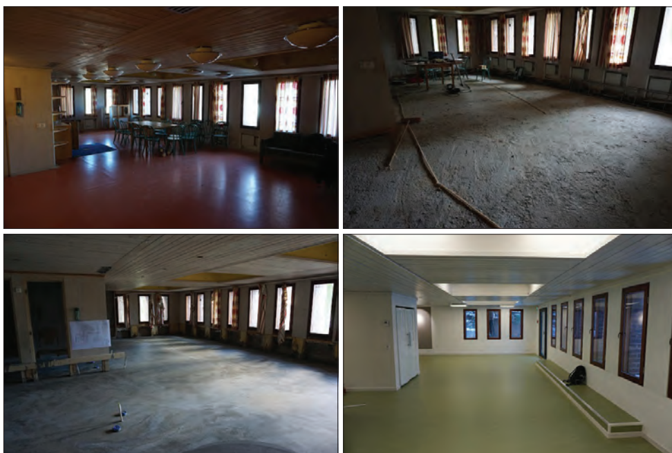
Figur 14 (övre, vänster). Matsalen innan åtgärd, mot norr.
