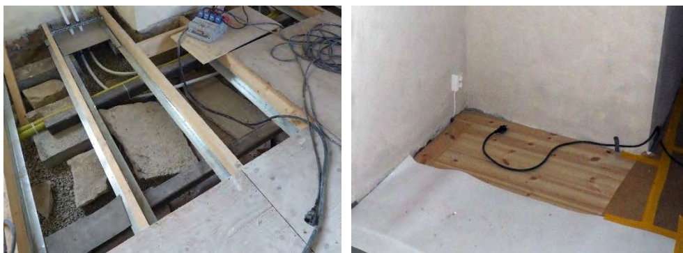
Figur 21. Järnbalkar har lagts över den sydvästra gravkryptan. Centralt i bild syns även den sten som återfanns inne i den äldre altarkonstruktionen.
