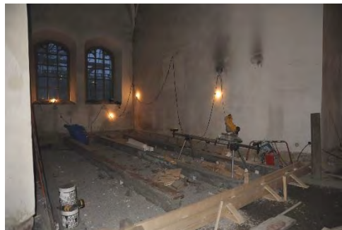
Figur 17. Förberedelse inför gjutning av bärlinor. Under golvet ligger ett lager med singel. Foto Svensk Klimatstyrning.
