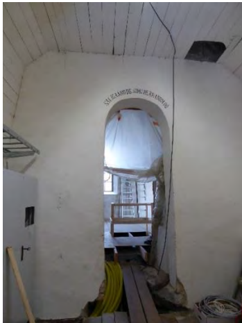
Figur 23. Södra vapenhuset sett mot norr.
