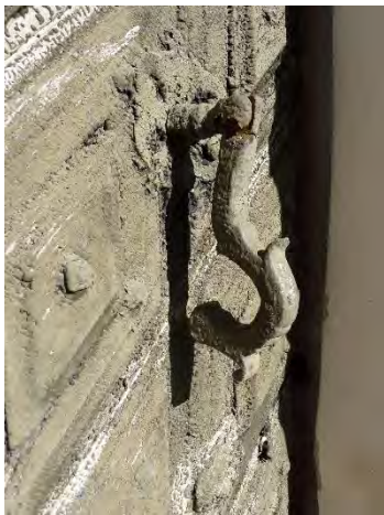
Figur 94. Dörrkläpp med tjocka färglager.
