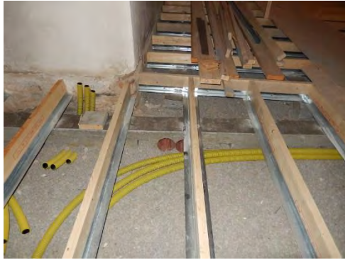
Figur 64. Nya eldragningar i kyrkorummet är dragna i slangar under golvet. Foto Svensk Klimatstyrning.
