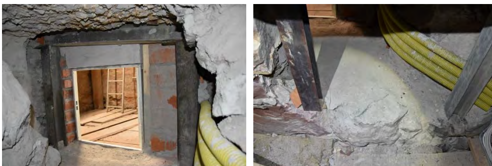
Figur 52. Färdig öppning sedd från långhusvinden. Foto Svenske Klimatstyrning.
