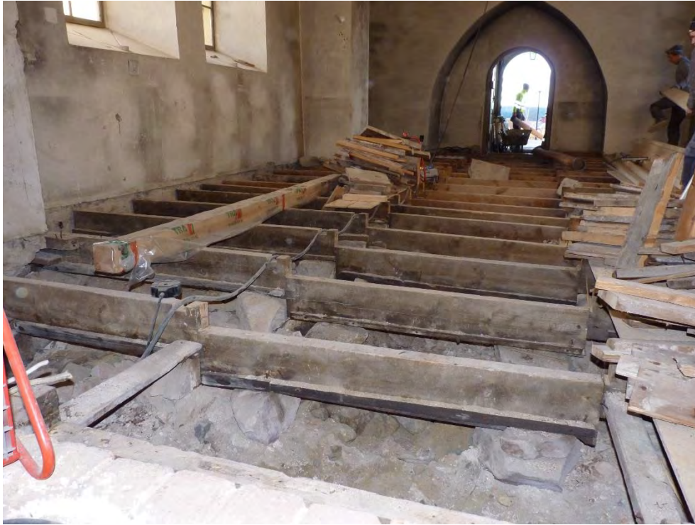
Figur 100. Äldre bjälklag sett från öster.
