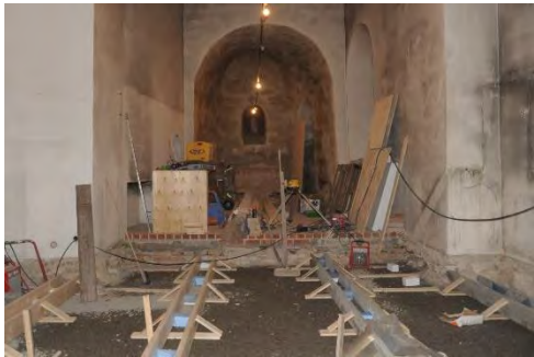
Figur 17. Förberedelse inför gjutning av bärlinor. Under golvet ligger ett lager med singel. Foto Svensk Klimatstyrning.
