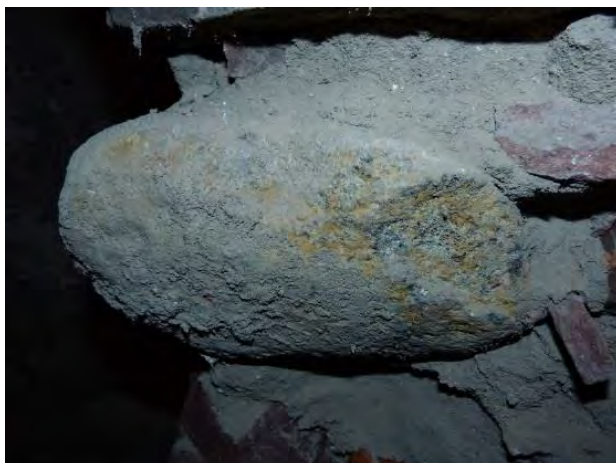
Figur 136. Inslag av annan stentyp i altarets övre nordvästra hörn, strax under den täckande stenhällen. Figur 137. Kyrkans nuvarande puts ligger som ett relativt tjockt lager som sluter an mot det tidigare altarbordets trähölje. Bakomvarande puts har relativt rikligt inslag av tegelkross samt är anfärgat med vit kalkfärg.
