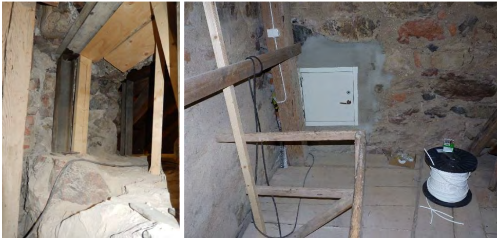
Figur 50. Arbete pågår med öppningen. Foto Svenske Klimatstyrning.
