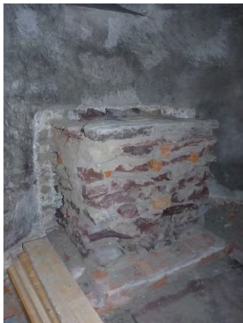
Figur 134. Altaret sett från nordväst. De tjocka utjämnande lagren av lerbruk som tidigare satt mellan kärnan av sten och ytterhöljet av tegel är till större delen borta. Överst ligger en slät stenhäll. Figur 135. Häll av röd sandsten som ligger framför altaret. Söder om denna finns inslag av kol i marken under teglet.
