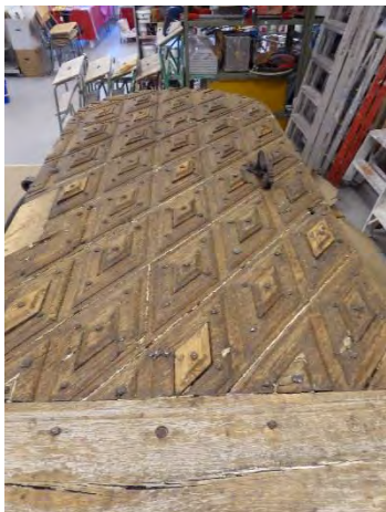
Figur 96. Dörrbladet rengjort. Äldre trälagningar ansas.
