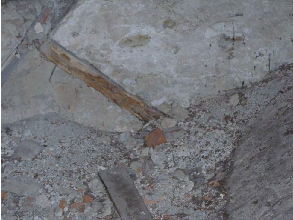
Figur 39. Detalj av träfragment från ett äldre, romanskt taklag som återfinns i muren för det gamla östtornet.
