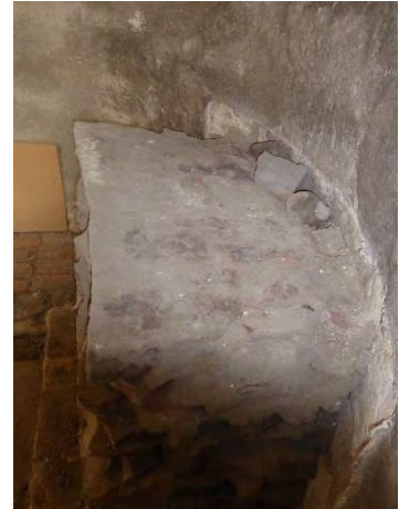
Figur 132. Röda sandstenshällar och tegel. Grått lerbruk med inslag av kalkklumpar. Figur 133. Slät stenhäll täcker delvis altarets yta.
