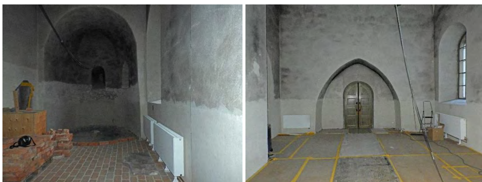
Figur 80. Nya radiatorer vid korets södra vägg,
