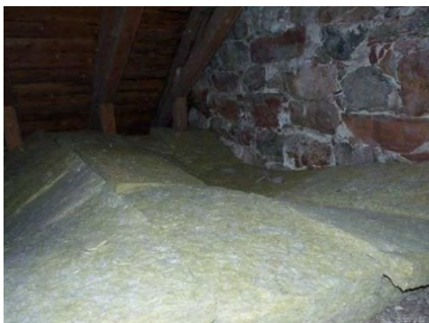
Figur 42. Påbörjad isolering över långhuset.
