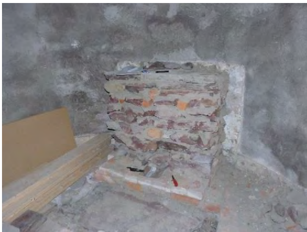
Figur 130. Tegelskalet runt om altaret demonterat och kärnan av röd sandsten framträder. Under konstruktionen ligger en bas av tegel.
