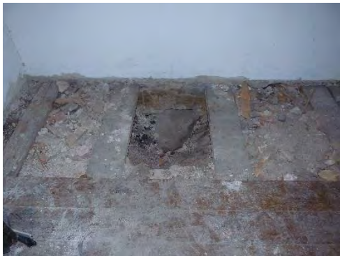
Figur 27. Schaktet i vapenbusets västra del inför indragning av installationer. Man anar inslag av kol.
