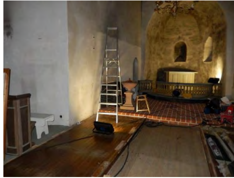
Figur 15. Befintligt golv i mittgången med trossbottenfyllning. Foto Tobias Mårud.
