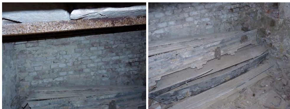
Figur 155. Stenskiivorna vilar på smidda järn, se bildens överkant.
