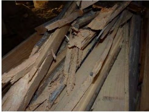
Figur 102. Exempel på insektangripet golvvirke.
