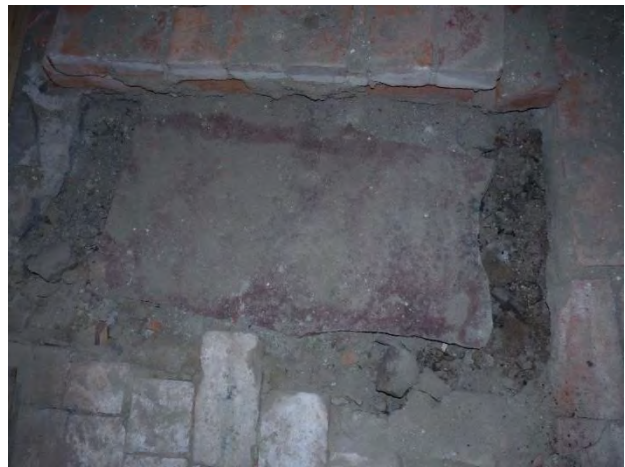
Figur 134. Altaret sett från nordväst. De tjocka utjämnande lagren av lerbruk som tidigare satt mellan kärnan av sten och ytterhöljet av tegel är till större delen borta. Överst ligger en slät stenhäll. Figur 135. Häll av röd sandsten som ligger framför altaret. Söder om denna finns inslag av kol i marken under teglet.
