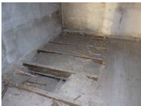
Figur 106. Norra korsarmen sedd mot norr.
