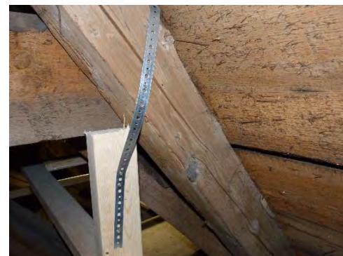
Figur 43. Upphängning av gångbryggor i takstolskonstruktionen. Infästningar enbart utförda i nytt virke.
