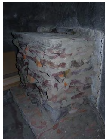
Figur 130. Tegelskalet runt om altaret demonterat och kärnan av röd sandsten framträder. Under konstruktionen ligger en bas av tegel.
