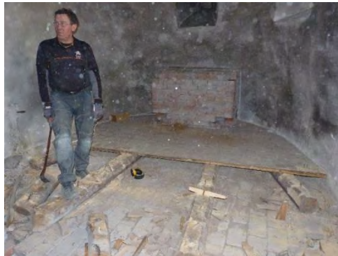
Figur 149. Korgolvet ligger på bjälkar av okantat, obarkat virke. Under bjälkarna anas ett äldre tegelgolv.
