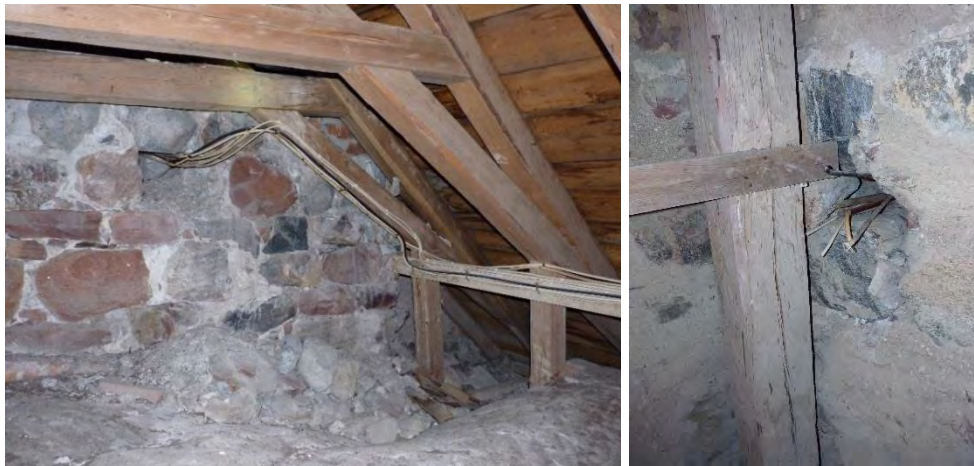
Figur 46. Befintlig öppning mellan långhusvind och torn sedd från långhuset.
