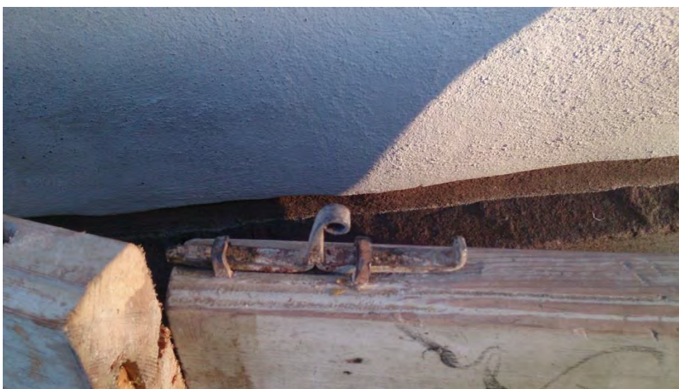
Figur 168. Smidd skjutregel på ovarsidan.
