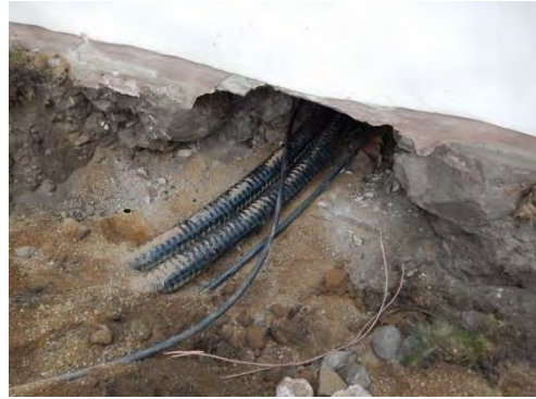
Figur 64. Nya eldragningar i kyrkorummet är dragna i slangar under golvet. Foto Svensk Klimatstyrning.
