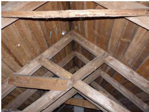
Figur 40. Takstol över långhuset sedd mot öster.
