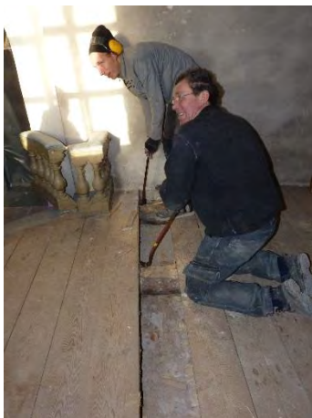
Figur 151. Demontering av korgolvet.
