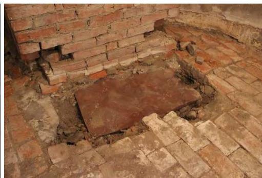
Figur 128. Altaret före demontering av yttre tegelskikt och omgivande trögolv.
