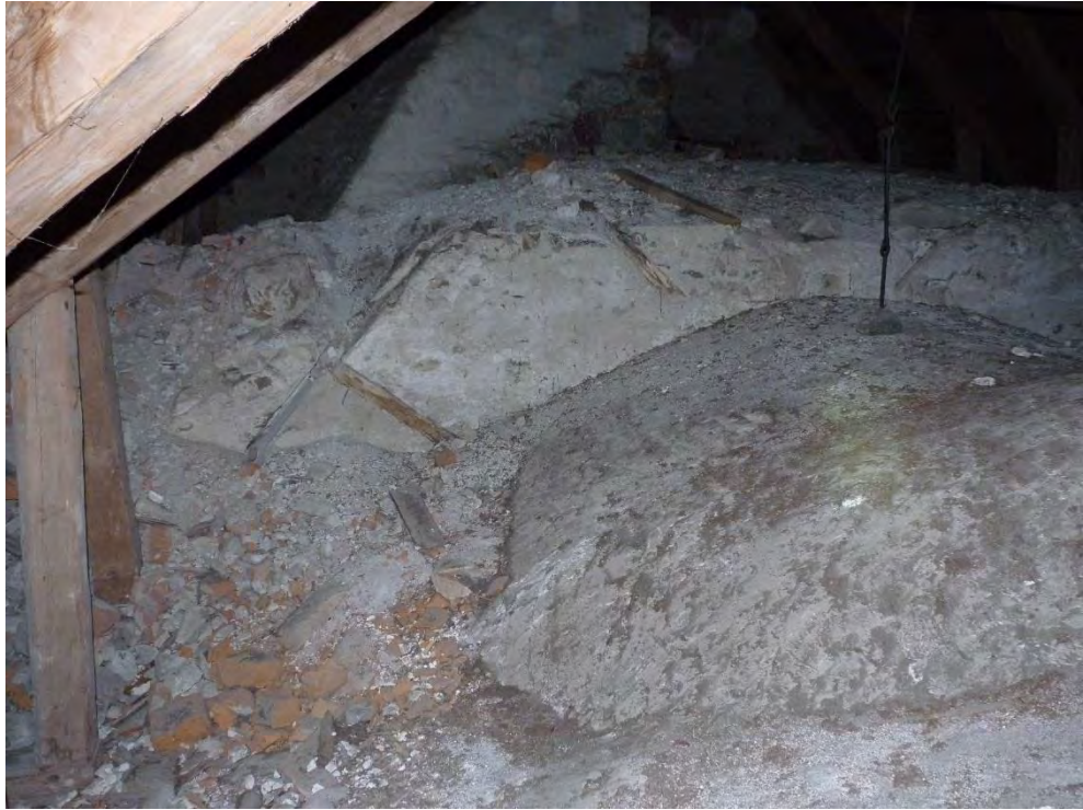
Figur 37. Långbusvinden sedd mot öster med det gamla östtornets mur. Inmurat trä.
