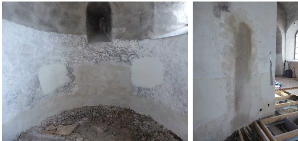
Figur 84. Putslagning i koret (de två ljusare fläckarna är provstrykningar av väggenlören).
