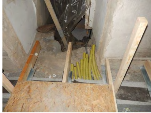
Figur 29. Schaktning under tröskel mellan södra vapenhuset och långhuset, sett från söder. Figur 30. Slangar dragna för elinstallationer mellan södra vapenhuset och långhuset, sett från norr. Foto Svensk Klimatstyrning.
