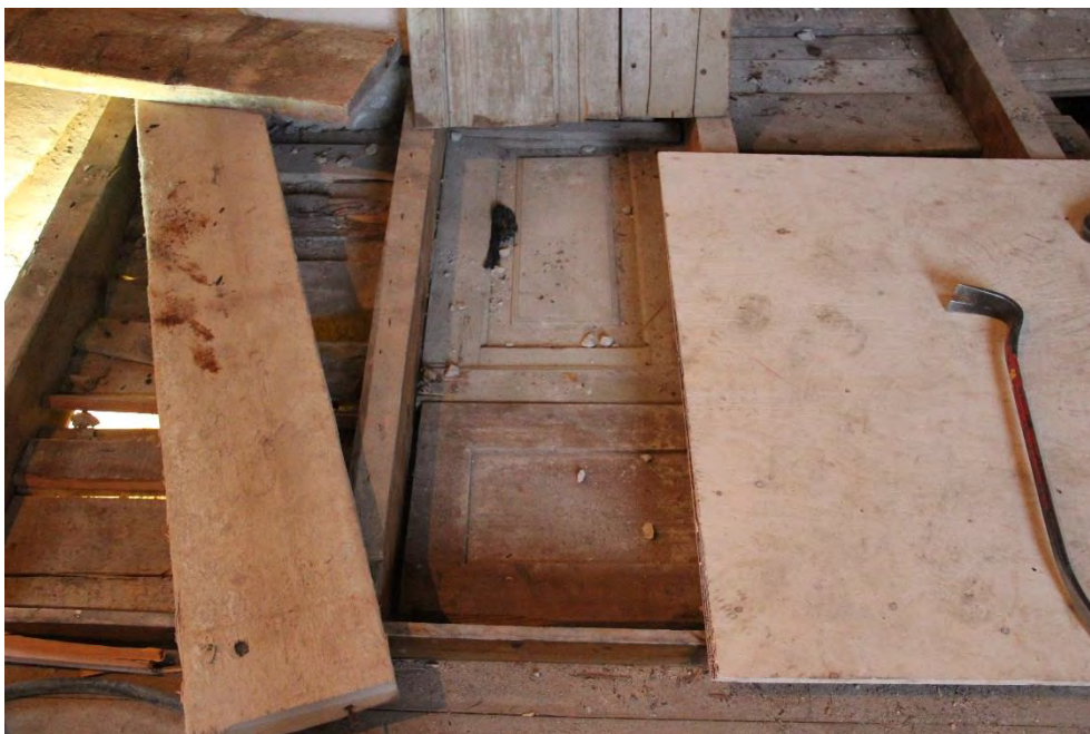
Figur 101. I blindbotten förekom återanvända bänkgavlar.
