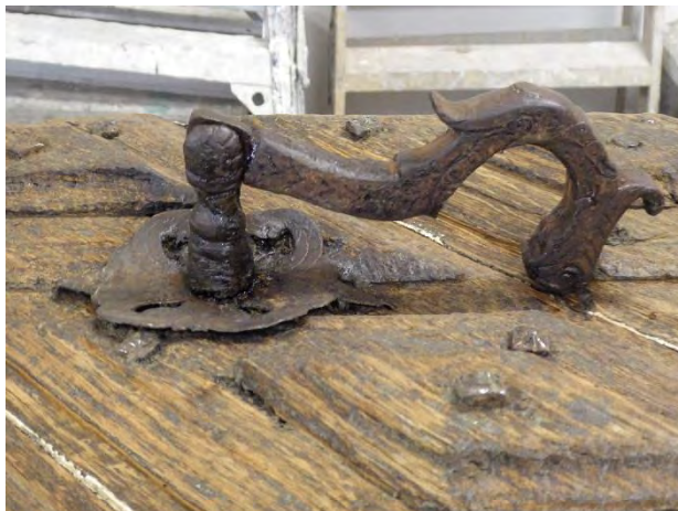
Figur 96. Dörrbladet rengjort. Äldre trälagningar ansas.
