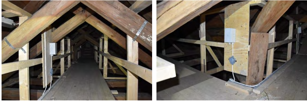
Figur 44. Landgång på vinden. Foto Svensk Klimatstyrning.
