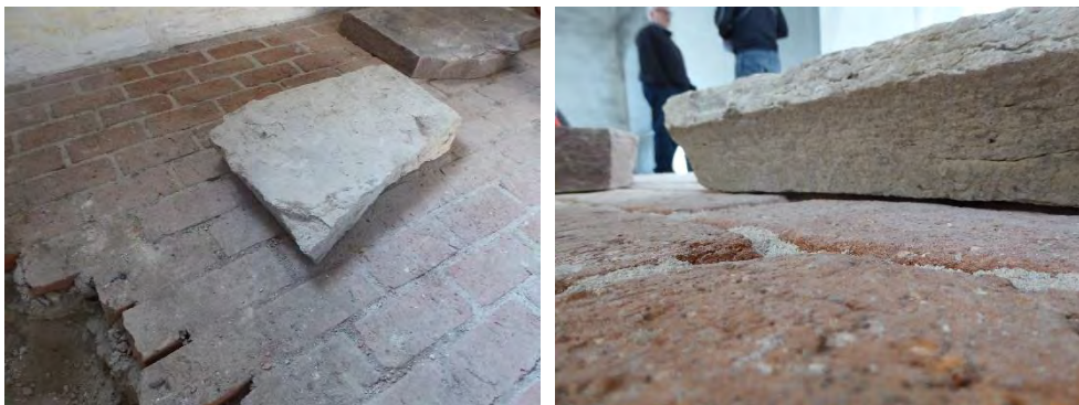
Figur 142. Slät, delvis bearbetad stenhäll som återfinns inne i altarkonstruktionen.
