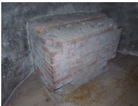
Figur 128. Altaret före demontering av yttre tegelskikt och omgivande trögolv.
