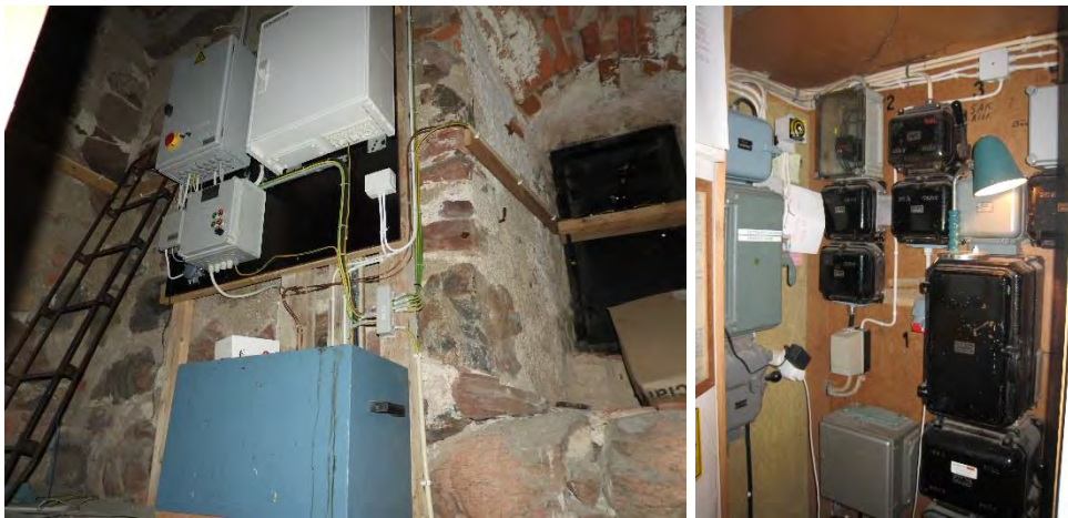
Figur 60. Nya tekniska komponenter monterade i tornet. Figur 61. Äldre elcentral under torntrappan.
