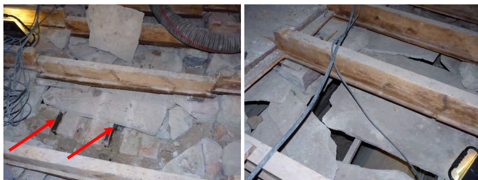
Figur 153. Stenskiivorna bärs upp av smidda järn vid pilarna.
