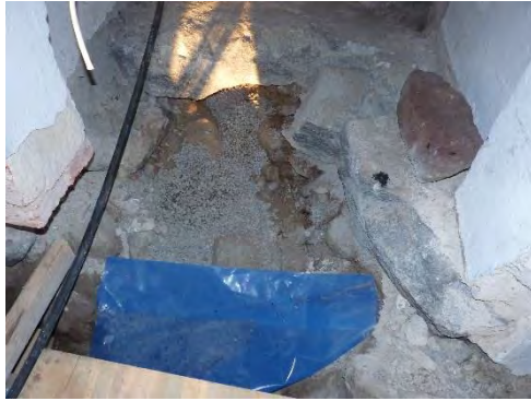
Figur 29. Schaktning under tröskel mellan södra vapenhuset och långhuset, sett från söder. Figur 30. Slangar dragna för elinstallationer mellan södra vapenhuset och långhuset, sett från norr. Foto Svensk Klimatstyrning.
