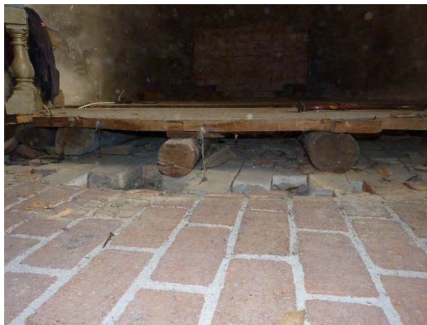
Figur 152. Korgolvet ligger på okantat, obarkat virke. Under detta ligger det äldre tegelgolv.
