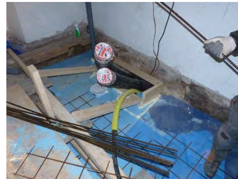
Figur 27. Schaktet i vapenbusets västra del inför indragning av installationer. Man anar inslag av kol.
