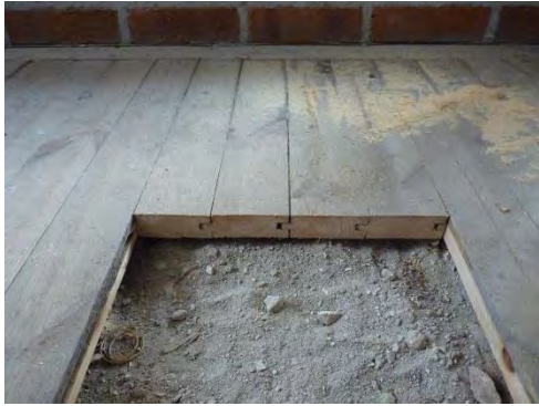
Figur 15. Befintligt golv i mittgången med trossbottenfyllning. Foto Tobias Mårud.
