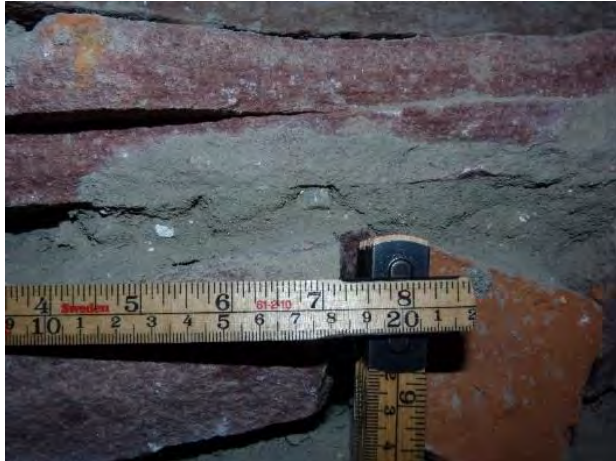
Figur 132. Röda sandstenshällar och tegel. Grått lerbruk med inslag av kalkklumpar. Figur 133. Slät stenhäll täcker delvis altarets yta.
