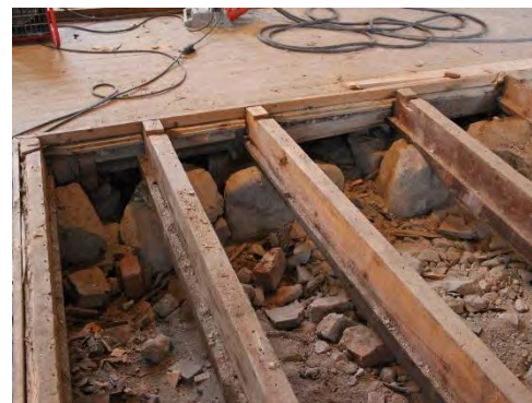
Figur 114. Norra bänkkvarterets östra parti. Kollapsad blindbotten, tidigare upplagd på återanvänd profilerad list (bildens nedre vänstra hörn).
