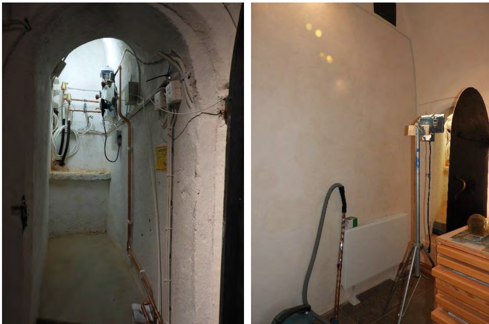
Figur 72. Nya rör för vattenburen värme via den gamla trappan till predikstolen.
