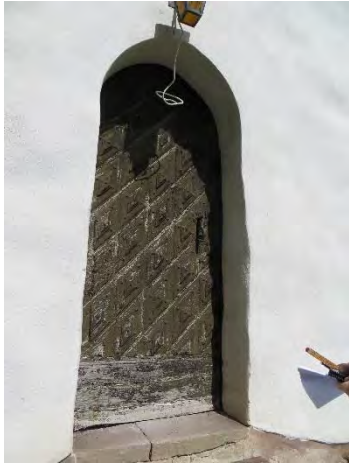
Figur 92. Södra porten före åtgärder.
