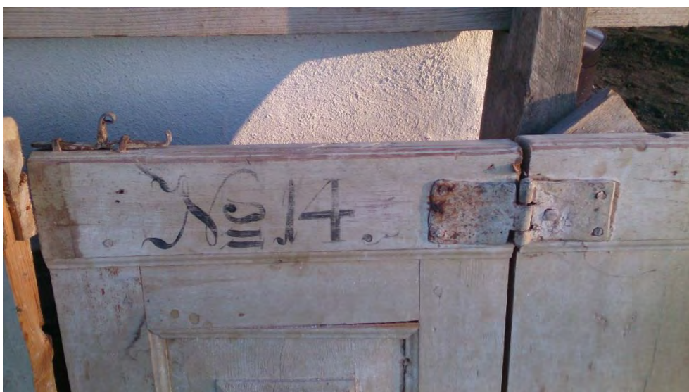
Figur 167. Numreringen av bänkgaveln sitter på översta delen av ramen.
