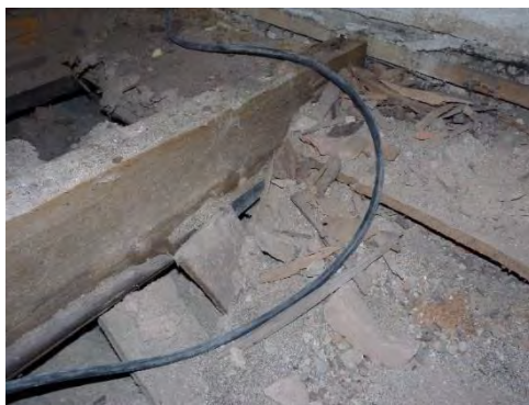
Figur 114. Norra bänkkvarterets östra parti. Kollapsad blindbotten, tidigare upplagd på återanvänd profilerad list (bildens nedre vänstra hörn).
