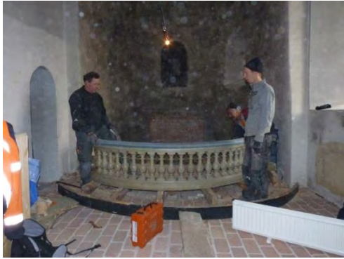
Figur 147. Altarringen under demonteringsarbete.
