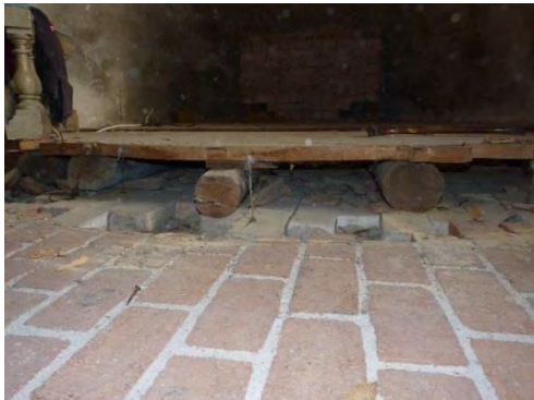
Figur 149. Korgolvet ligger på bjälkar av okantat, obarkat virke. Under bjälkarna anas ett äldre tegelgolv.
