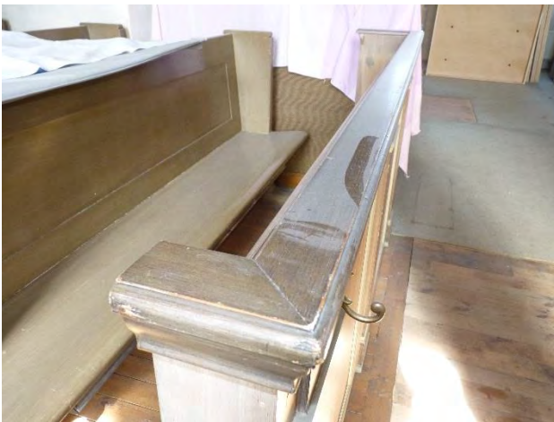
Figur 176. Stommen i bänken är densamma som jugendinredningen men den övre delen på gavlarna har kapats och ryggen ändrats. Jämför figur 170.
