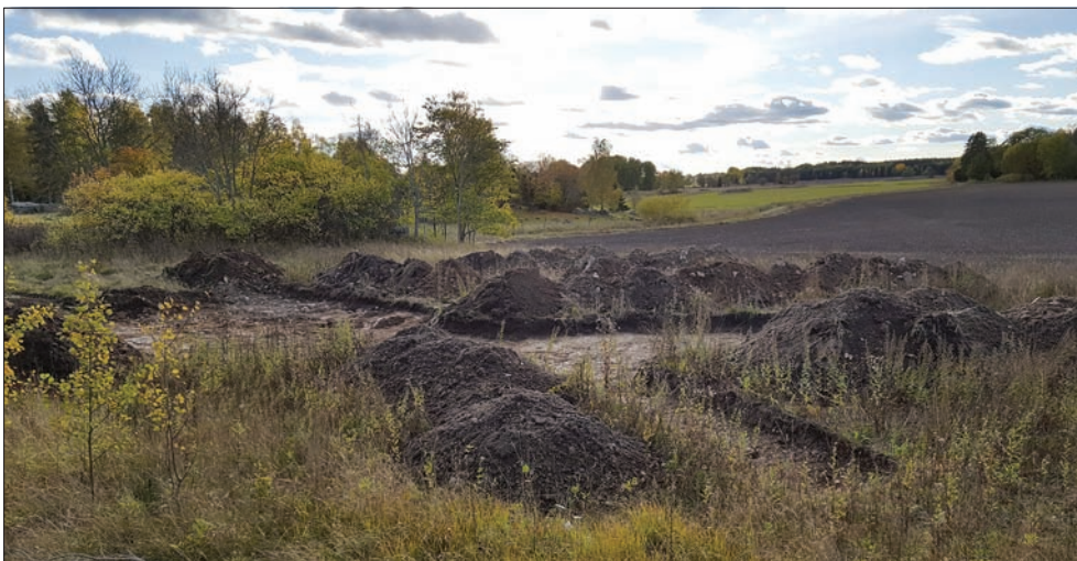
Figur 7. Översikt över utredningsområdet efter schaktning. Foto från nordost.
