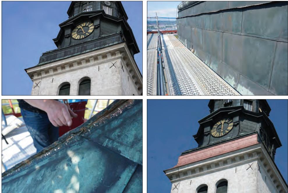
Figur 4 (övre, höger). Södra sidan av tornet innan åtgärd.
