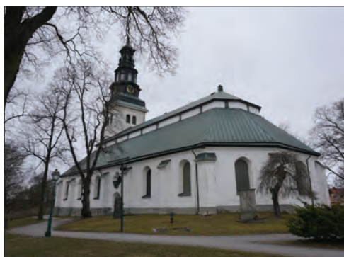
Figur 2. Köpings kyrka sedd från sydöst innan åtgärd.
