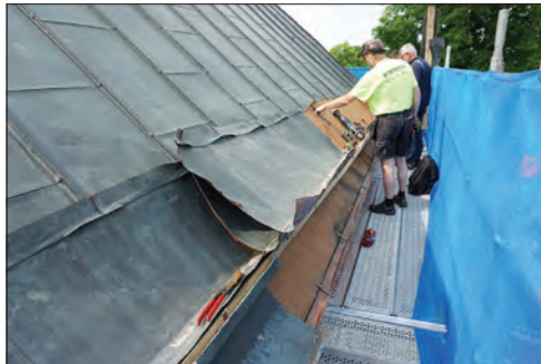
Figur 17 (nedre, höger). Övre södra takfallet efter pappan lagts.
