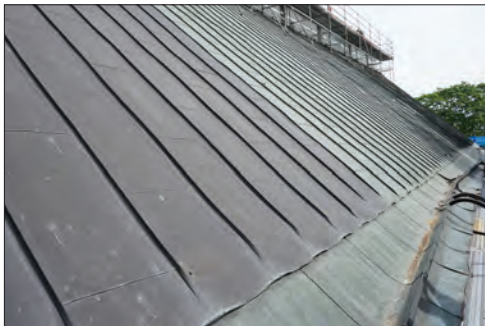
Figur 27. Nedre södra takfallet innan åtgärd.
