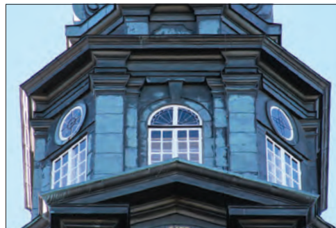
Figur 39. Ett av fönstren i italianen efter åtgärd. Reversibel gångbrygga med falsfästen syns på taket framför fönstret. Foto Lisa Skanser.
