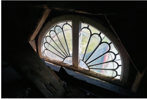
Figur 33. Blyspröjsat lunettfönster in situ, innan åtgärd.
