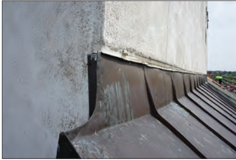
Figur 23. Mjukfog i skarv mellan plåt och puts.
