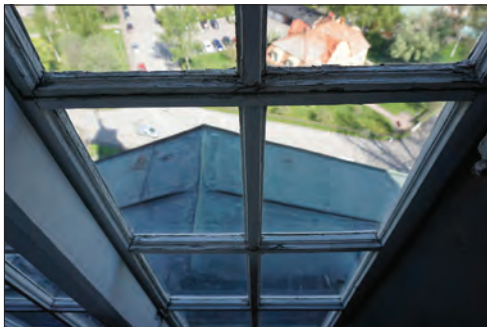
Figur 37. Ett av tornfönstrens ytterbågar, innan åtgärd.
