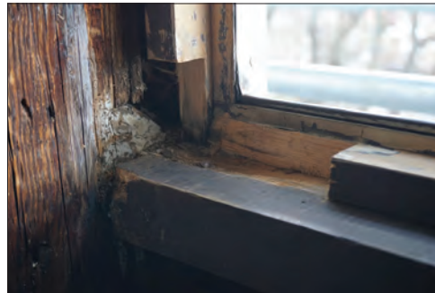
Figur 36. Virkeslagning av karm i italianen, rötskadat virke har tagits ut.
