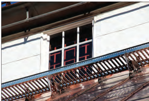
Figur 39. Ett av fönstren i italianen efter åtgärd. Reversibel gångbrygga med falsfästen syns på taket framför fönstret. Foto Lisa Skanser.
