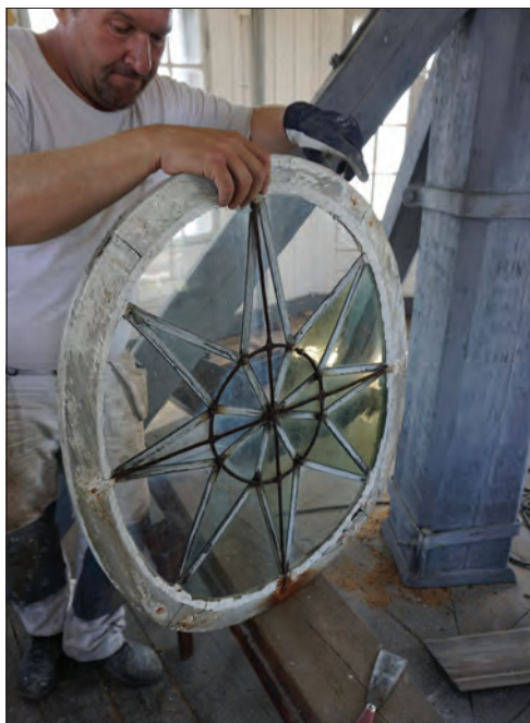
Figur 31. Ett av de ovala blyspröjsade tornfönstren.
