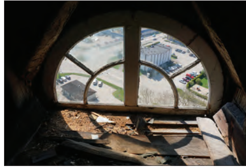
Figur 34. Det fanns även enklare, spröjsade lunettfönster, här innan åtgärd.
