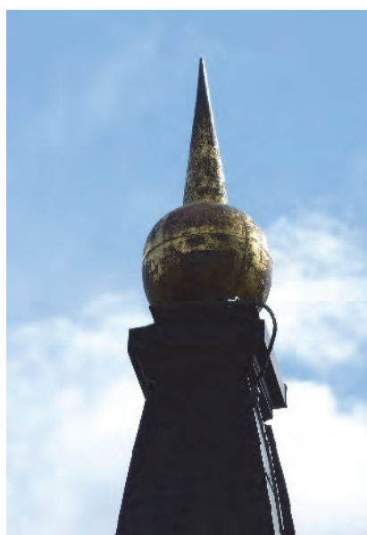
Figur 45. Pik uppe på ett av hörntornens kula. Före åtgärder. Rester återstår av förgyllningen. Foto Helén Sjökvist.
