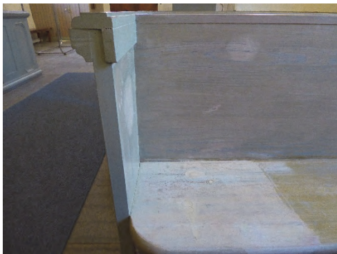
Figur 104. Prov på borttagning av fernissa på bänkarna. Foto Helén Sjökvist.
