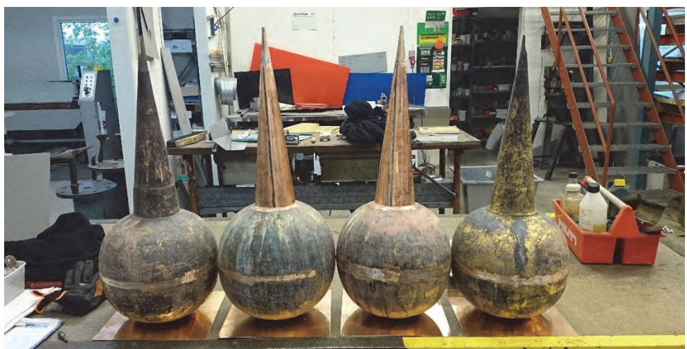
Figur 49. Pikarna fastlödda på kulorna. Nya kopparplåtar monterade under kulorna. Foto Aros plåt.
