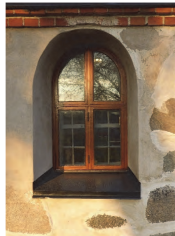
Figur 76. Korfönstret var rostangripet och kittet var till stora delar bortfallet i utsatta lägen. Foto Helén Sjökvist.
