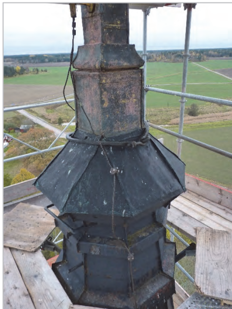
Figur 25. Korsets anslutning mot spiran. Foto Helén Sjökvist.
