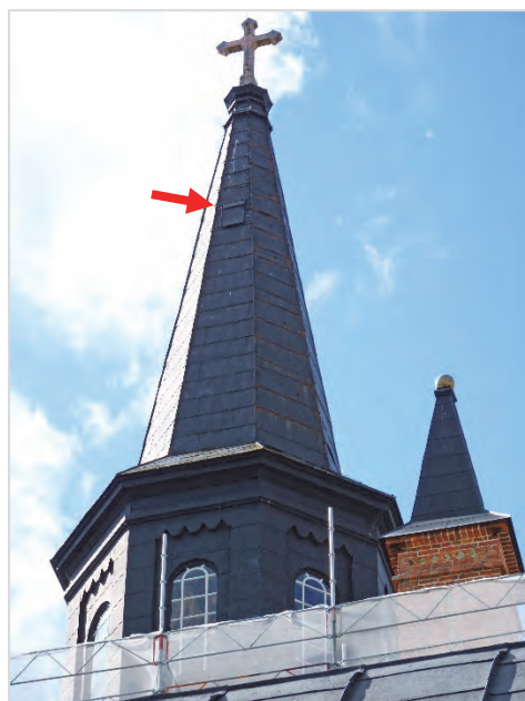
Figur 20. Luckan med tillhörande steg på spirans östra sida. Foto Helén Sjökvist.
