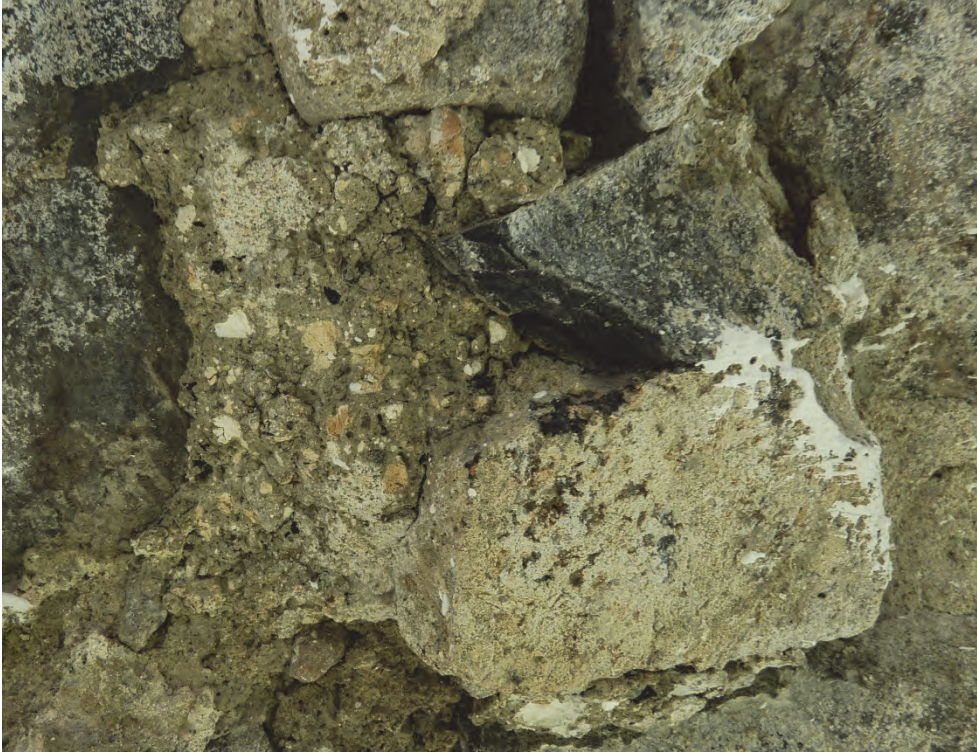
Figur 90. Östra fasaden till böger om korfönster, äldre gråaktigt fogbruk med stora kalkklumpar. Foto Helén Sjökvist.
