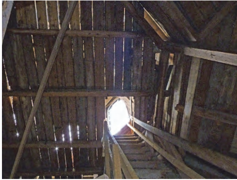
Figur 67. Lanterninens bjälklag före åtgärder. Foto Helén Sjökvist.
