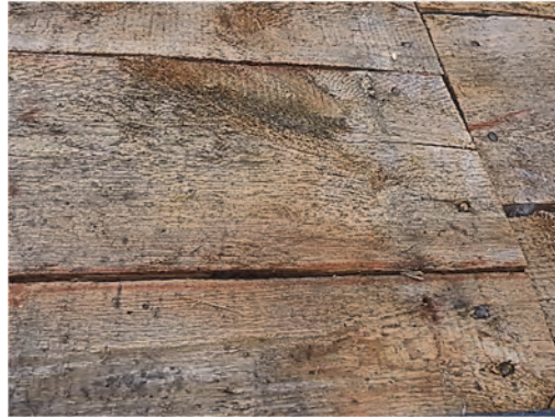
Figur 11. Skivtäckning på norra takfallet före åtgärder. Foto Helén Sjökvist.
