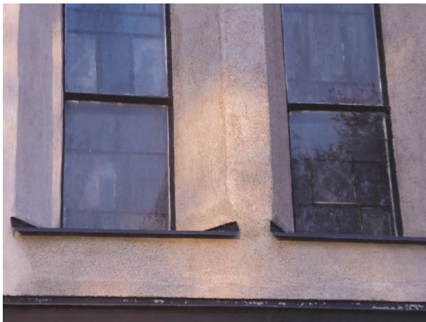
Figur 78. Korfönster efter åtgärder.
