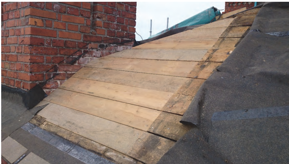
Figur 59. Lagning av undertak på tornkransen (jfr figur 57 och 58). Foto Aros plåt.
