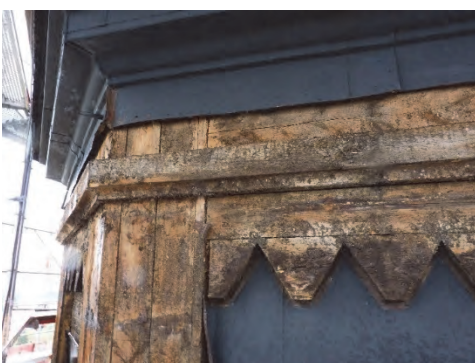
Figur 22. Profilerade delar i lanterninens trästomme. Foto Helén Sjökvist.
