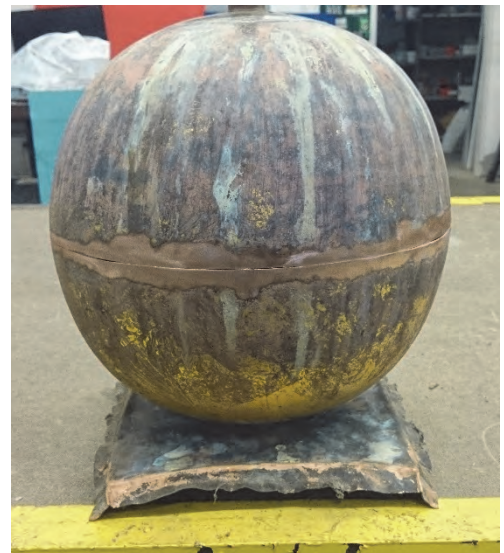
Figur 47. De två nya pikarna löddes fast vid kulorna. Foto Aros plåt.
