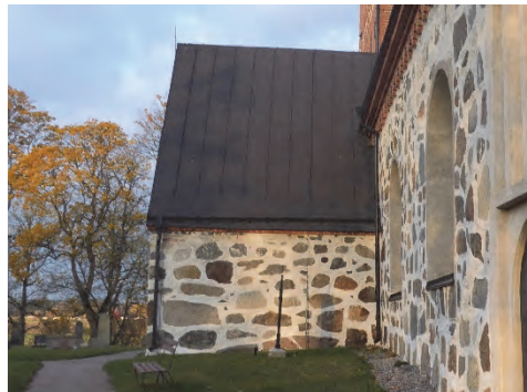
Figur 29. Vapenhusets taklucka togs bort på grund av läckageproblem. Foto Helén Sjökvist.
