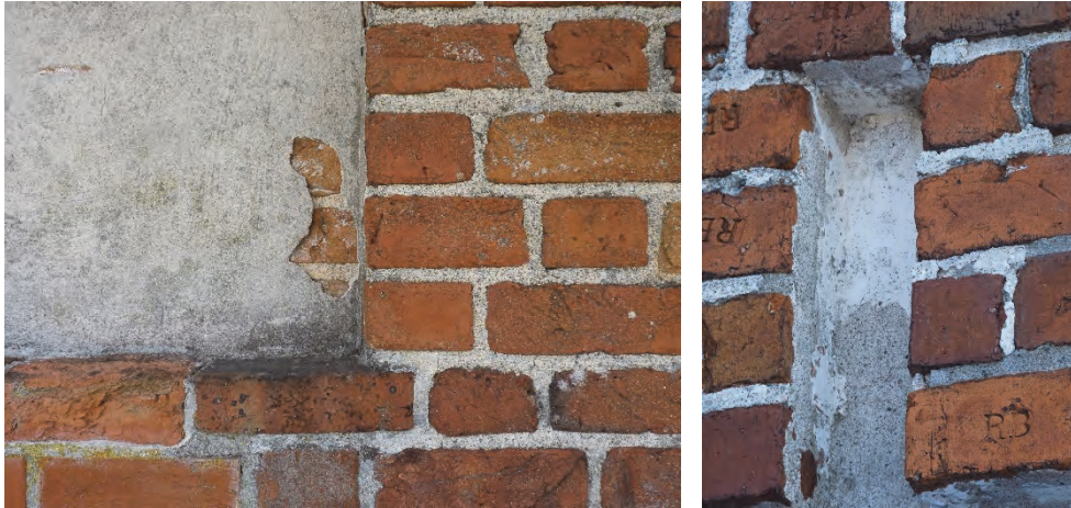
Figur 94. Putsen släpper från blindingen. Tornets norra sida. Foto Helén Sjökvist.
