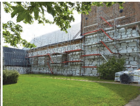
Figur 86. Södra fasaden, puts spår på stenen. Modern, cementhaltig fogstrykning. Foto Helén Sjökvist.
