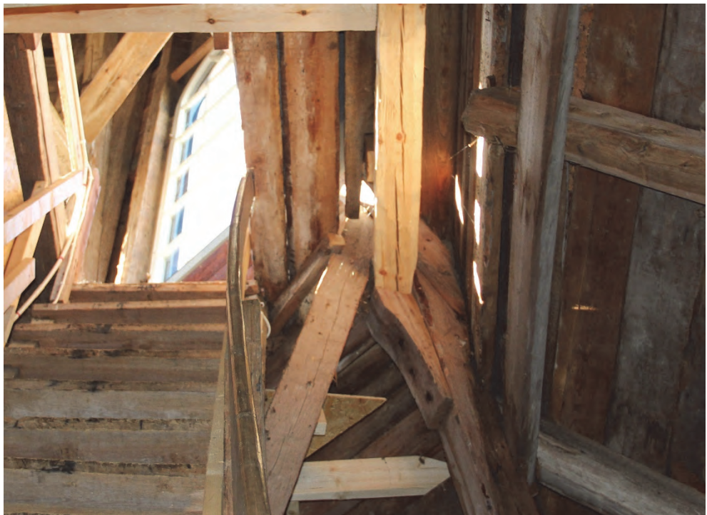
Figur 66. Bjälken i figur 65 är utbytt men konsolen kunde återanvändas. Foto Lisa Skanser.
