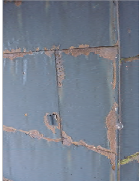
Figur 25. Korsets anslutning mot spiran. Foto Helén Sjökvist.
