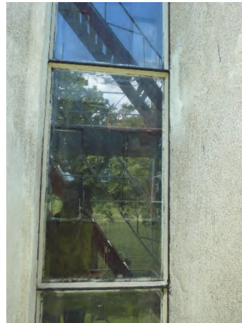
Figur 76. Korfönstret var rostangripet och kittet var till stora delar bortfallet i utsatta lägen. Foto Helén Sjökvist.
