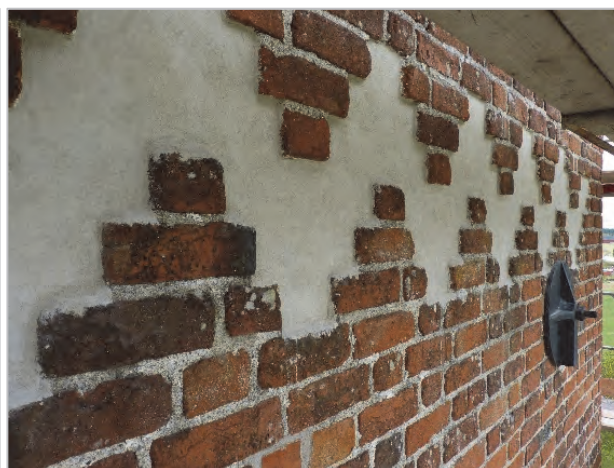
Figur 98. Omfogat tegel på hörntorn. Foto Helén Sjökvist.
