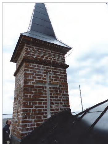
Figur 98. Omfogat tegel på hörntorn. Foto Helén Sjökvist.
