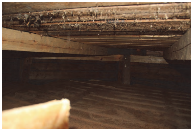
Figur 75. Nya, bilade bjälkar under lanterninens golv. Foto Lisa Skanser.
