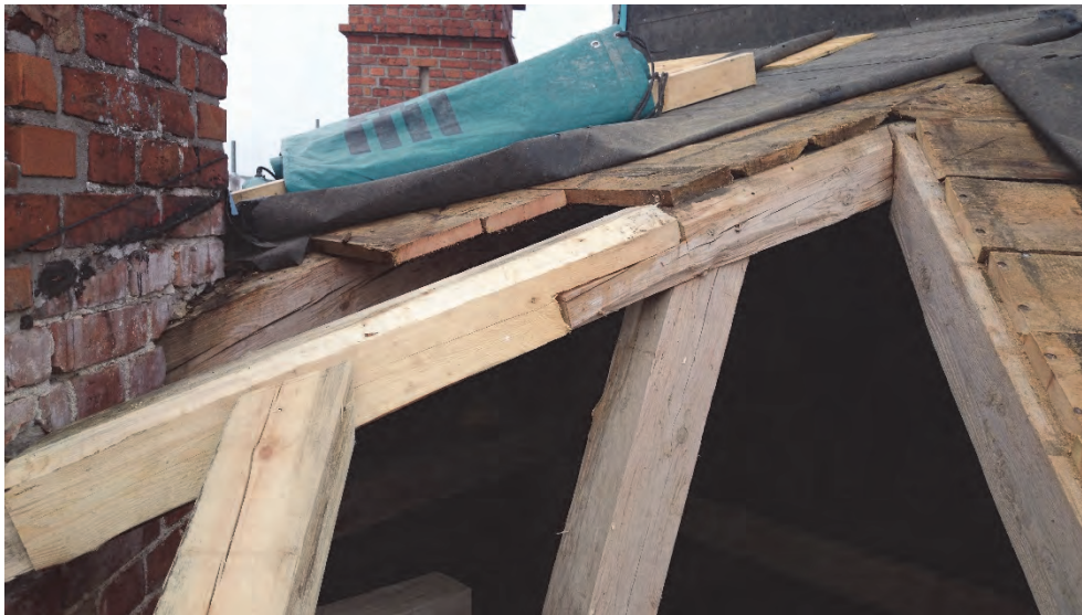
Figur 58. Byte av virke i stommen vid skada i sydöstra delen av tornkransen. Halvt i halvt lagning. Foto Aros plåt.
