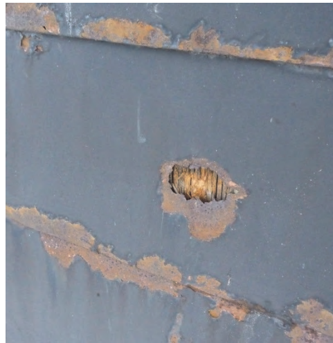
Figur 13. Den gamla plåtens baksida med fästbleck och klippspik. Rostangripna falsar. Foto Helén Sjökvist.
