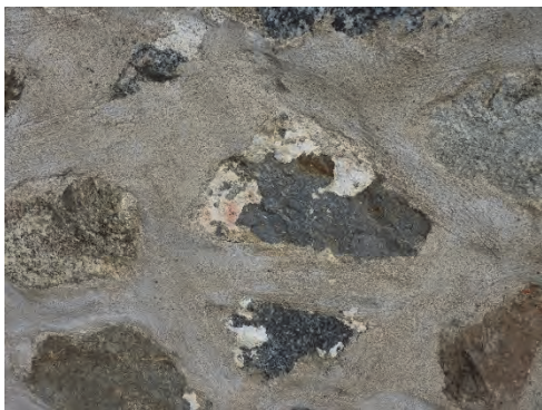
Figur 86. Södra fasaden, puts spår på stenen. Modern, cementhaltig fogstrykning. Foto Helén Sjökvist.
