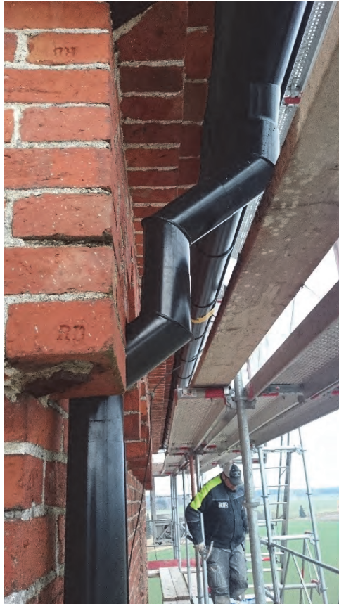
Figur 33. Ny takavvattning på torn. Foto Helén Sjökvist.
