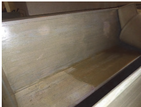
Figur 104. Prov på borttagning av fernissa på bänkarna. Foto Helén Sjökvist.
