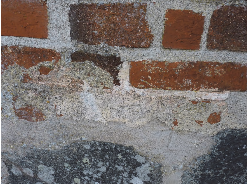
Figur 88. Anslutningen mellan tegel och naturstensmur på tornets norra sida. Små spår finns av att kalkbruket i äldre tid har tonats i rosa och vitt för att få en jämn övergång mellan murverken och ett mer distinkt utseende på fogen. Den moderna kc-fogen har en jämngrå ton.
