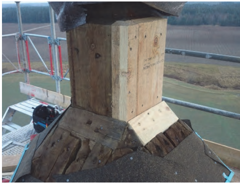
Figur 27. Delvis utbytt virke vid korsets infästning. Foto Aros plåt.
