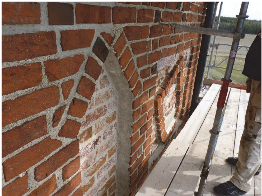
Figur 93. Bländeringar på tornets södra sida har i princip knackats rena från tidigare puts. Foto Helén Sjökvist.
