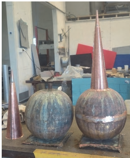
Figur 47. De två nya pikarna löddes fast vid kulorna. Foto Aros plåt.
