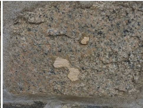
Figur 84. Rosa kulör under vit kalkfärg. Vapenbusets östra sida. Foto Helén Sjökvist.
