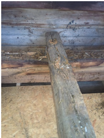
Figur 69. Vid bortmonteringen av golvbrädorna visade sig större delen av timret vara kraftigt rötskadat. Foto Johan Back, 3:12 byggnadsvård.
