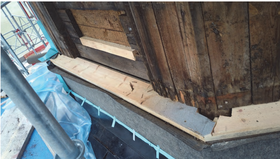
Figur 64. Lagningar i speglar under lanterninfönster. Foto Aros plåt.
