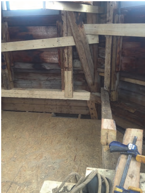
Figur 71. Utbyte av timmer. Foto Johan Back, 3:12 byggnadsvård.
