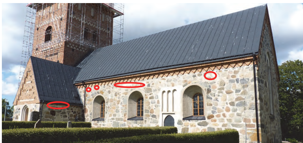
Figur 108. Några av platserna där fragment av rosatonad puts återfanns (ungefärliga lägen). Foto Helén Sjökvist.
