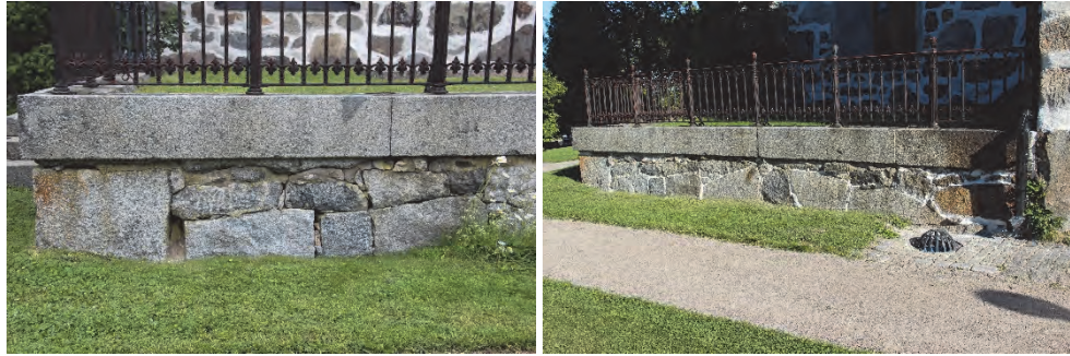
Figur 100. Terrassering för gravvård väster om det södra vapenhuset före åtgärder.
