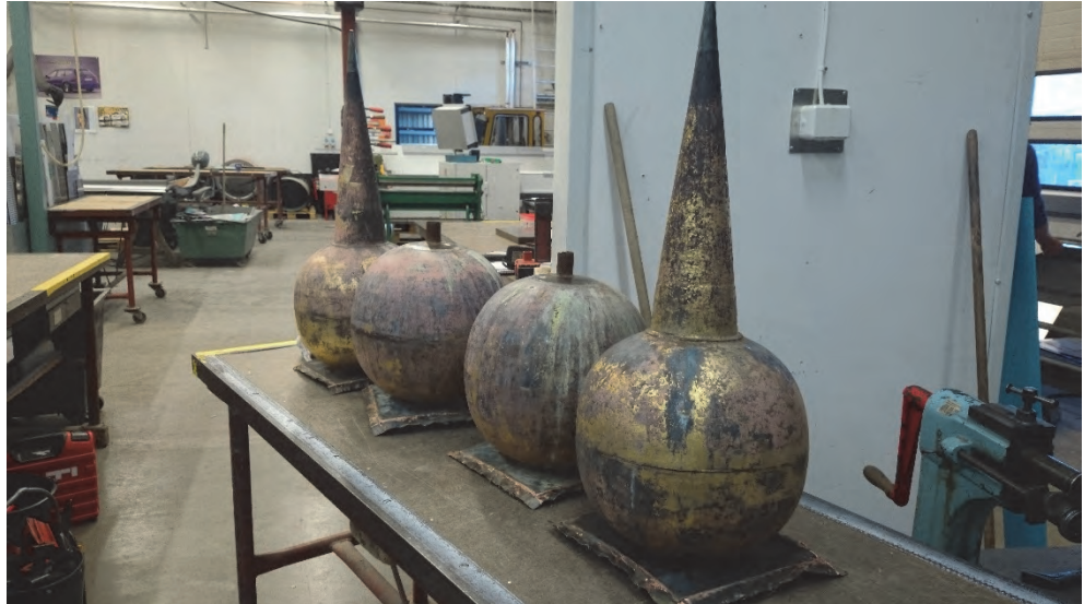
Figur 46. Kulorna intagna på verkstad. Två pikar saknas. Foto Aros plåt.
