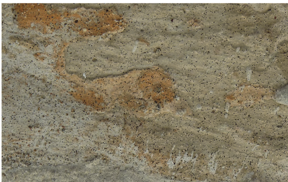
Figur 109. Vapenbusets östra sida, fragment av avfärgad puts under takfot. Foto Helén Sjökvist.
