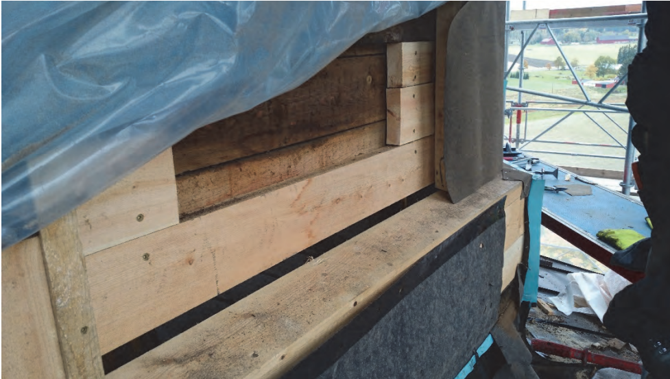
Figur 63. Pågående lagningar i speglar under lanterninfönster. Foto Aros plåt.
