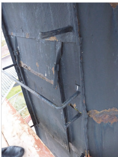
Figur 20. Luckan med tillhörande steg på spirans östra sida. Foto Helén Sjökvist.
