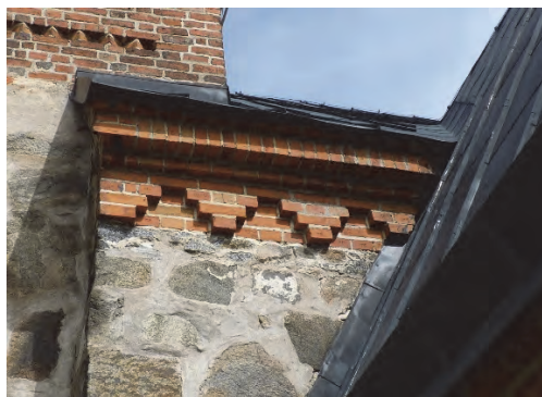
Figur 35. Södra långhustaket saknade hängränna eller fotränna där vattnet kom att ledas ner via tornets nya stuprör. Foto Helén Sjökvist.
