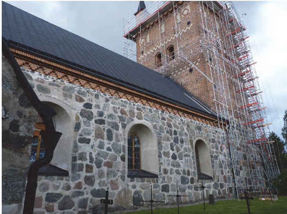
Figur 10. Norra fasaden och takfallet före åtgärder. Foto Helén Sjökvist.
