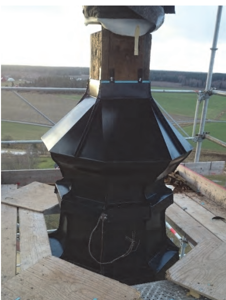
Figur 44. Ny plättäckning. Foto Aros plåt.
