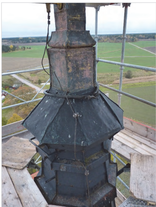
Figur 42. Korsets anslutning mot spiran. Foto Helén Sjökvist.
