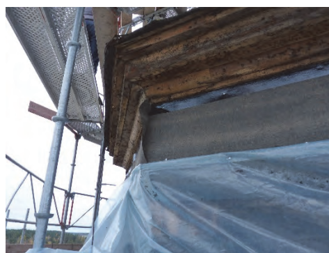
Figur 22. Profilerade delar i lanterninens trästomme. Foto Helén Sjökvist.
