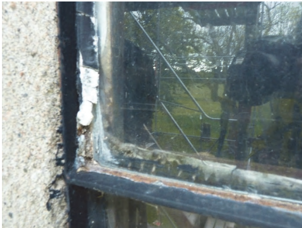
Figur 76. Korfönstret var rostangripet och kittet var till stora delar bortfallet i utsatta lägen. Foto Helén Sjökvist.
