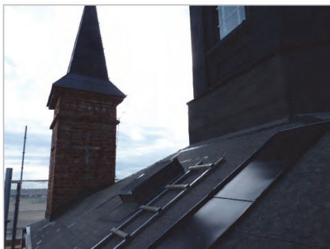
Figur 18. Ny taklucka på tornkeransen. Foto Helén Sjökvist.
