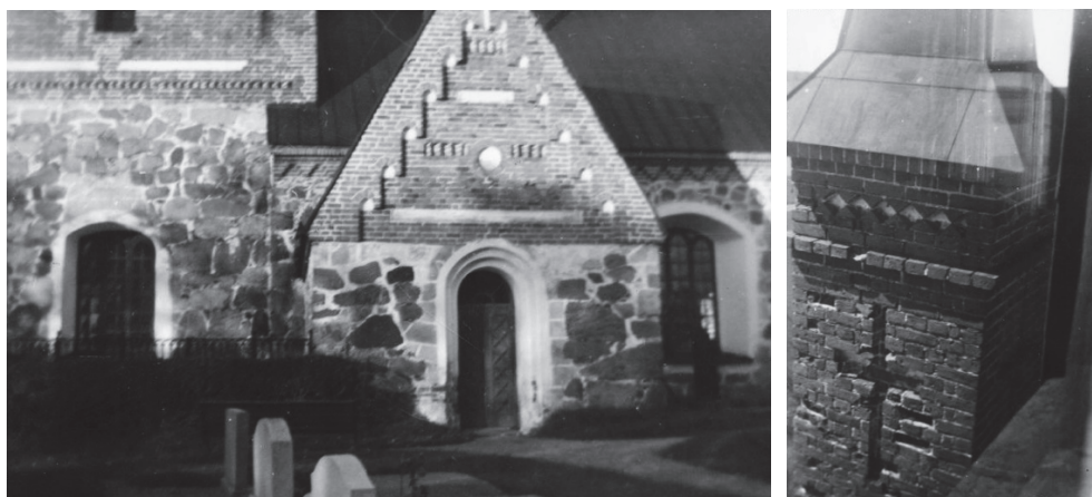
Figur 80. Södra vapenhuset. Antydning till bemalad puts kring entrén. Okänd fotograf och år, ATA. Figur 81. Ett av hörntornen med åtminstone delvis putsade blindingar. Skadat tegel. Okänd fotograf och år, ATA.
