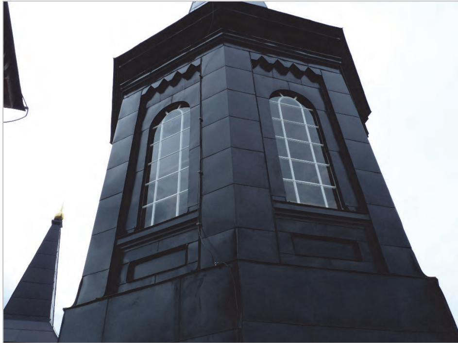
Figur 24. Ny plättäckning på lanterninen. Foto Helén Sjökvist.
