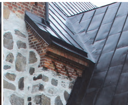
Figur 35. Södra långhustaket saknade hängränna eller fotränna där vattnet kom att ledas ner via tornets nya stuprör. Foto Helén Sjökvist.
