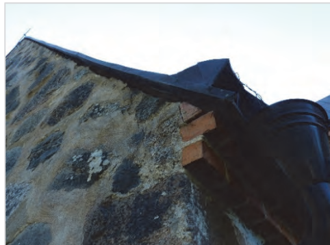
Figur 31. Sakristians plåttak hade före åtgärder en glipa där undertaketets bräder var oskyddade. Foto Helén Sjökvist.
