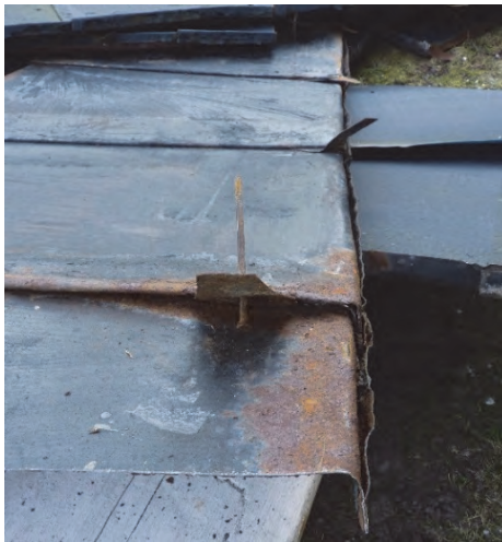
Figur 13. Den gamla plåtens baksida med fästbleck och klippspik. Rostangripna falsar. Foto Helén Sjökvist.
