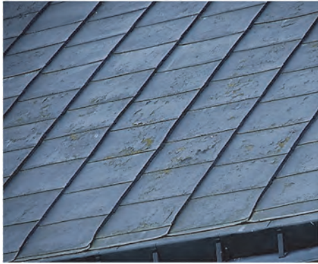
Figur 11. Skivtäckning på norra takfallet före åtgärder. Foto Helén Sjökvist.
