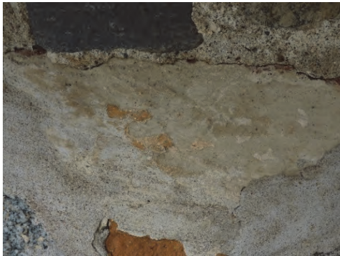
Figur 84. Rosa kulör under vit kalkfärg. Vapenbusets östra sida. Foto Helén Sjökvist.
