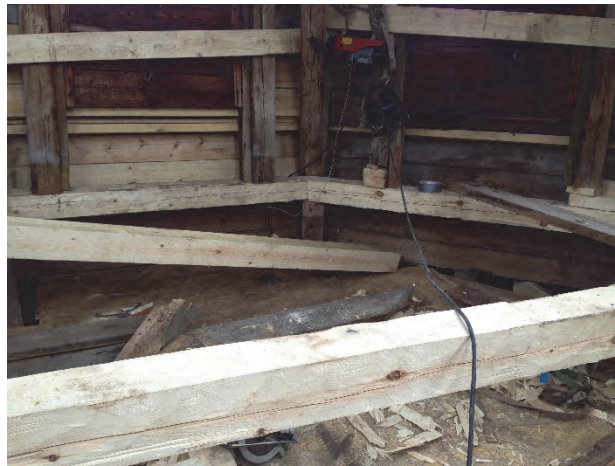
Figur 69. Vid bortmonteringen av golvbrädorna visade sig större delen av timret vara kraftigt rötskadat. Foto Johan Back, 3:12 byggnadsvård.
