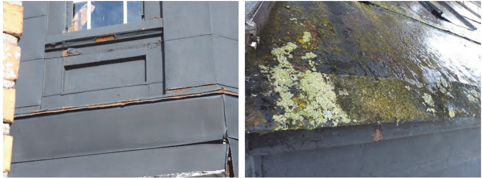
Figur 15. Rostangrepp på lanterninens södra sida. Foto Helén Sjökvist.
