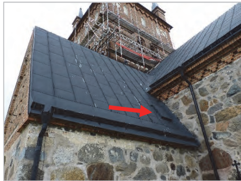
Figur 29. Vapenhusets taklucka togs bort på grund av läckageproblem. Foto Helén Sjökvist.
