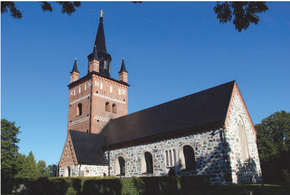
Figur 91. Kyrkan sedd från sydöst efter genomfört arbete. Foto Helén Sjökvist.
