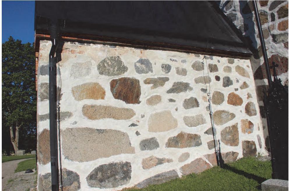
Figur 92. På vapenhusets östra sida har ett parti med äldre fog och puts sparats under takfoten. Foto Helén Sjökvist.
