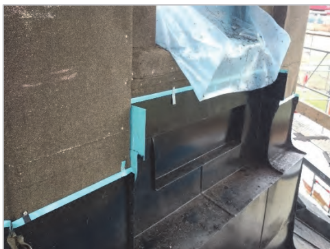
Figur 19. Lanterninen med papp och ny plåt. Foto Helén Sjökvist.
