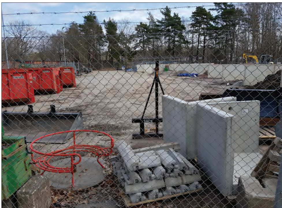
Figur 7. Platsen för gruvområdet Nyköping 280:5 som det ser ut idag. Foto från sydväst.
