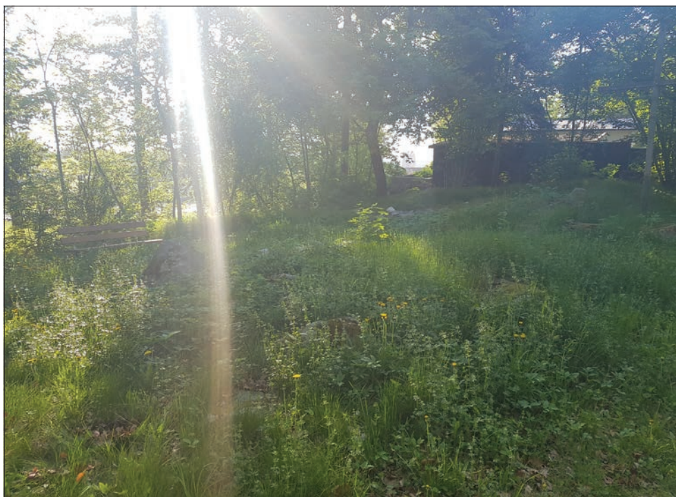
Figur 3. S:ta Ursulas kapellruin. Vid undersökningstillfället var ruinen till stora delar övervuxen. Foto från nordväst.
