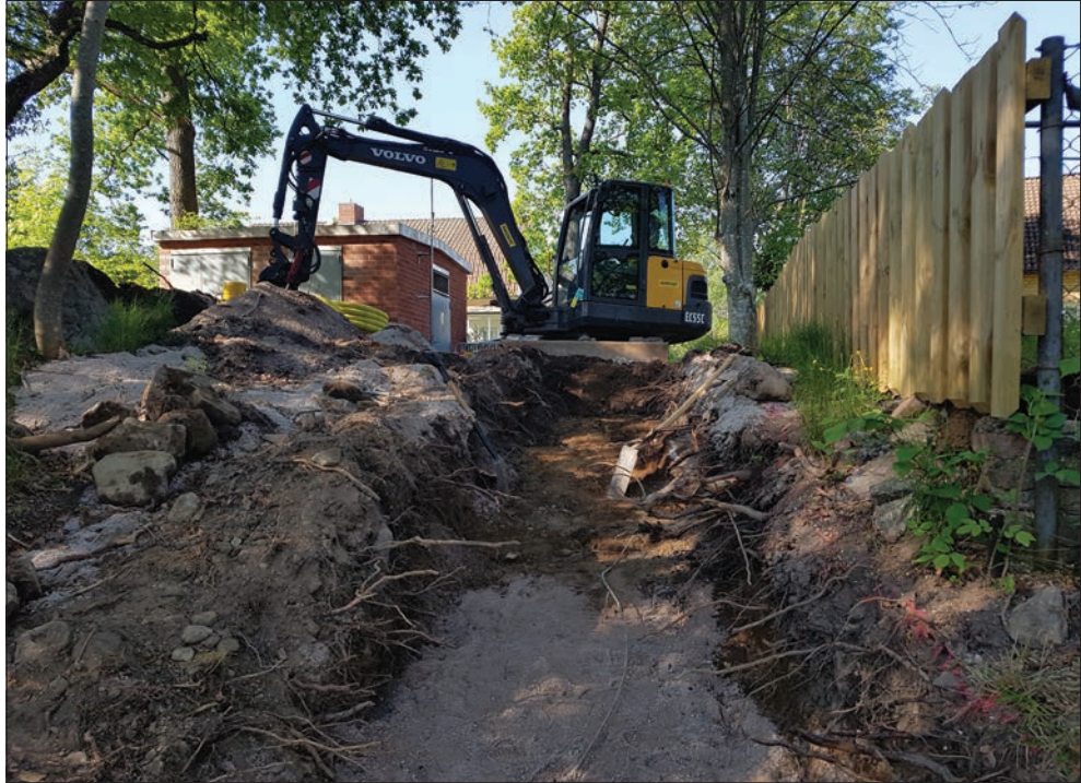
Figur 5. Schaktet anslöt till transformatorstationen som syns till vänster om grävmaskinen. Foto från öster.
