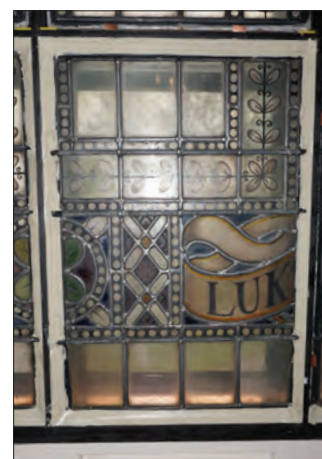
Figur 56. Ruta under montering, kittning pågår. Distansklössar och bleck är synliga.
