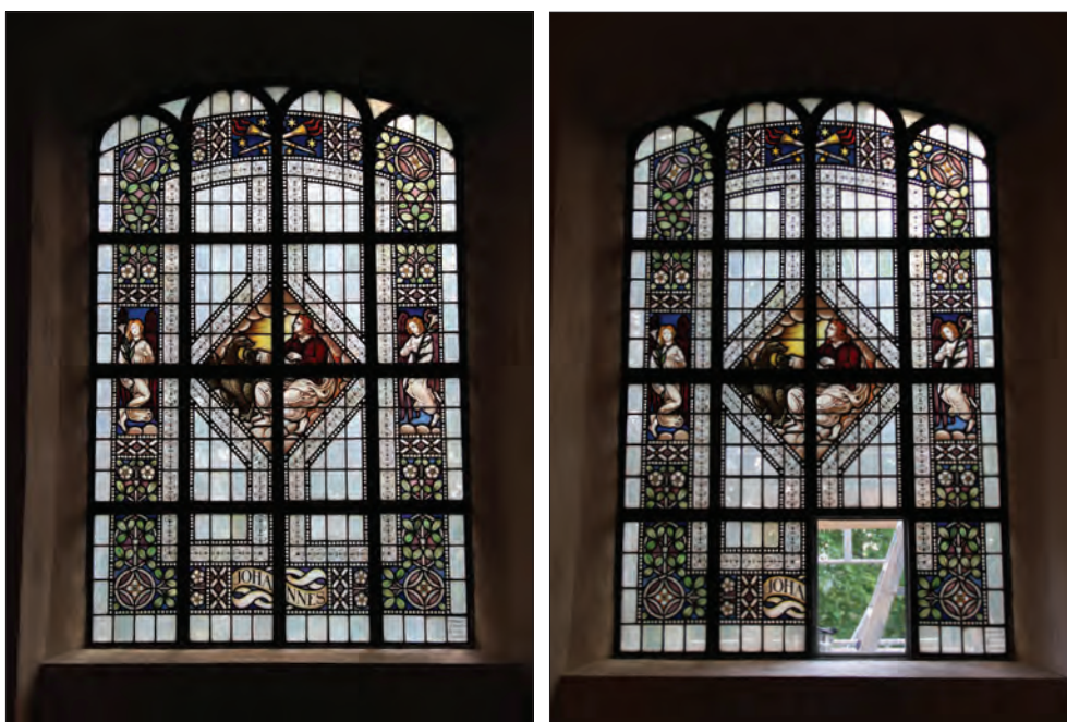
Figur 39. Västra fönstret på korets södra sida, innan åtgärd.
