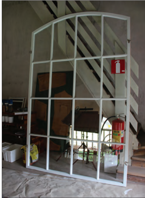
Figur 11 (vänster, övre). Omkittning av ytterbåges insida, kitt i god kondition lämnades kvar.
