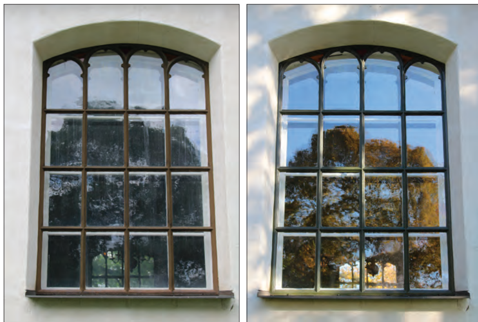
Figur 9. Fönster i södra långhusfasaden, innan åtgärd.
