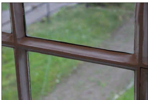
Figur 48. Inside av ytterbåge efter omkittning och grundmålning.
