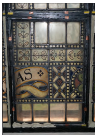
Figur 56. Ruta under montering, kittning pågår. Distansklössar och bleck är synliga.
