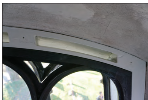
Figur 53. Ny innerbåge på plats, utan rutor. Fönsterbänk är putsad och kondensavrinningen är synlig liksom ventilationsöppningarna i innerkarmens nederkant.
