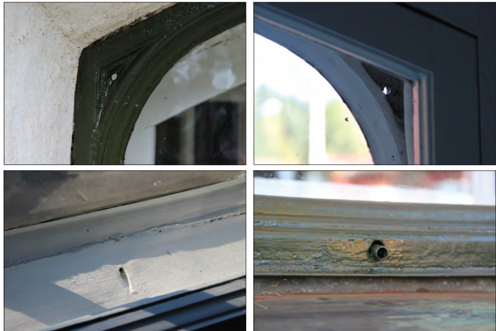
Figur 18 (vänster, övre). Luftningshål i ytterbågens ena övre hörn.
