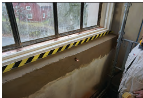
Figur 49. Omputsning av fönsterbänk, med ram till innerbåge monterad och tapp för kondensavrinning synlig.
