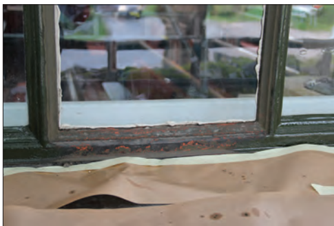
Figur 14. Behandling av rostigt parti på ytterbåge.
