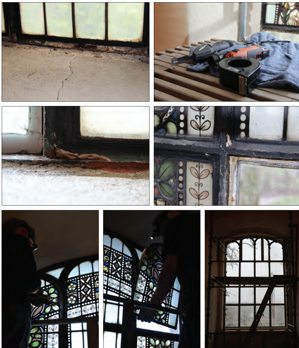
Figur 41 (överst, vänster). Detalj av korffönster och fönsterbänk innan åtgärd. Figur 42 (överst, höger). Några av de verktyg som användes vid arbetet. Figur 43 (mitten, vänster). Detalj som visar på mängden kitt som rutorna var monterade i. Figur 44 (mitten, höger). Kvarvarande tryckkitt efter demontering av ruta. Figur 45 (nederst, vänster). Bearbetning av kitt. Figur 46 (nederst, mitten). Demontering av ruta (eller kassett). Figur 47 (nederst, höger). Fönster med samtliga rutor demonterade.
