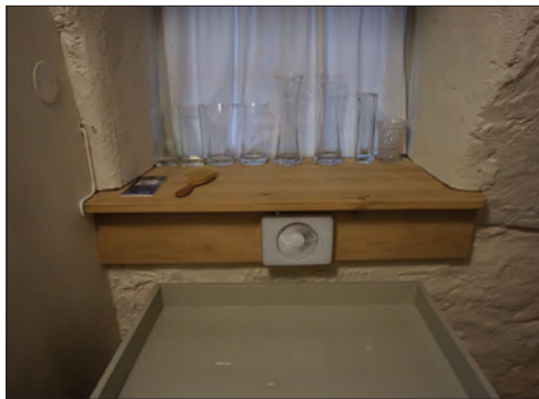
Figur 11. Bänkskiva och fläkt monterad.
