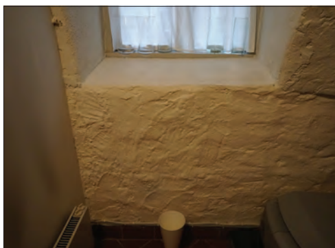
Figur 5. Fönster och murverk invändigt innan åtgärd.
