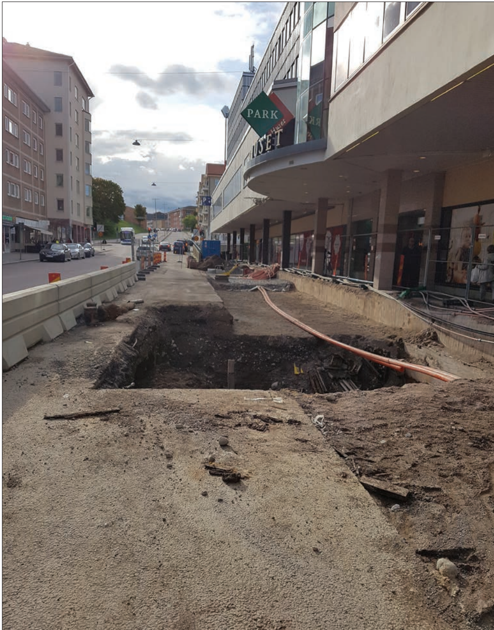
Figur 3. Schakt 1 för underhåll av VA. Foto från öster av Oskar Spjuth.
