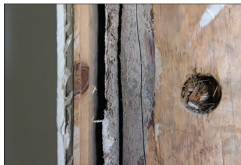
Figur 19. Lerklining närmast timmer i vägg, därefter träskiva och gips (mot vänster, dymlingshål till höger).
