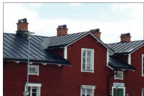
Figur 14. Samma vy efter att samtliga skorstenar åtgärdats. Foto Anders Larsson, Harakers Bygg.
