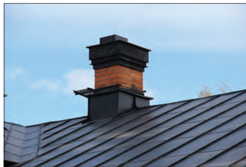
Figur 11. Den södra skorstenen innan åtgärd.
