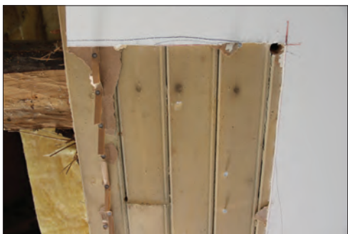
Figur 18. Pärlspont gömmer sig under den senare takbeklädnaden.
