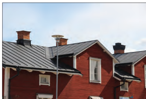
Figur 13. Taket från nordväst med orörda skorstenar.
