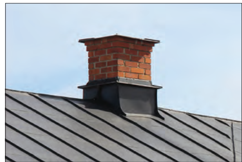
Figur 12. Den norra skorstenen innan åtgärd, från början tänkt att rivas och ersättas med plåt.
