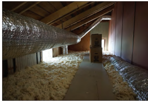
Figur 9. Ena kattvinden efter åtgärd.
