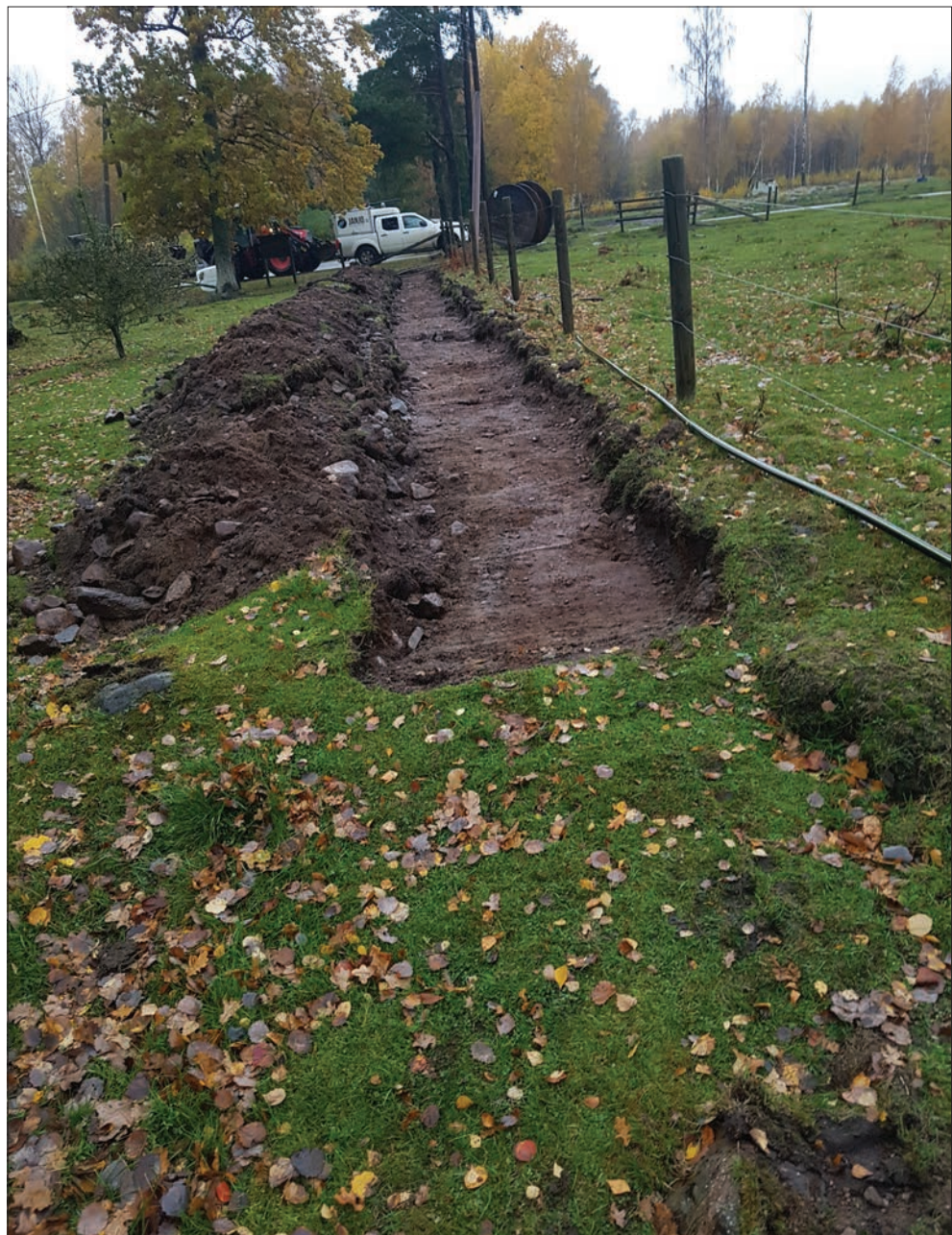
Figur 13. Pågående schaktning i kohagen söder om gravfältet Östra Eneby 59:1. Foto från söder av Tom Carlsson.
