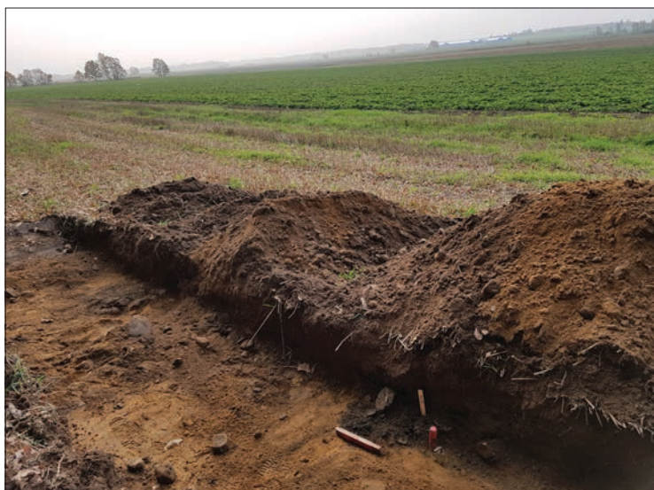
Figur 11. Område 3, västra delområdet. Utsikt mot sydöst med A15 i schaktkanten. Foto Tom Carlsson.
