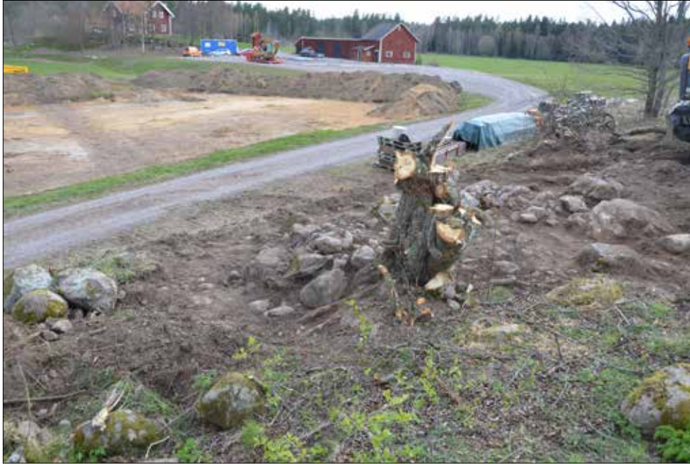
Figur 26. Översiktsbild från kullen under pågående schaktning, med Kulla Brunnsgården i bakgrunden. I slutningen syns terrasskanten A2279, lagd som en stenrad med tre sidor, i form av en öppen rektangel. Notera också den nyligen uppförda gårdsplanen hitom gården och grusvägen som delade undersökningsytan i två halvor. Foto från sydost av Marcus Asserstam.
