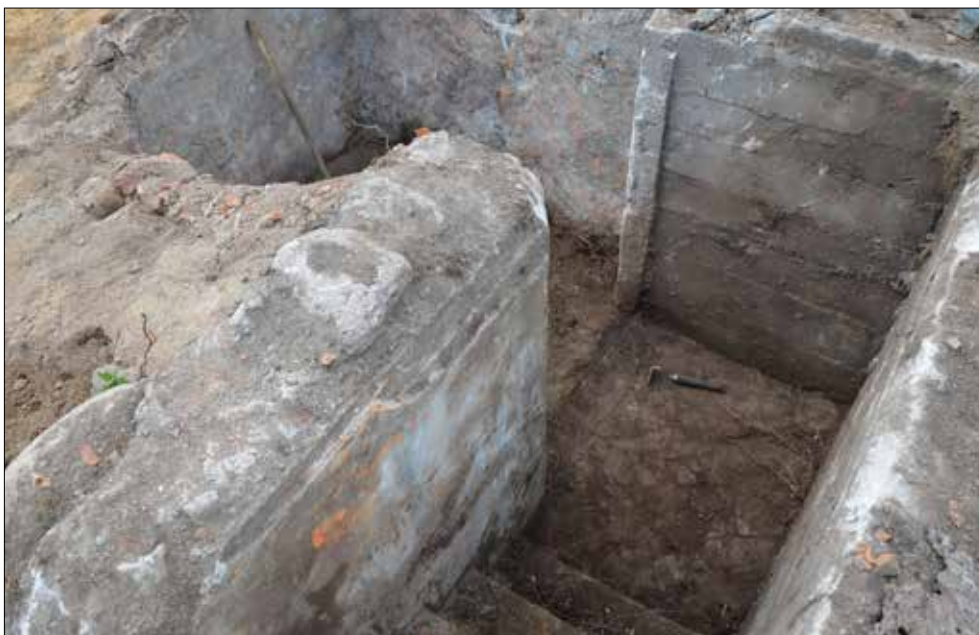
Figur 17–18. Källarutrymmet och källartrappen före och efter tömning. Foto från sydväst av Maria Sjöquist och efteråt från sydost av Mattias Johansson.
