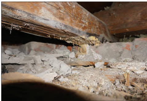
Figur 23. Svamp syns på undersidan av remstycket, i skarven mot teglet.
