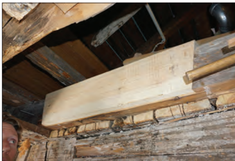
Figur 21. Det nya virket är ipassat.
