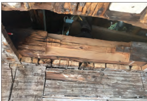
Figur 19. Det skadade trät sågades från två håll. Foto Johannes Pennström.
