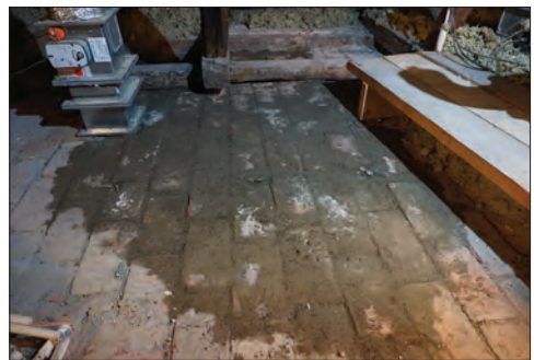
Figur 32. Hela ytan återställd, i väntan på att torka och täckas med isolering.
