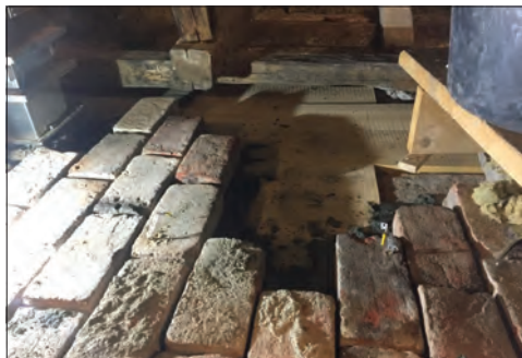
Figur 29. Läggning pågår. Foto Johannes Pennström.
