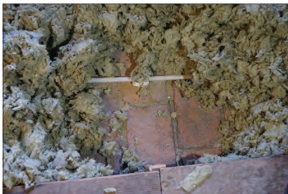
Figur 7. Brandbotten av tegelsten synligt under lösullsisoleringen. Dokumenterat i april 2017.
