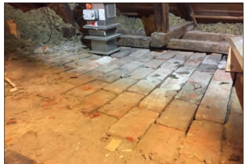
Figur 30. Hela ytan täckt med brandtegel. Foto Johannes Pennström.
