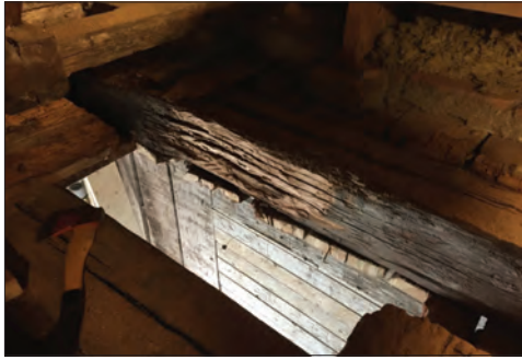
Figur 17. Rötskadat ytträ har buggits bort i viss omfattning. Foto Johannes Pennström.
