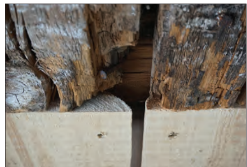
Figur 12. Detalj visar vankant och spår från ramsåg.
