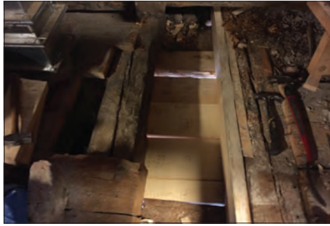
Figur 25. Träläggning av takbrädor (blindbotten) och bjälkar är klart. Foto Johannes Pennström.
