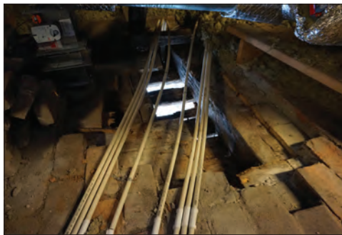
Figur 13. Kabelrör dragna över den i övrigt frilagda ytan.
