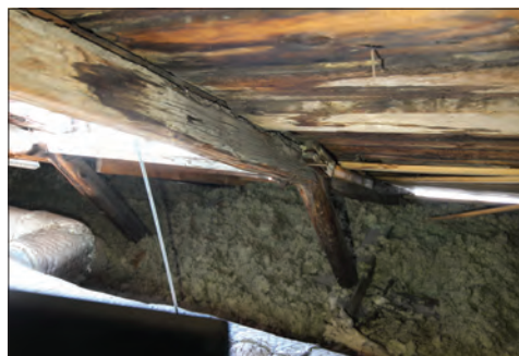
Figur 3. Äldre fuktskada i högben och takpanel i anslutning till den aktuella ytan. Foto Lisa Skanser.
