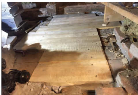
Figur 27. Nytt ramsågat virke över bjälkarna. Foto Johannes Pennström.
