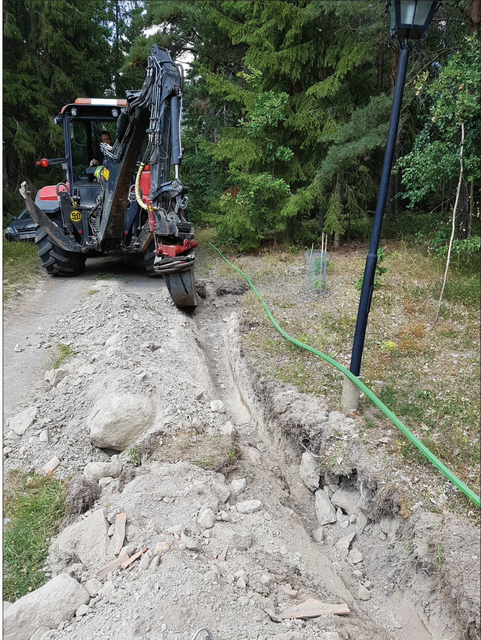
Figur 5. Schaktning i sydöstslutningen inom tomten till Villa Lövdalen. Vy från sydöst.
