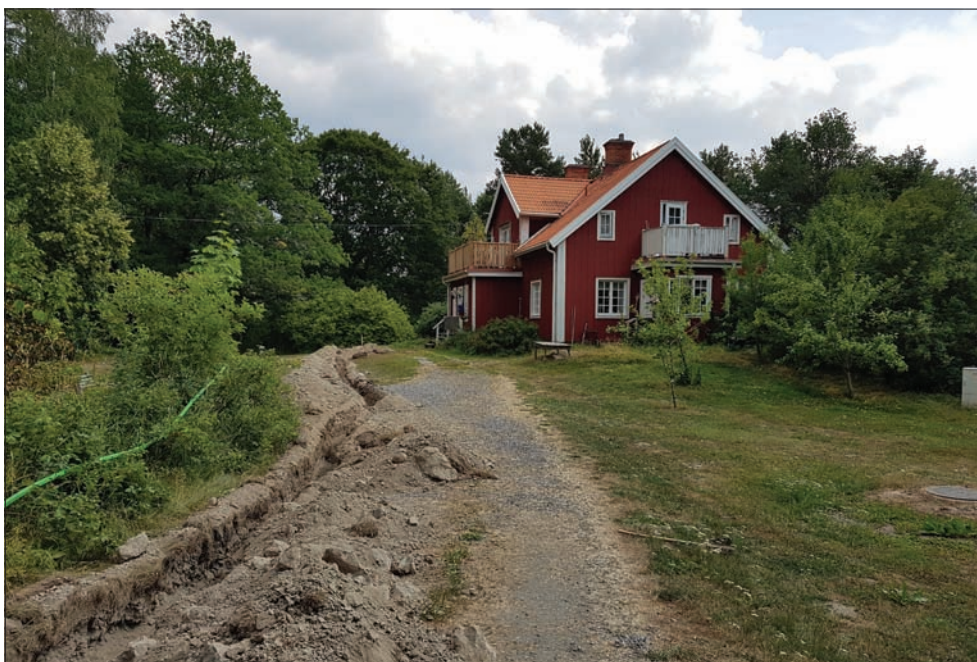
Figur 4. Kabelschaktet grävdes huvudsakligen i omgrävda och påförda lager i den norra kanten på körvägen vid bostadshuset på Villa Lövdalen. Vy från nordväst.
