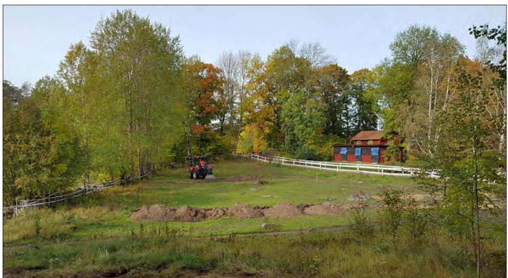
Figur 14. Schakt 12 återfylls. I förgrunden ansas schakt 7. Foto från öster.
