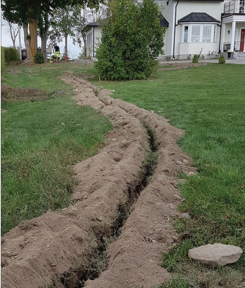
Figur 9. Igenläggning av schakt i den östra delen av Stenta. Foto från sydöst av Reidar Magnusson.
