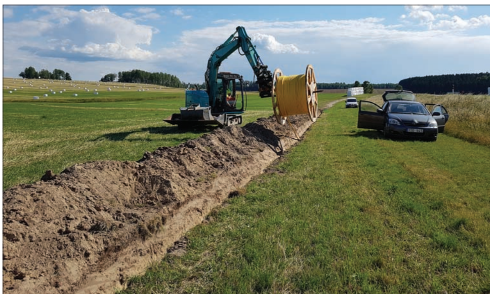
Figur 4. Nedläggning av kabel i den västra åkern, Valla (schakt 1a). Foto från nordöst av Ann Vinberg.
