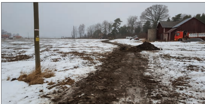
Figur 6. Schaktet vid Vallby 89:1–2, 90:1 och 157:1 sett från söder. Foto Jan Åhlström.
