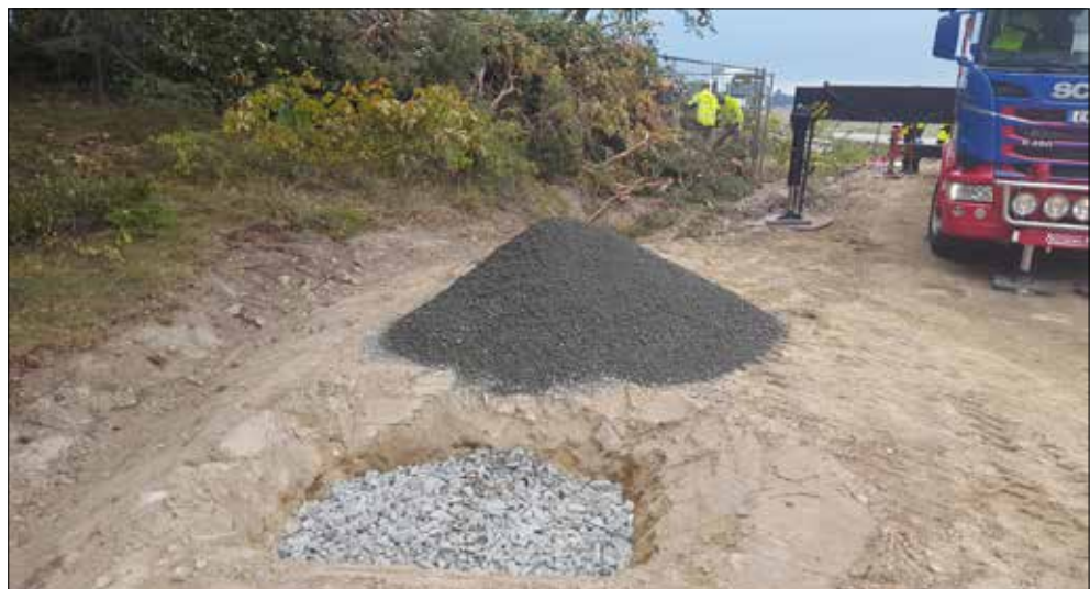
Figur 5. Platsen där runstenen skulle placeras var förberedd av Trafikverkets entreprenör Tranab. I bakgrunden syns två medarbetare från Stenkonservatorn Skanska i färd med att frigöra runstenen. Avståndet mellan de två platserna är 17 meter.
