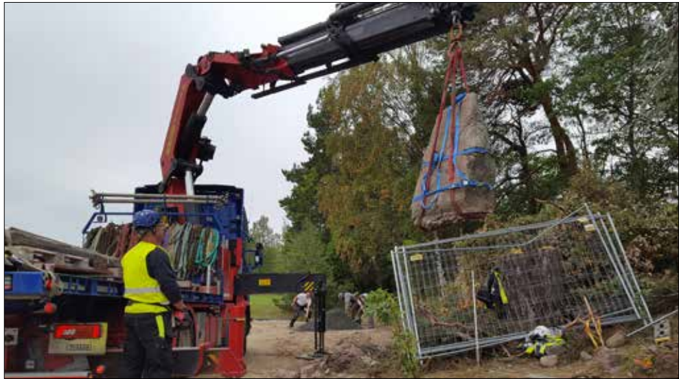
Figur 12. Runstenen är lossad och på väg till sin nya plats (bakom grusbögen).
