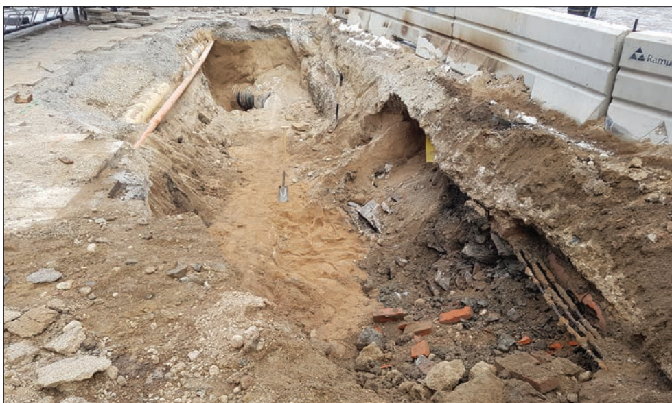
Figur 4. Påbörjad schaktning för VA-ledning i schakt 1. Till höger i bild ses övre delen av utfyllnaden med spruckna block. Övriga delar av schaktet var störda av senare ingrepp. Foto från söder.
