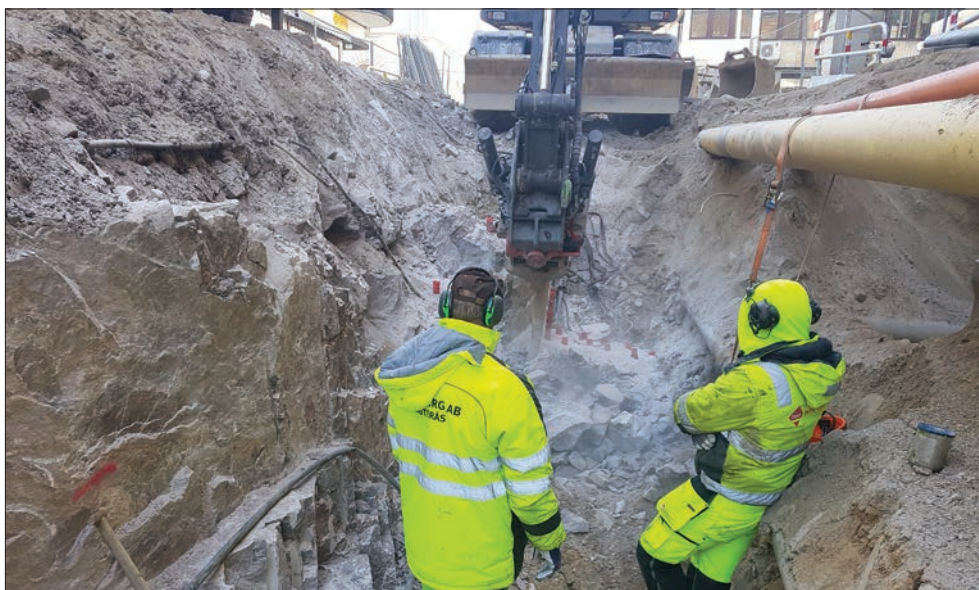
Figur 5. Schakt 1 från norr. I schakten uppnåddes berggrunden som fick borrar bort. Foto från norr.
