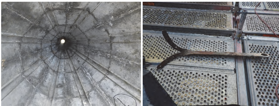
Figur 38. Inne i huven syns spåren efter hur delarna är sammanlödda. Figur 39. Infästningsjärn.
