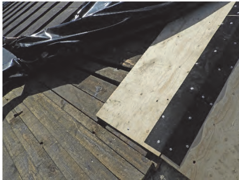
Figur 14. Nedre delen av baksidans undertak var bytt sedan tidigare, högre upp anas det äldre undertaket med glesare lagd underlagspanel.
