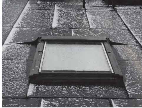
Figur 56. De moderna takfönstren läckte och hade därmed blivit mjölkeiga på insidan.
