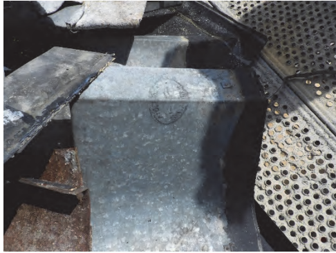
Figur 10. Befintlig plåt stämplad med Stockholms galvaniseringsfabrik.
