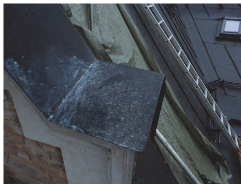
Figur 62. Tak före åtgärder. Skorstenen till höger i bild var inte helt plåtinklädd.
