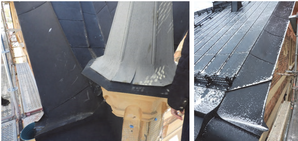
Figur 20. Avtäckning över gavlarna före åtgärder.
