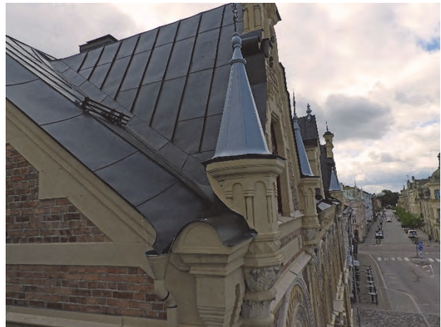
Figur 44. Lagningar i nedre del av huv. Foto: Lennart Holmström.
