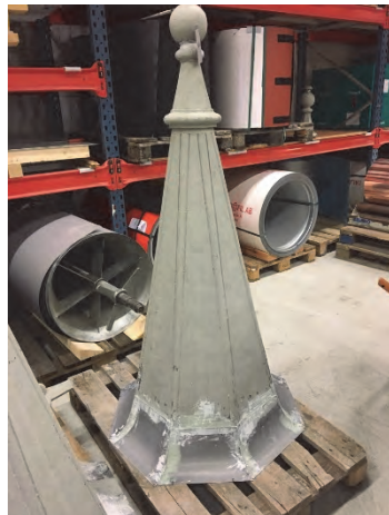
Figur 44. Lagningar i nedre del av huv. Foto: Lennart Holmström.
