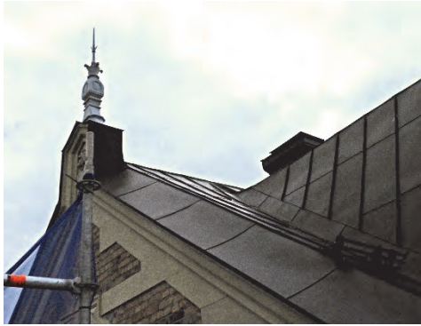
Figur 46. Återmonterad takryttare.
