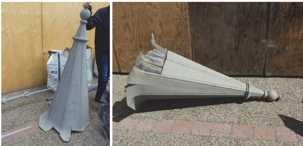
Figur 36. Nedre delen med avslagna delar av zinkplåten. Figur 37. Skador i nedre delen av huven.
