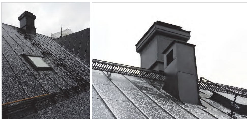
Figur 26. Snörasskydd och stegar på takfallet mot gatan.
