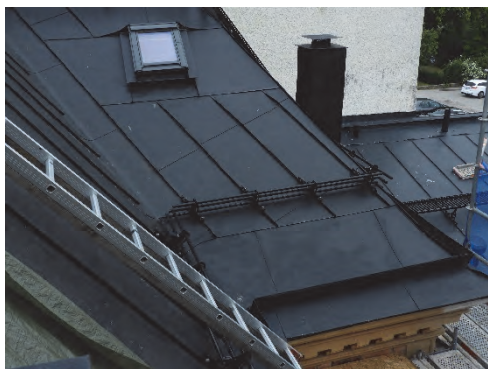
Figur 64. Tak efter åtgärder. Helt plåtinklädd skorsten.
