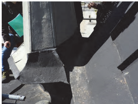
Figur 32. Tidigare lagningar vid buvar.
