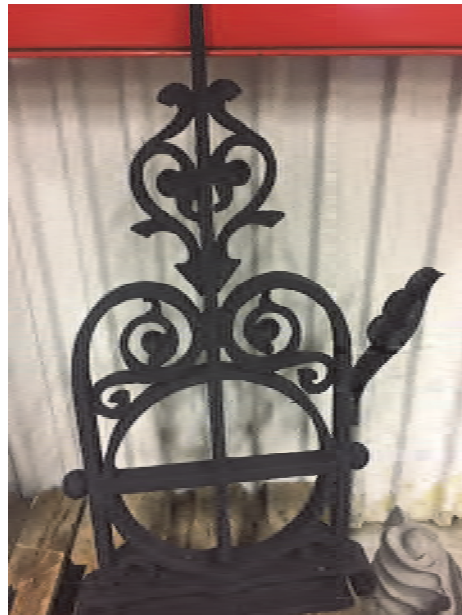
Figur 50. Några smidesdetaljer saknades sedan tidigare. Ingen komplettering av dessa gjordes. Foto: Plåt-Lars AB.
