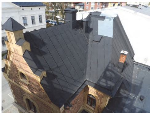
Figur 62. Tak före åtgärder. Skorstenen till höger i bild var inte helt plåtinklädd.
