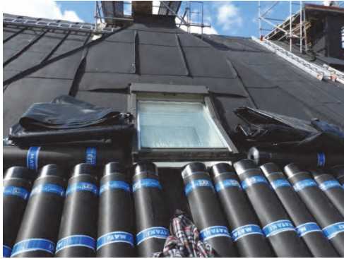
Figur 56. De moderna takfönstren läckte och hade därmed blivit mjölkeiga på insidan.
