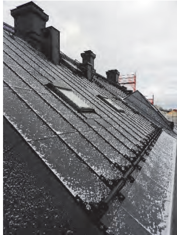
Figur 22. Omtäckt takfall mot gården.
