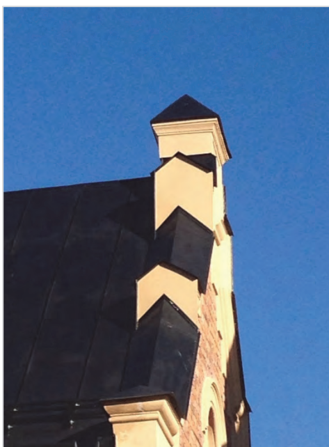
Figur 68. Plåttäckningen på de stående putsytorna har målats i samma gula kulör som putsen. Foto: Lennart Holmström.
