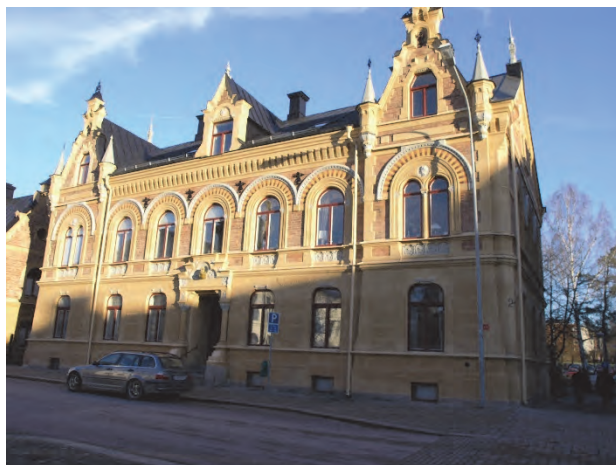
Figur 4. Apoteksbuset efter renoveringen 2006.
