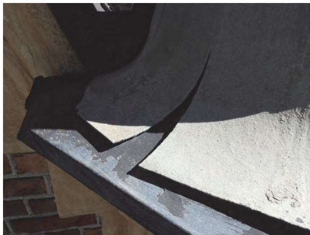
Figur 30. Huv före nedmontering sommaren 2017. Nedre delen spricker upp i skarvarna, där den vilar på turellen.
