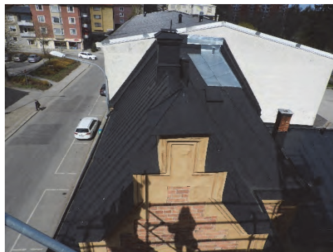
Figur 62. Tak före åtgärder. Skorstenen till höger i bild var inte helt plåtinklädd.
