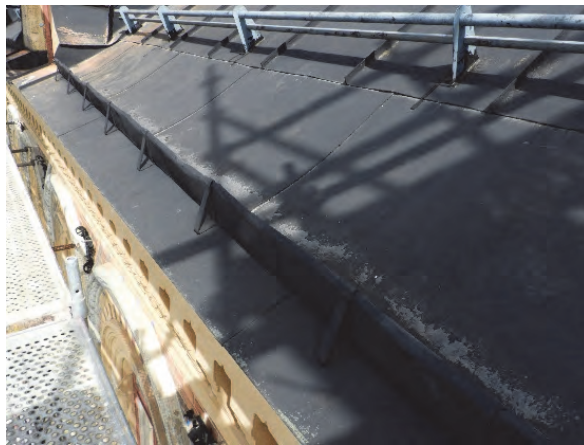
Figur 24. Befintligt snörasskydd monterat genom plåten.
