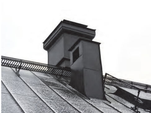
Figur 60. Skorsten, befintlig ventilationshuv och tak efter åtgärder (gårdssidan).
