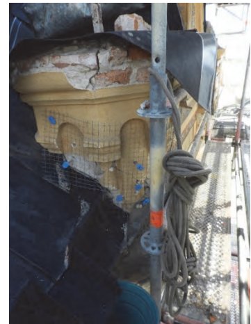
Figur 43. Den södra takkupans norra turell har sprickebildningar och upplevs sitta delvis löst.
