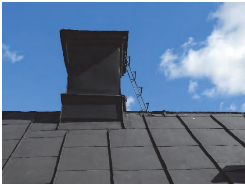
Figur 58. Skorsten och tak före åtgärder (gatusidan).
