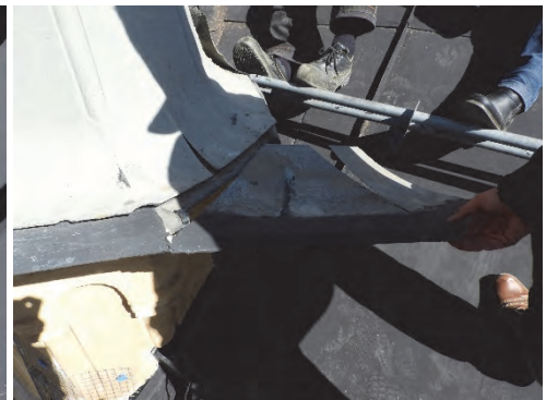
Figur 33. Tidigare lagning bestående av en inskjuten plåt under buven.
