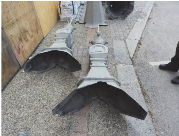
Figur 42. Gavelspetsarnas takryttare är i relativt gott skick.
