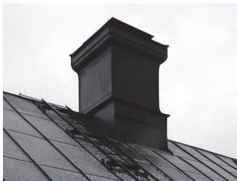
Figur 60. Skorsten, befintlig ventilationshuv och tak efter åtgärder (gårdssidan).
