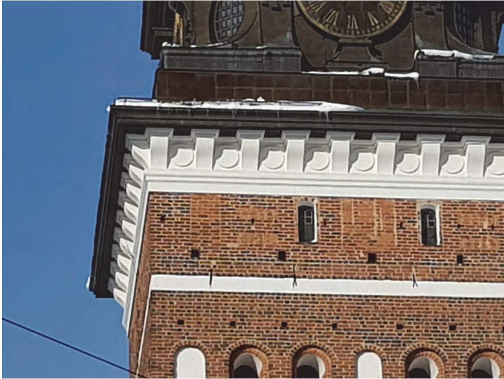
Figur 15. Snörasskyddet fångar upp snömassorna effektivt. Foto: Helén Sjökvist.
