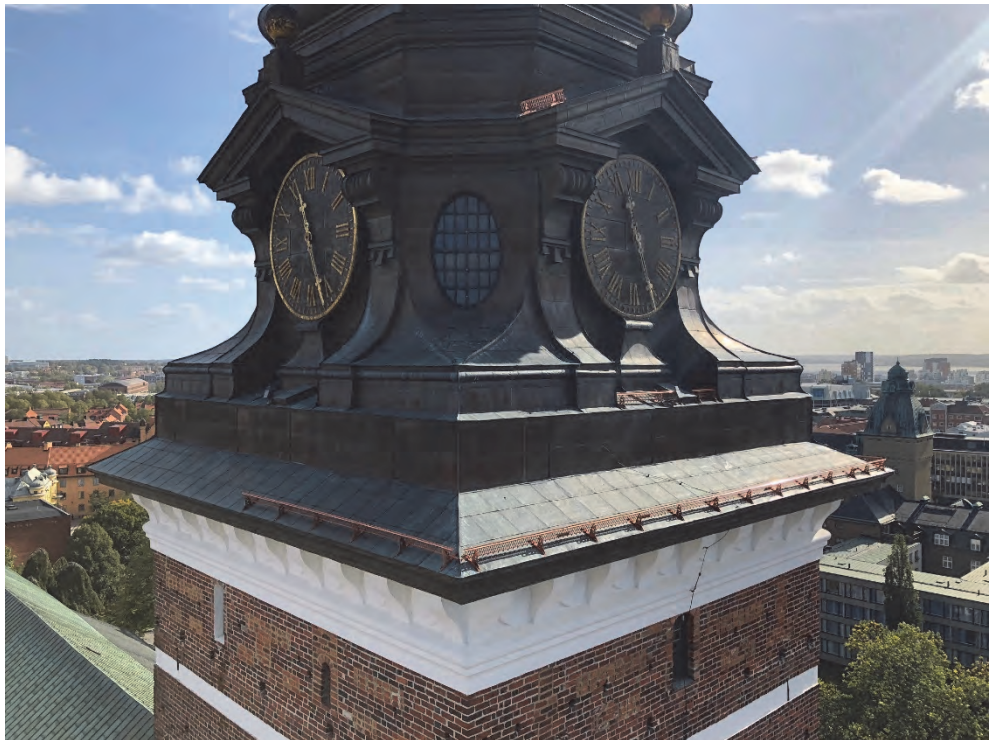
Figur 12. Monterat snörasskydd, översikt från nordväst. Foto: Västerås Byggplåt AB.
