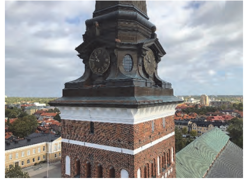
Figur 11. Monterat snörasskydd, översikt från sydväst. Foto: Västerås Byggplåt AB.
