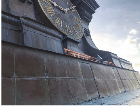
Figur 10. Iskratta under klocka. Foto: Västerås Byggplåt AB.
