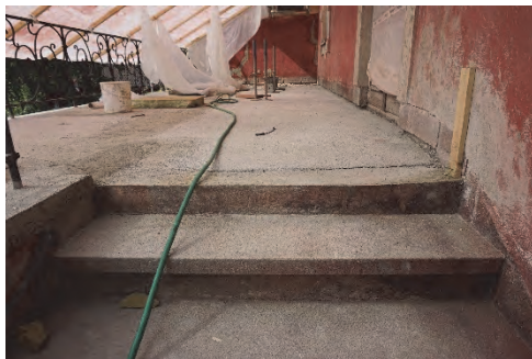
Figur 28. Avjämnning inför stenläggning.
