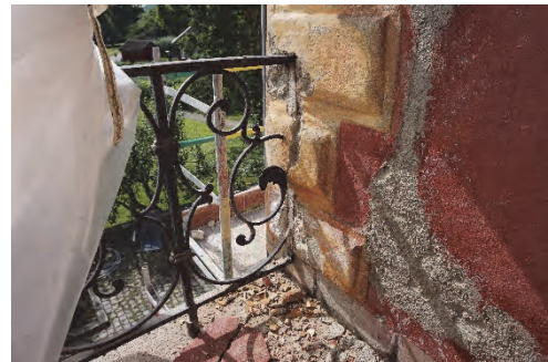
Figur 25. Övre sättsteg har varit fastlimmat med epoxylim. I mellanrummet mellan epoxyyta och svart tätskikt har fukt kommit in.
