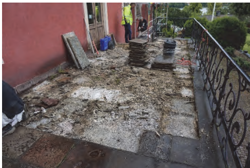
Figur 20. Kalkstensplattorna läg i ett lager sättsand.
