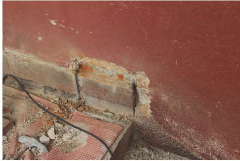
Figur 24. Försök att lossa sockelsten från bakomliggande cementbaserade sättbruk.
