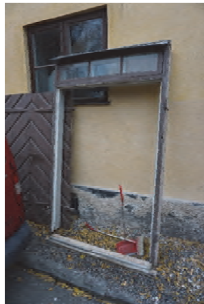
Figur 52. Dörrbladen och karmen, inklusive överljusfönster, har demonterats och sparats.
