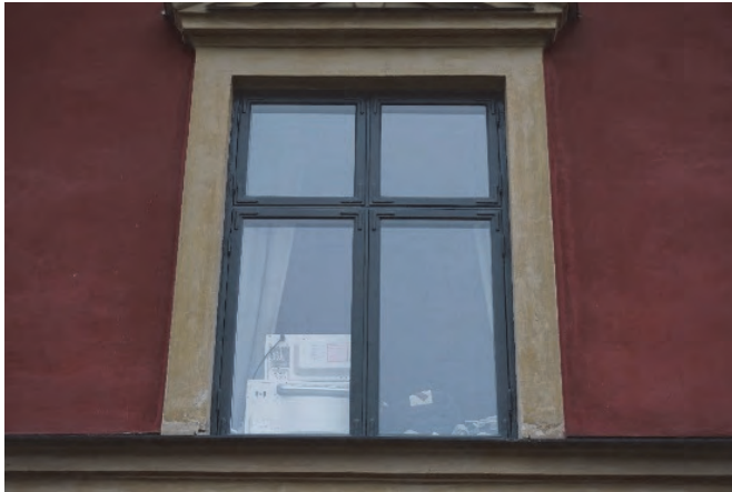
Figur 46. Åtgärdat fönster med ny kromoxidgrön färgställning.
