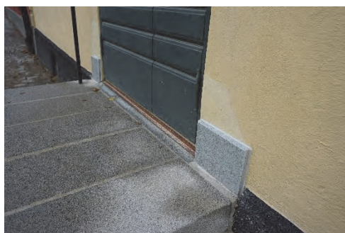
Figur 70. Nya sockelstenar i granit.
