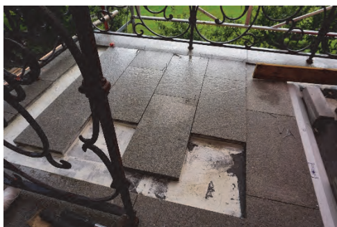
Figur 30. Påbörjadläggning av granit.
