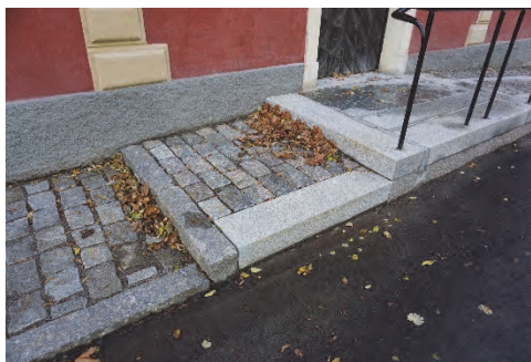
Figur 76. Tidigare befintlig anslutning mot omfattningens sockelsten Figur 77. Nytt plan mellan trappans vilplan och dörren utförd i granit.
