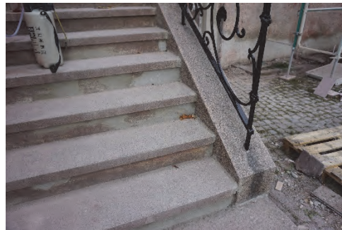
Figur 35. Lagning av sättsteg i trappa samt omläggning av plansteg.
