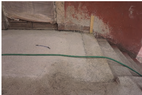
Figur 26. Nytt avjämnande skikt under stenläggningen.
