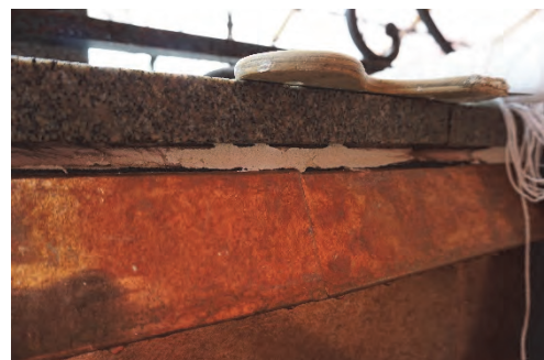
Figur 29. Nya stosar till infästningen av räcket utfördes med samma princip som använts tidigare.
