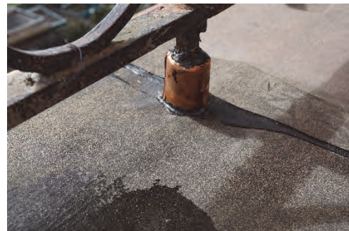
Figur 29. Nya stosar till infästningen av räcket utfördes med samma princip som använts tidigare.
