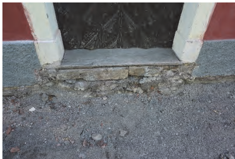
Figur 74. Pågående arbeten. Tidigare plan av ek mellan trappa och dörr. Figur 75. Befintlig trappa borttagen.
