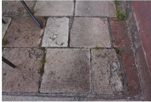
Figur 17. Terrassens fogning var i mycket dåligt skick vilket ledde till att fukt trängt ner i konstruktionen och kalkstensens ytskikt spjälkades loss.
