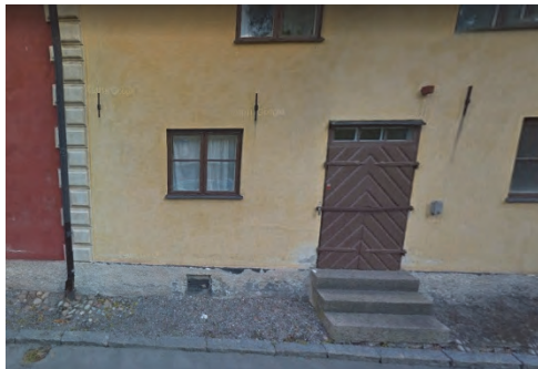
Figur 58. Trottoar vid tiondeboden före åtgärder.
