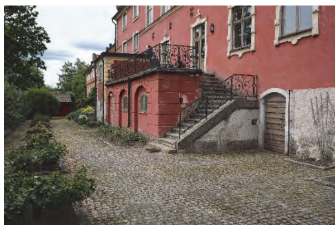
Figur 12. Terrassen före åtgärder.
