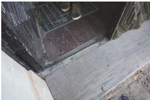
Figur 74. Pågående arbeten. Tidigare plan av ek mellan trappa och dörr. Figur 75. Befintlig trappa borttagen.
