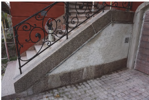
Figur 36. Stödmuren är ompputsad.
