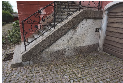
Figur 17. Terrassens fogning var i mycket dåligt skick vilket ledde till att fukt trängt ner i konstruktionen och kalkstensens ytskikt spjälkades loss.
