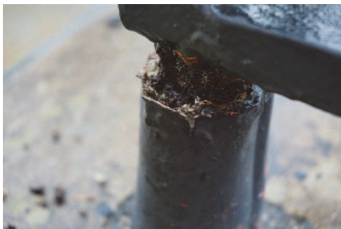
Figur 22. Räcket var monterat med stosar i koppar som fyllts med kitt.
