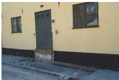
Figur 68. Tidigare trappa demonterad.
