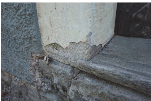
Figur 76. Tidigare befintlig anslutning mot omfattningens sockelsten Figur 77. Nytt plan mellan trappans vilplan och dörren utförd i granit.
