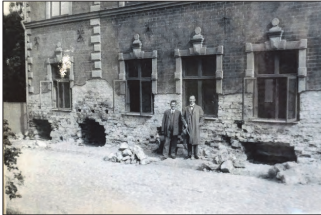
Figur 7. Pågående renovering 1929. Foto Å. Noréen. ATA.
