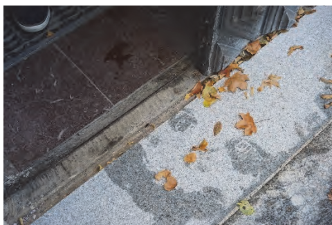
Figur 76. Tidigare befintlig anslutning mot omfattningens sockelsten Figur 77. Nytt plan mellan trappans vilplan och dörren utförd i granit.
