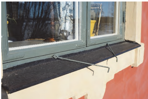
Figur 48. Åtgärdat fönster med ny kromoxidgrön färgställning.
