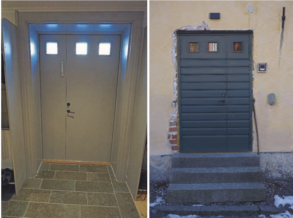
Figur 54. Ny dörr sedd från hallen.
