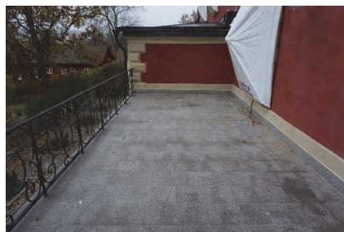
Figur 39. Ny putslist över stensockeln anfärgades i samma kulör som övriga listverk.
