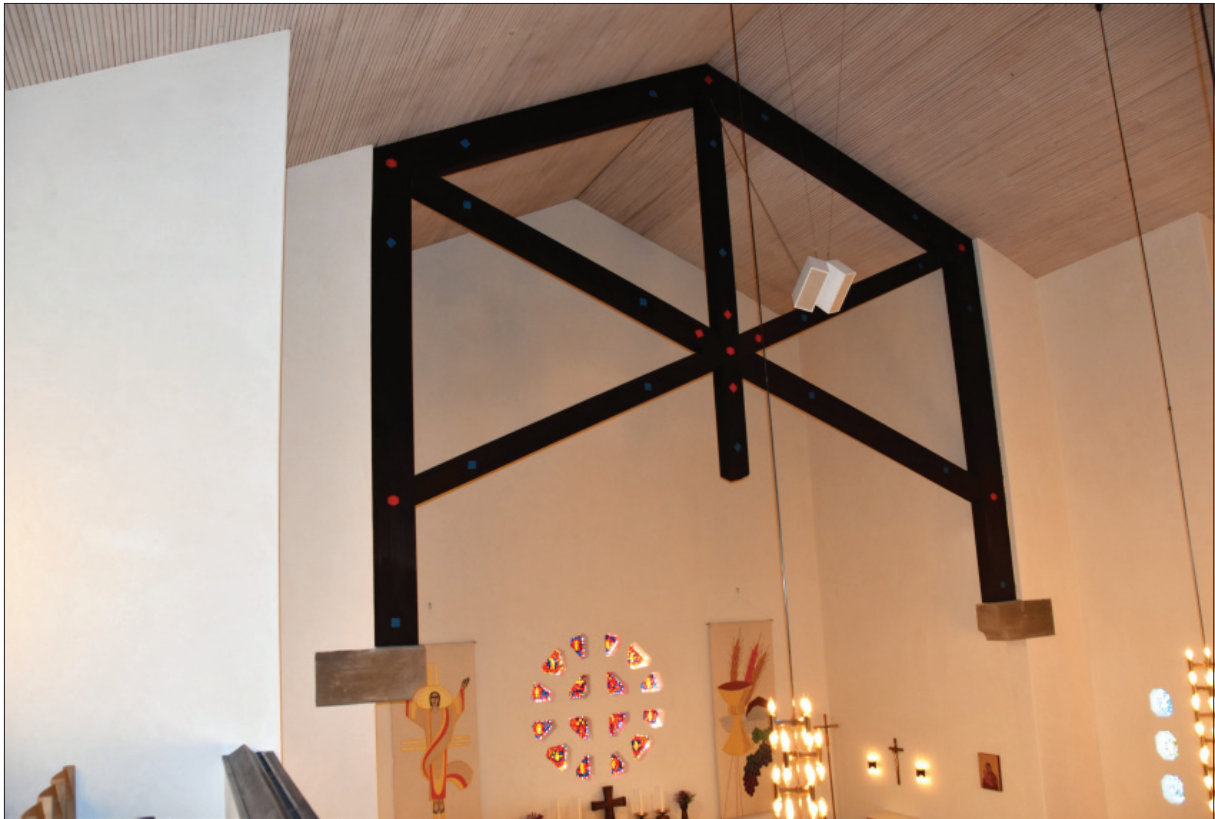
Figur 11. Slutbesiktning den 14 maj 2019. Utsikt mot koret. Väggarna är efter renovering ljusa och fräscha med en svagt glittrande yta som är svår att förmedla på bild.
