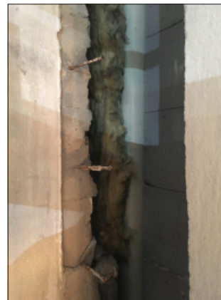
Figur 7. Slits upptagen vid stuprör. Foto Leif Göttberg.
