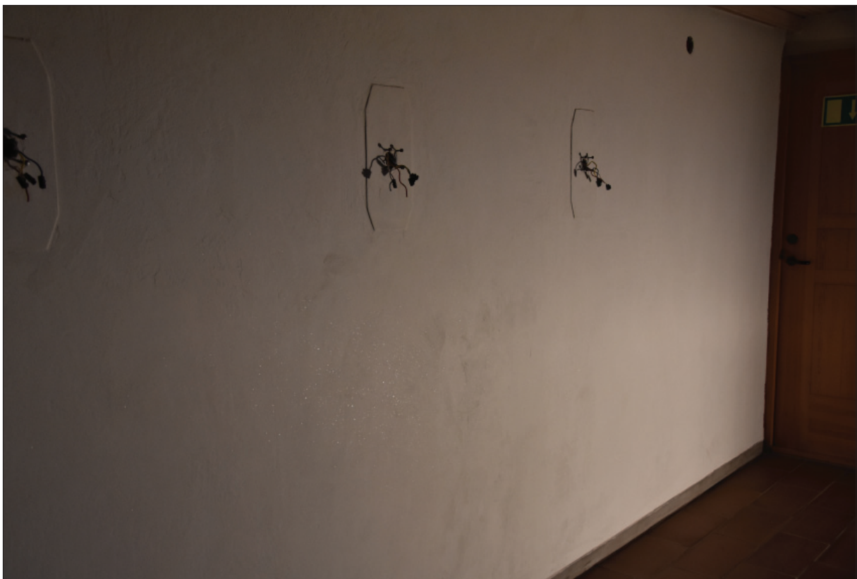
Figur 10. Detalj av norra väggen under sidoläktaren, efter åtgärd. Om man tittar noga ser man hur väggen glimmar.
