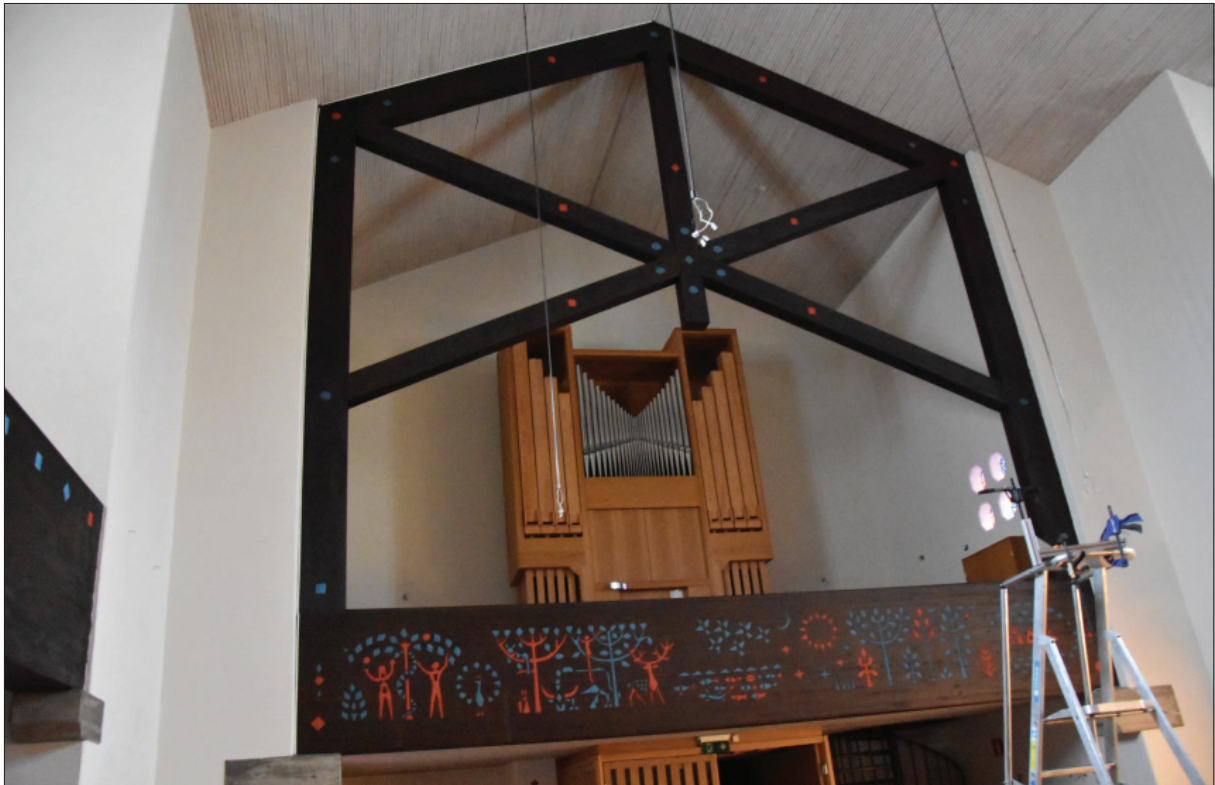
Figur 9. Byggmöte i mars 2019, takarmatur och övrig belysning är nedmonterad för rengöring och omkabling. Väggarna är åtgärdade.
