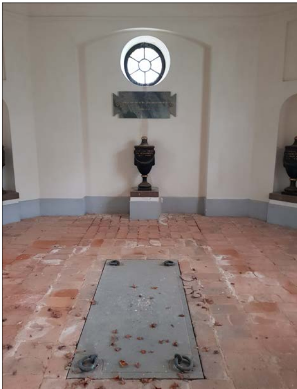
Figur 5–6. Gravkorets interiör som det såg ut hösten 2018. Kapellet's kalkstenshäll kom på plats under 1920-talet. Tidigare fanns en lucka av trä. I gravkoret anordnades ett kolumbarium för askurnor på 1920-talet. Det utsökta kupolvalvet är åttakantigt.
