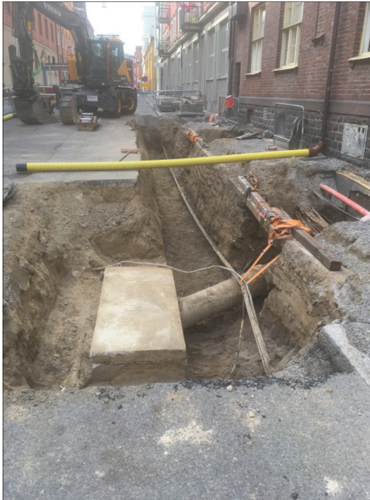
Figur 3. Schaktet. Foto från norr.
