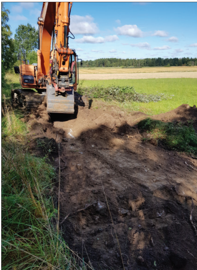
Figur 5. Schakt 2, arbete pågår. Foto från öster.
