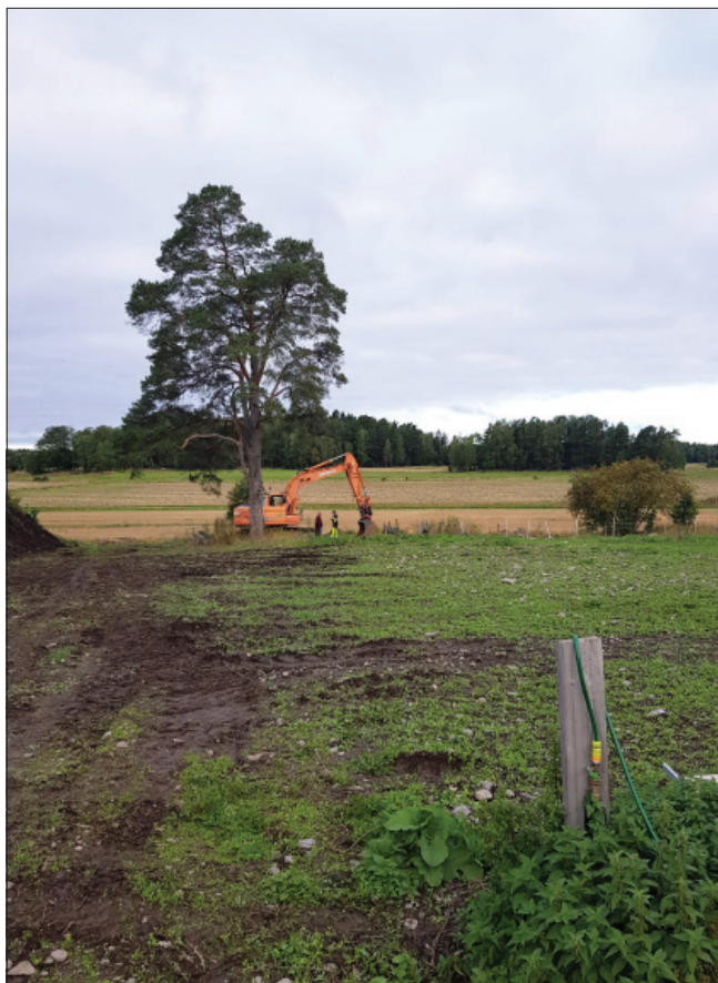
Figur 3. Sträckan för ledningsdragning vid schakt 1. Foto från öster.
