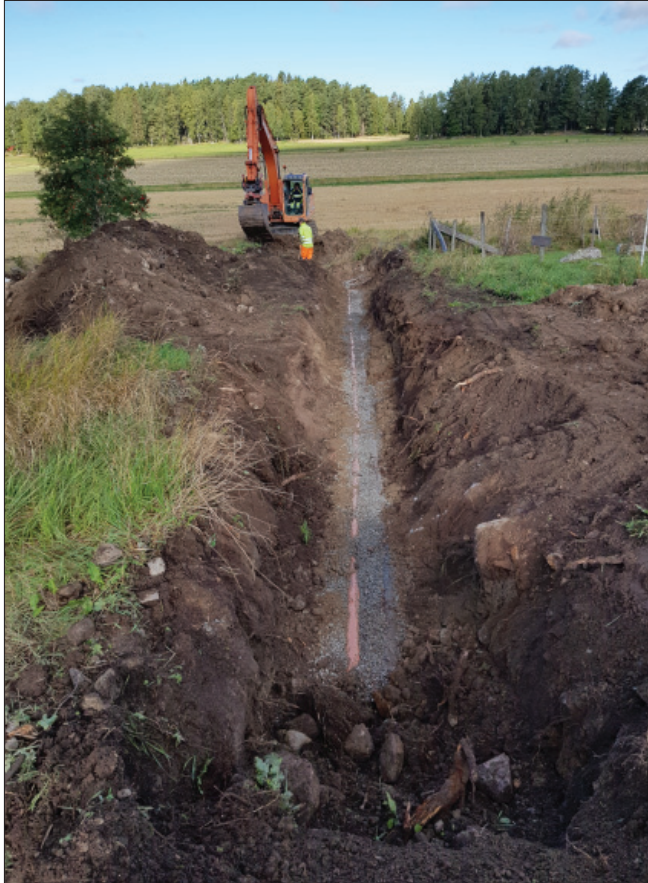
Figur 4. Schakt 1 med befintlig avloppsledning synlig i botten. Foto från öster.
