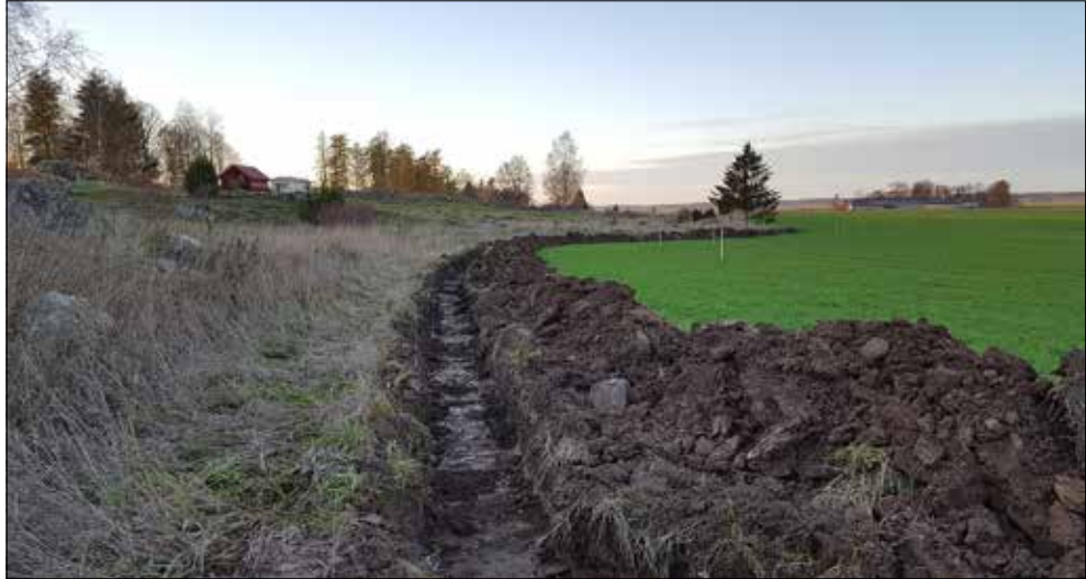
Figur 6. Schakt 3 i åkermarken. Gravfältet Tillberga 8:1 och bytomten Tillberga 78:1 i hagmarken. Foto från sydost.
