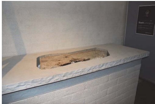
Figur 86. Altaret uppmurat och äldre sten inlagt i urtag i den nya stenslivan. Figur 87. Skiva med inlagt stenfragment.
