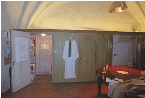
Figur 32. Skåpsektion utefter södra väggen före åtgärder.
