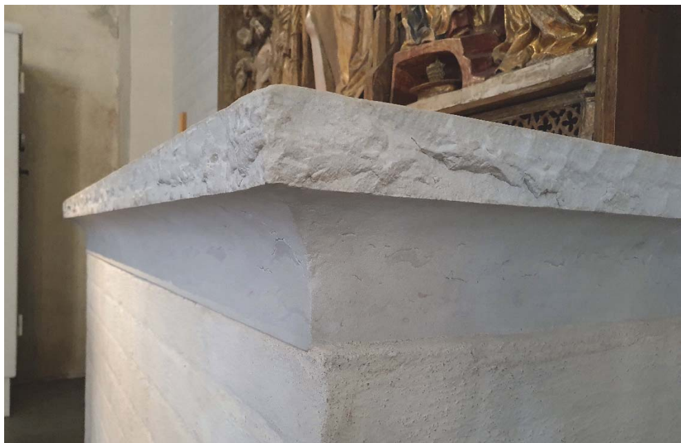
Figur 88. Kanten på den nya stenslivan med hälkäl som motsvaras av formen på den äldre, infällda stenen. Foto: Johan Sohlberg.
