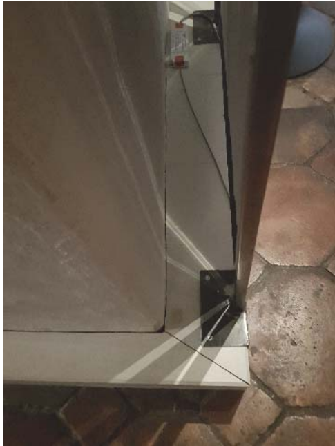
Figur 65. Träsockeln döljer eldragningar, men kan även användas för infästning av stativ för vepor. Figur 66. Fönstret var sedan tidigare försett med galler för att höja säkerheten. Foto: Johan Soblberg.
