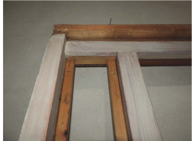
Figur 42. Dörrpartiets karm efter demontering, sett från "baksidan" vitlaserad karm.
