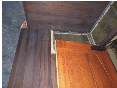
Figur 8. Vindfångets vägg flyttad. Staget kvar på befintlig plats i murverket.
