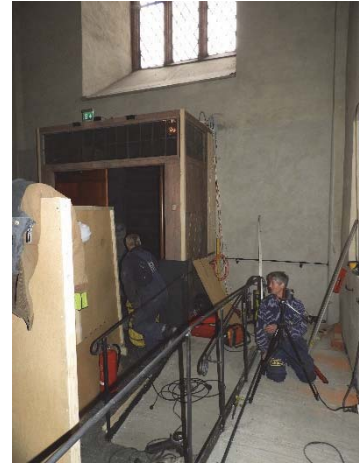
Figur 13. Trappan och det låga murpartiet har delvis kapats för att ge plats åt rampen. Figur 14. Arbete pågår med rampen.
