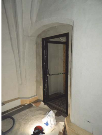
Figur 52. Inpassning av nytt dörrparti i öppning i sydöst.
