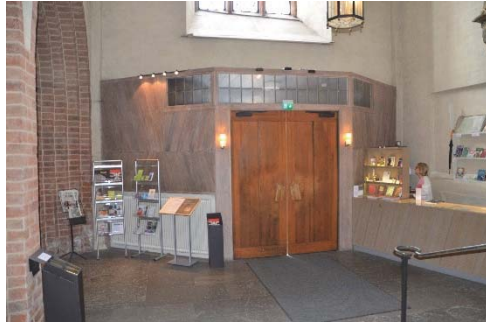
Figur 3. Vindfånget före arbetets påbörjande.
