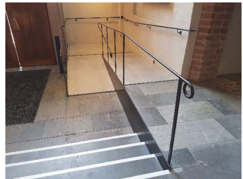
Figur 15. Detalj av linoljebränt räcke. Figur 16. Det nya räcket tar upp former från andra liknande räcken från Lundbergs renovering.
