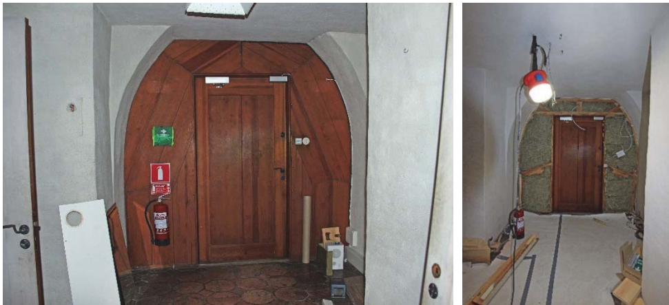
Figur 57. Dörrpartiet mot öster före åtgärder.
