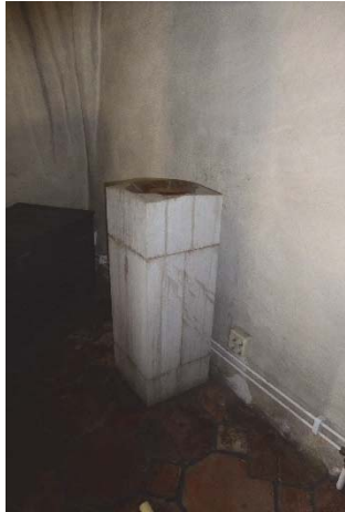
Figur 30. Piscinans placering före åtgärder.
