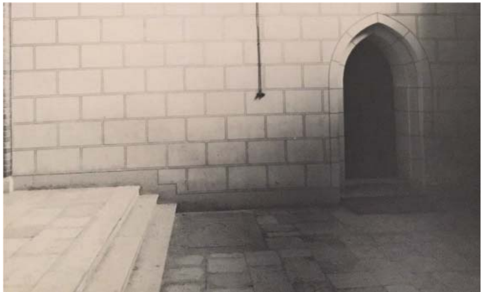
Figur 2. Södra vapenhusväggen efter Lindegrens renovering.
