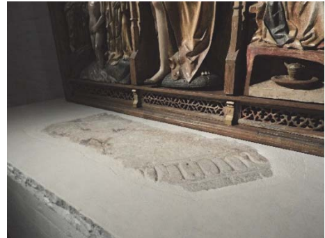
Figur 86. Altaret uppmurat och äldre sten inlagt i urtag i den nya stenslivan. Figur 87. Skiva med inlagt stenfragment.
