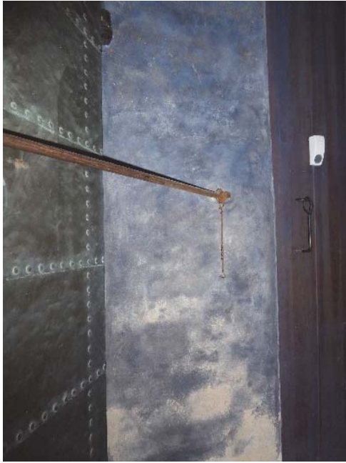
Figur 7. Putsad väggyta inne i vindfångets norra del före åtgärder- infästning av låsning med metallstag.
