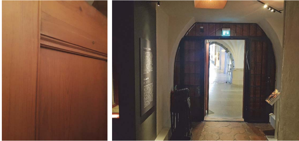
Figur 61. Dörrbladet har behandlats med brandskyddsfärg utan någon nämnvärd utseendemässig förändring.
