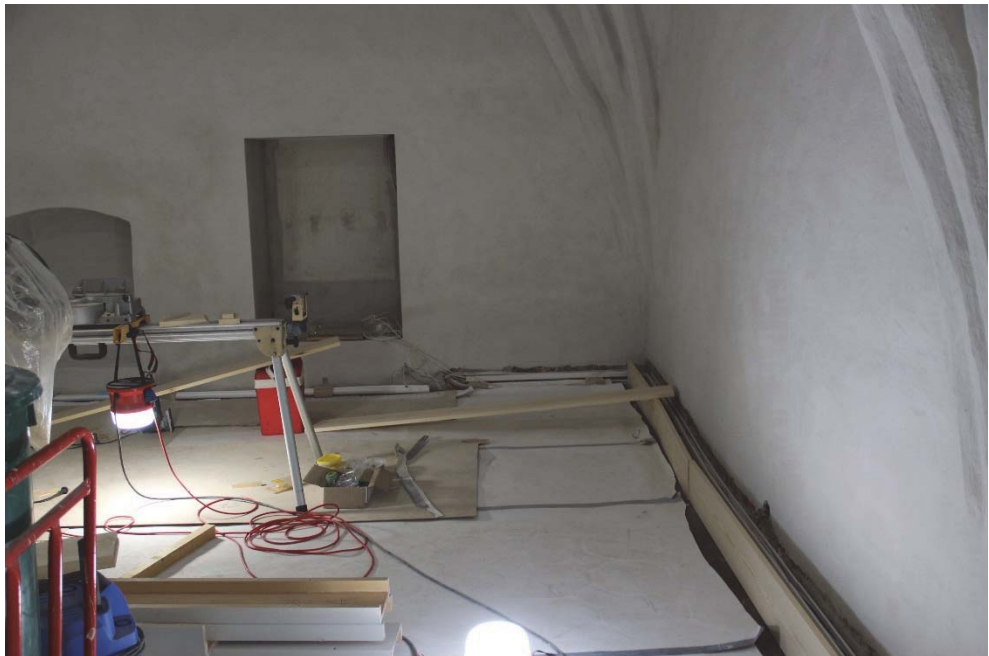
Figur 56. Åtgärdad puts och laverade väggar. Sydvästra hörnet.
