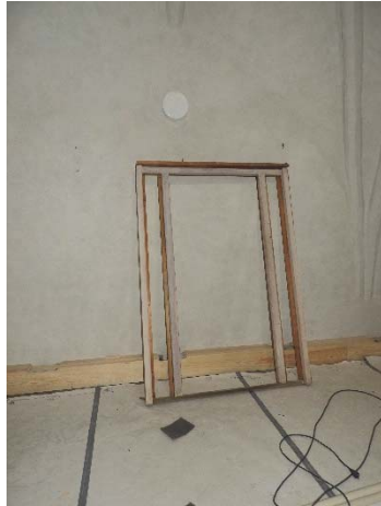
Figur 42. Dörrpartiets karm efter demontering, sett från "baksidan" vitlaserad karm.
