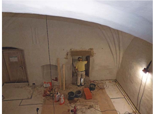
Figur 52. Inpassning av nytt dörrparti i öppning i sydöst.
