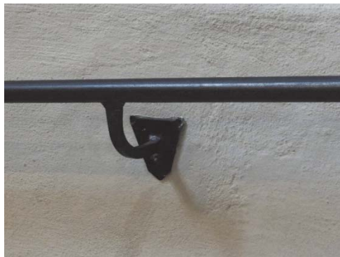
Figur 15. Detalj av linoljebränt räcke. Figur 16. Det nya räcket tar upp former från andra liknande räcken från Lundbergs renovering.
