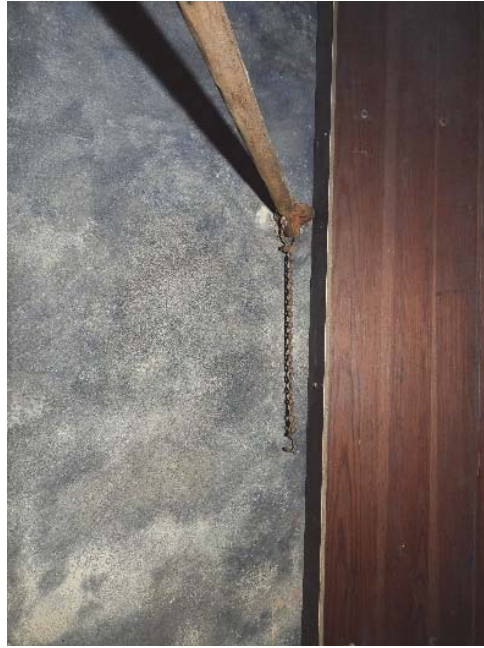
Figur 7. Putsad väggyta inne i vindfångets norra del före åtgärder- infästning av låsning med metallstag.
