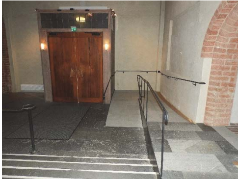
Figur 19. Vindfånget efter färdigställande.
