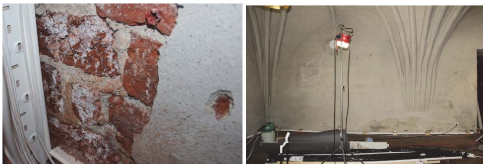
Figur 48. Saltutfällningar i murverk,
