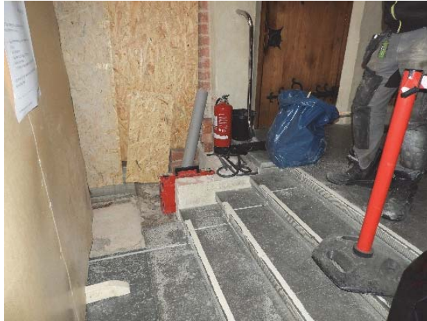
Figur 13. Trappan och det låga murpartiet har delvis kapats för att ge plats åt rampen. Figur 14. Arbete pågår med rampen.
