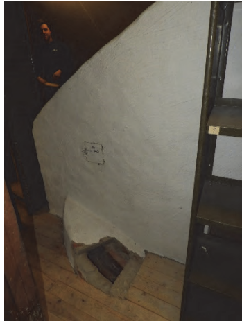
Figur 117. Västra delen av murstocken, upptagen öppning för att kontrollera kanaler inför projektering.
