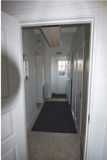
Figur 52. Passagen före åtgärder
