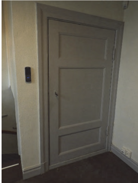
Figur 74. Vindsdörren försågs med ett kortläsare som kopplades till magnetkontakten för att kunna behålla befintlig äldre läskista.
