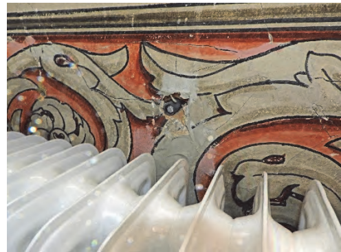
Figur 92. Bultarna från de tidigare radiatorerna kapades och lämnades kvar.
