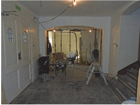
Figur 21. Stickbågigt valv friställt, sett mot väster.
