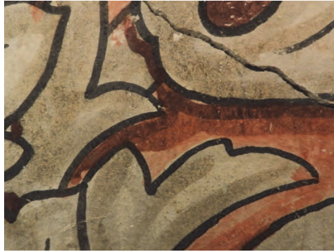
Figur 89. Exempel på sprickbildning som krävde infästning.
