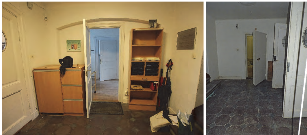
Figur 19. Mellan rum 3101 och 3102 var den stickbågiga öppningen igensatt, sett mot väster.
