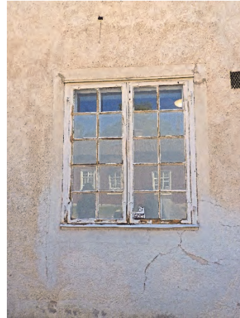
Figur 161. Pågående skrapning inför ommålning av fönster. Norra fasaden.
