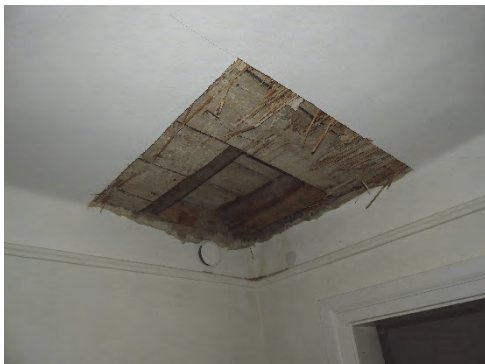
Figur 34. Håltagning i samband med bjälklagsundersökning.
