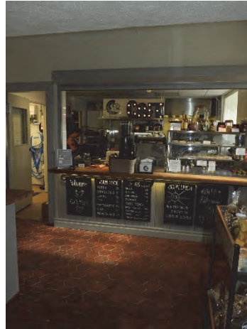
Figur 70. Cafékök med modernt undertak på bärverk och kalklade väggar.
