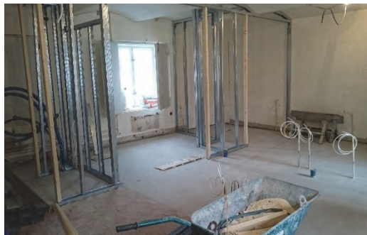
Figur 66. Metallreglar för ny rumsindelning, nordöstra hörnet. Foto: Johan Soblberg.
