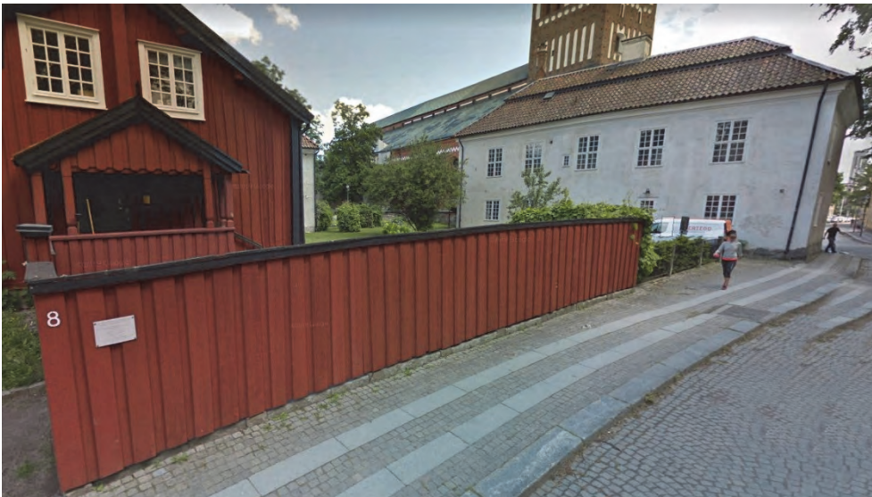
Figur 186. Staketets utsträckning före åtgärder. Källa: Google maps.
