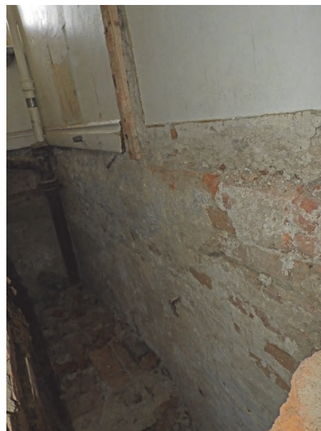
Figur 82. Inga spår av någon äldre trappa. Murat tegel vid pilen är delar av kassavalsmurningen.
