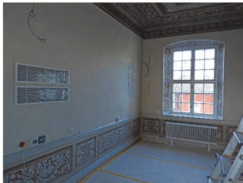
Figur 93. Nya galler för ventilation är placerade där det fanns en äldre igensättning efter en öppen spis.
