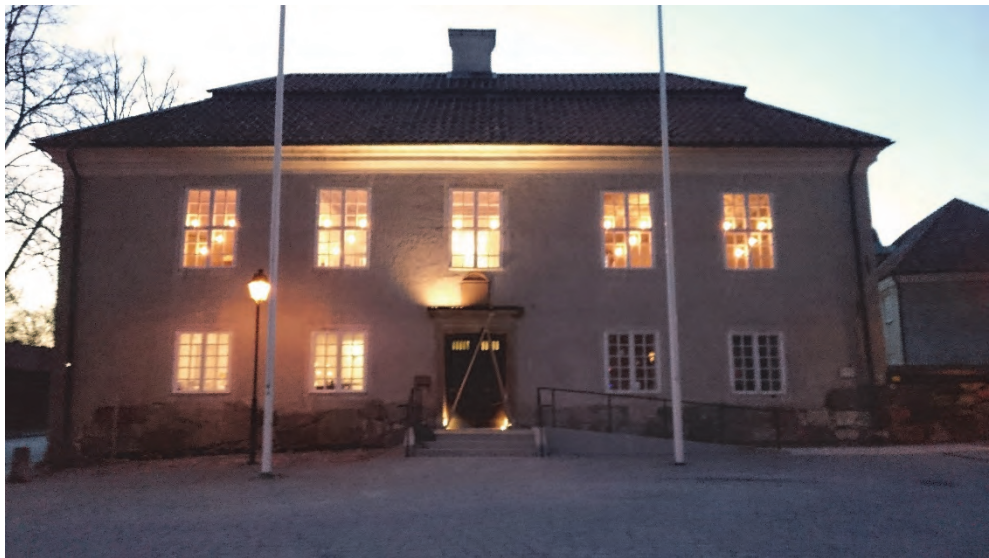
Figur 209. Arbete med fasadbelysning. Foto: Johan Sohlberg.
