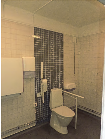
Figur 42. Nyinredd toalett. Takets form bevarat. Klamrad kulokabel i tak.
