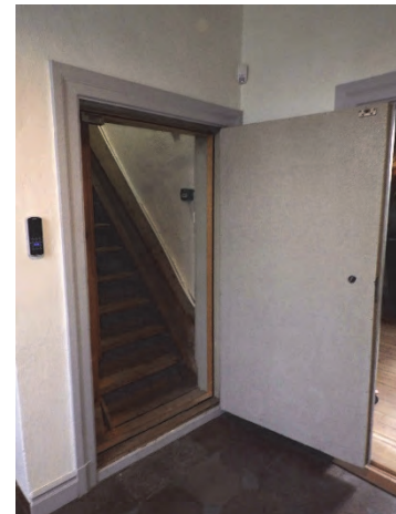
Figur 77. En ny skiva har satts på baksidan av dörren. På denna har även magnetkontakten placerats.
