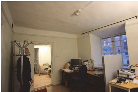
Figur 32. Rummet sett mot sydöst inför arbetets påbörjande.
