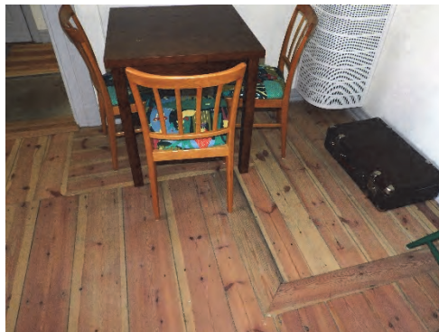
Figur 50. Golvet är lagat och oljevaxbehandlat.
