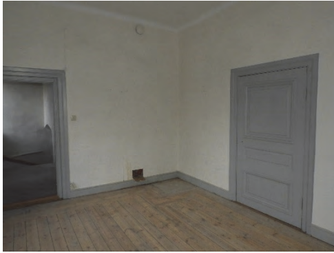
Figur 111. Trägolvet har tagits fram.
