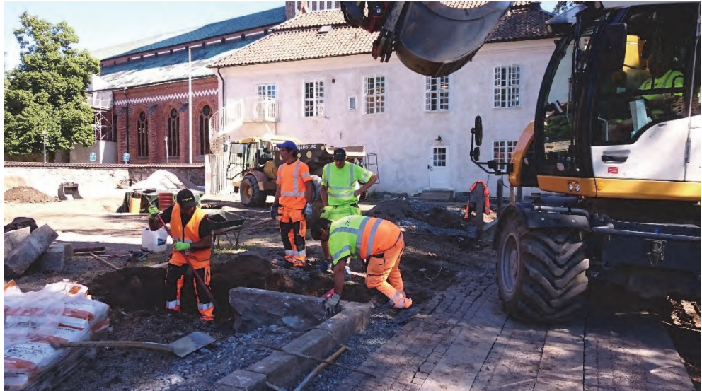
Figur 201. Pågående arbete med stenram för staketet. Foto: Johan Soblberg.
