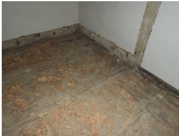
Figur 38. Bjälklagsfyllning med träflis mm, rummets nordvästra hörn.
