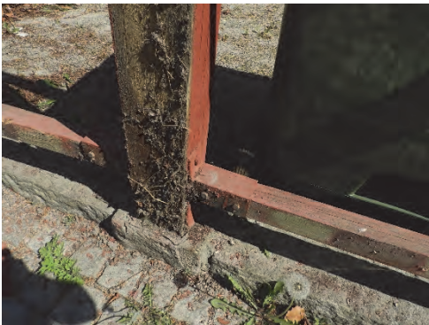
Figur 197. Montering mot sten med vinkeljärn.
