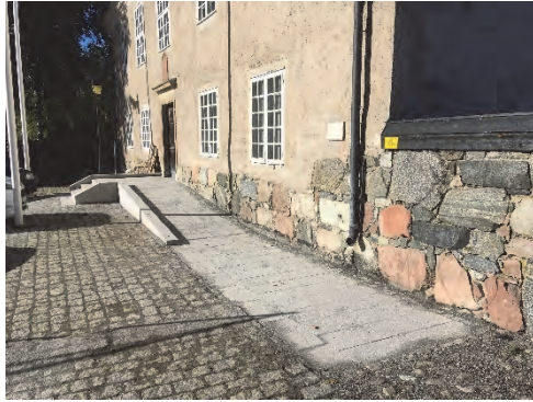
Figur 155. Ny ramp under uppbyggnad.
