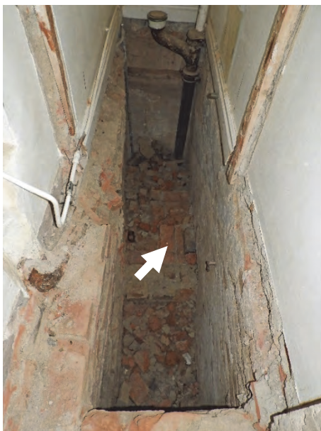
Figur 82. Inga spår av någon äldre trappa. Murat tegel vid pilen är delar av kassavalsmurningen.
