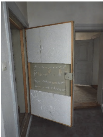
Figur 72. Dörren till vinden var sedan tidigare isolerad på baksidan med frigolitskivor.
