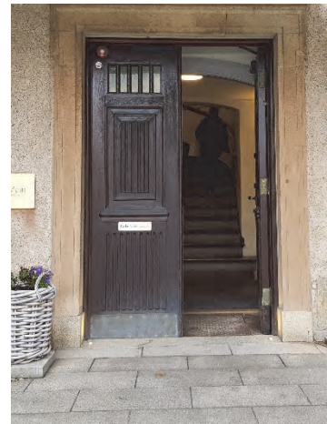
Figur 158. Dörrpartiet efter genomförda åtgärder. Blixtljus för räddningstjänsten uppe till vänster.
