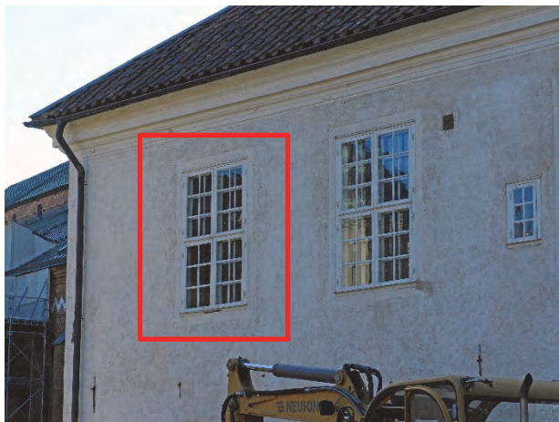
Figur 135. Befintligt fönster med inåtgående innerbåge och utåtgående ytterbåge.
