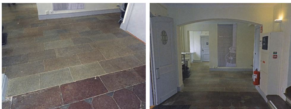
Figur 29. Anslutning mellan nytt och gammalt kalkstengolv.
