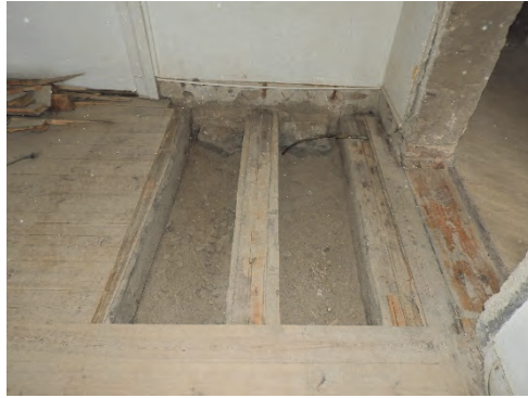
Figur 36. Golvet öppnat i läget för hissen för bjälklagsundersökning.
