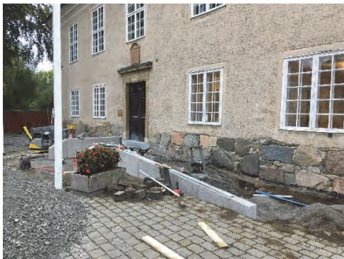
Figur 153. Ny ramp och trappa under uppbyggnad.
