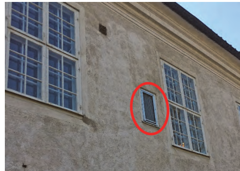
Figur 160. Fönsteröppningen har använts till ett ventilationsgaller för att slippa ta upp nya öppningar i fasaden.
