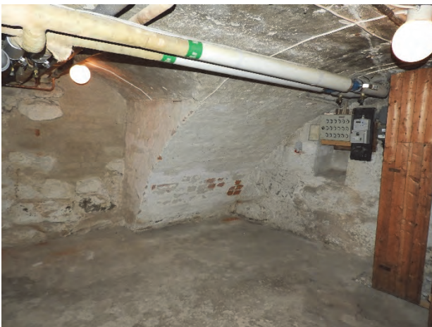
Figur 127. Källare mot sydöst före åtgärder.
