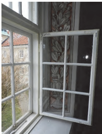
Figur 135. Befintligt fönster med inåtgående innerbåge och utåtgående ytterbåge.
