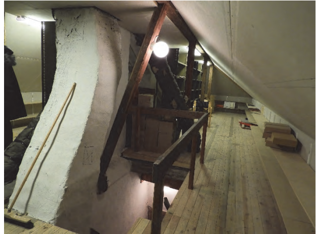
Figur 117. Västra delen av murstocken, upptagen öppning för att kontrollera kanaler inför projektering.
