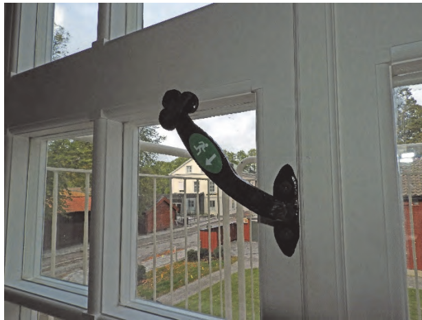
Figur 141. Utrymningsbeslag, specialtillverkat av Västerås kyrkogårdsförvaltning.
