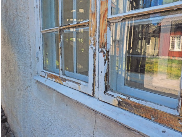
Figur 161. Pågående skrapning inför ommålning av fönster. Norra fasaden.
