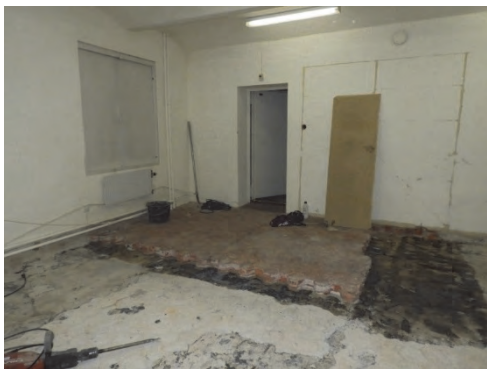
Figur 62. Tegelgolvet är upplockat. Ytterligare kommer att återläggas.
