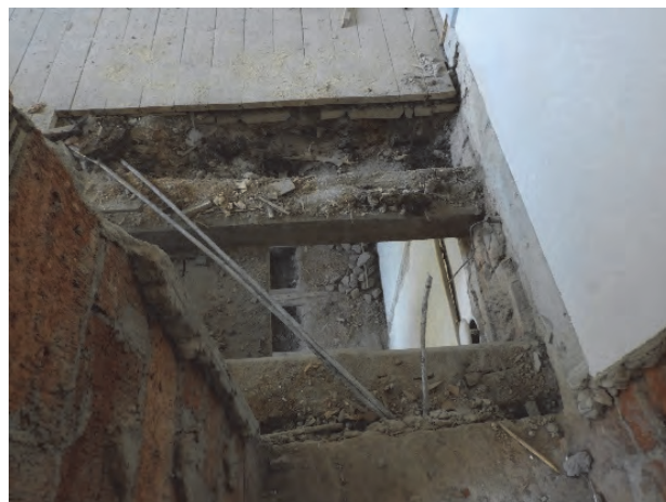
Figur 103. Anslutning mellan tak och vägg före åtgärder.
