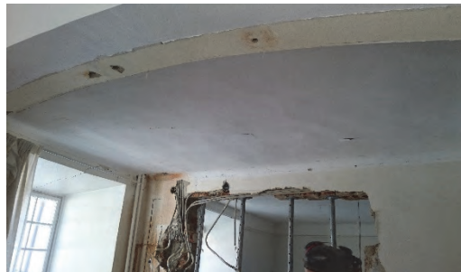
Figur 33. Upptagning av större dörröppning i murverk. Foto: Johan Soblberg.
