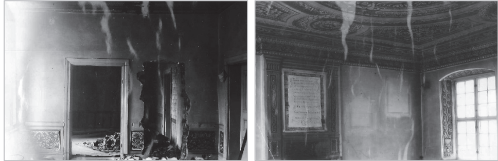
Figur 13. Renoveringen 1952 innebar att en ny dörröppning togs upp mellan rum 3205 och 3206. Foto: VLM arkiv.
