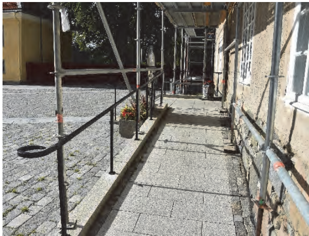
Figur 157. Ny ramp färdigställd.
