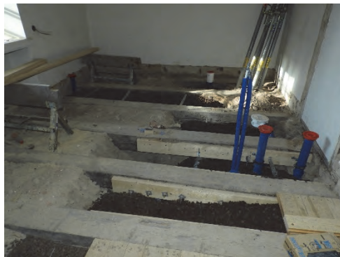
Figur 40. Förstärkning av bjälklag vid hissläge, sett från öster.
