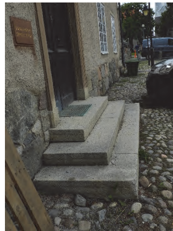
Figur 151. Anslutning mellan trappans vilplan och dörrens omfattning före åtgärder.
