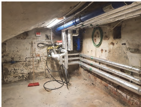
Figur 131. Källaren sedd mot norr efter åtgärder
