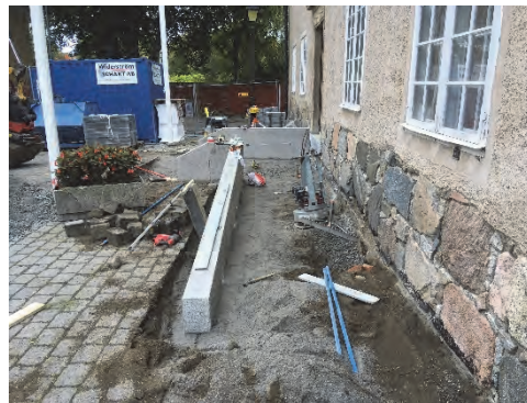
Figur 151. Anslutning mellan trappans vilplan och dörrens omfattning före åtgärder.
