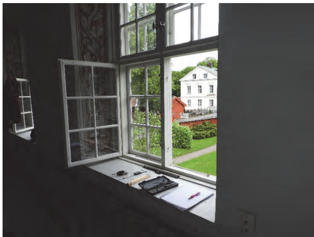
Figur 137. Gångjärn och spröjsprofil på befintligt fönster.
