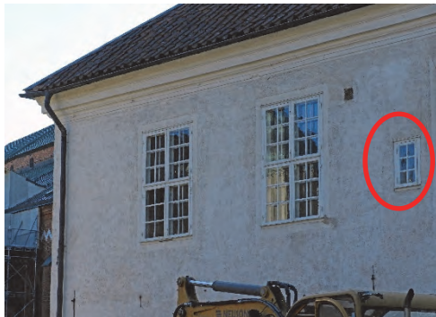
Figur 159. Tidigare befintligt fönster till toaletten.
