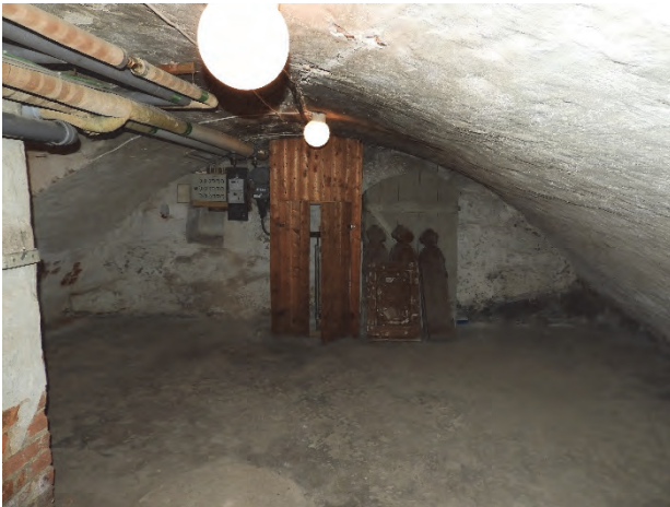
Figur 125. Källaren mot söder före åtgärder.
