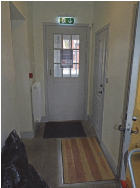
Figur 54. Passagen efter åtgärder, med ny trälucka till källaren.
