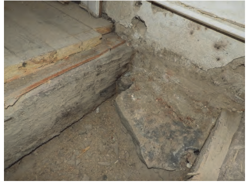
Figur 36. Golvet öppnat i läget för hissen för bjälklagsundersökning.
