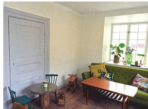
Figur 51. Den äldre dörren är igensatt men dörrbladet sitter kvar.
