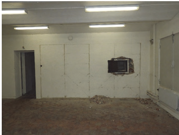
Figur 60. Gamla arkivet med stickbågsvalv mellan järnbalkar.
