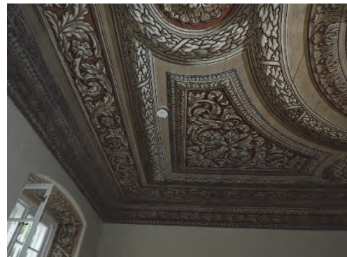
Figur 93. Nya galler för ventilation är placerade där det fanns en äldre igensättning efter en öppen spis.
