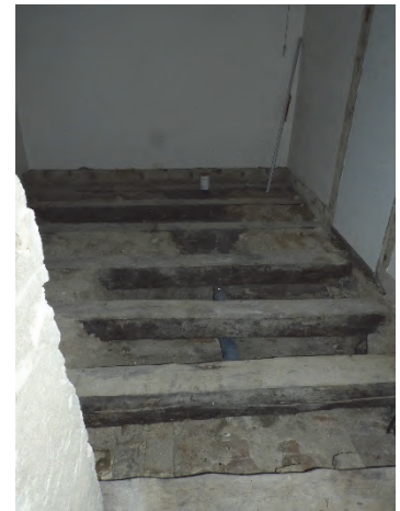
Figur 39. Bjälklag vid hiss frilagt, sett från öster. Teglet från källarvalvet anas.
