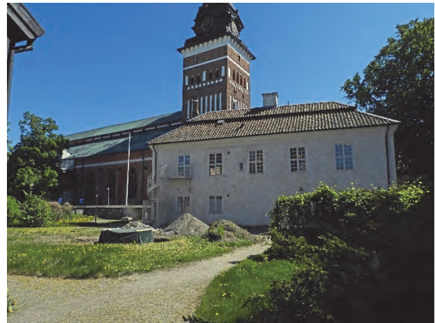
Figur 181. Trädgården sedd från nordväst under pågående arbete.
