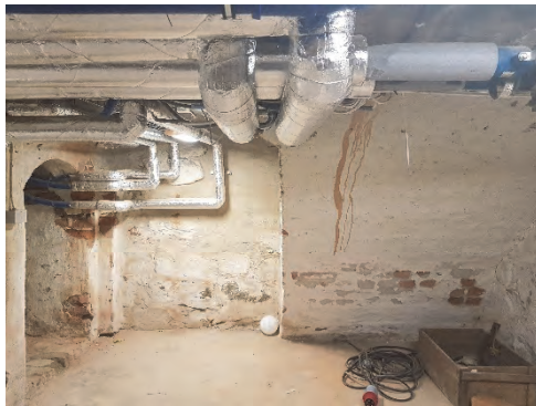
Figur 133. Källaren sedd mot öster efter åtgärder.
