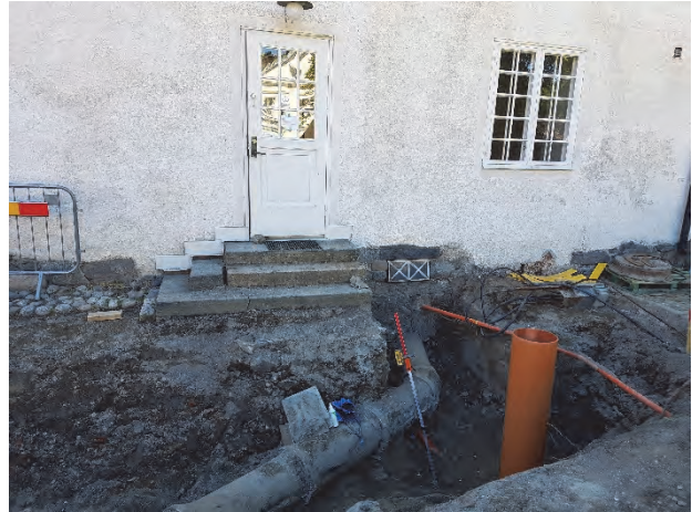
Figur 129. Grävarbeten för ny ledningsdragnig. Foto: Jonas Ros.
