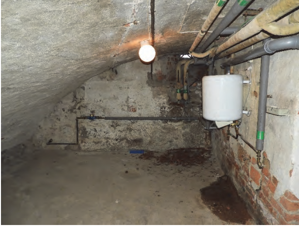
Figur 123. Källaren mot norr före åtgärder.
