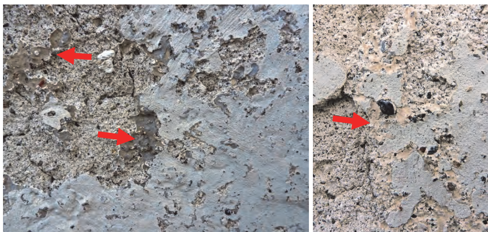
Figur 147. Färgfragment norra fasaden, västra delen. Grå kulör vid undre pilen cirka S3502-Y. Under denna kulör återfinns ytterligare en gråbeige kulör vid övre pilen motsvarade cirka S3005-Y20R
