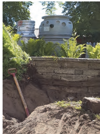
Figur 200. Springbrunnen framgrävd i samband med ledningsarbete. Foto: Jonas Ros.
