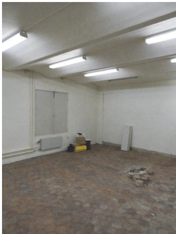
Figur 60. Gamla arkivet med stickbågsvalv mellan järnbalkar.
