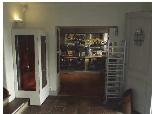
Figur 26. Den tidigare ståldörren till arkivet har tagits bort och öppningen har breddats.
