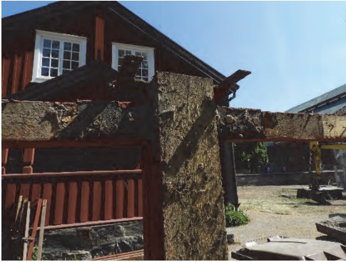
Figur 195. Befintlig stomme till plank.
