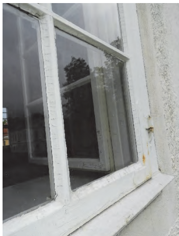
Figur 137. Gångjärn och spröjsprofil på befintligt fönster.
