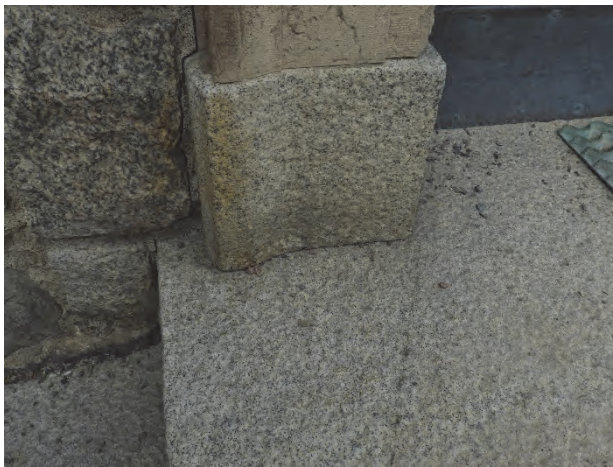
Figur 151. Anslutning mellan trappans vilplan och dörrens omfattning före åtgärder.
