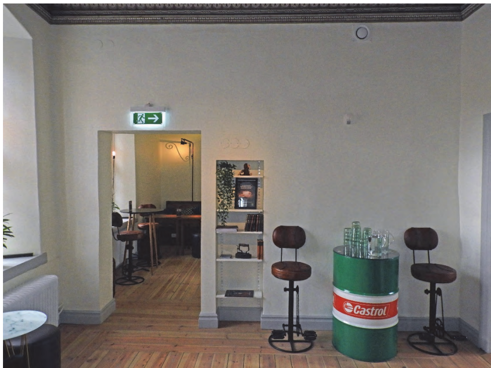
Figur 101. Dörröppningen har flyttats mot söder. Delar av den ursprungliga dörröppningen har blivit en hylla. Den högra dörröppningen från 1950-talet är däremot igensatt. Jämför fig 98.
