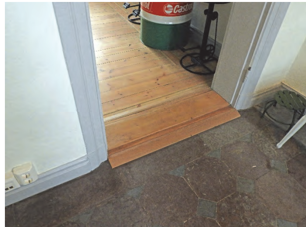
Figur 79. Trösklarna har kompletterats med ekkilar för att förbättra tillgängligheten.
