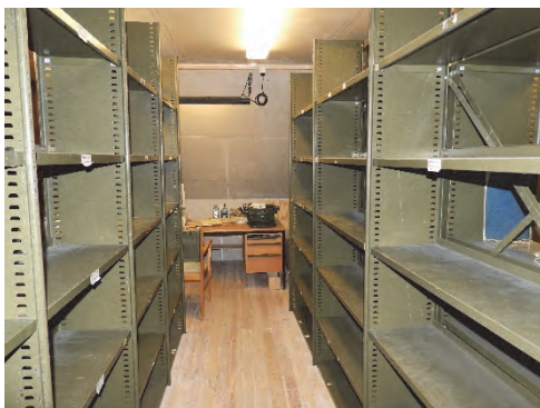
Figur 115. Vinden sed mot öster före åtgärder.
