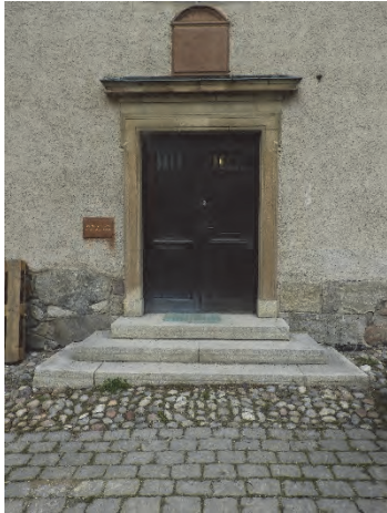
Figur 149. Entrén före åtgärder.
