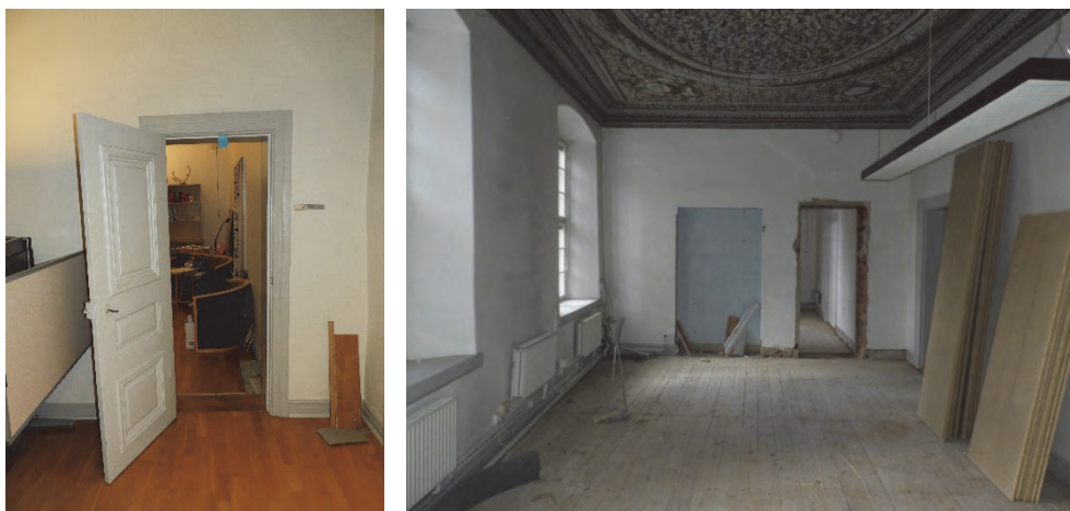
Figur 97. Dörr mot rum 3206 togs upp 1952.
