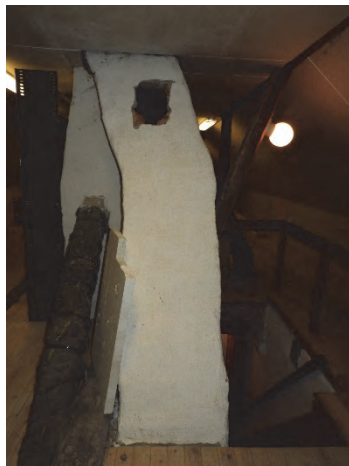
Figur 119. Murstocken vid vindstrappan, upptagen öppning för att kontrollera kanaler inför projektering.
