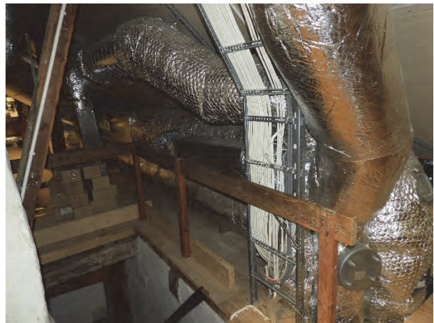
Figur 119. Murstocken vid vindstrappan, upptagen öppning för att kontrollera kanaler inför projektering.
