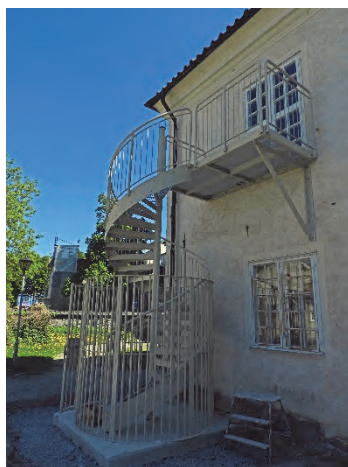
Figur 143. Brandtrappan är infärgad i fasadfärg.
