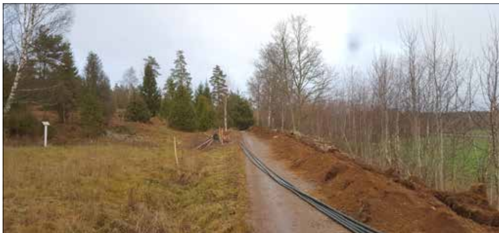
Figur 8. Översikt över schaktningsarbetet vid Husby-Oppunda 23:1 (till vänster). Uppe på det lilla krönet till höger påträffades gravlämningar (A275 och A279).
