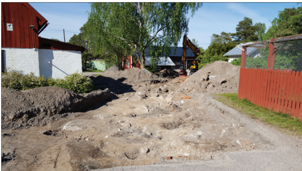
Figur 7. Den framrensade stenpackningen (stenkistan) i schakt 4. Foto från väster av Maud Emanuelsson.
