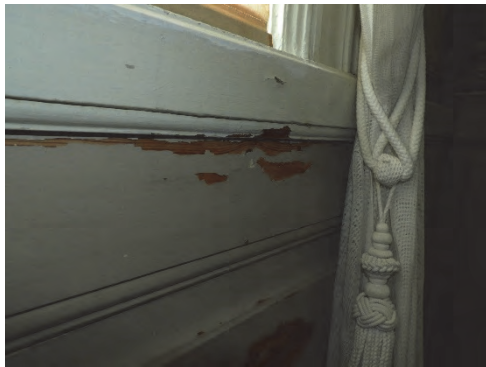
Figur 19. Bröstningspanelen på salongens östra vägg hade stora färgbortfall.
