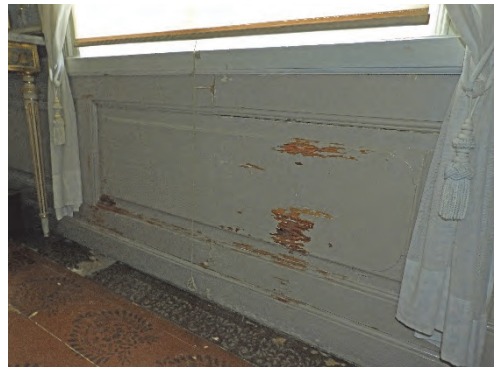
Figur 19. Bröstningspanelen på salongens östra vägg hade stora färgbortfall.
