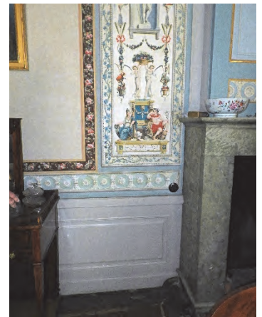
Figur 21. Snickerierna i salongen hade tunt pålagda färglager till skillnad från salen.
