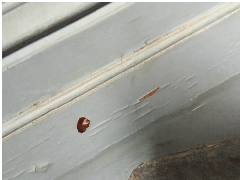
Figur 13. Spår av äldre rödbrun kulör vid färgsläpp.
