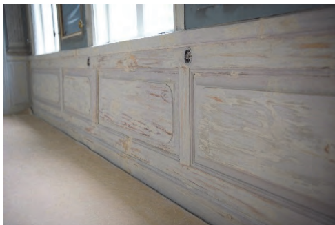
Figur 23. Panelen spacklad och slipad inför mellanstrykning. Foto: Christer Lorichs.
