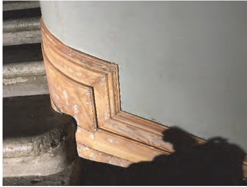
Figur 17. Färdigskrapad golvlöst i trappans mellersta del.
