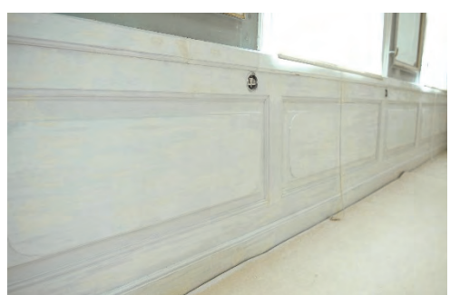
Figur 23. Panelen spacklad och slipad inför mellanstrykning. Foto: Christer Lorichs.
