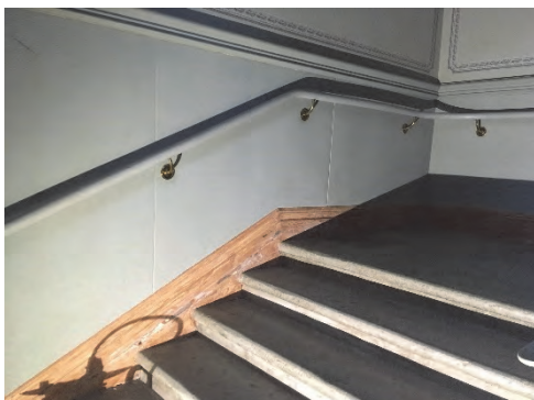
Figur 15. Färdigskrapad golvlist i trappans mellersta del.
