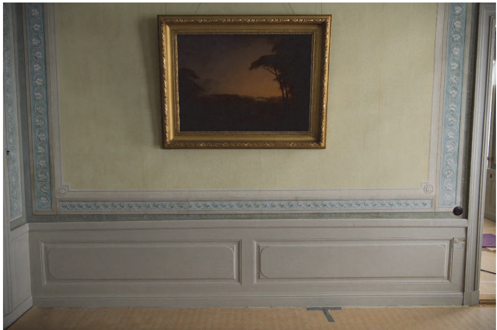
Figur 33. Panel i salen efter åtgärder. Foto: Christer Lorichs.
