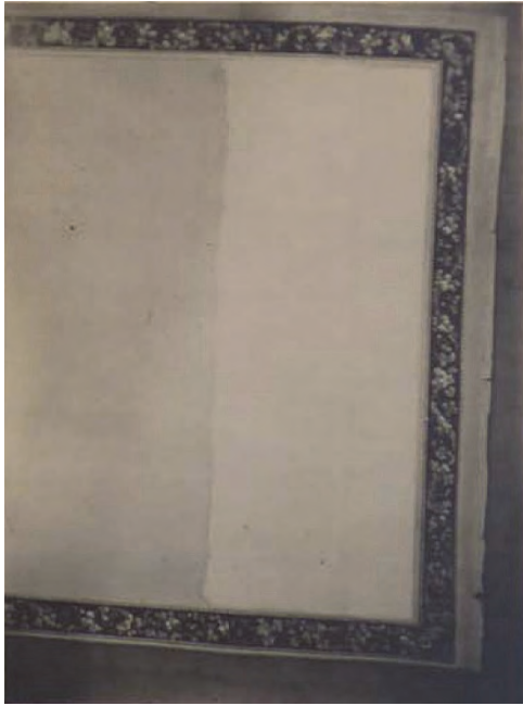
Figur 4. Rengöring av väggfältet med bröd under 1920-talets restaurering. Foto: Sundbaum. Nordiska museets arkiv.
