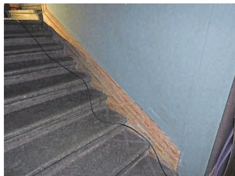
Figur 14. Bröstningen i trappan har färglager med bättre vidhäftning.
