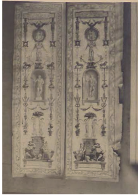
Figur 4. Rengöring av väggfältet med bröd under 1920-talets restaurering. Foto: Sundbaum. Nordiska museets arkiv.
