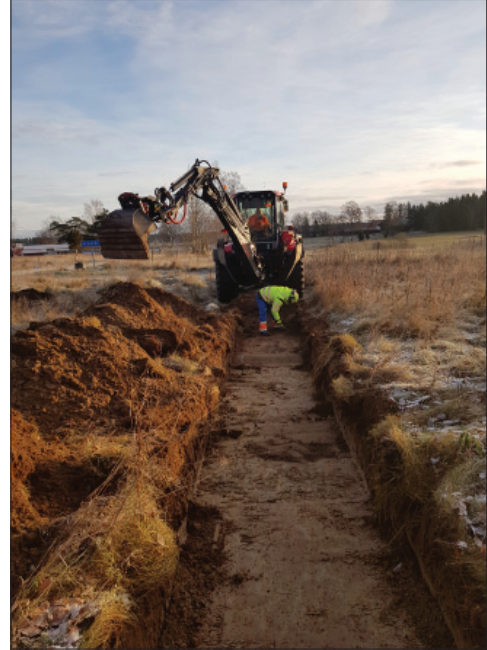
Figur 5. Christian Gatti i schakt 2. Foto från väster.
