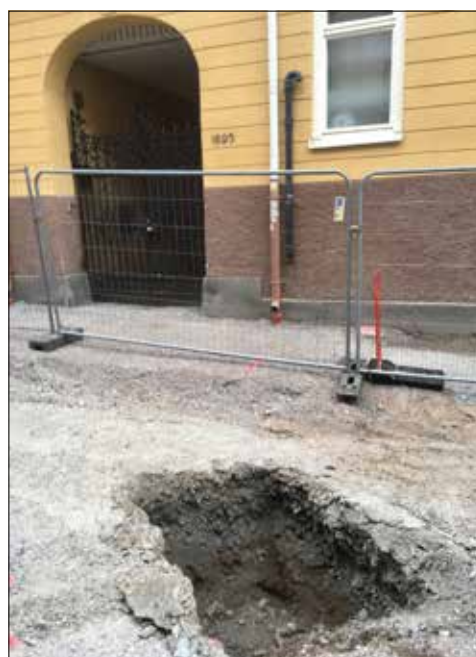
Figur 5. Schakt 2 från nordväst.
