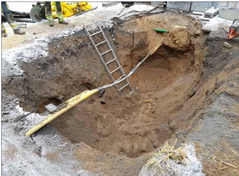
Figur 68. Schakt 10 från sydöst. Foto Duncan Alexander.
