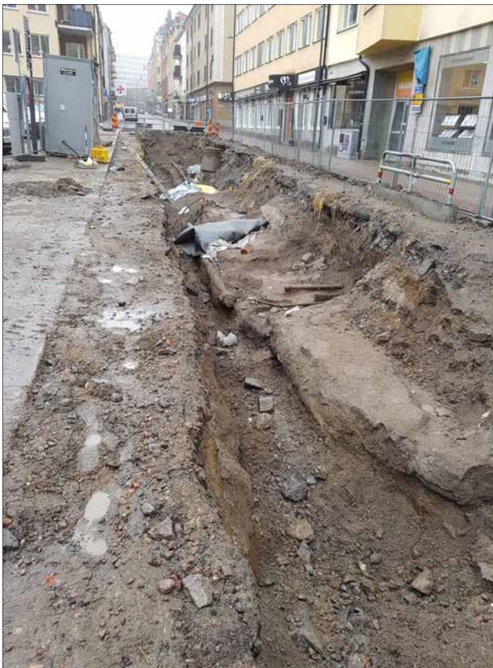
Figur 5. Slutundersökningschaktet från väster. Foto Oskar Spjuth.
