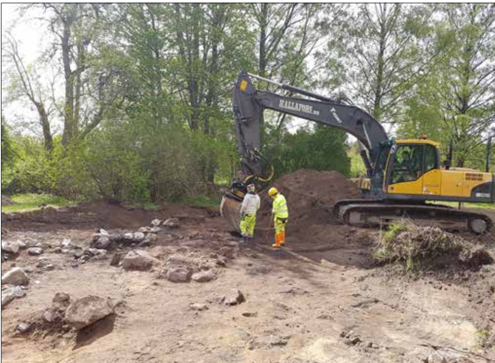
Figur 8. Framschaktning av hela hus 1 vid steg 2. Arkeologerna Christian Gatti och Sofia Lindell hjälper till att rensa bort lösa massor mellan stenkonstruktionerna. Foto från norr.
