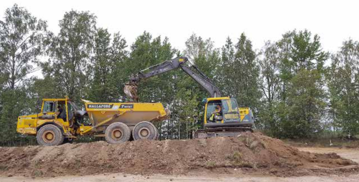
Figur 10. För att skydda anläggningar från dumperns tyngd lades massorna i en sträng på vilken dumpern sedan fick köra. Foto från söder av Maud Emanuelsson.
