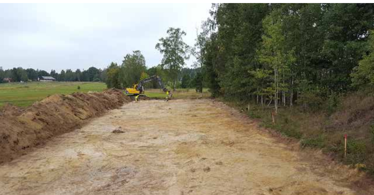
Figur 6. Arbetsbild över avbaning. Foto från öster av Maud Emanuelsson.
