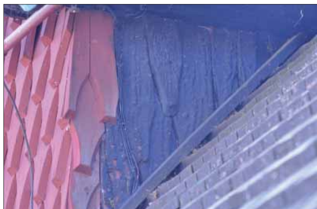
Kvistbro kyrka. På korets norra fasad finns några få av kyrkans originalspån bevarade, täckta med ett tjockt skikt av svart tjära.
