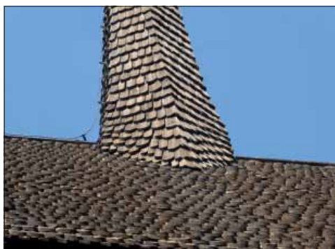
Lista klockstapel. Detalj av spåntäckning på klockstapelns huv och spira.
