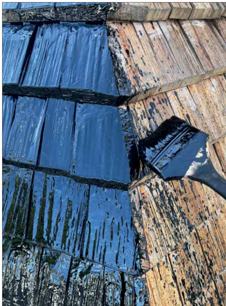
Figur 9. Pågående tjärning av spåntak på Blacksta klockstapel, Strängnäs stift, med tjära utifrån ett recept från 1790. Foto Daniel Eriksson.
