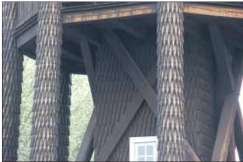
Västermo klockstapel. Spånklädda stolpar och fasad.
