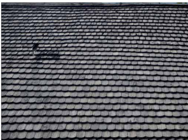
Vallby kyrka. Vapenhusets östra takfall täcks med rundade spån.
