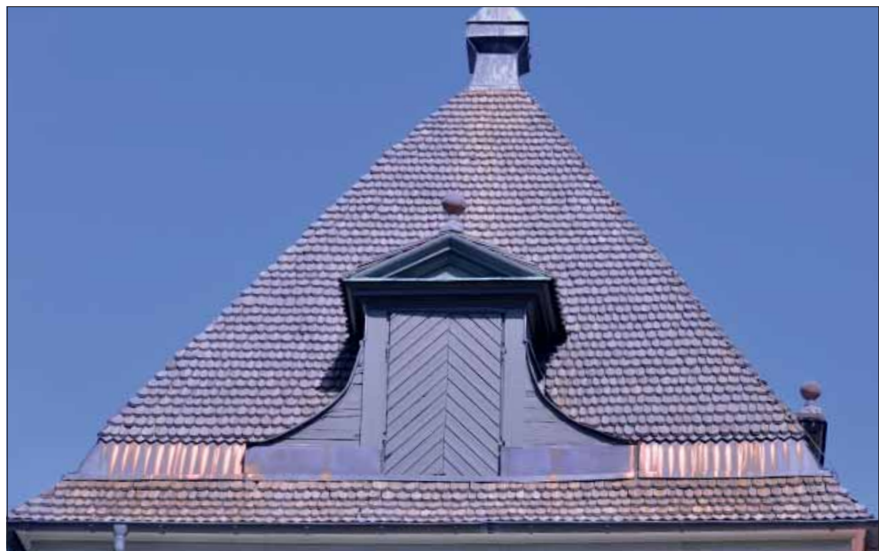
Birgittakyrkan, Olshammar. Takspånen är spjälkade och tillkom vid en takomläggning 2000–2001.
