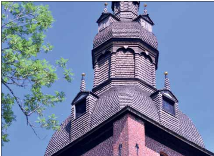
Askersunds landskyrka. Tornet är spänklätt i alla sina detaljer.
