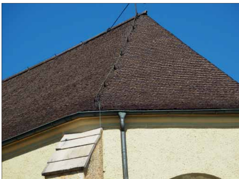
Fors kyrka. Del av långhuset och korets spåntäckning.
