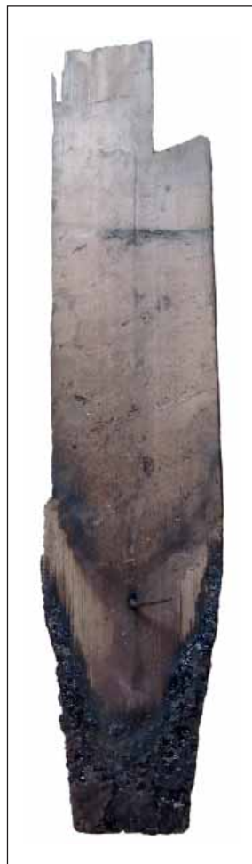
Figur 53. Baksidan/undersidan av ett demonterat spån. Verktygsspåren visar att sidan är huggen i sin helhet. Foto Lars Jönnes.
