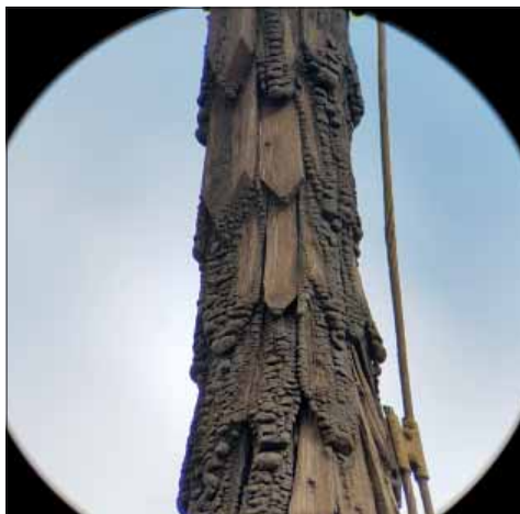
Figur 3. Tunabergs kyrka, Strängnäs stift. Kikarbilden visar spån med tjocka tjärklumpar på en av takets spiror. Foto Karin Myhrberg.
