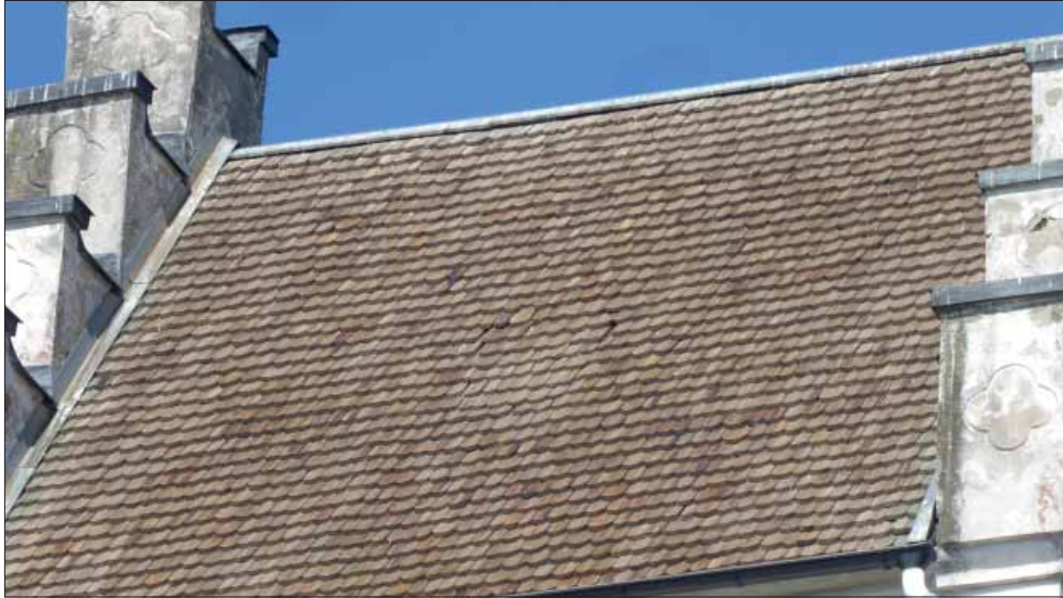
Gillberga kyrka. Tornets spånklädda tak. Södra takfallet.
