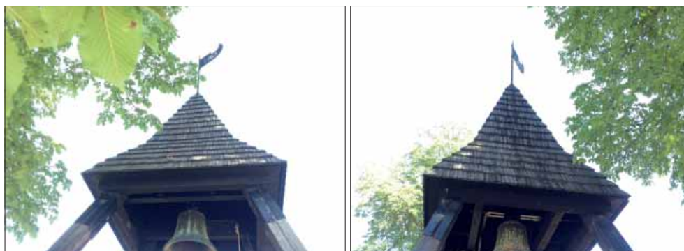
Ramundeboda klockstapel. Klockstapelns spån är raka och mycket smala (t.v.). På takfallets västra sida finns synliga tjärrester (t.h.).
