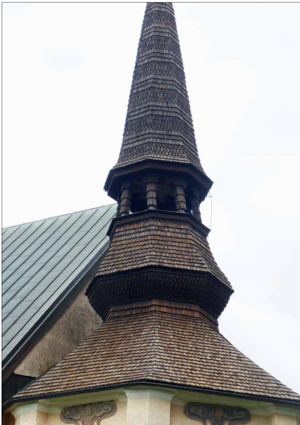
Sköldinge kyrka. Gravkorets spåntäckta tak.
