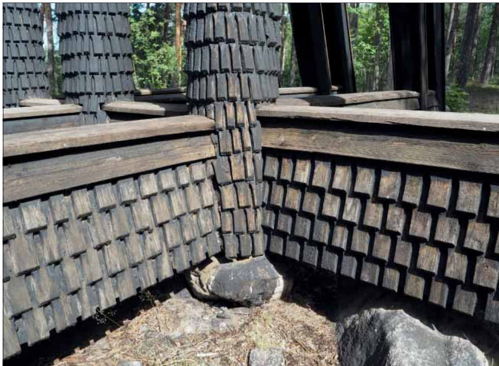
Barva klockstapel. Detalj av spåntäckning på syllen i sydöst.
