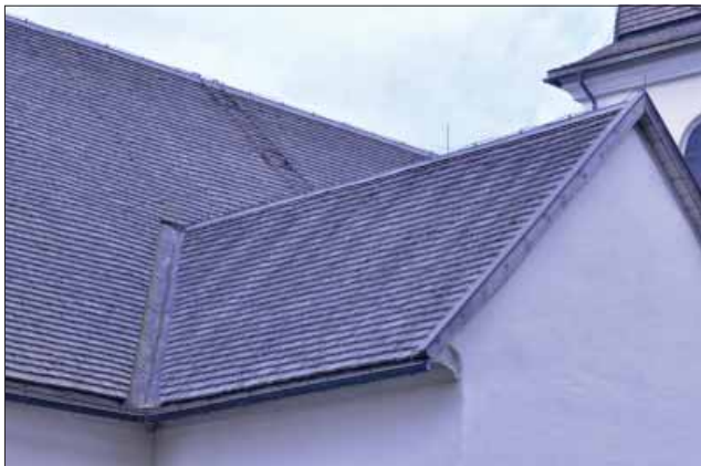
Lerbäcks kyrka. Sakristians spåntak sett från öster.
