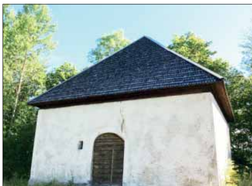
Hardemo sockenmagasin. Sockenmagasinets pyramidtak är liksom tornets spåntäckt. Spåntäckningen är mönsterlagd med varannan rad med omväxlande raka respektive näbbspån.
