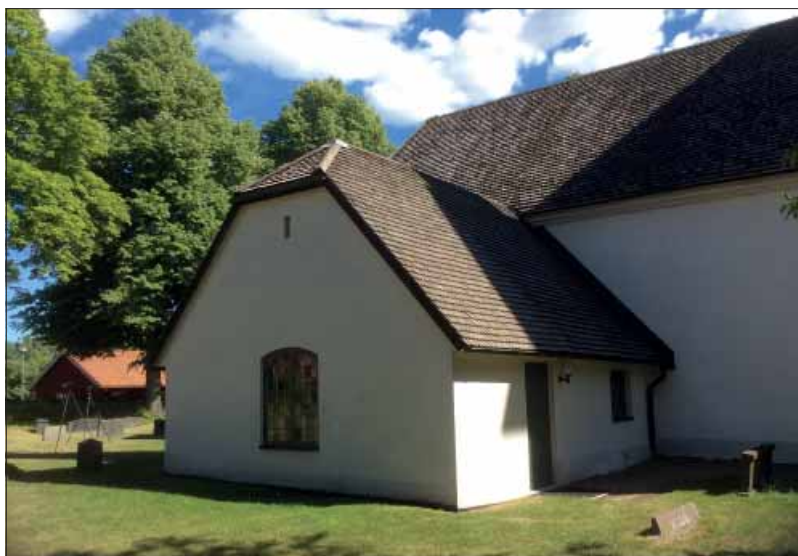
Hovsta kyrka. Sakristian tillbyggdes 1981 varvid den nya delens spån fick samma utseende och dimensioner som den redan befintliga delen.
