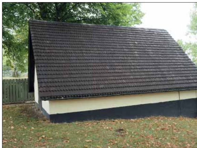
Tuna kyrka. Bårhusets östra takfall.
