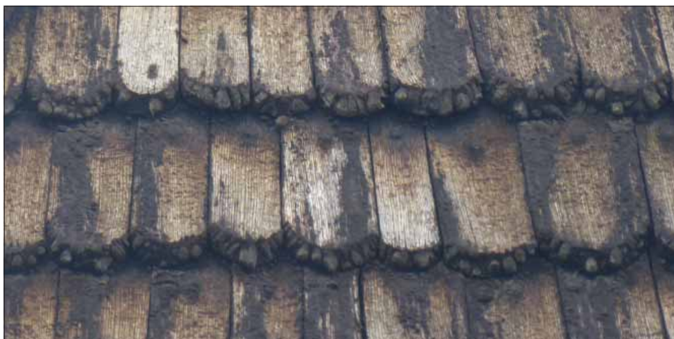
Lilla Malma klockstapel. Fasadspån på klockstapelns huv. Notera de synliga infästningarna och tjärklumparna på spånens bas.
