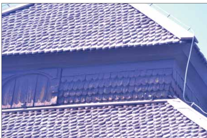
Glanshammars kyrka. Detalj av fasadpartiet mellan säteri- takets båda takfall. Här är spåntäckningen av hög ålder med tjärskiktet bibehållet.
