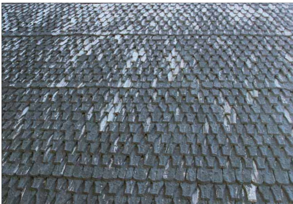
Figur 35. Sala sockenkyrka, Västerås stift. Västra takfallet på vapenhuset är täckt med stavspån som kan vara en av de äldsta taktäckningarna inom undersökningsområdet. Foto Lisa Skanser.
