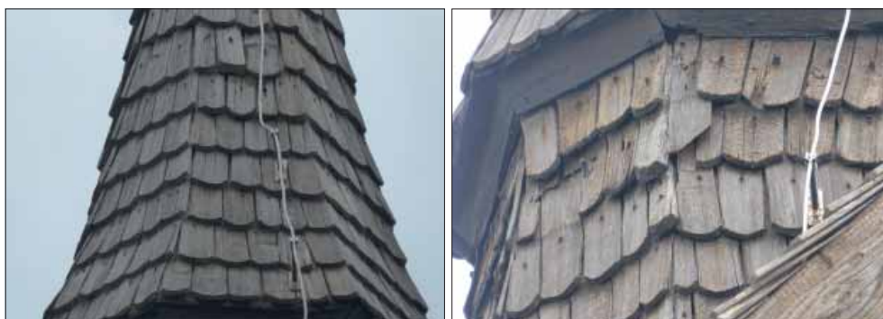
Floda klockstapel. Del av spiran (t.v.) och detalj av spån med olika åldrar på spiran (t.h.).
