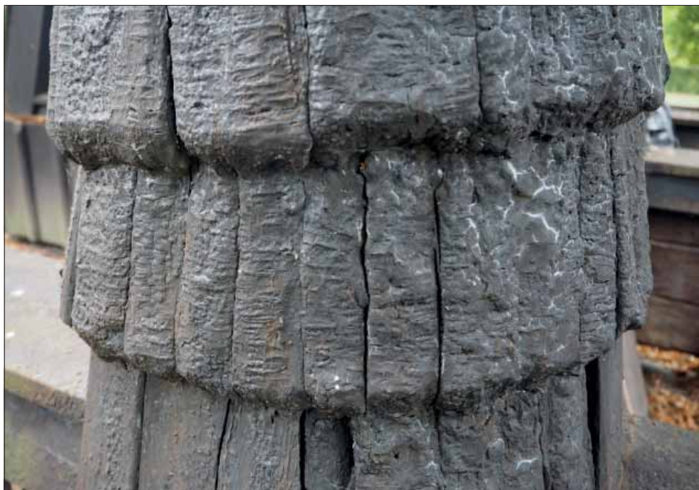
Bergshammars klockstapel. Detalj från hjärtstolpe med spån i varierande mått och med ett tjockt lager tjära.
