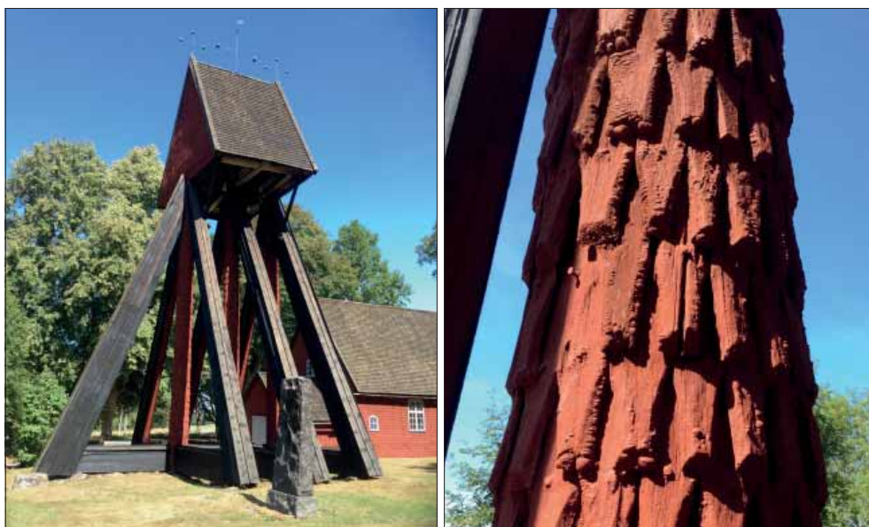
Skagershults klockstapel. Hjärtstolparnas näbbspån är av hög ålder. Möjligen rör det sig om originalspånen från byggnadstiden. Huvens fasader har rundade spån av hög ålder, mönsterlagda nedtill.
