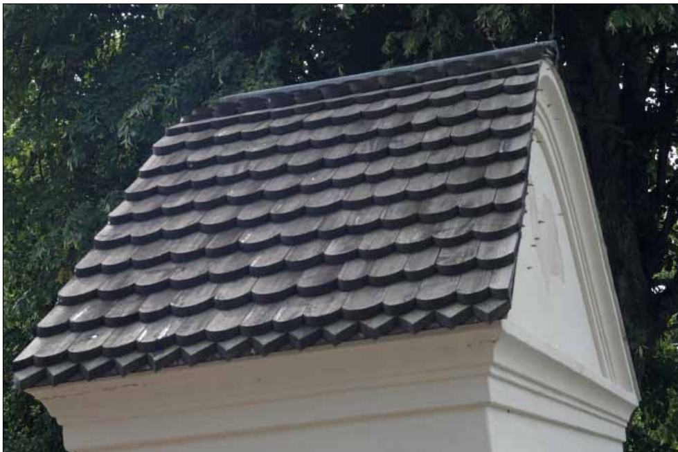
Tunabergs stiglucka. Stigluckan med späntäckt tak.
