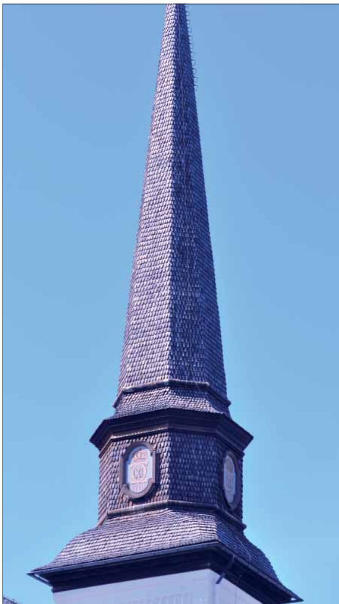
Glanshammars kyrka. Torn- takets alla delar är spåntäckta.
