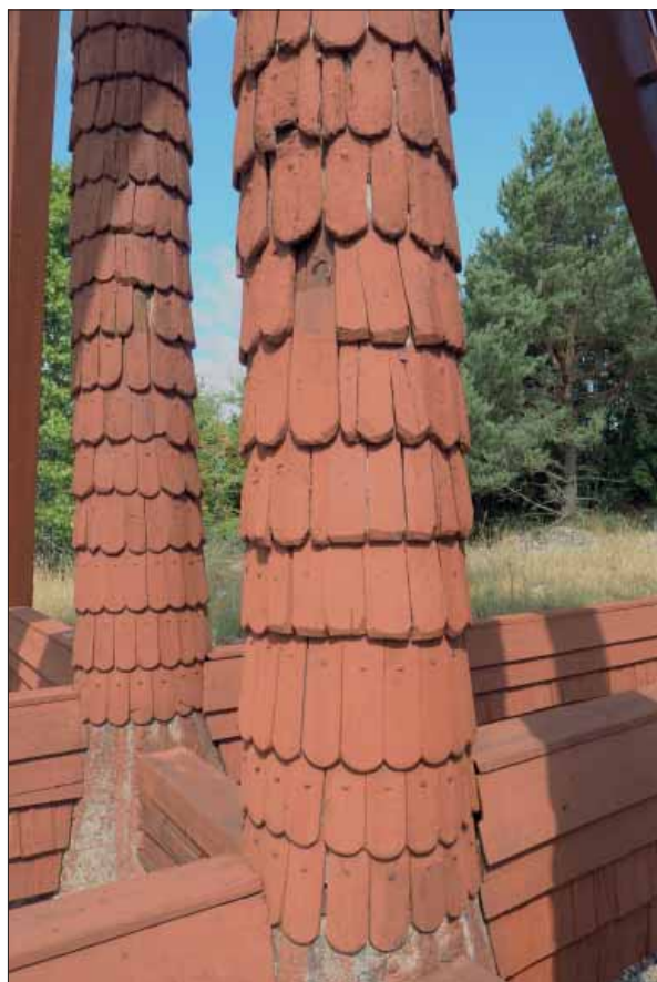
Mörkö klockstapel. Spån av olika ålder, form och storlek på klockstapelns hjärtstockar.
