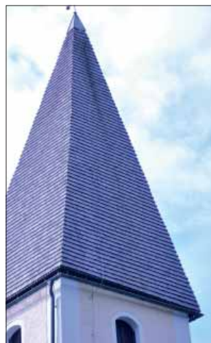
Norrbyås kyrka. Spåntäckningen på norra takfallet lades ny 2001.
