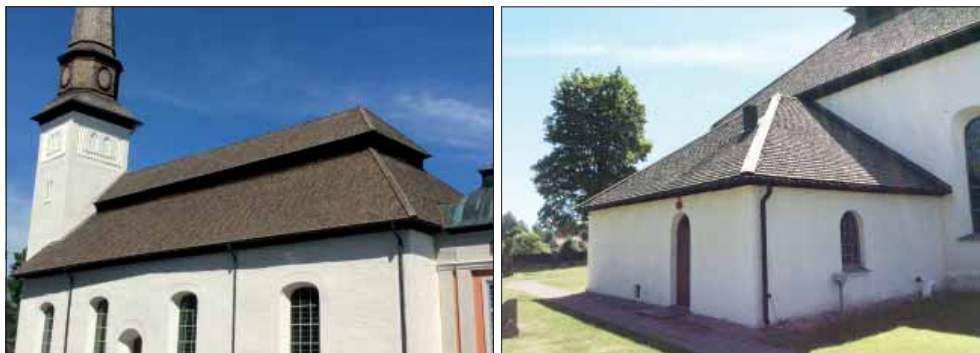
Glanshammars kyrka. Kyrkans spåntak tillkom på 1960-talet då man bytte takmaterial från tegel till spån.
