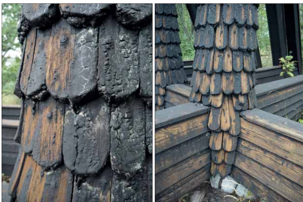
Kila klockstapel. Ålderdomliga spån på en av hjärtstolparna (t.v.). Notera de spetsiga spånen längst ner (t.h.).
