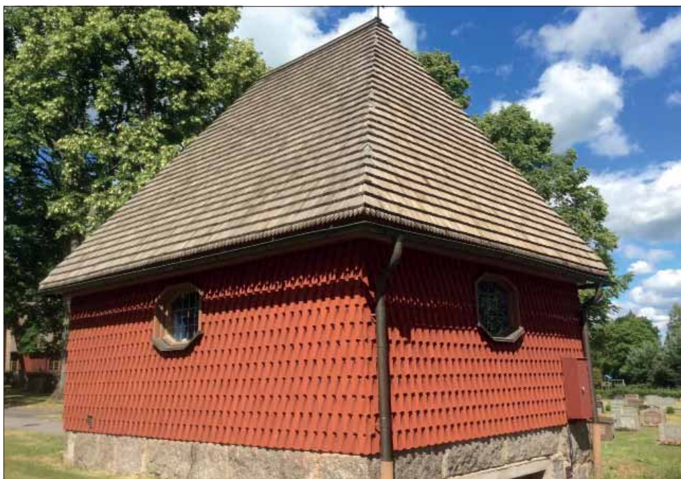
Kvistbro gravkapell. Gravkapellet från 1927 har spåntäckta tak och fasader utformade lika långhusets.
