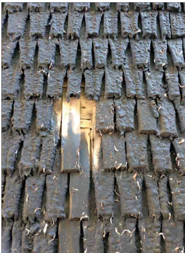
Sköllersta klockstapel. Spåntäckning på klockstapelns västra fasad.
