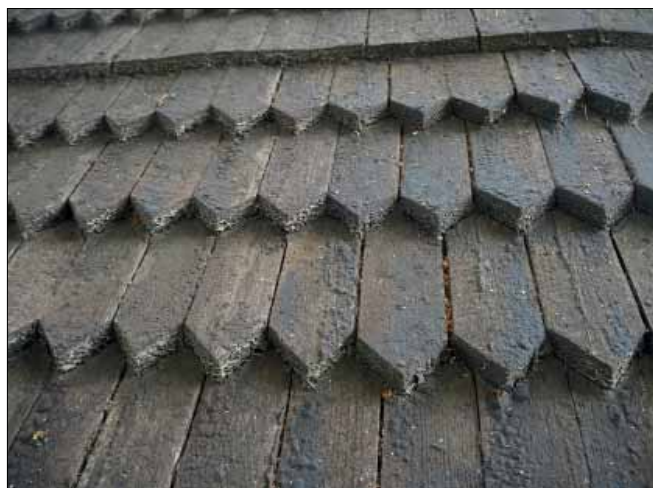
Tuna kyrka. Spån på bårhusets västra takfall.
