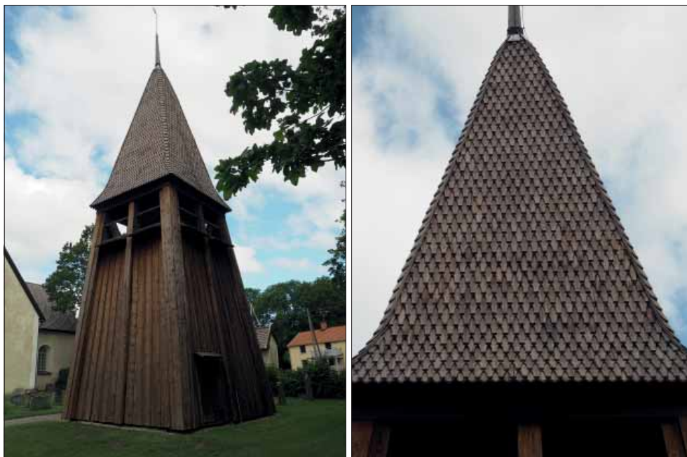
Häradsklockstapel. Klockstapeln med spåntäckt tak sedd från sydöst (t.v.). Spåntäckt tak på södra sidan (t.h.).
