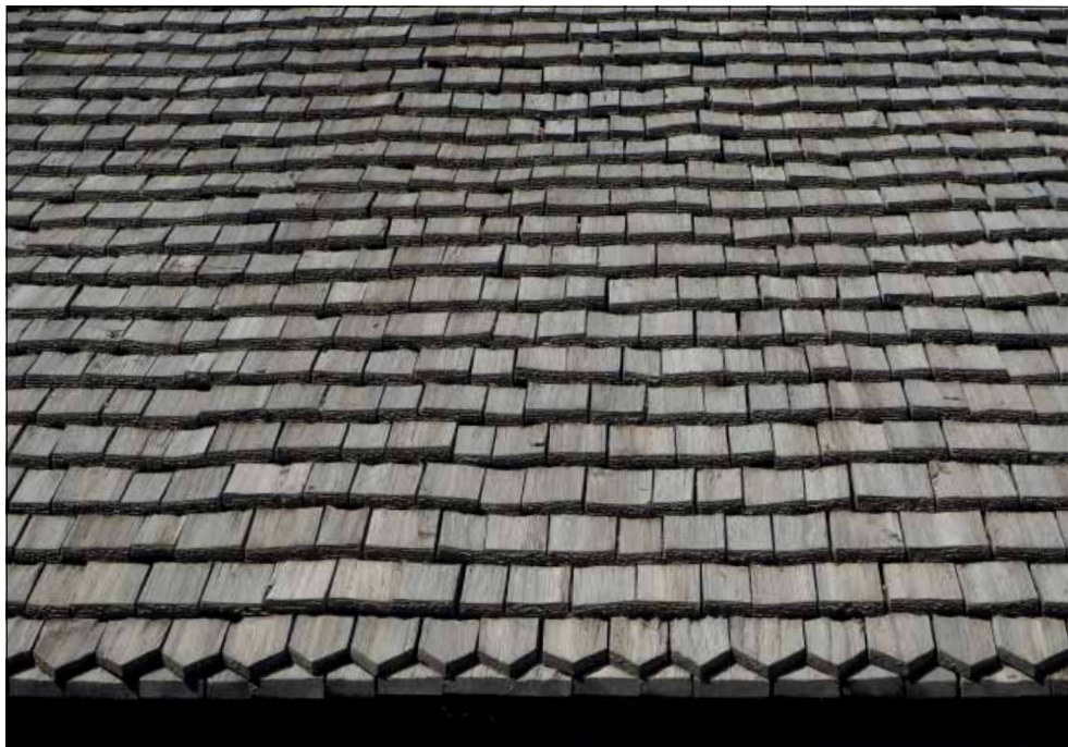
Spelviks kyrka. Vapenhusets östra takfall.
