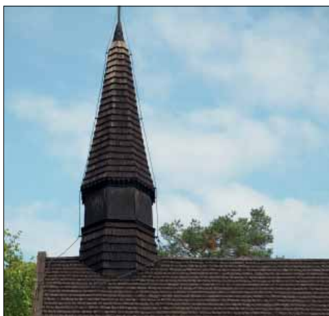
Tunabergs kyrka. Den spänklädda större takryttaren på kyrkans långhus.
