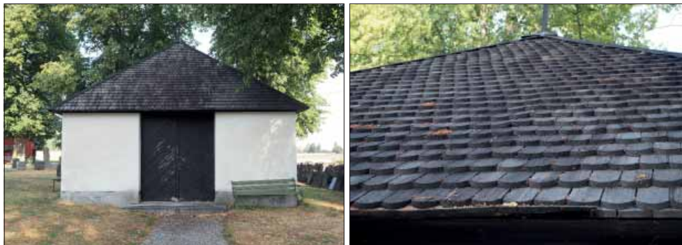
Överselö kyrka. Bisättningshus från söder (t.v.). Spån på bisättningshusets södra takfall (t.h.).
