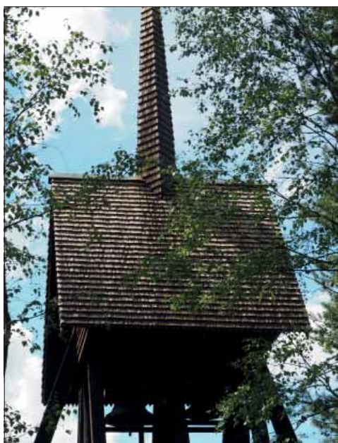
Säby begravningsplats. Spåntäckning på klockstapelns ena takfall.
