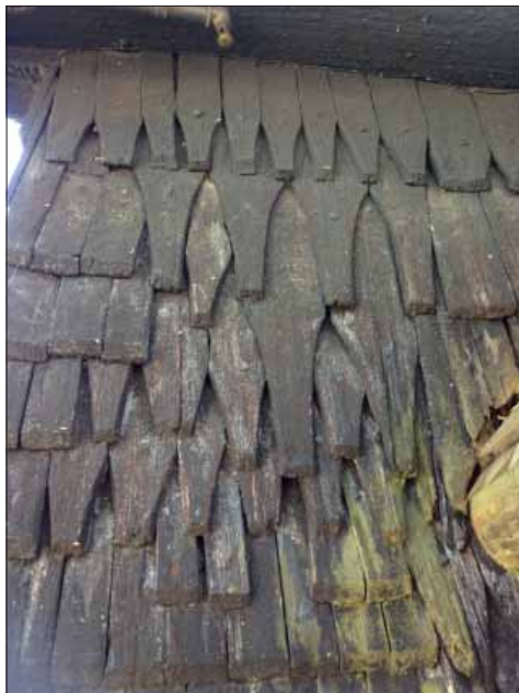
Tångeråsa kyrka. På den övre delen av norra korfasaden finns en yta med mycket ålderdomliga spån som möjligen härrör från medeltiden.
