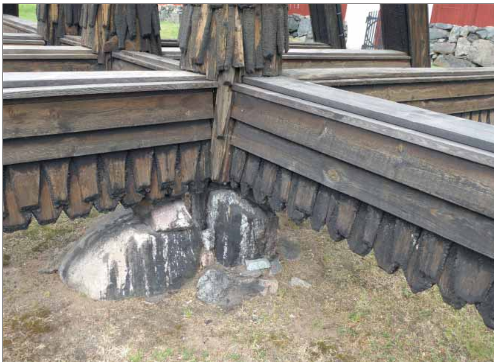
Lilla Malma klockstapel. Näbbformade spån på klockstapelns syll.
