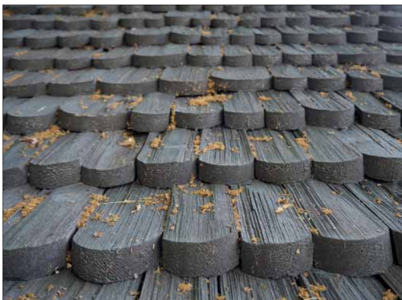
Runtuna stigluckor. Kluvna spån på västra stigluckans norra takfall. Spånen lades 2013.
