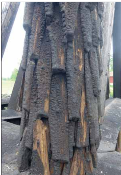
Helgesta klockstapel. Näbbspån med synlig spikning på en av klockstapelns hjärtstolpar.
