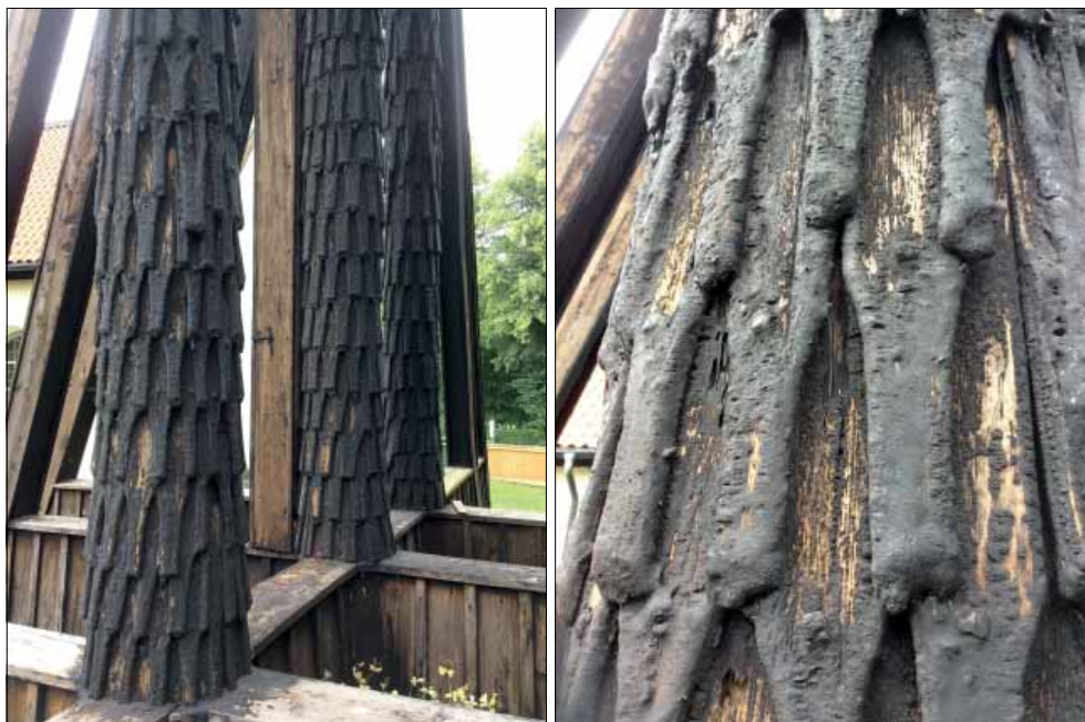
Råby-Rönö klockstapel. Klockstapelns hjärtstolpar är täckta med näbbformade spån.
