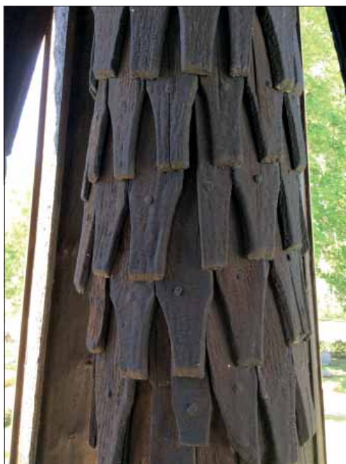
Kräcklinge klockstapel. Hjärtstockarnas spån har synlig infästning och mycket tjocka tjärskikt (t.v.). Ett löst näbbspån med rits på baksidan för näbb, hål för infästning och spar av tjocka tjärager (t.h.).
