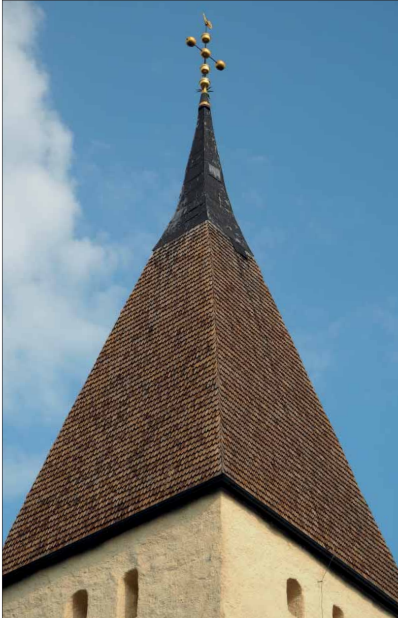
Ytterselö kyrka. Tornets spån- täckt tak.
