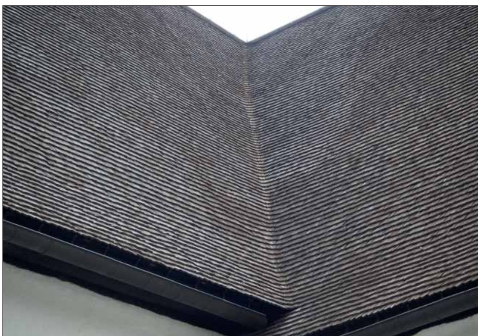
Sorunda kyrka. Spånlagd rännedal mellan långhus och norra korsarmen.
