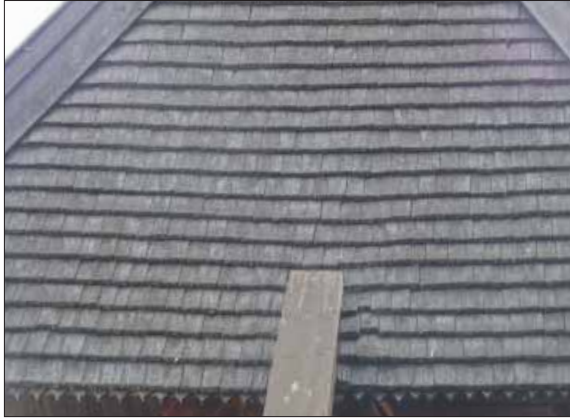
Vrena klockstapel. Klockstapelns fasadspån i norr (t.v.). Detalj av fasadspån (t.h.).
