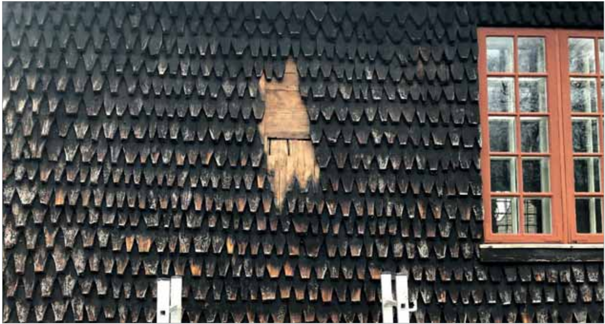
Undersökningsytan på södra fasaden efter demontering av spån. Den tidigare sydportalens västra överkant är synlig i ytans mitt. Foto: Daniel Eriksson.
