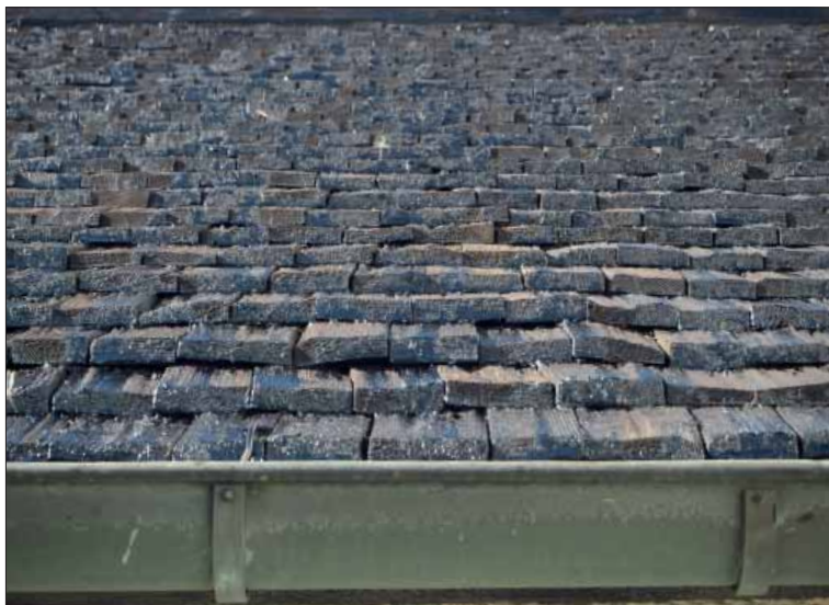
Ytterenhörna kyrka. Detalj av vapenhusets spåntak efter tjärning september 2018. Foto från öster.
