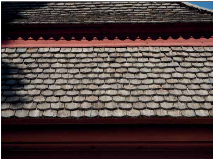
Ludgo kyrka. Detalj av span på gravkorets östra takfall.
