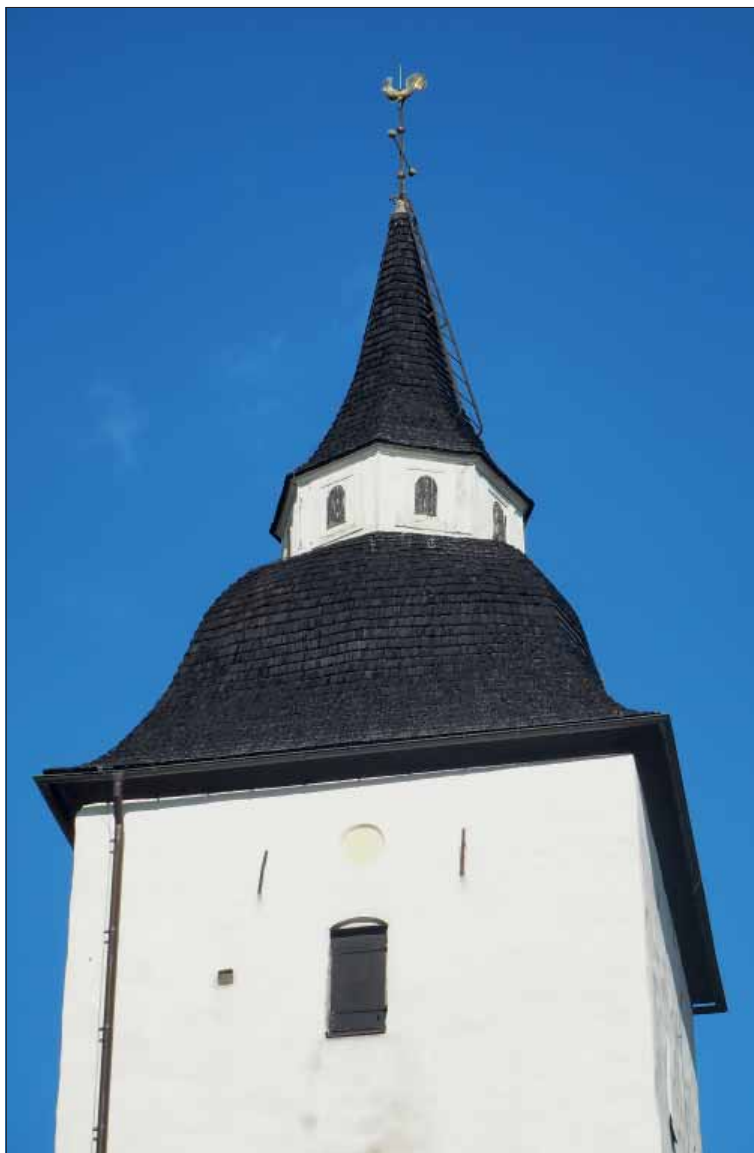
Ytterehörna kyrka. Tornets spåntäckning efter tjärning, septem- ber 2018.
