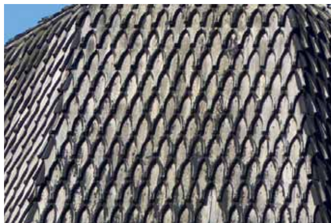
Klockhuv med plåtavtäckningar i takfallens brytningar. Foto: Lisa Skanser.
