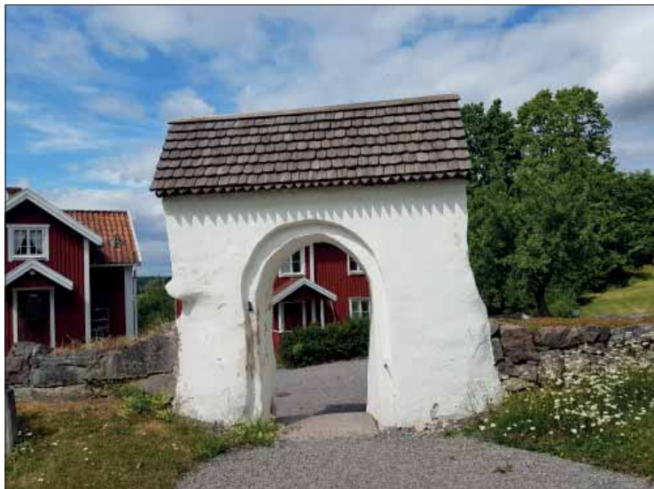
Åkers stigluckor. Västra stigluckan med spåntäckt tak.
