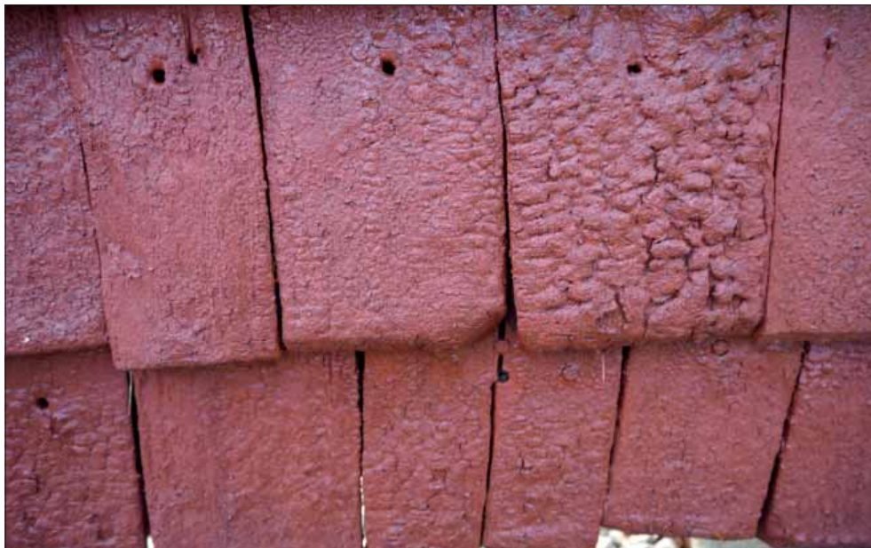
Mörkö klockstapel. Syll med äldre spån som har hål från tidigare infästningar. Notera spånens varierande mått.
