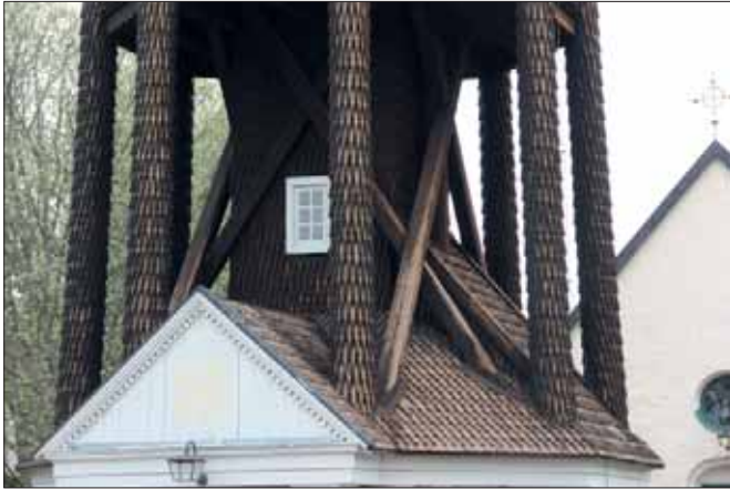
Foto från väster. Antal spånskift och spånens mått överensstämmer med utseendet 1936, se foto intill. Foto: Lisa Skanser.
