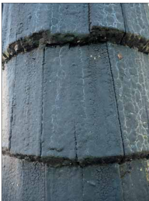
Hällby klockstapel. Trots att spånen på hjärtstolparna är från 1930-talet har ett tjockt tjärlager byggts upp.
