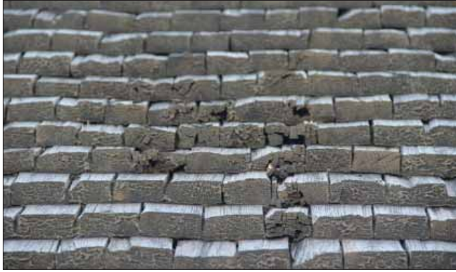
Figur 43. Rötskadade spån på bårhuset vid Bergs kyrka, Västerås stift. Spånen är klivna, tjärdoppade innan läggning och uppskattningsvis lagda under sent 1900-tal eller tidigt 2000-tal. Foto Lisa Skanser.
