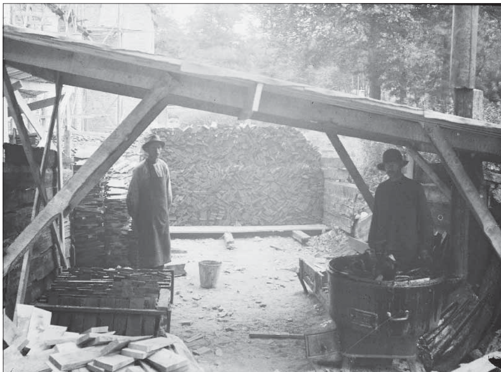
Figur 20. Tjärdoppning av takspån vid Varnhems klosterkyrka i samband med kyrkans restaurering, 1910- eller 1920-tal. Foto Axel Förssén. Bildkälla Kulturmiljöbild.
