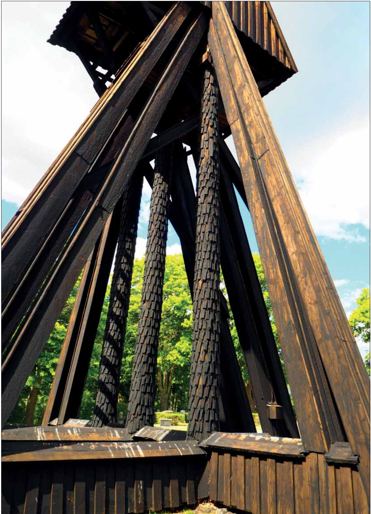
Sättersta klockstapel. Klockstapelns spånklädda hjärtstolpar.
