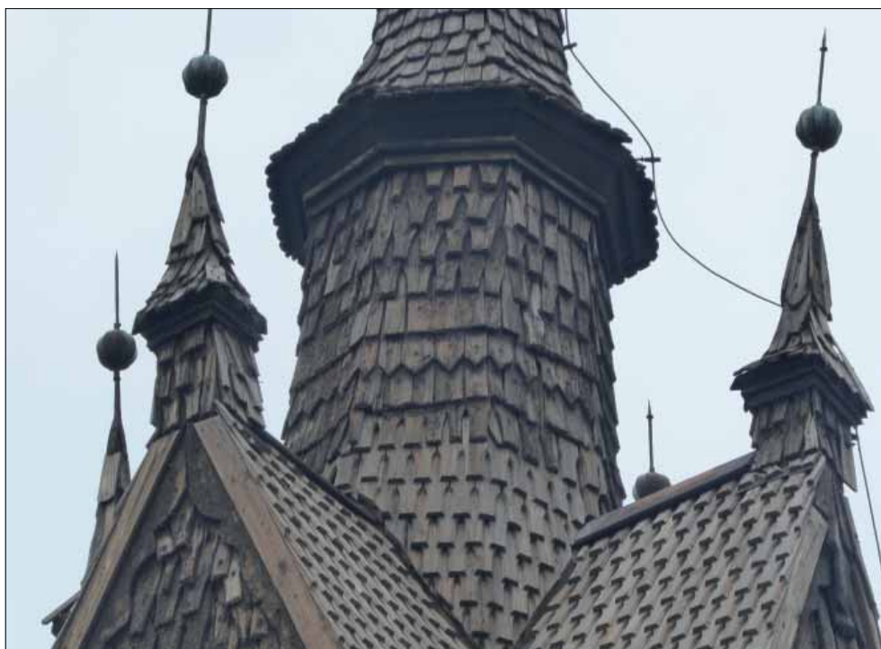
Sköldinge klockstapel. Del av klockstapeln. Samtliga ytor är spåntäckta, men med olika typer av spån från olika tider.
