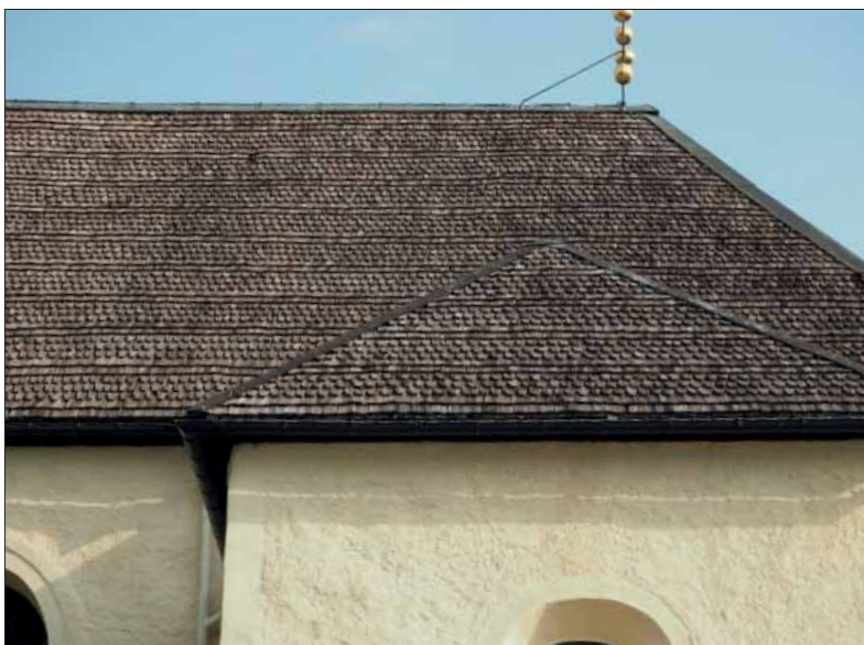
Ytterselö kyrka. Spån på långhusets och gravkorets södra takfall.
