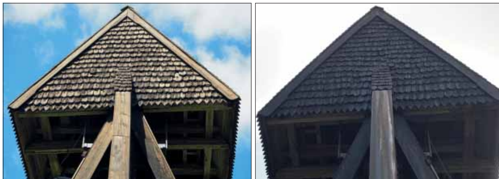
Råby-Rekarne klockstapel. Klockstapelns södra fasad (t.v.) och norra fasad (t.h.)
