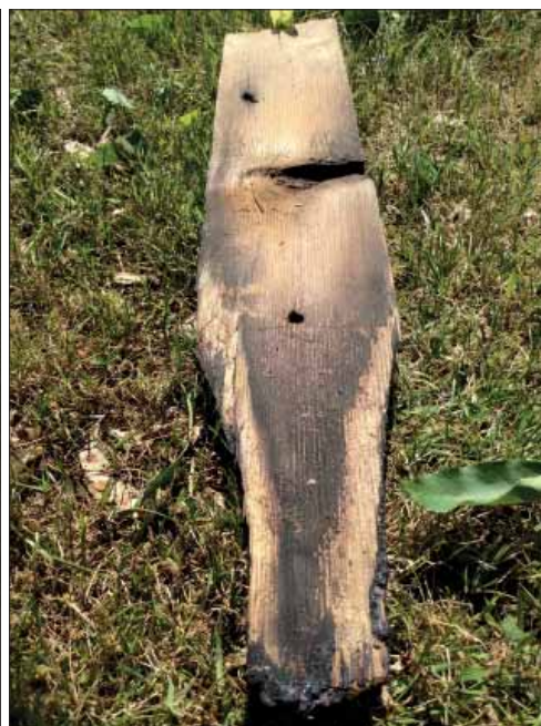
Kräcklinge klockstapel. Hjärtstockarnas spån har synlig infästning och mycket tjocka tjärskikt (t.v.). Ett löst näbbspån med rits på baksidan för näbb, hål för infästning och spar av tjocka tjärager (t.h.).
