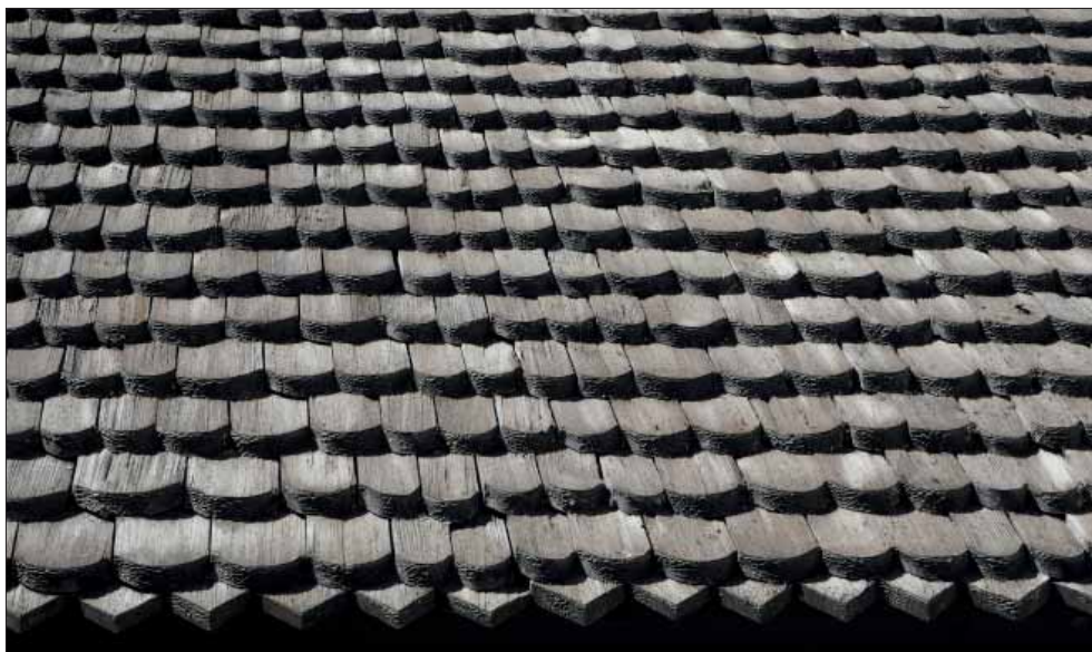
Grödinge kyrka. Vapenhusets östra takfall.
