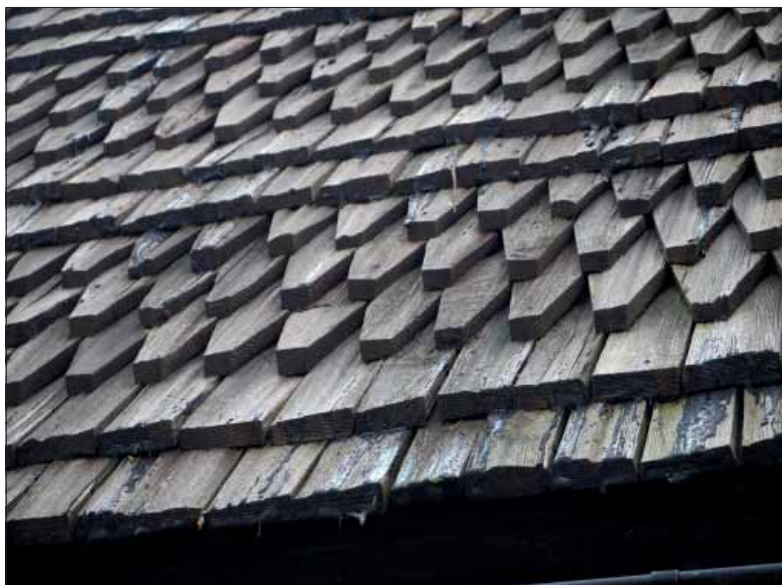
Ytterselö kyrka. Mönsterläggning på sakristians västra takfall.
