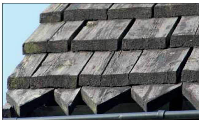
Figur 42 Sågade spån med liggande årsringar ger sprickor på kärnsidan. Sådana spån krymper och sväller mer än ett spån med stående årsringar. Bårhus vid Säby kyrka, Västerås stift. Foto Lisa Skanser.
