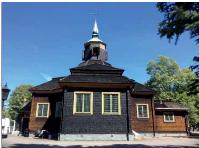
Ramundeboda kyrka. Såväl tak som fasader är klädda med spetsiga spån.
