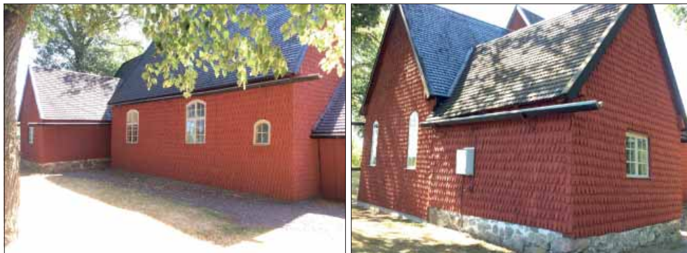
Skagershults gamla kyrka. Kyrkan sedd från nordväst (t.v.). Sakristian sedd från nordöst (t.h.). De norra fasaderna har spån av hög ålder över stora välbevarade sammanhängande ytor.
