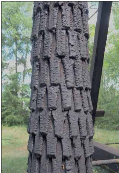
Bälinge klockstapel. Näbbspan med ett tjockt lager tjära på en av klockstapelns hjärtstolpar.
