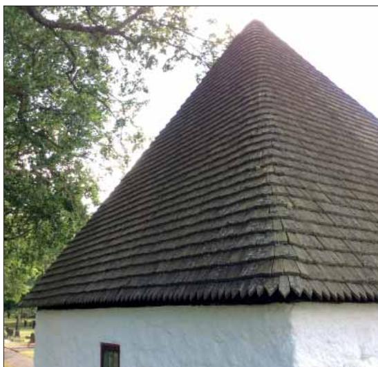
Tångeråsa gravkapell. Gravkapellet sett från öster. Takfallens hörn är lagda med runda hörn i solfjädertäckning.
