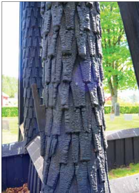
Sättersta klockstapel. Spånen med olika form och storlek på en av klockstapelns hjärtstolpar.
