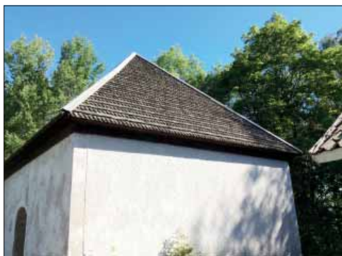
Hardemo sockenmagasin. Sockenmagasinets pyramidtak är liksom tornets spåntäckt. Spåntäckningen är mönsterlagd med varannan rad med omväxlande raka respektive näbbspån.
