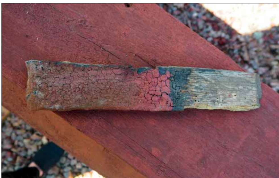
Mörkö klockstapel. Löst spån. Under rödtjäran finns skikt av svart tjära.
