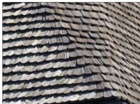
Lista kyrka. Detalj av gravkorets spåntäckning.
