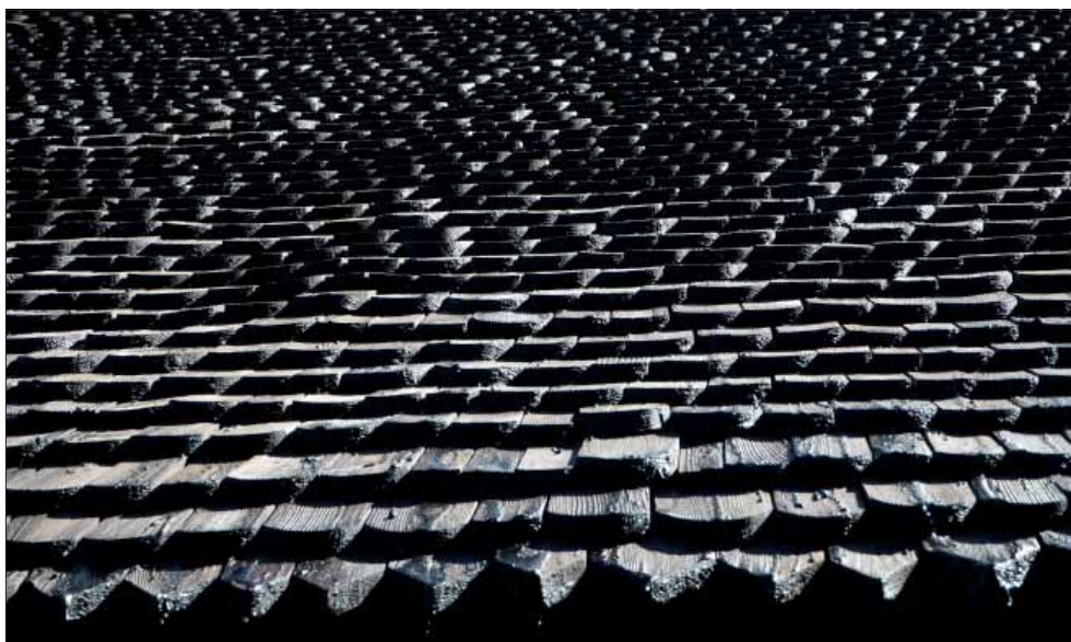
Grödinge kyrka. Detalj av sakristians västra takfall.
