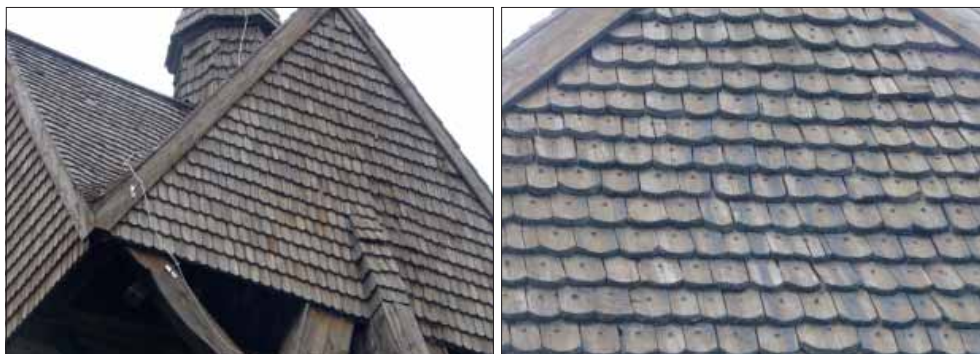
Floda klockstapel. Huvens fasad och tak (t.v.) och detalj av spån på huvens fasad (t.h.).
