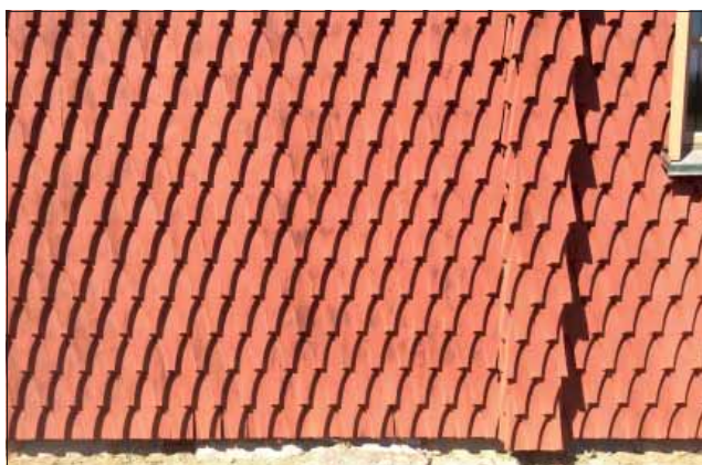
Kvistbro kyrka. Långhusets fasad sedd från söder. Även knutbrädorna är spåninklädda.
