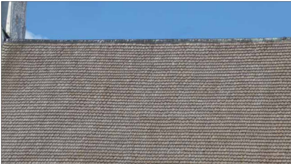
Gillberga kyrka. Långhusets södra takfall.
