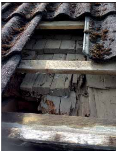
Tångeråsa bårhus. Bårhusets tegeltak har en äldre spåntäckning under.
