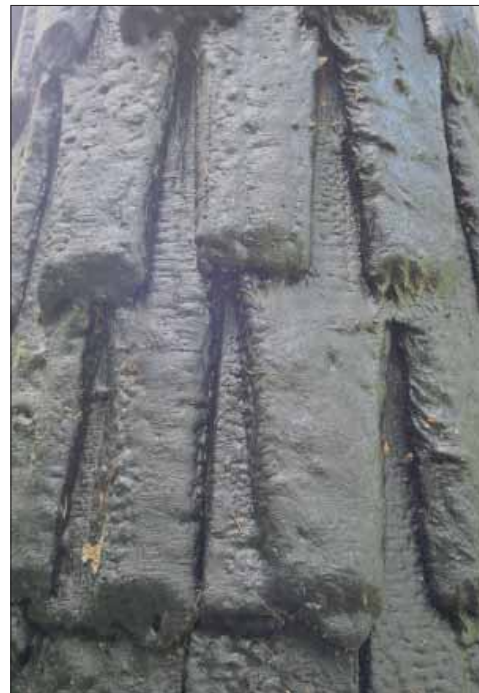
Bälinge klockstapel. Detalj av span på en av hjärtstolparna. Notera hur spänen mitt i bilden är lagda.
