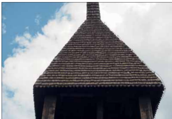
Runtuna klockstapel. Spån på klockstapelns huv.
