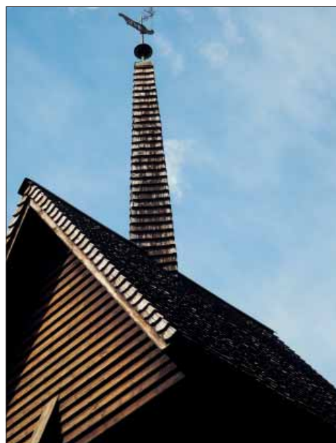
Säby begravningsplats. Vindskivespån på klockstapelns huv. Foto från sydöst.
