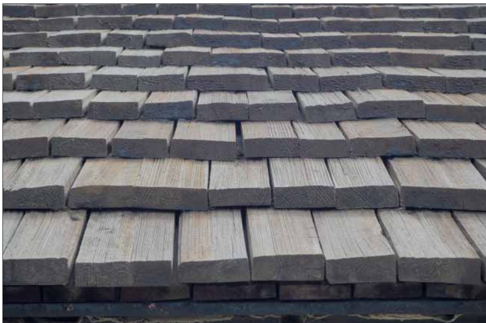
Bälinge kyrka. Detalj av spån på vapenhusets västra takfall.
