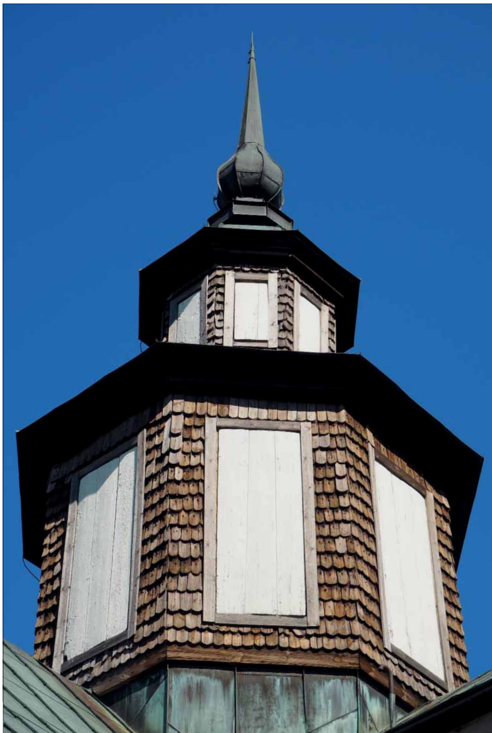
Ludgo kyrka. Tornets spänklädda fasad från sydöst. Två olika generationer av spån finns, de äldre med synlig spikning och de yngre med dold infästning.
