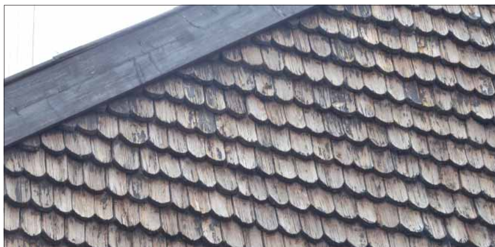
Dunkers kyrka. Spånparti på fasad.
