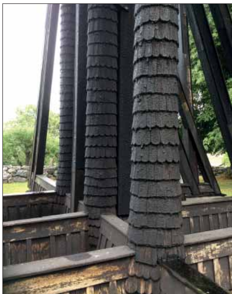
Bärbo klockstapel. Omväxlande rundade och raka spån på hjärtstolparna.
