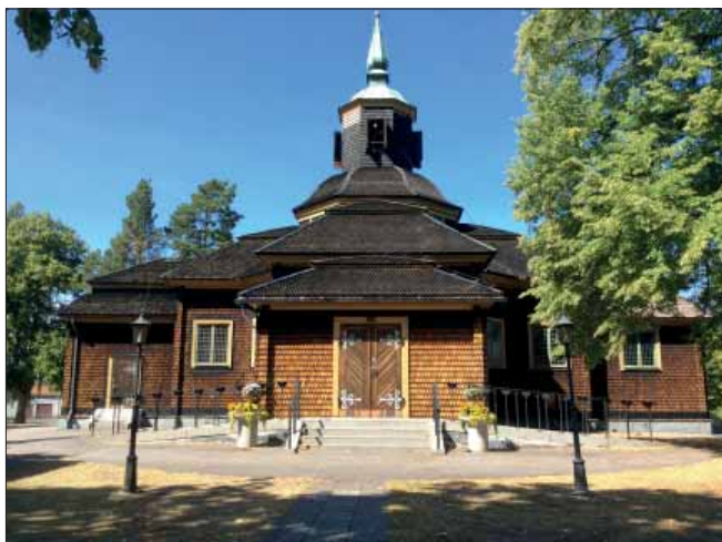
Ramundeboda kyrka. År 1991 byggdes den södra korsarmen till och spånen dateras här till 1991–1992.
