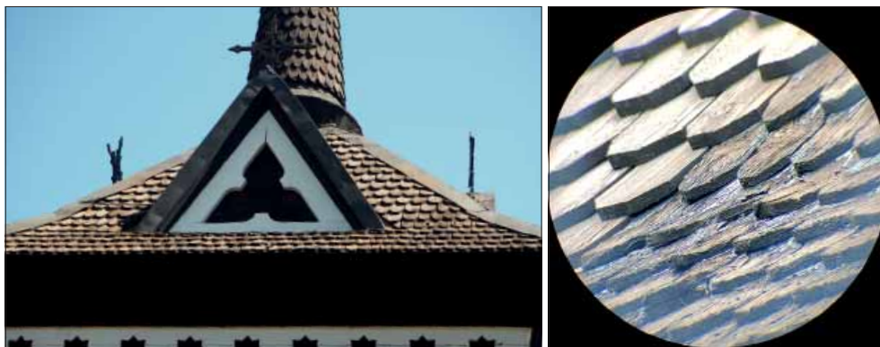
Taxinge klockstapel. Notera skillnaden mellan äldre och yngre spån på huven.
