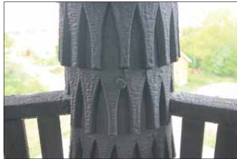
Västermo klockstapel. Näbbformade spån på pelare.
