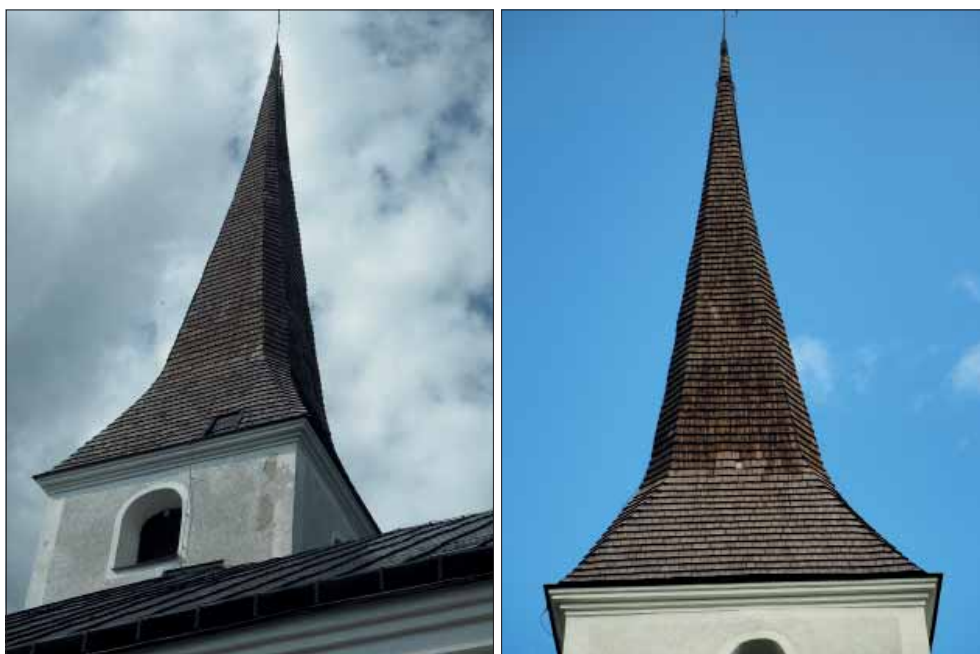
Aspö kyrka. Den spåntäckta tornspiran från sydöst respektive väster.
