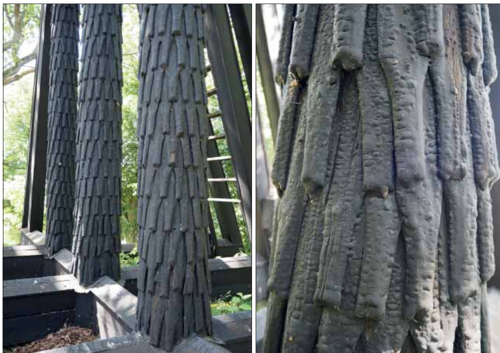
Lästringe klockstapel. Spånklädda hjärtstolpar (t.v.). Detalj av näbbformade spån på en hjärtstolpe. Synlig infästning och ett tjockt tjärskikt (t.h.).
