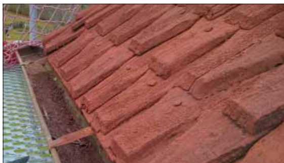
Figur 50. Takspån på ett av korets nordöstra takfall. Fotskiftet består av raka spån som ligger kant i kant med de ovanliggande näbbformade spånens baser. Foto Lars Jönnes.
