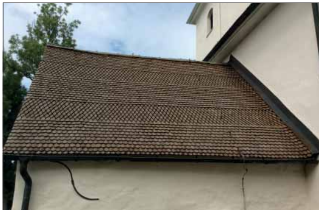
Viby kyrka. Vapenhusets östra takfall. Partier med runda och spetsiga spån varvas och bildar mönsterläggningen som är karaktäristisk för hela kyrkan.
