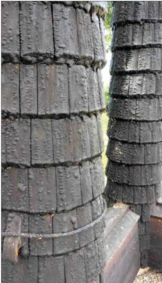
Vrena klockstapel. Hjärtstolparnas spåntäckning.
