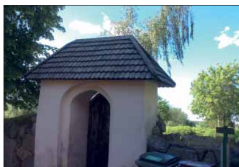
Hovsta stiglucka. Stigluckan har spetsiga spån med fasad kant, liksom långhuset.
