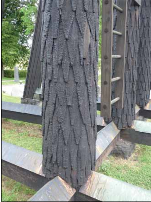
Sköldinge klockstapel. Hjärtstolparnas spåntäckning.
