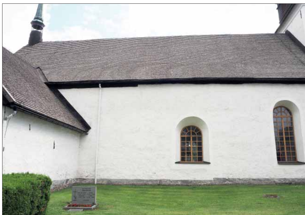
Vansö kyrka. Långhusets norra takfall.
