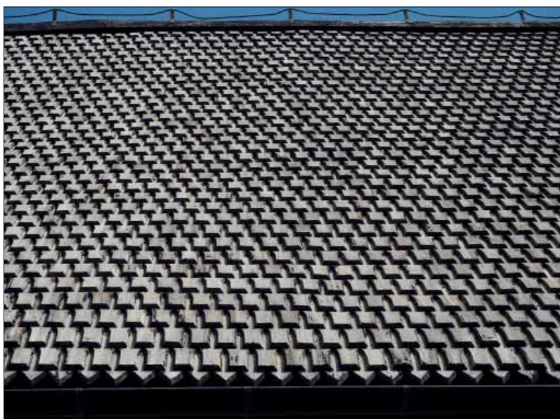
Vallby kyrka. Närbild på vapenhusets västra takfall.
