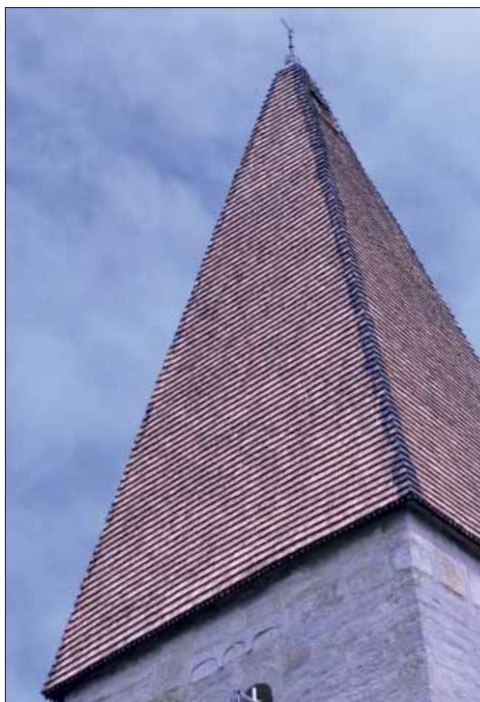
Hardemo kyrka. Tornhuvens nedersta spånvarv utgörs av spetsspån.
