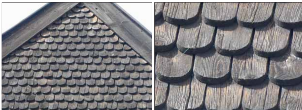
Halla klockstapel. Fasadspån på huv.
