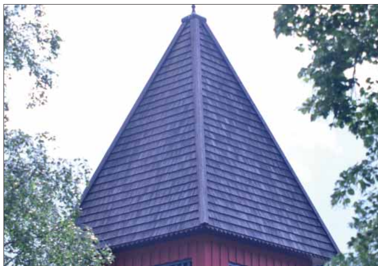
Mullhyttans klockstapel. Klockstapelns uppfördes 1930 och fick ett spånklätt tak. Spåntäckningen utgörs av raka spån och kantas nedtill av spetsspån.
