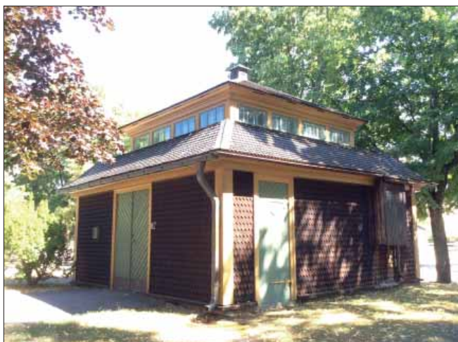
Ramundeboda bårhus. Bårhusets tak och fasader är klädda med spetsiga spån.
