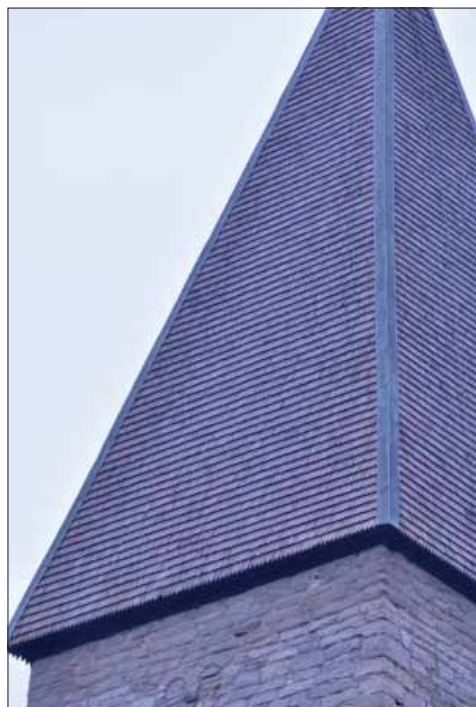
Mosjö kyrka. Torntakets västra takfall. Tillsammans med östra och södra takfallet saknas den mönsterläggning som återfinns på norra sidan. Möjligen rör det sig om en äldre mönsterläggning som gått förlorad.
