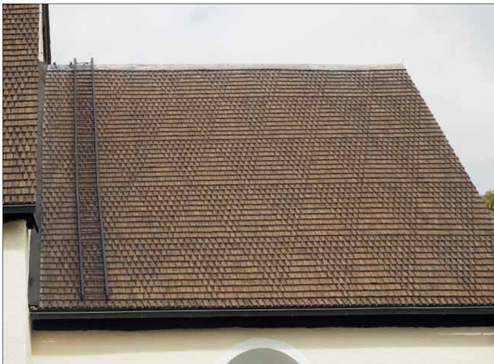
Tuna kyrka. Korets södra takfall.
