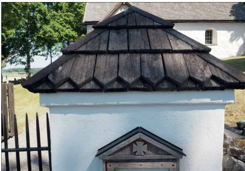
Spelviks grindstolpar. Grindstolpe med spånklädd täckning.
