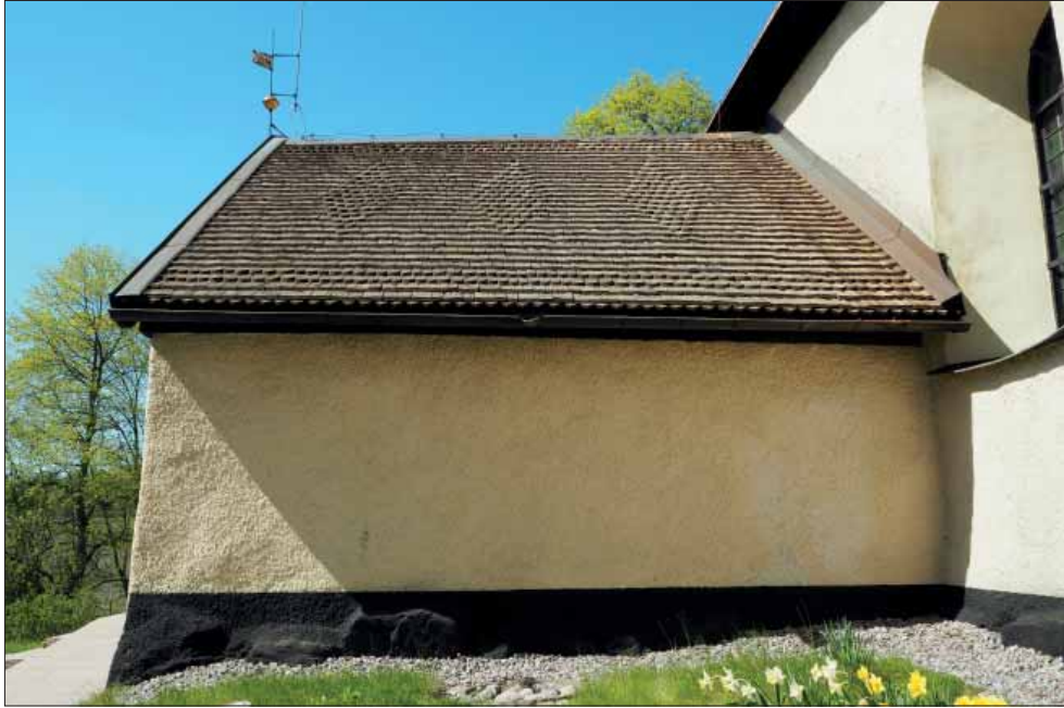
Salems kyrka. Vapenhusets östra takfall.
