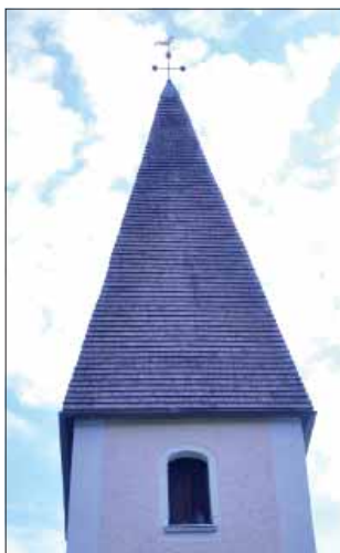
Norrbyås kyrka. Den äldsta spåntäckningen finns i väster. Här är också tjärrester synliga.
