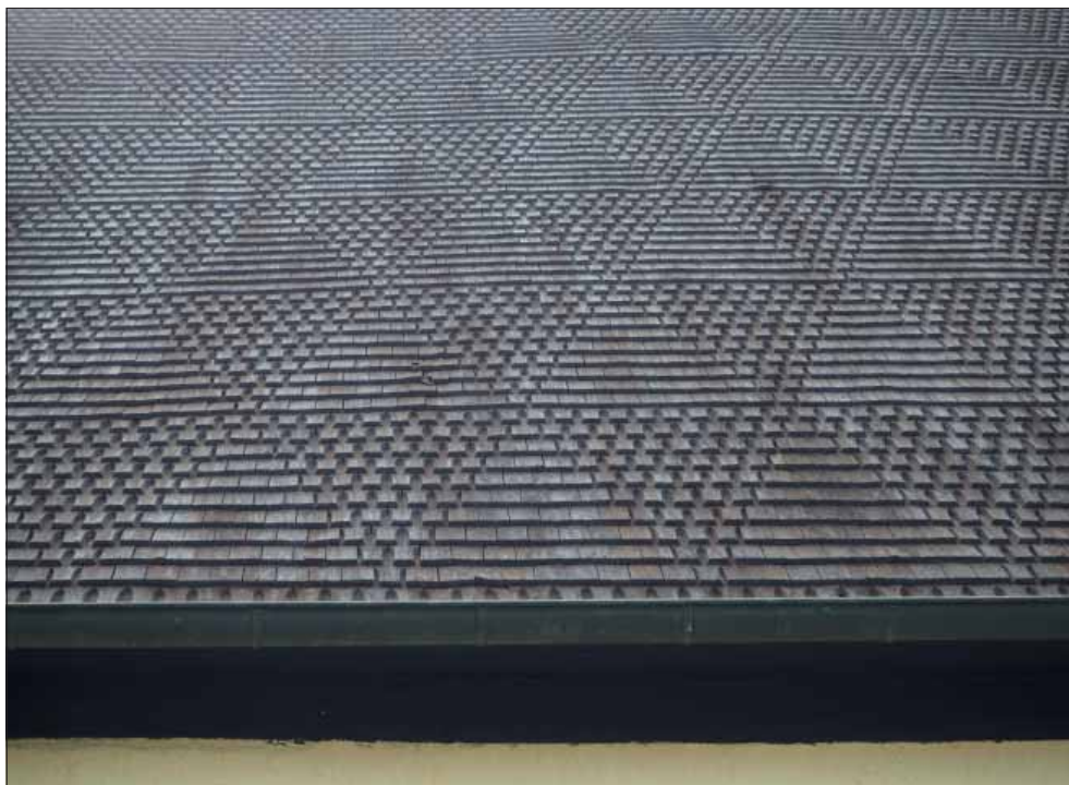
Tuna kyrka. Långhusets norra takfall med mönsterläggning.
