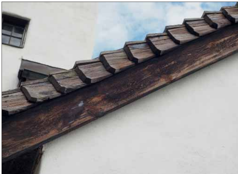
Ytterenhörna kyrka. Vapenhusets vind- skivespån före tjär- ning. Foto från söder.
