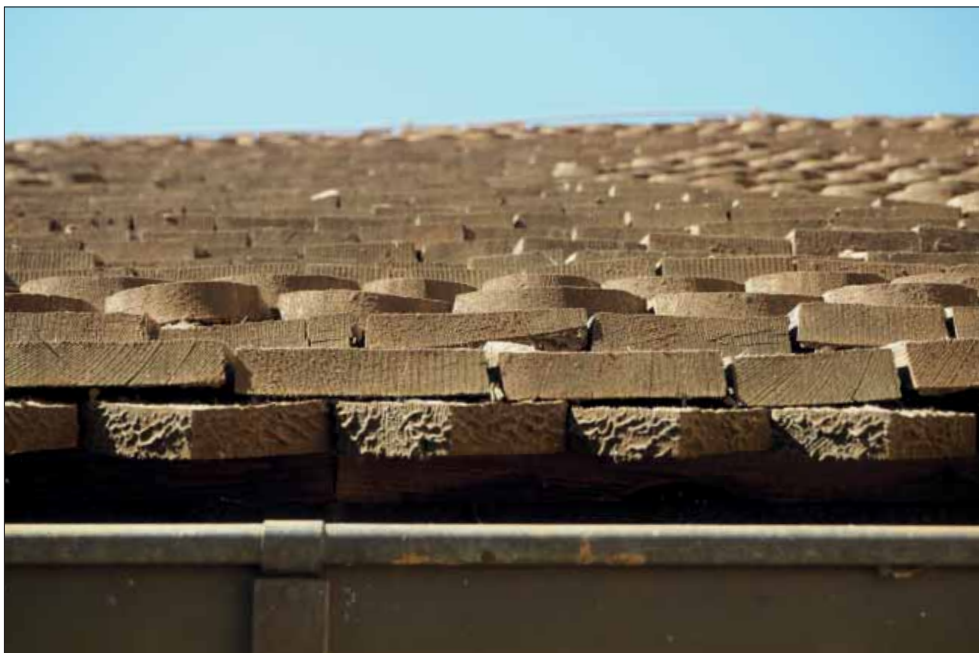
Salems kyrka. Detalj, vapenhusets östra takfall.
