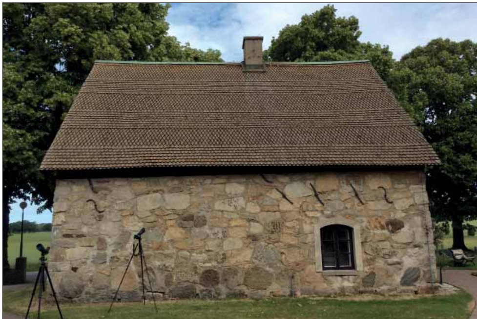
Viby bårhus. Bårhuset, det före detta sockenmagasinet, har mönsterlagt spån liksom kyrkan. Foto från söder.
