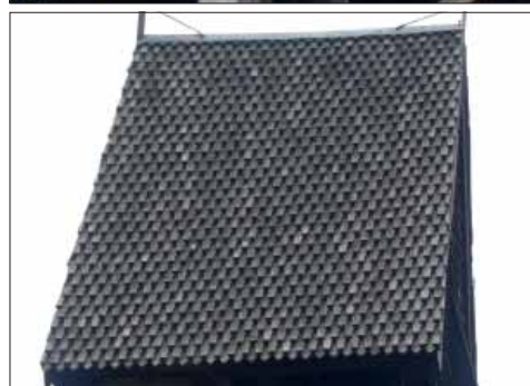
Helgesta klockstapel. Modernare näbbspån på huvens fasader och takfall.
