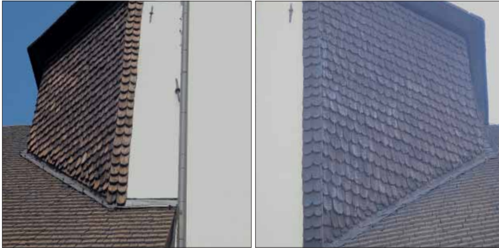
Bälunge kyrka. Tornets spånklädda fasad från nordväst (t.v.) och sydväst (t.h.)
