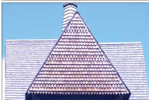
Kräcklinge klockstapel. Takspånen har raka spån med en rad spetsspån som avslutning nedtill. Huvens fasader har mönsterlagda spåntäckningar i väder med spån som är rundade, näbbformade, spetsiga och raka.
