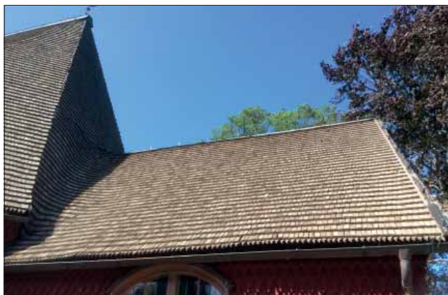
Kvistbro kyrka. Korets södra takfall. Notera uppsvingningen mot långhuset.
