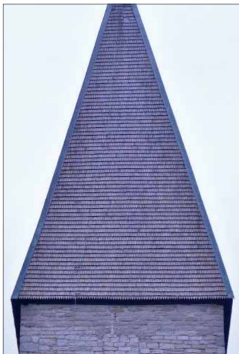
Mosjö kyrka. De östra, västra och södra takfallen har rundat spån och kantas nedtill av spetsspån.
