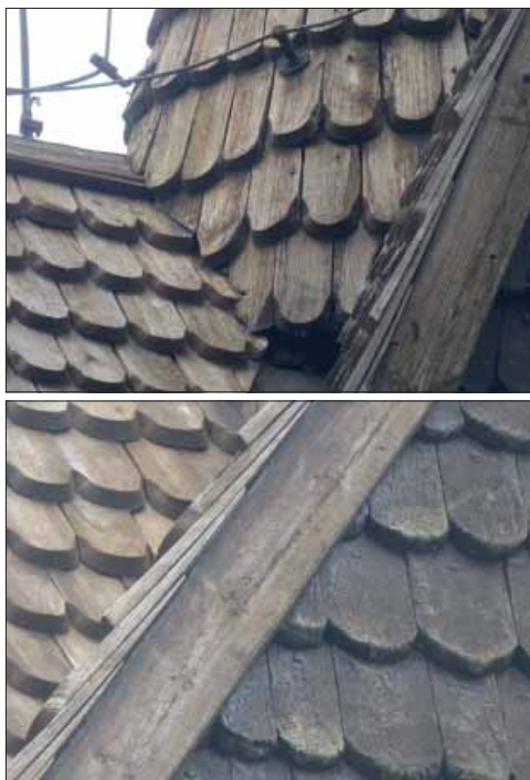
Lilla Malma klockstapel. Klockstapelns tak och spira. Detaljer som visar äldre spån på klockstapelns gavel och yngre takspån. Notera den synliga infästningen och lagret med tjära på fasadspånen.
