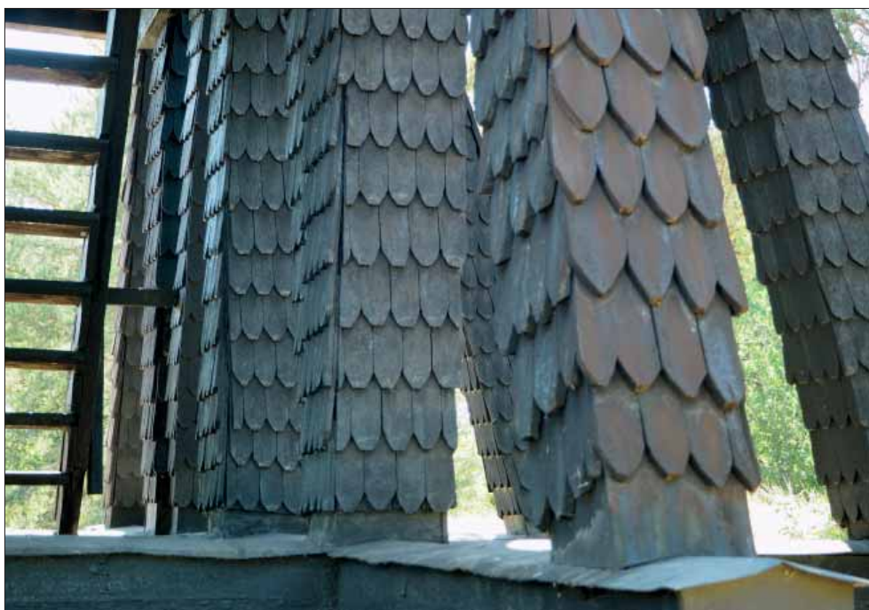
Taxinge klockstapel. Snedsträvor och hjärtstockar – yngre spån närmast i bild. Foto från nordöst.
