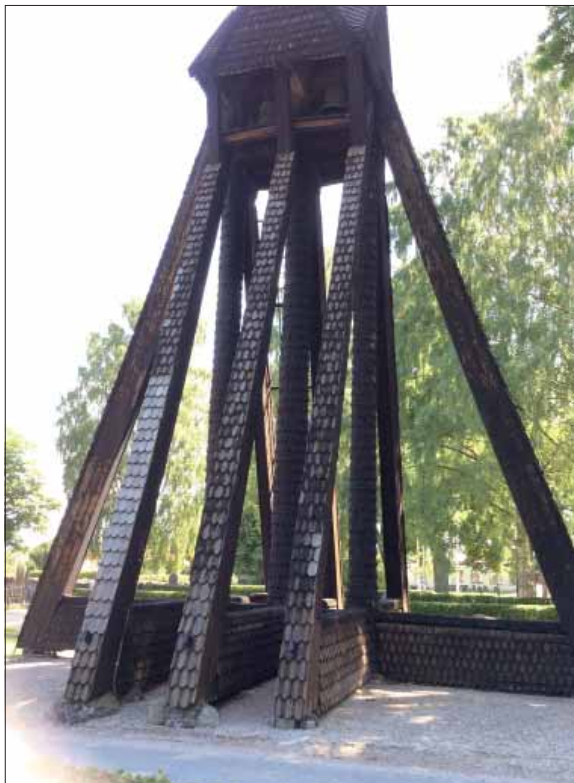
Almby klockstapel. På strävorna återfinns klockstapelns yngsta spån.
