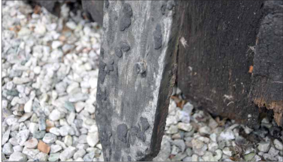
Figur 24. Spån med träplugg för infästning från Kvikne kyrka i Norge. Pluggen är förskjuten från spånets centrum och sitter högre upp i jämförelse med spånspiken som vanligen placeras i spånets centrum längre ner på den synliga delen av bleket. Foto Daniel Eriksson.
