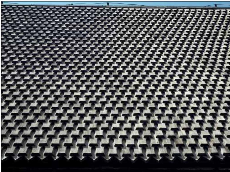
Vansö kyrka. Vapenhusets östra takfall.
