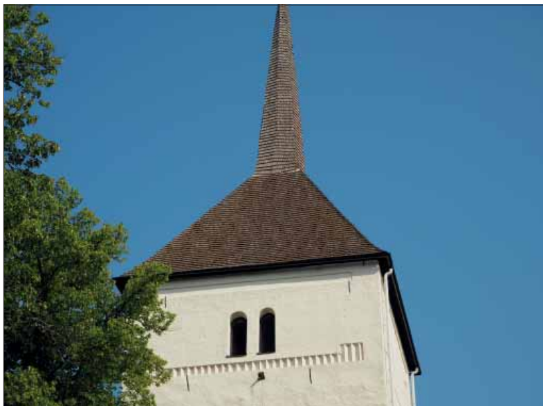
Överselö kyrka. Kyrkans torn med spåntäckt tak.
