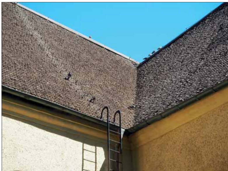
Fors kyrka. Spänklädd rännad mellan långhus och korsarm.
