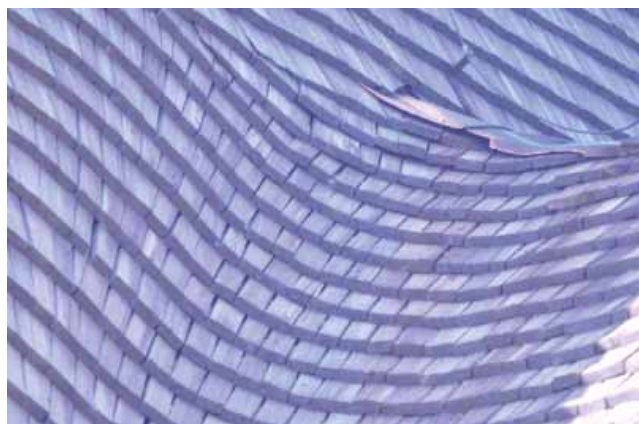
Kvistbro kyrka. Detalj av det uppsvängda taket mellan kor och långhus.
