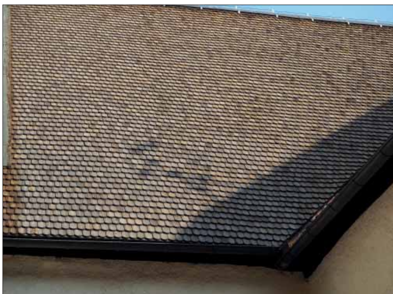
Överselö kyrka. Del av långhusets södra takfall.
