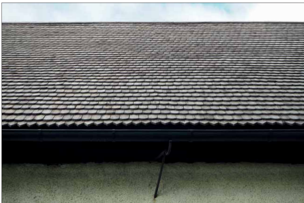
Härads kyrka. Spåntäckning på vapenhusets östra takfall.
