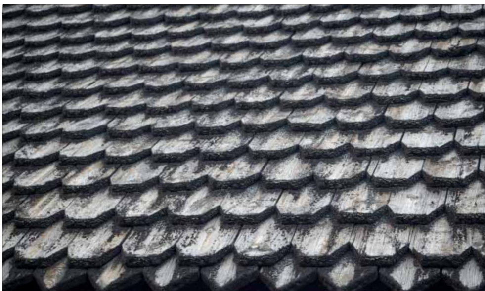
Ösmo kyrka. Långhusets södra takfall.
