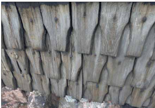
Floda klockstapel. Detalj av spån på klockstapelns syll.
