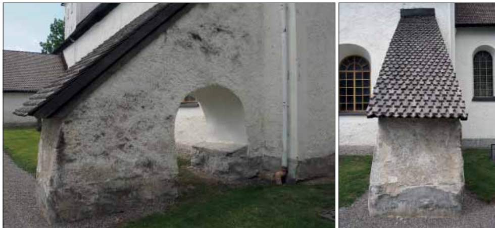
Vansö kyrka. En av de spåntäckta strävpelarna.
