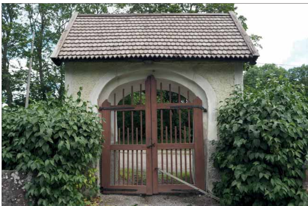
Häradstuglucker. Västra stugluckerens södra takfall.
