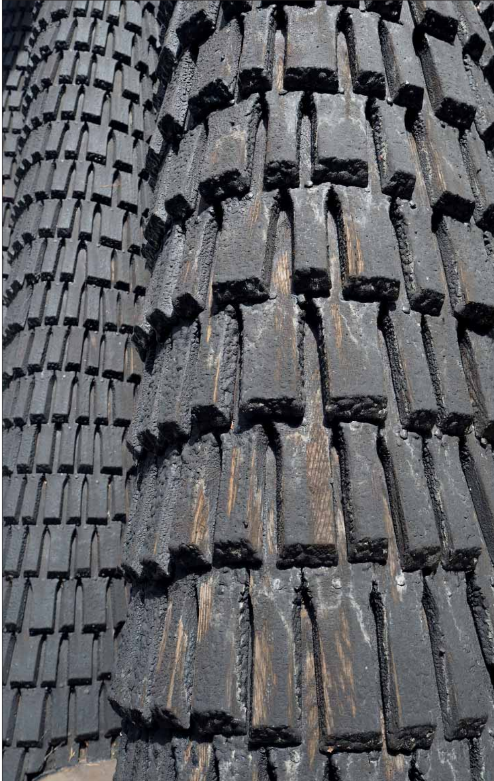
Barva klockstapel. Detalj av spåntäckning på hjärtstolpe.
