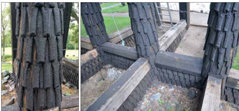
Forssa klockstapel. Näbbformade spån av hög ålder på klockstapelns hjärtstolpar.
