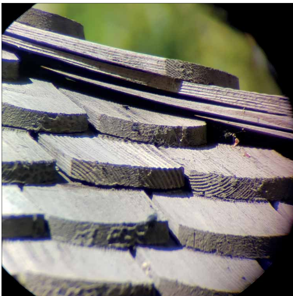
Toresunds klockstapel. Detalj av spån på klockstapelns östra takfall.
