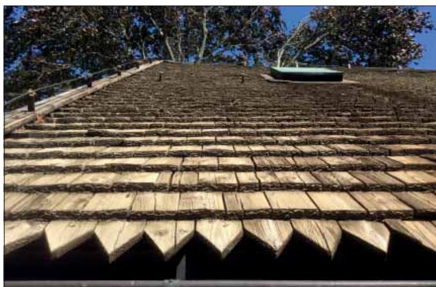
Kvistbro kyrka. Västra takfallet på sakristian har tunnare spån av ett annat träslag än furu, möjligen gran.
