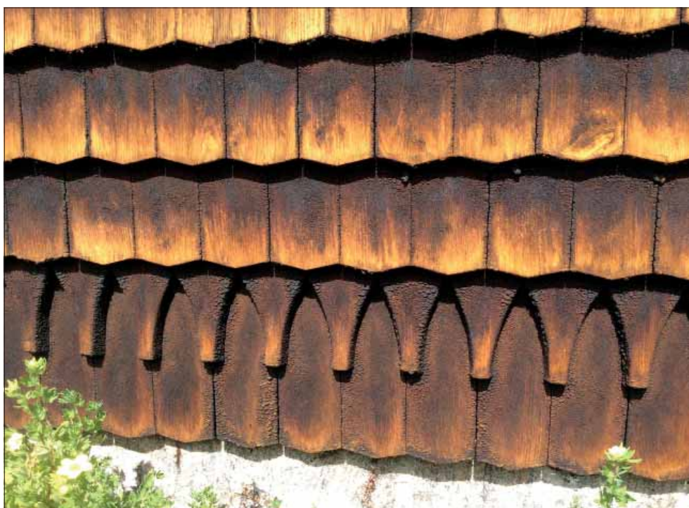
Adventskyrkan i Hjortkvarn. Näst nedersta spånvarvet på fasaden har näbbspån.
