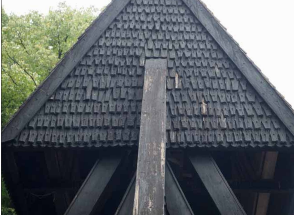
Bergshammars klockstapel. Huvens södra fasad med ålderdomliga spån, variation i spånens form och mått.
