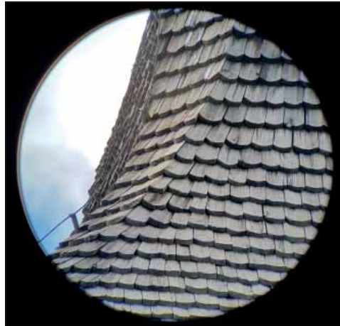
Vårdinge kyrka. Spån på tornets tak. Foto från norr.
