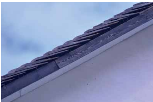
Viby kyrka. Detalj av långhusets spåntäckning som går ända ut i kanten.
