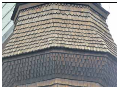
Sköldinge kyrka. Mönsterläggning på gravkorets tak.
