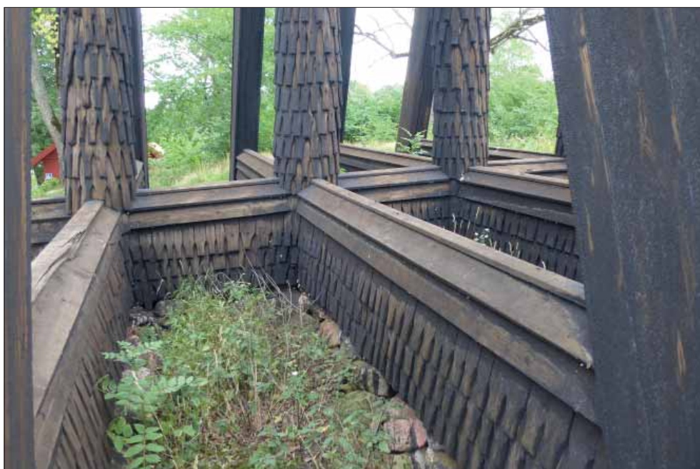
Floda klockstapel. Klockstapelns syll och hjärtstolpar är klädda med näbbformade spån av hög ålder.
