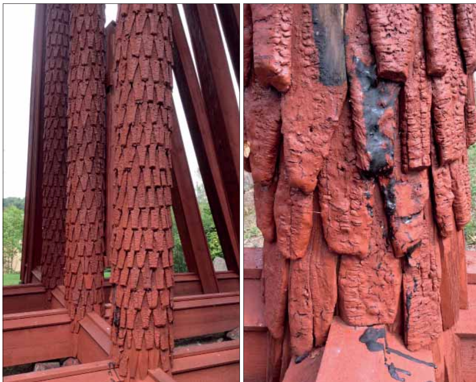
Husby-Oppunda klockstapel. Klockstapelns spänklädda hjärtstolpar.
