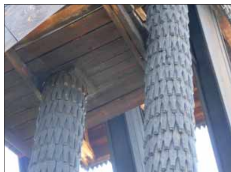
Lista klockstapel. Äldre näbbspån på klockstapelns hjärtstolpar.
