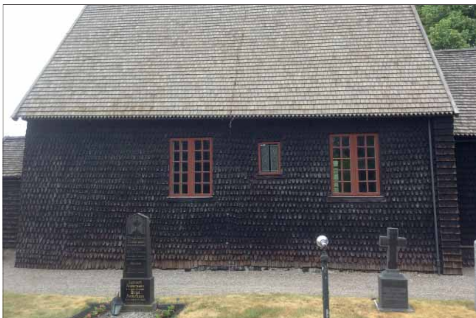
Tångeråsa kyrka. Långhusets södra fasad har en gråaktig yta till följd av att spånen på 1950-talet behandlades med Toptite.
