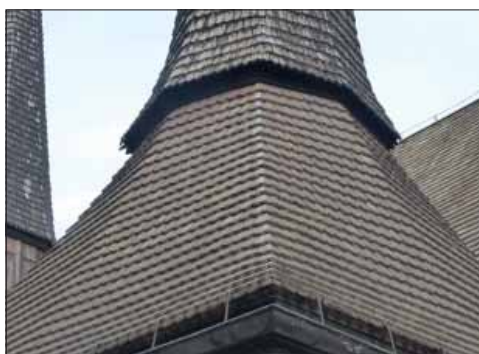
Ripsa kyrka. Gravkorets spånklädda tak.
