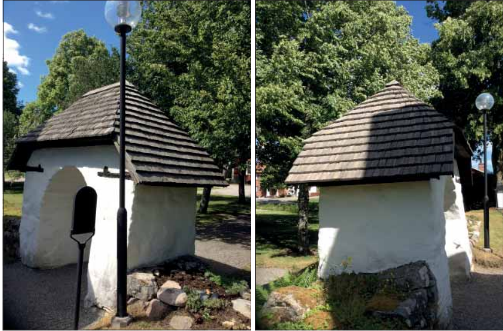
Täby stiglucka. Stigluckan uppfördes på 1760-talet med valmat spåntäckt sadeltak. Spånen är raka med kluven ovalsida.
