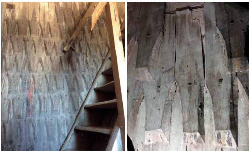
Skagershults gamla kyrka. Vapenhuset rymmer invändigt en äldre spåntäckning på långhuset, tillkommen före 1750-talet då vapenhuset byggdes.
