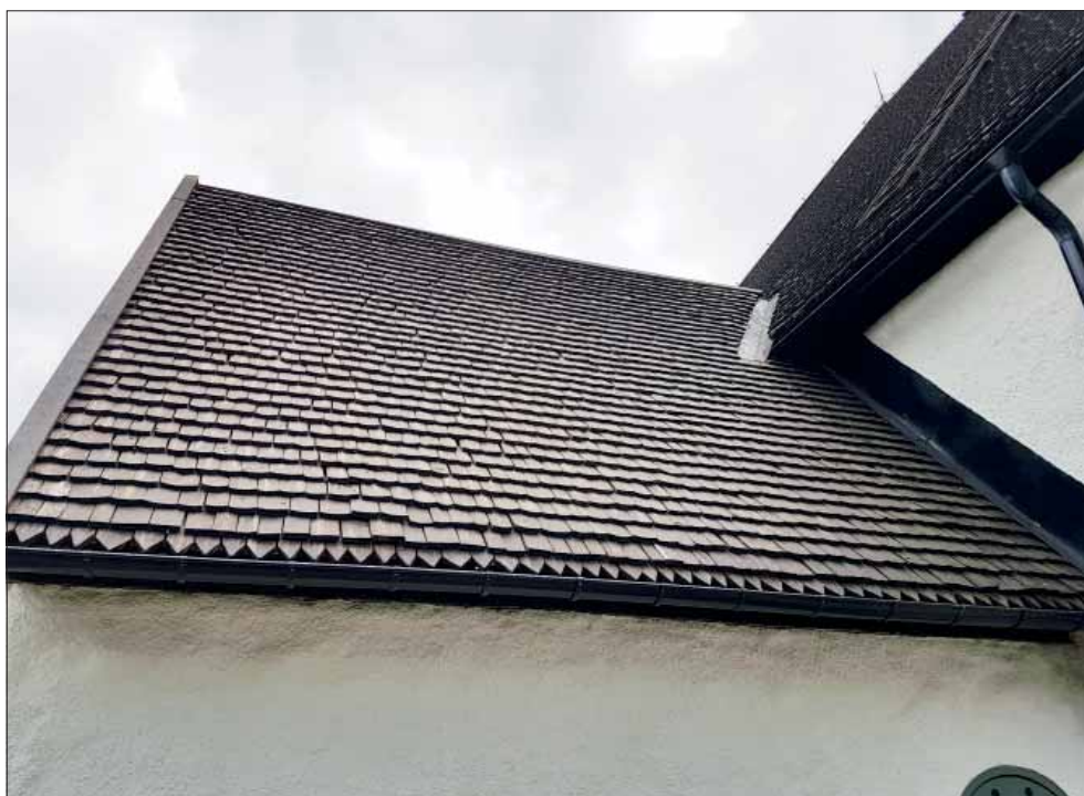
Åkers kyrka. Sakristians västra takfall.
