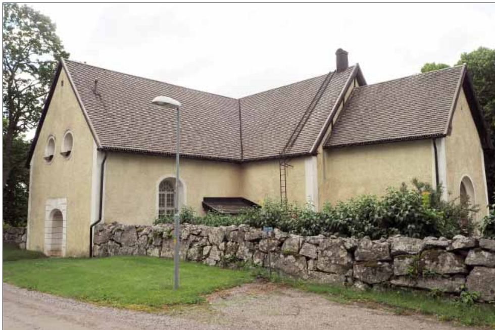
Härads kyrka. Vapenhusets östra takfall.
