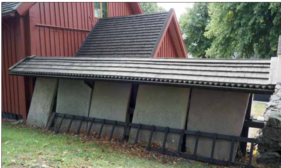
Tunabergs lapidarium. Spåntäckt tak över lapidarium.
