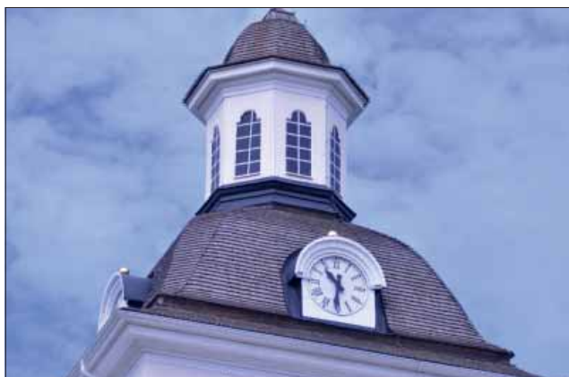
Viby kyrka. Kyrkans torn har återfått spåntäckningen efter att takmaterialet på 1980-talet ändrades till plåt.
