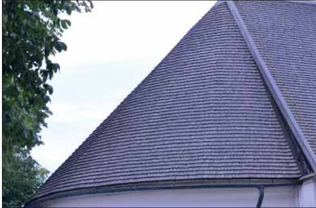
Lerbäcks kyrka. Korabsidens spåntak sett från norr.
