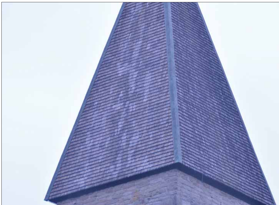
Mosjö kyrka. Norra takfallet bevarar en äldre spåntäckning av okänt datum.
