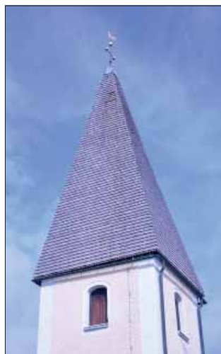
Norrbyås kyrka. Torntakets södra sida fick nya spjälkade spån 2010.
