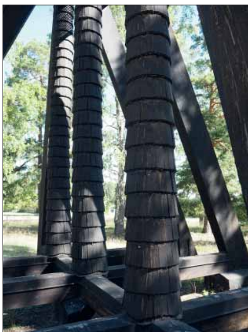
Hällby klockstapel. Trots att spånen på hjärtstolparna är från 1930-talet har ett tjockt tjärlager byggts upp.
