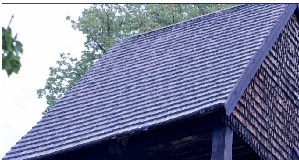
Bärbo klockstapel. Det västra takfallet med modernare spån.
