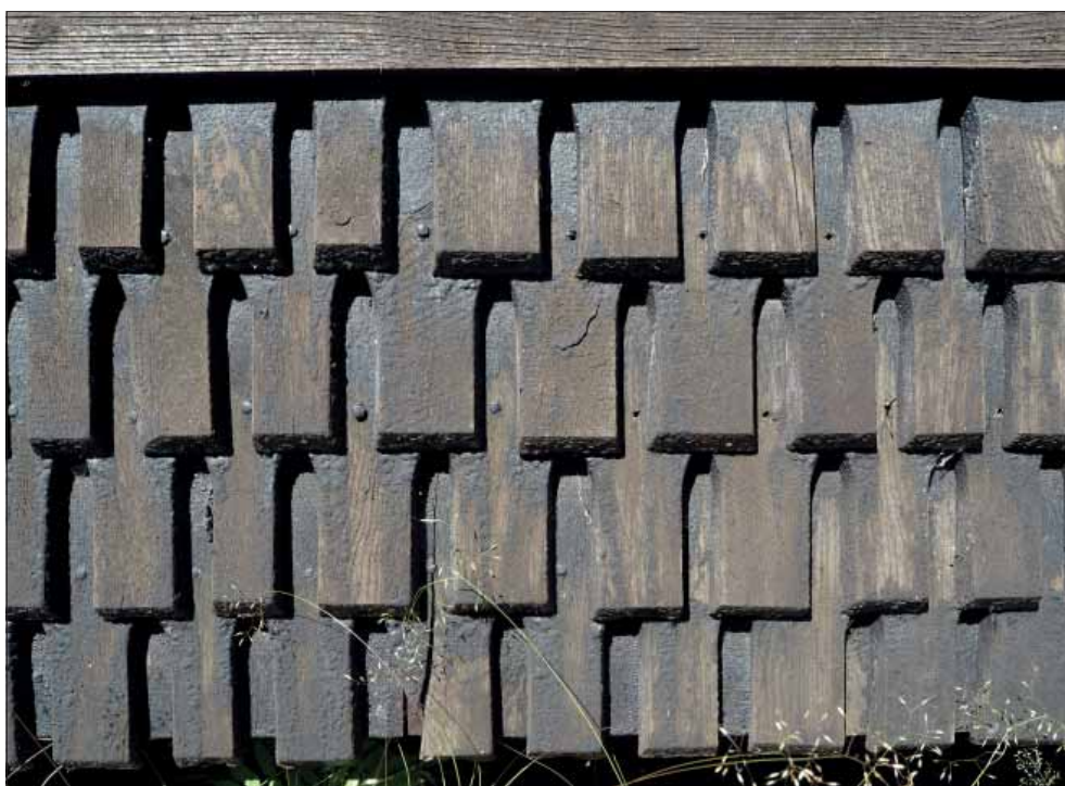
Barva klockstapel. Spåntäckning på syllen i sydöst. Notera att det finns hål i spånen som inte har använts för infästningen.
