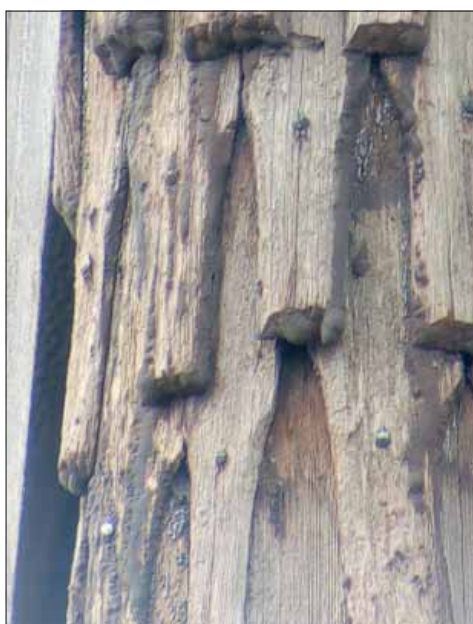
Vadsbro klockstapel. Näbbformade spån på hjärtstolpe.
