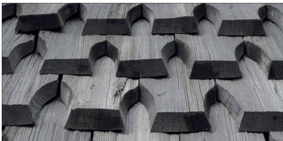
Vansö kyrka. Detalj av spån på strävpelaren.
