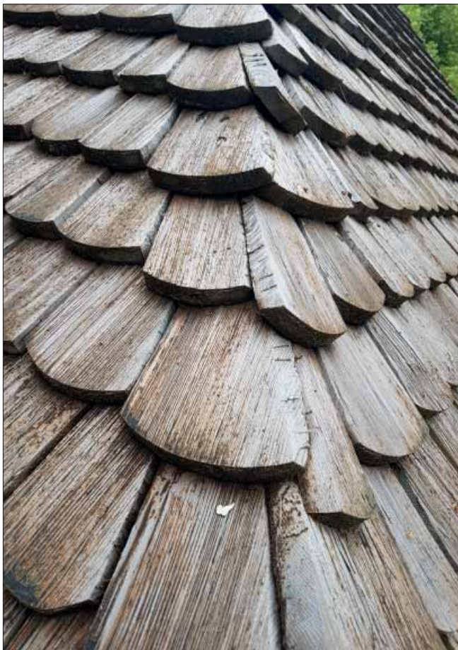
Åkers gravkapell. Späntäckning på gravkapellet, sydvästra hörnet.
