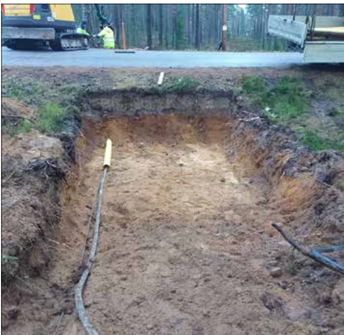
Figur 3. Ledningsschaktets sträckning längs med Flädervägen invid transformatorstationen. Från sydväst.
