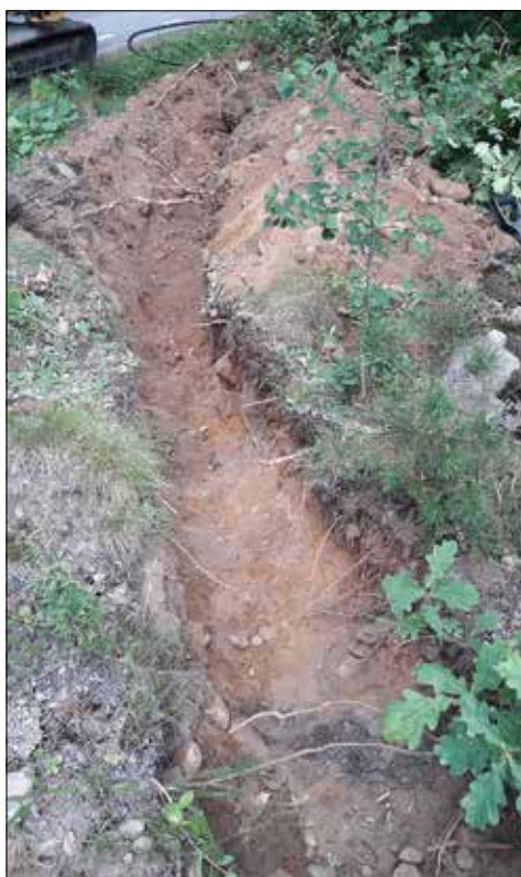
Figur 6. Schakt 2 i Sandviksvägen. Fotot mot norr av Mats Nelson.
