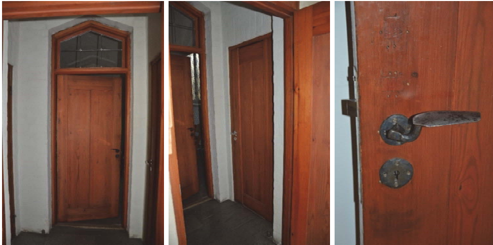
Figur 19. Dörr mot personalrummet.
