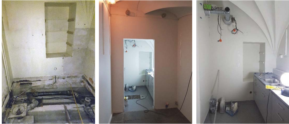
Figur 137. Golvet upptaget för att komma åt avloppet.
