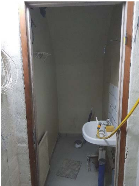
Figur 104. Personaltoalett under ombyggnad.
