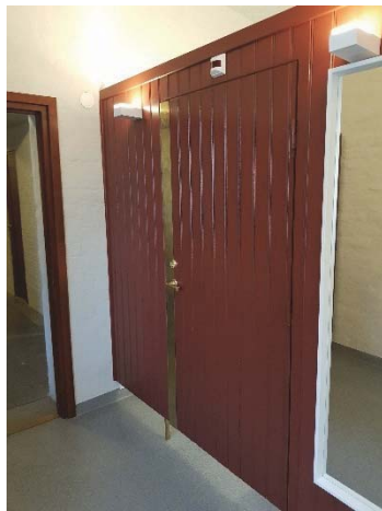
Figur 116. Dörr till RWC med tillgängligt beslag.
