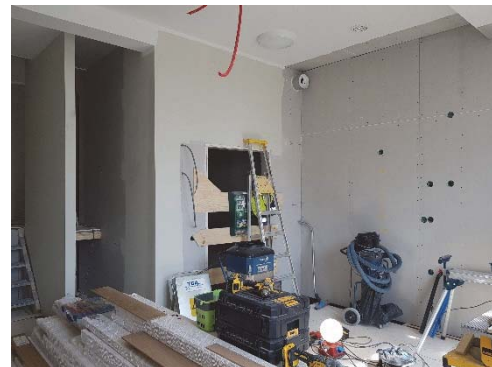
Figur 194. Hisschaktet sett mot nordväst. Figur 195. Nytt bjälklag och uppregling av vägg för montage av köksinredning.
