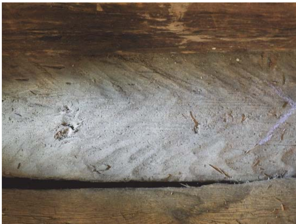
Figur 71. Bebuggen brüda ligger som en del av det lösa trägolvet. Kan möjligen vara medeltida.
