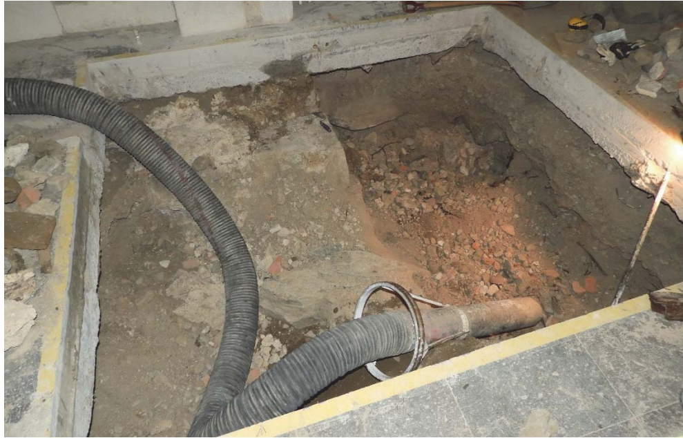
Figur 74. Hissgroppen vid grävarbeten. Sett mot sydöst.
