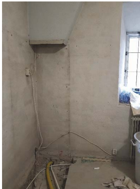
Figur 112. Ny håltagning under marknivån genom grunden för avlopp. Foto: Jonas Ros.
