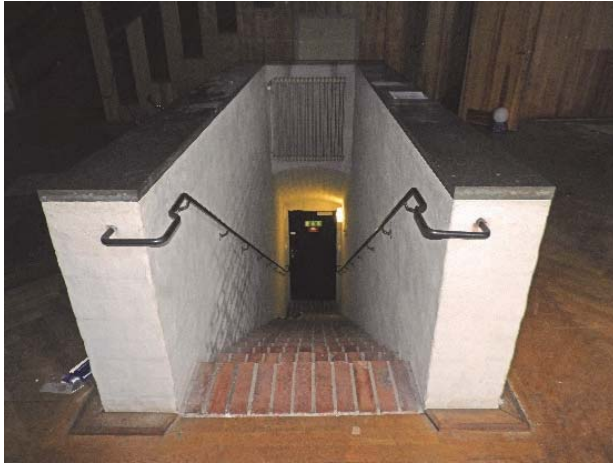
Figur 55. Trappan med murade sidor, kalkstensskivor och smidda ledstänger före åtgärder.
