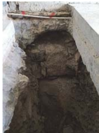
Figur 110. Utsugning av massor i nytt schakt för avlopp. Foto: Jonas Ros.
