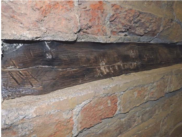
Figur 43. Inmurad, brandskadad bjälke i medeltida murverk, övre entresolplan.
