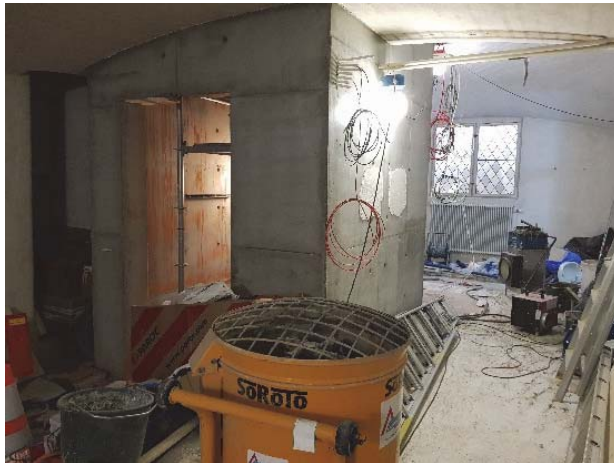
Figur 79. Hisschaktet lämnar ett öppet utrymme mot den äldre muren i öster.
