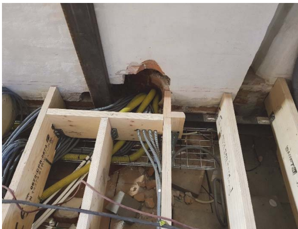
Figur 190. Förstorad håltagning.
