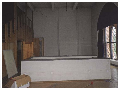
Figur 54. Trappan från bottenvåningen är murad i tegel och låg tidigare exponerad i rummet.
