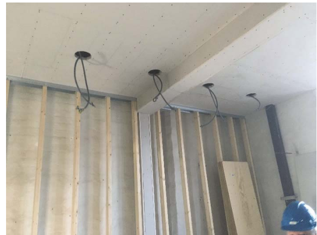
Figur 194. Hisschaktet sett mot nordväst. Figur 195. Nytt bjälklag och uppregling av vägg för montage av köksinredning.
