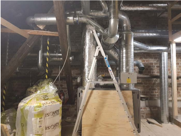
Figur 277. Ny ventilationsanläggning mot västvägg.
