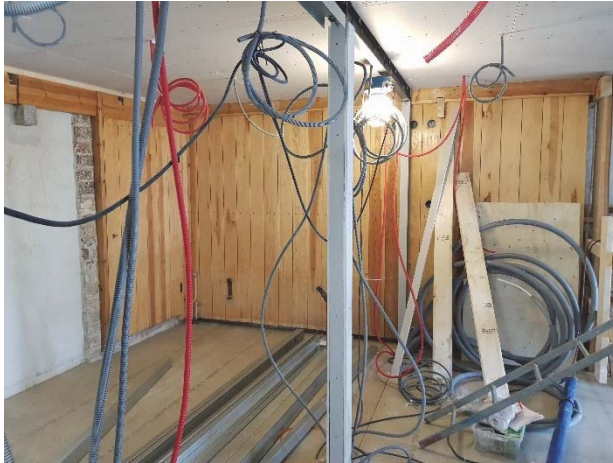
Figur 215. Regelstomme under uppförande för avgränsning mellan 210a och 210c.
