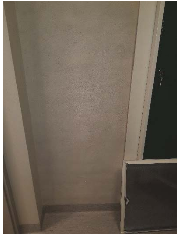
Figur 231. Äldre väggyta i söder.
