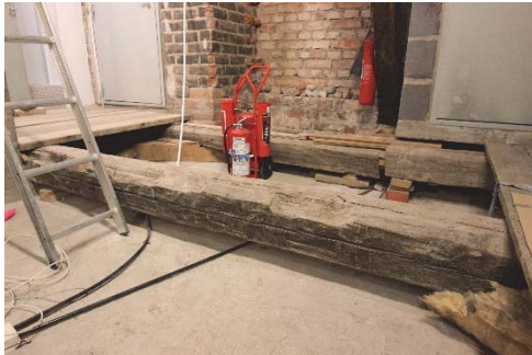
Figur 266. Bjälkar som kapats för att ge plats för hisschakt. Underliggande betongbjälklag. Figur 267. Rundade huggspår.
