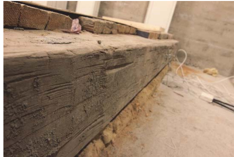
Figur 266. Bjälkar som kapats för att ge plats för hisschakt. Underliggande betongbjälklag. Figur 267. Rundade huggspår.
