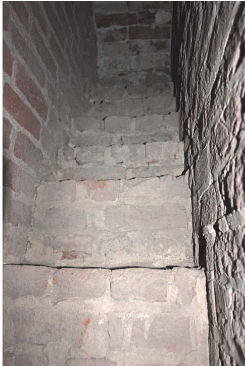
Figur 49. Den bevarade tornttrappan
