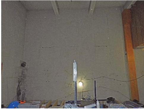
Figur 225. Före nytt bjälklag.
