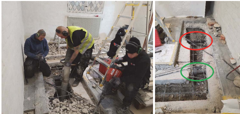
Figur 77. Bortsugning av massor för att komma åt avloppsstammar. Foto Jonas Ros.
