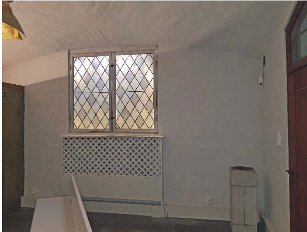
Figur 91. Södra väggen i ny sakristia.
