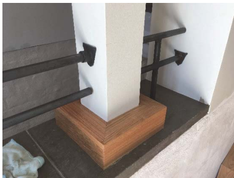
Figur 182. Den murade trappan har använts som stöd för nya stålpelare.
