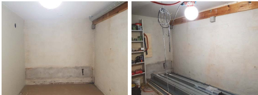
Figur 221. Putsad, äldre vägg mot väster och norr.
