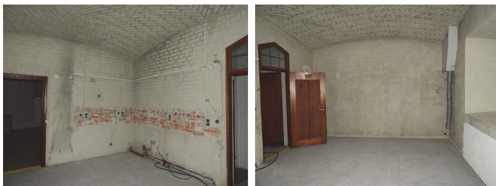
Figur 106. Den tidigare köksinredningen i personalrummets nordöstra hörn är demonterad.
