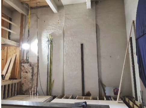
Figur 237. Östra väggen före nytt bjälklag.
