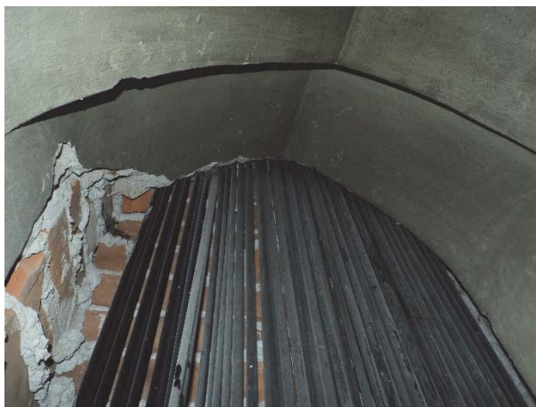
Figur 186. Övre delen av portalen sedd mot väster. Omfattande eldragningar från 1950-talet.
