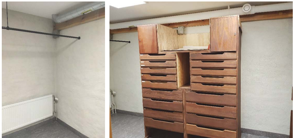
Figur 223. Väggarna avfärgade med gotlandskalk.
