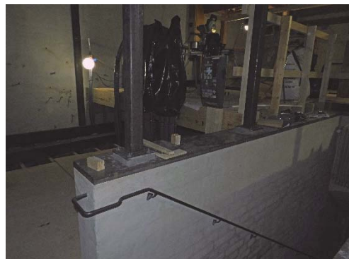
Figur 177. Diverse infästningar för tidigare museiföremål på västra väggen. Vissa fästjärn har kunnat tas bort hela medan andra måste kapas av.
