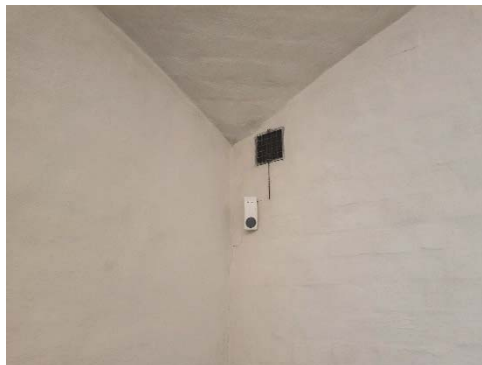
Figur 89. Äldre ventilationsgaller bevarat. Befintlig rörelsedektor återmonterad.
