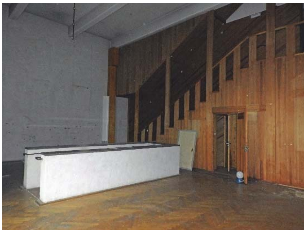
Figur 148. Trappan sedd från sydöst före åtgärder.
