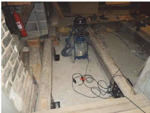
Figur 268. De två bjälkar som kapats för hissen. Figur 269. Isolerat utrymme mellan bjälklaget för fläktrummet och betongbjälklag mot tidigare museet.
