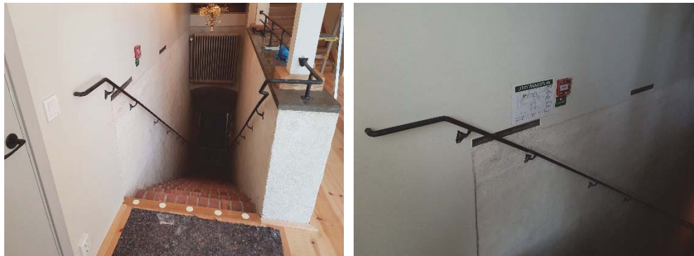
Figur 203. Trappan förlängd med ett steg. Räcke anpassat efter den nya väggen till vänster och den längre trappan, jämför med figur 55.
