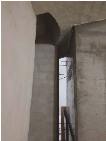
Figur 79. Hisschaktet lämnar ett öppet utrymme mot den äldre muren i öster.
