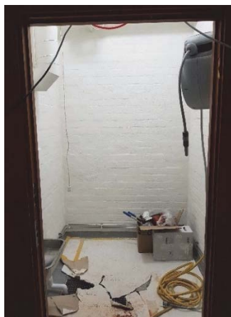
Figur 127. Rengjorda väggar 132B.
