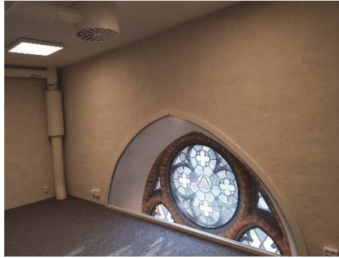
Figur 241. Framför fönstret sitter ett fallskydd av lamellglas, fäst med en trälist.
