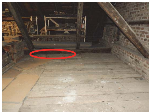
Figur 69. Enstaka äldre bräder i golvet med spår efter kransågning. Figur 70. Löst liggande golv sett mot söder. Läge för behuggen bräda.
