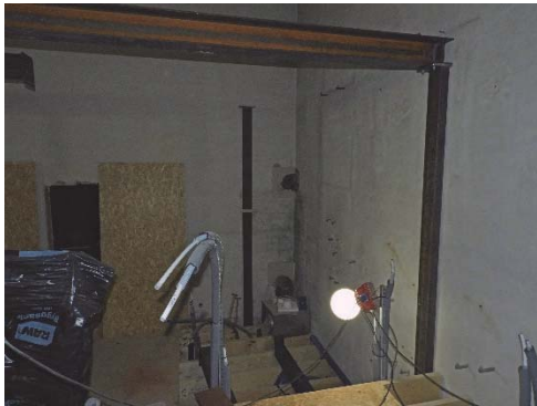
Figur 180. Stålpelare på västra väggen och södra väggen.
