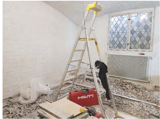
Figur 76. Delar av golvet har tagits upp för att komma åt avloppsstammarna.
