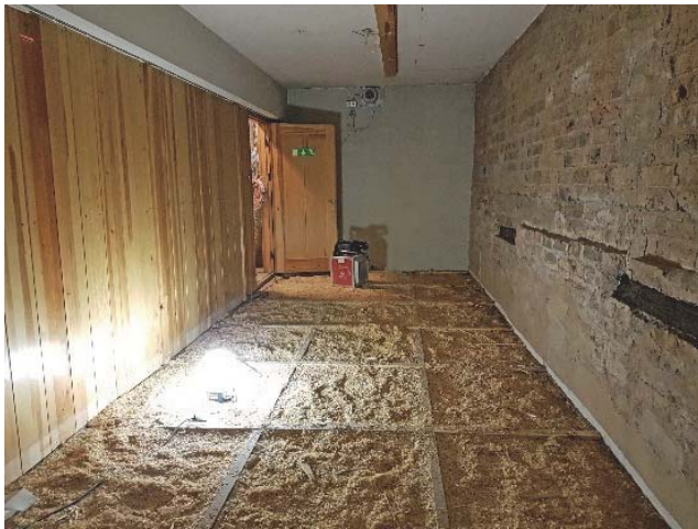
Figur 151. Demonterat golv och monter i entresolens övre plan. Spånfüllt bjälklag. Figur 152. Trappa mot vinden.
