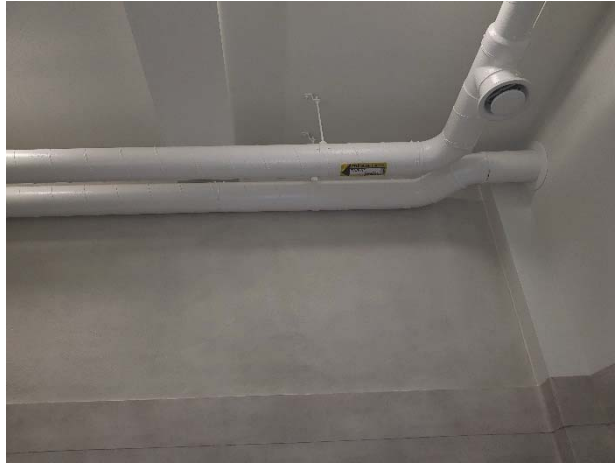
Figur 236. Vätrumsattan uppdragen två meter. I övrigt har väggarna lämnats.
