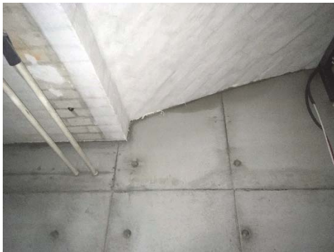
Figur 83. Anslutning valv i vestibul, mot hisschaktets västra vägg. Befintligt dragstag.
