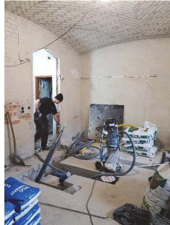
Figur 109. Dörrkarm demonterad. Golvet är delvis uppbilat för avloppsdragning.
