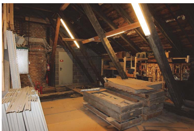
Figur 61. Plan 4 sett mot sydöst. I bortre hörnet syns orgelpumprummet som är uppfört i lättbetong.
