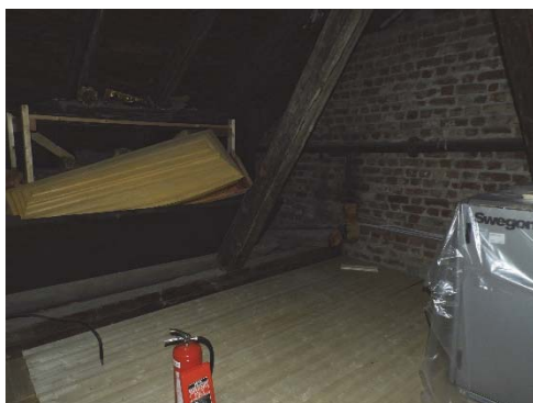
Figur 275. Nytt trägolv lagt över befintligt.
