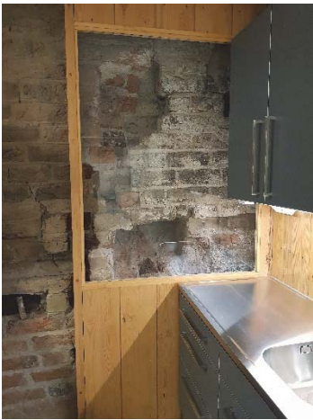
Figur 247. den nya inredningen är placerad invid den gamla dörren. Dörrens panel är delvis ersatt med en glasskiva för att inte dölja de historiska spåren.
