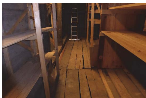
Figur 63. Löst liggande golvvirke på plan 4, norra sidan mot väster, före åtgärder.
