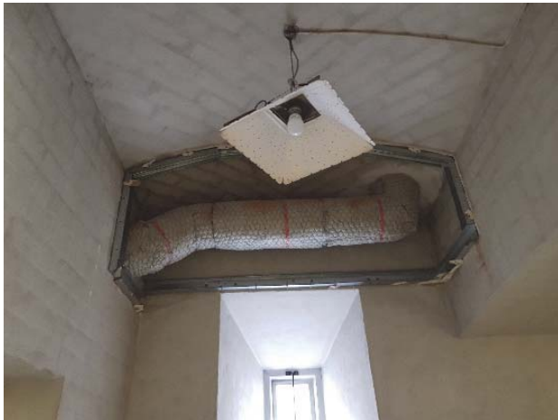
Figur 132. Befintlig kanalisering för ventilationen riven 132A.
