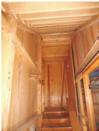
Figur 160. Nedmontering av panel.
