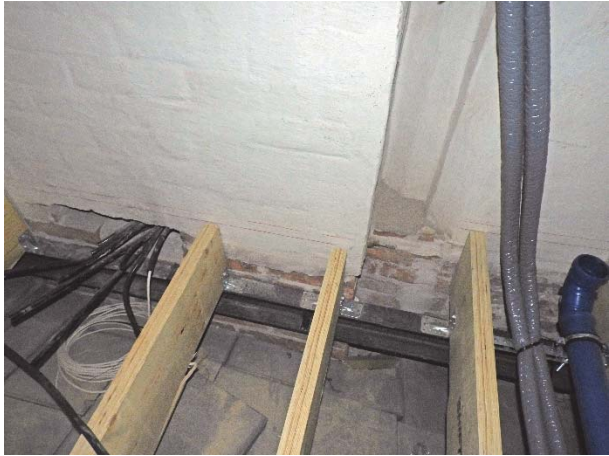
Figur 188. Befintligt hål för eldragningar på plan 2 är för litet.
