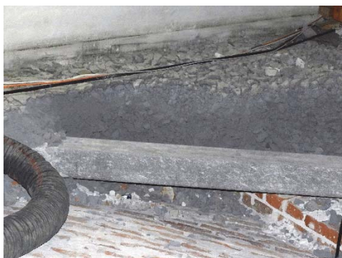
Figur 166. Valven var täckta med krossad blåbetong. Det förekom även eternitkanaler.
