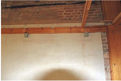
Figur 205. Efter rivning av entresolbjälklag.
