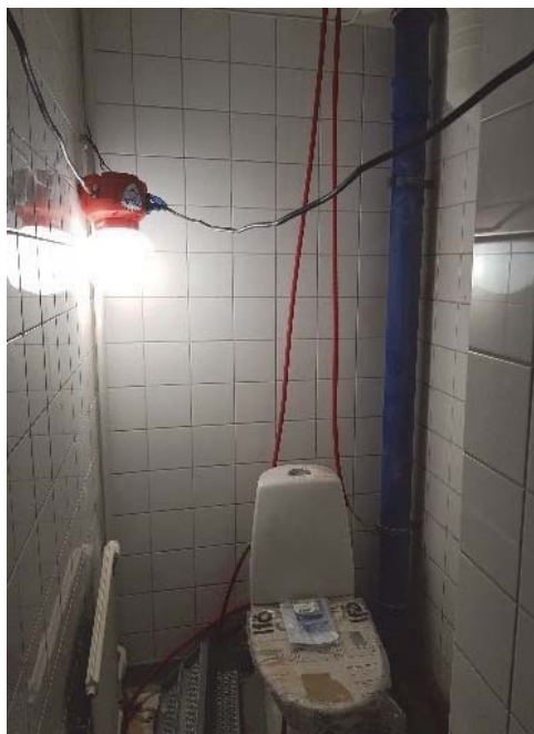
Figur 130. Toalett under ombyggnad 132C.
