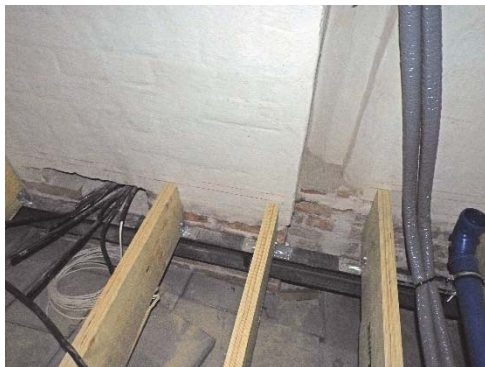
Figur 176. Nya kertobalkar för den nya golvkonstruktionen.
