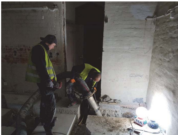
Figur 110. Utsugning av massor i nytt schakt för avlopp. Foto: Jonas Ros.
