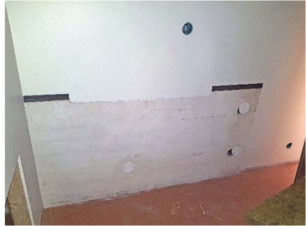
Figur 232. Spår efter trappans sidostycke, påbyggt med nytt väggparti.
