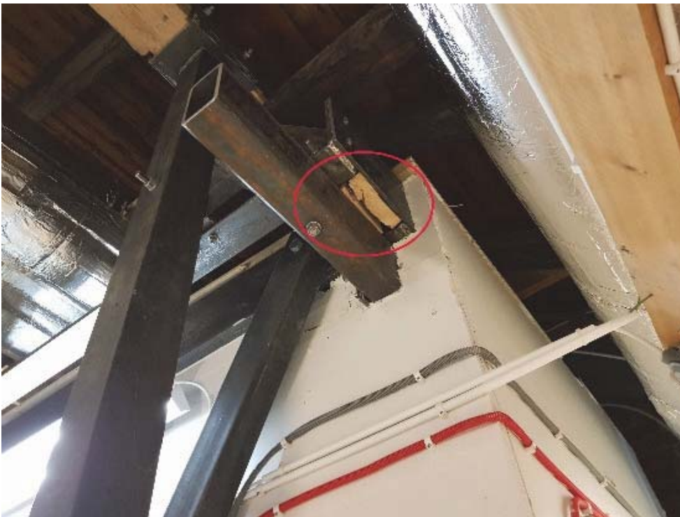
Figur 279. Avskapat stödben till takstolen inringat. Konstruktionen är avlastad på stälpelare och stålbalkar i hisschaket.
