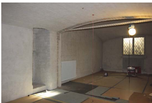
Figur 72. Tidigare vickvägg har rivits. I valvets övre del syns befintligt dragstag.
