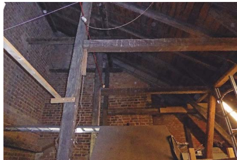
Figur 67. Nordvästra hörnet efter borttaget trägolv. Befintligt betongbjälklag och ventilationskanal. Observera spåren efter en igensatt, välvd öppning i det västra murverket. Medeltida murverk till höger (norr) och till större delen något nyare murverk rakt fram (väster). Figur 68. Takstolar sett mot öster.
