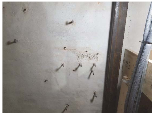
Figur 177. Diverse infästningar för tidigare museiföremål på västra väggen. Vissa fästjärn har kunnat tas bort hela medan andra måste kapas av.
