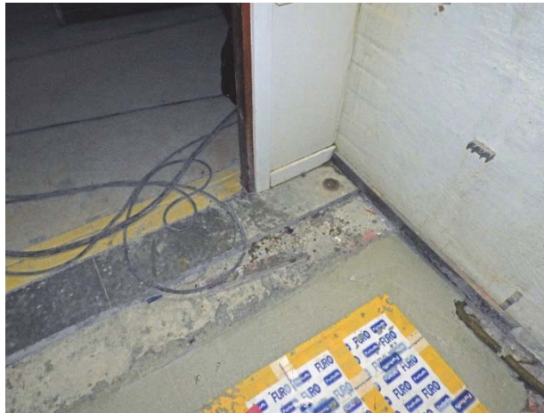
Figur 124. Kalkstensgolv borttaget nästan fram till dörrkarm.
