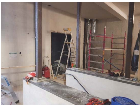
Figur 182. Den murade trappan har använts som stöd för nya stålpelare.
