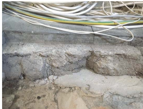
Figur 83. Anslutning valv i vestibul, mot hisschaktets västra vägg. Befintligt dragstag.
