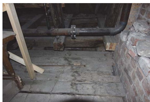
Figur 63. Löst liggande golvvirke på plan 4, norra sidan mot väster, före åtgärder.
