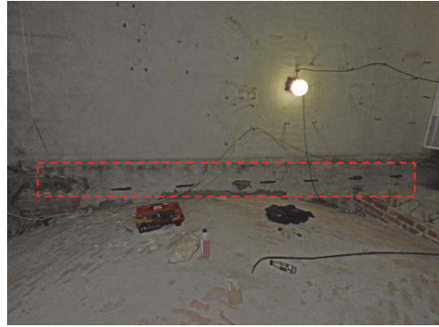
Figur 172. Stålplattor som slitsats in i fogar för att hålla bjälklaget.
