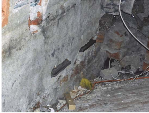
Figur 172. Stålplattor som slitsats in i fogar för att hålla bjälklaget.
