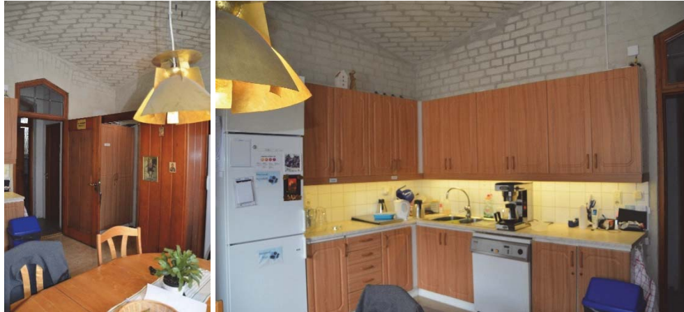
Figur 24. Valv och omklädningshytt i personalrummets sydöstra del. Hytten är troligen från sent 1970-tal.
