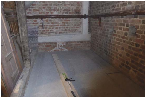
Figur 67. Nordvästra hörnet efter borttaget trägolv. Befintligt betongbjälklag och ventilationskanal. Observera spåren efter en igensatt, välvd öppning i det västra murverket. Medeltida murverk till höger (norr) och till större delen något nyare murverk rakt fram (väster). Figur 68. Takstolar sett mot öster.
