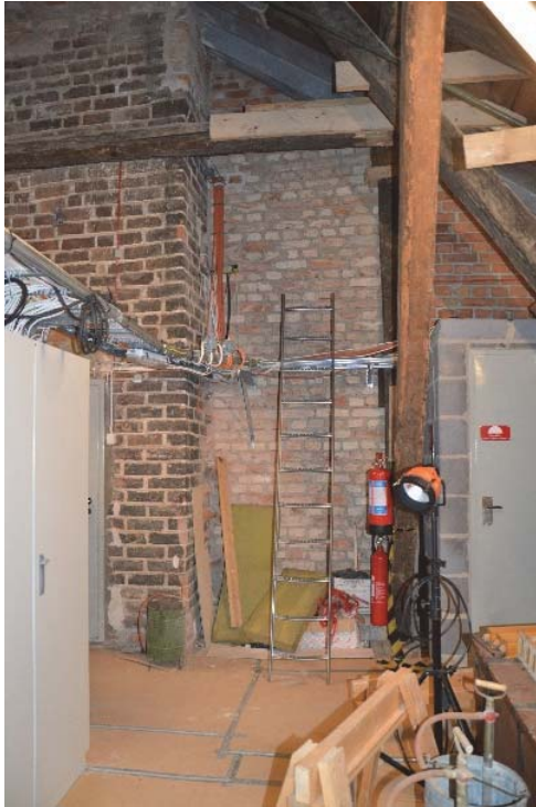
Figur 65. Mörkare tegel till vänster i bild utgör medeltida partier. Läge för hisschaket från väster. Figur 66. Läge för hisschaket från söder.
