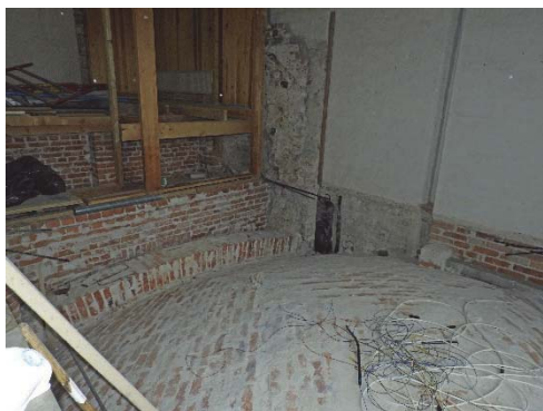
Figur 168. Valv över den nya sakristian, sett mot nordöst och nytt hisschakt.
