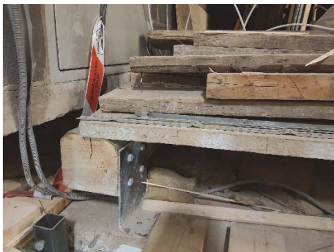
Figur 270. Kapad östlig bjälke. Figur 271. Kapad västlig bjälke.
