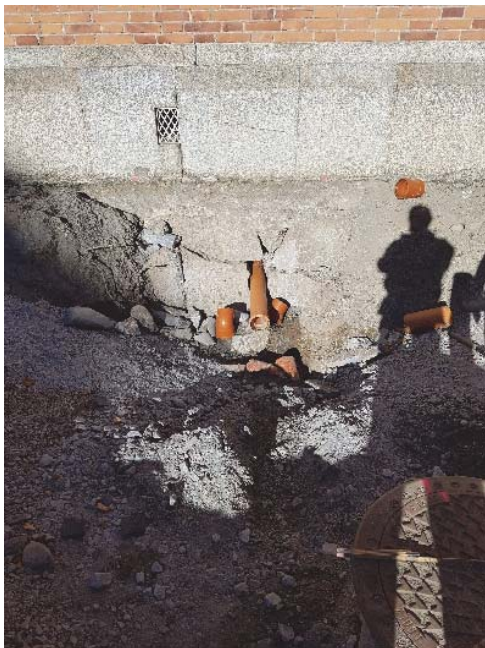
Figur 112. Ny håltagning under marknivån genom grunden för avlopp. Foto: Jonas Ros.
