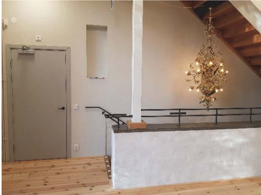
Figur 202. Personalrummet sett mot trapplopp och dörr in mot rum 213. Ny stälpelare, placerad på trappans sidomur och inklädd med gips. Flyttad ljuskrona.
