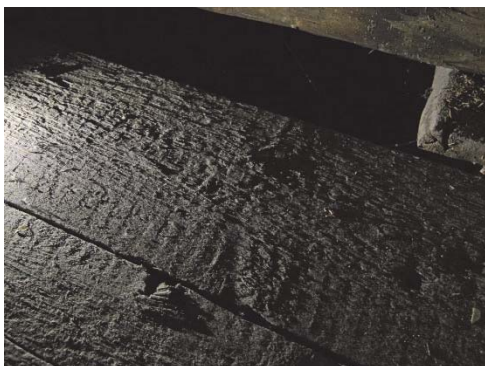
Figur 69. Enstaka äldre bräder i golvet med spår efter kransågning. Figur 70. Löst liggande golv sett mot söder. Läge för behuggen bräda.
