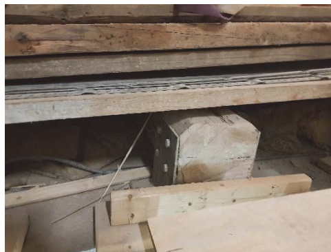
Figur 268. De två bjälkar som kapats för hissen. Figur 269. Isolerat utrymme mellan bjälklaget för fläktrummet och betongbjälklag mot tidigare museet.
