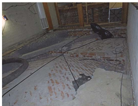
Figur 166. Valven var täckta med krossad blåbetong. Det förekom även eternitkanaler.
