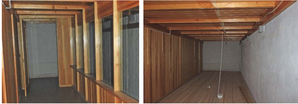
Figur 219. Utrymmet sett mot väster före åtgärder.
