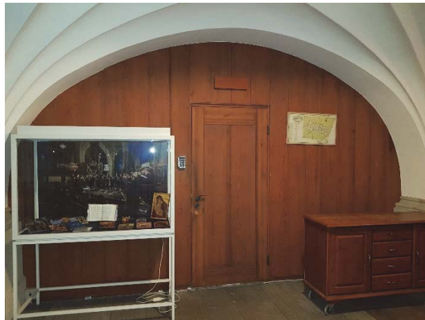
Figur 147. Ventilationsdon över dörr infärgat i väggkulör.
