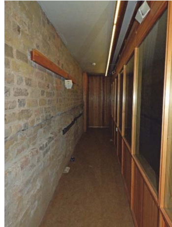
Figur 43. Inmurad, brandskadad bjälke i medeltida murverk, övre entresolplan.
