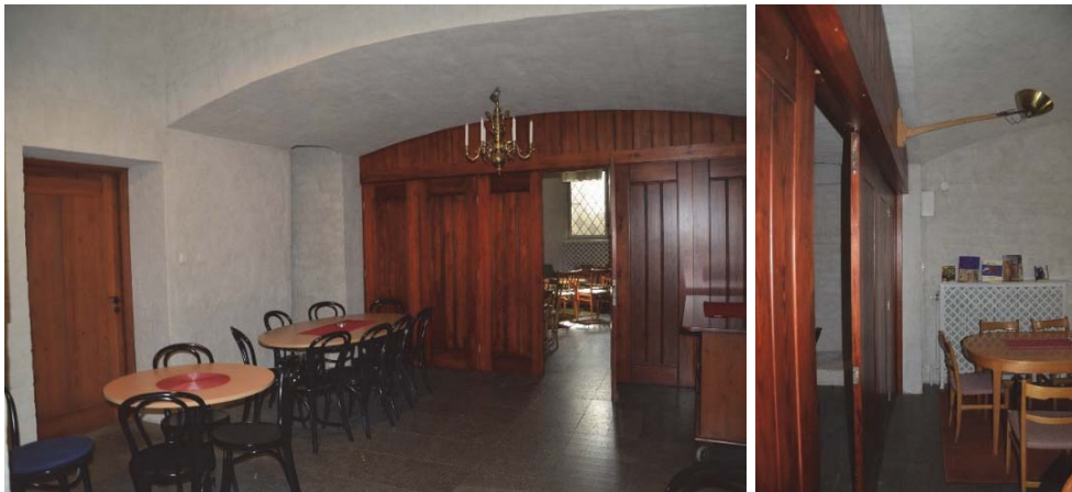
Figur 11. Hissen kommer att placeras där vickväggen möter östra väggen.
