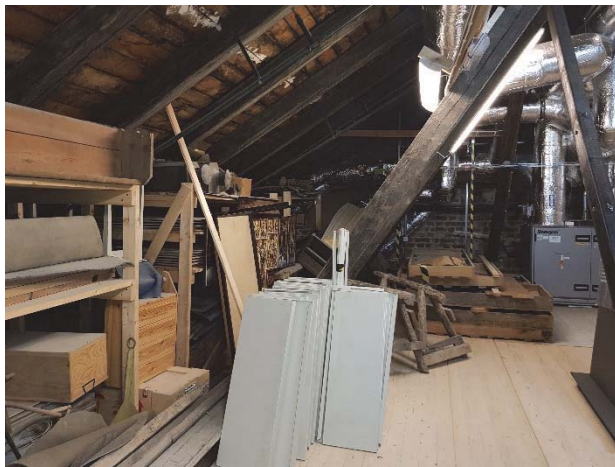
Figur 282. Utrymmet sett mot väster efter åtgärder.
