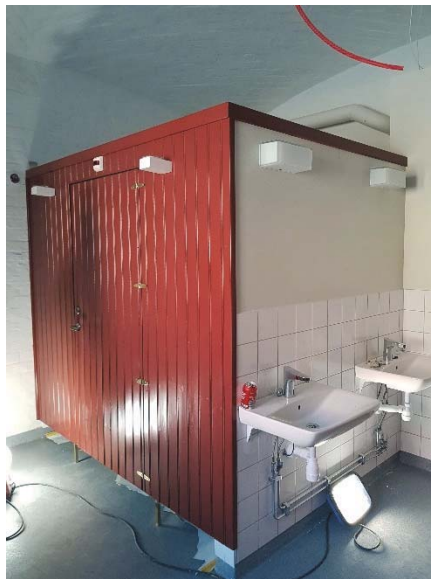
Figur 118. Handfat. Gångjärnen i mässing som syns på bilden var för veka och byttes därför senare till stabilare standardgångjärn som målades in i kulör med dörren.
