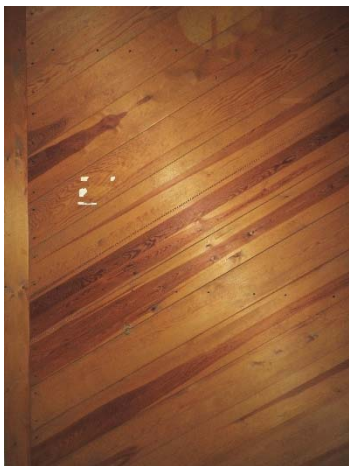
Figur 34. Panelen i trapploppet är snedställd i trappans lutning.
