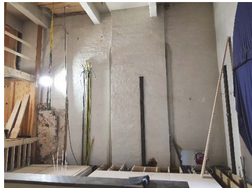
Figur 175. Nya stälbalkar som skall bära det nya entresolplanets bjälklag.
