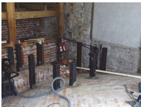
Figur 170. Förberedande arbeten inför håltagning av valvet.
