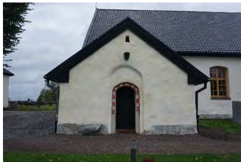
Figur 97. Återskapad dekor kring södra entrén.
