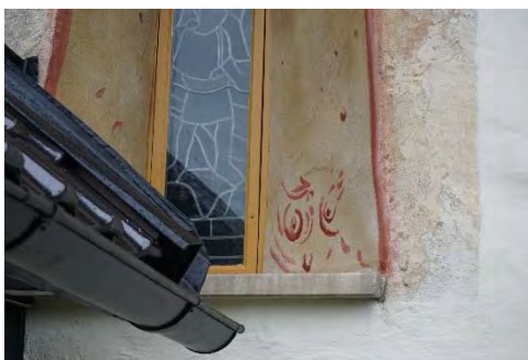
Figur 102. Romanskt fönster efter åtgärder.
