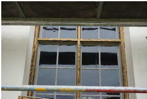
Figur 42. Skrapning av karmar.
