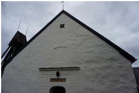
Figur 68. Västra gaveln efter åtgärder.
