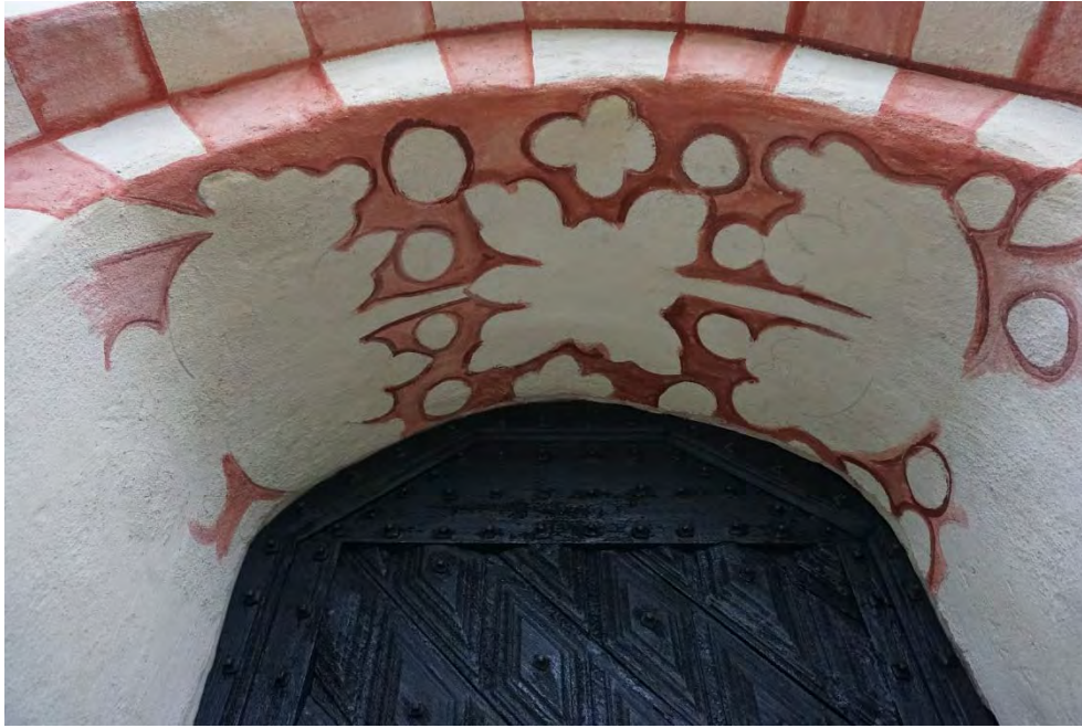
Figur 99. Återskapad dekor i södra entrén.
