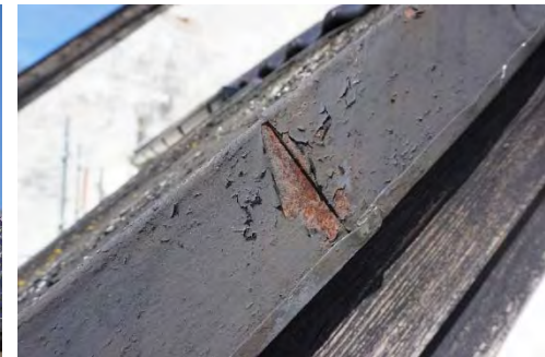
Figur 23. Plättäckning korets sydöstra kontrefort före åtgärder.
