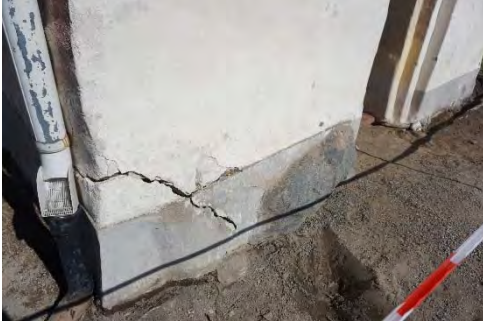
Figur 52. Sättningskada i södra vapenbusets sydvästra hörn.
