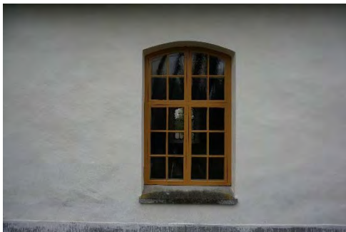
Figur 44. Färdigställt fönster på långbuset.
