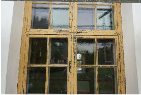
Figur 40. Påbörjad skrapning av fönster.
