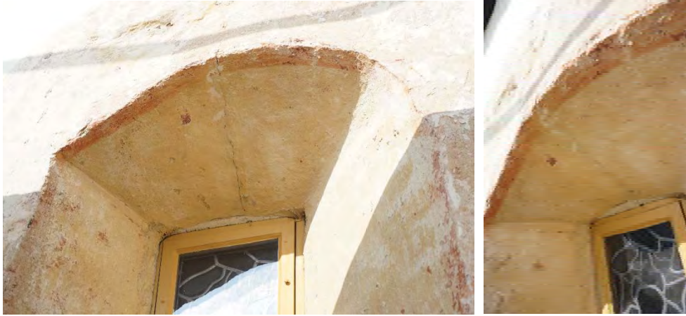
Figur 90. Romanskt fönster på sydsidan före åtgärder.
