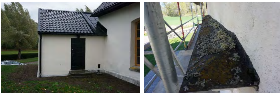
Figur 16. Polyestergrundad plåt som färdigstrukturs på plats.
