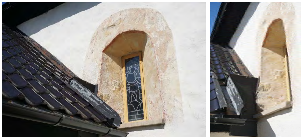
Figur 88. Romanskt fönster på sydsidan före åtgärder.
