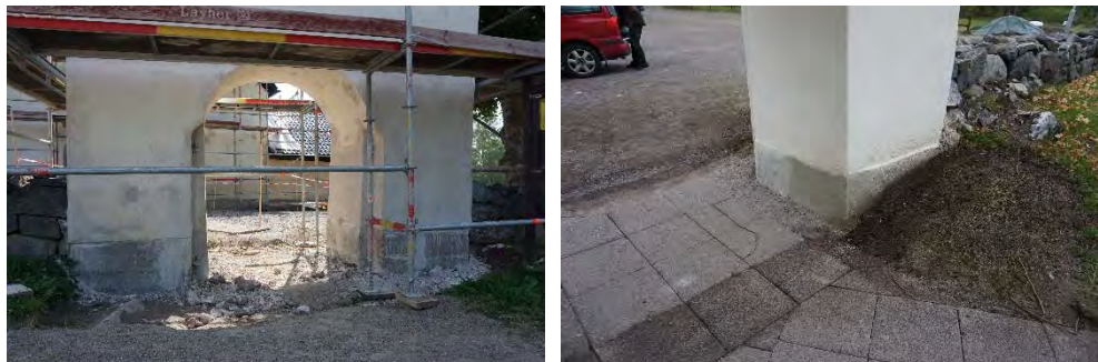
Figur 78. Påbörjad putslagning av stiglucka.
