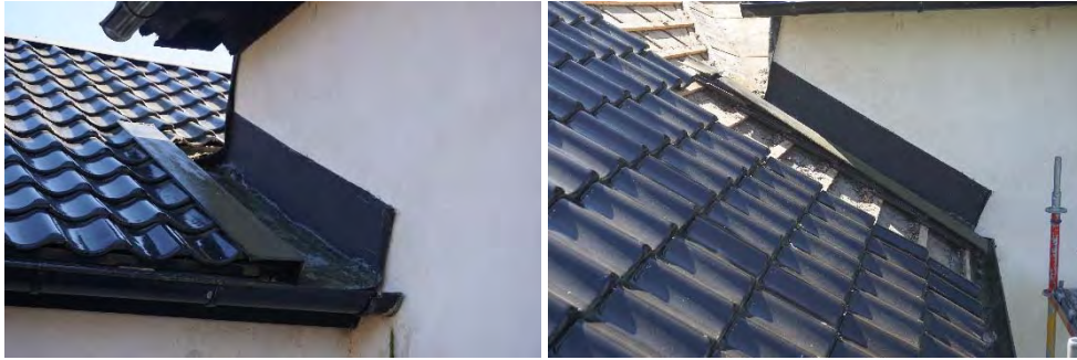
Figur 12. Befintlig ränna, sakristians västra del, före nedplockning av tegel.
