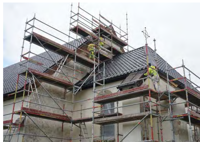
Figur 64. Underliggande, rosatonad putskulör anas vid nedknackning av bomputs.
