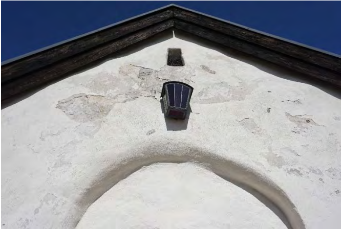
Figur 54. Putsskador södra vapenbusets gavelröste.
