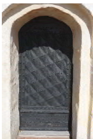
Figur 50. Vapenhuset före konservering.
