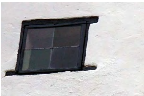
Figur 46. Färdigställt fönster på västgaveln.
