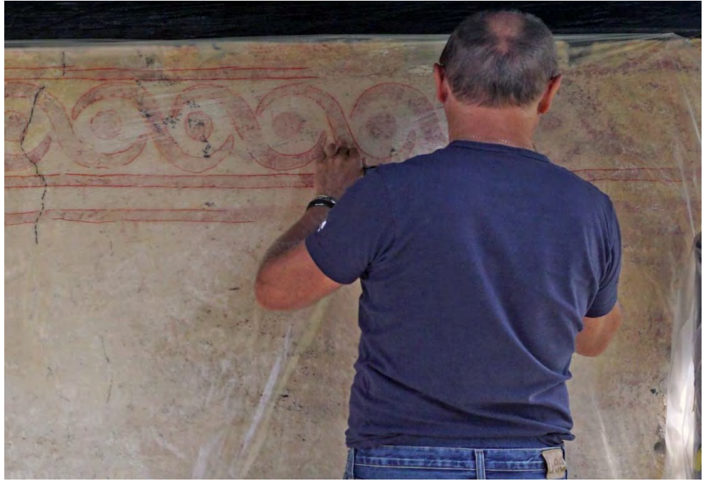
Figur 92. Kalkering av målningar på vapenhusets västra fasad.
