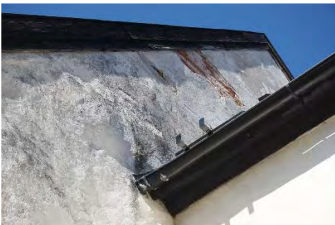
Figur 56. Putsskador på långhusets östra gavel.
