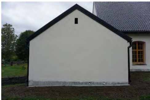
Figur 70. Sakristian sedd från norr efter åtgärder.
