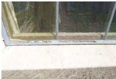
Figur 38. Korffönstret före åtgärder.
