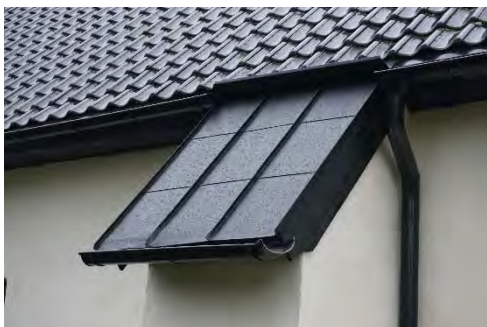
Figur 30. Ny plättäckning på kontrefort.
