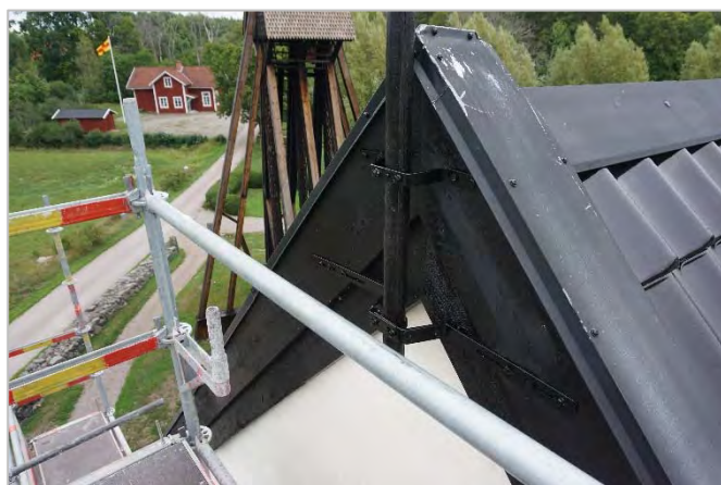
Figur 34. Ny infästning av flöjel på västra gaveln.
