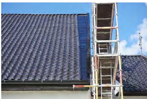
Figur 32. Plättäckning långhusets södra takfall vid östra gaveln.
