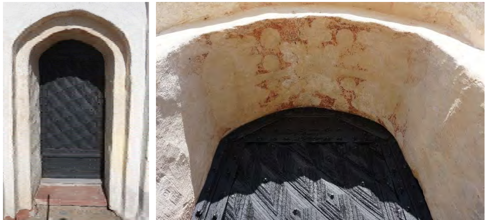
Figur 86. Södra vapenbusporten före åtgärder.
