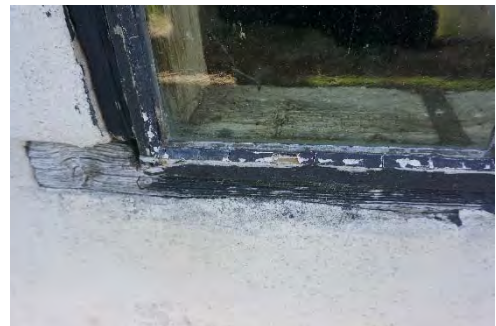
Figur 37. Fönster på västra gavelröset med inmurad karm, före åtgärder.
