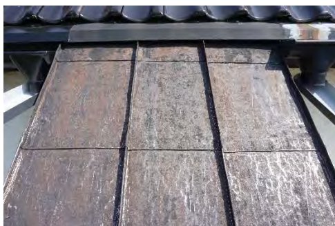
Figur 26. Renskräpad plättäckning på kontrefort.
