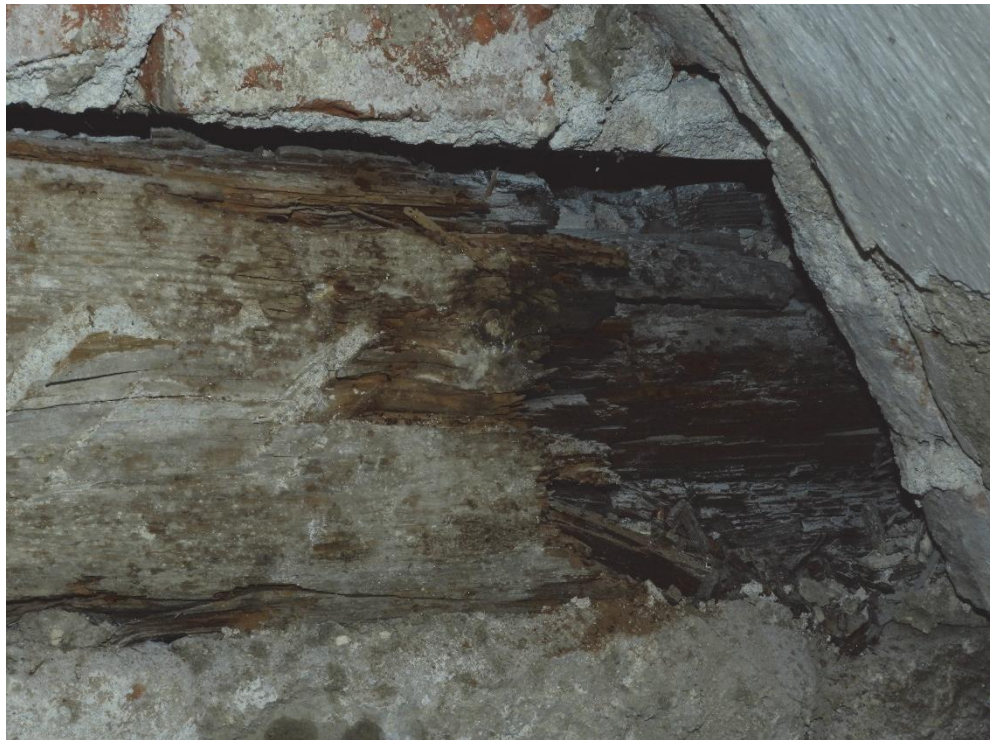
Figur 48. Långhuset, västra travén, södra väggen. Det inmurade virket har rötskador där det går in bakom valvanfanget.
