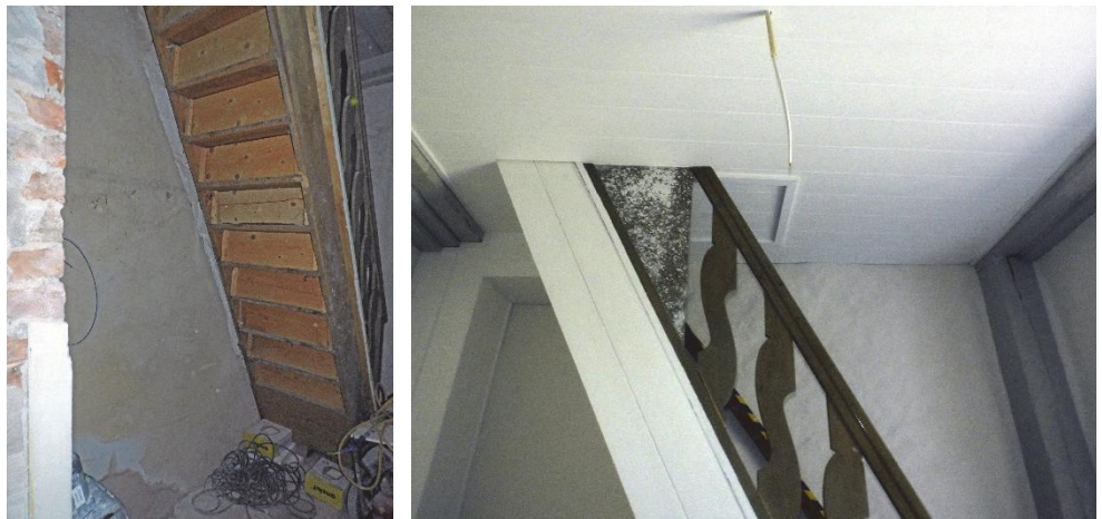
Figur 109. Torntrappans undersida sedd inifrån underbyggnaden. Trappan tycks inte vara byggd för att vara synlig. Figur 110. Underbyggnaden till trappan i vapenbuset är borttagen. Taket har ny panel. Väggar är putslagade och avfärgade med gotlandskalk.
