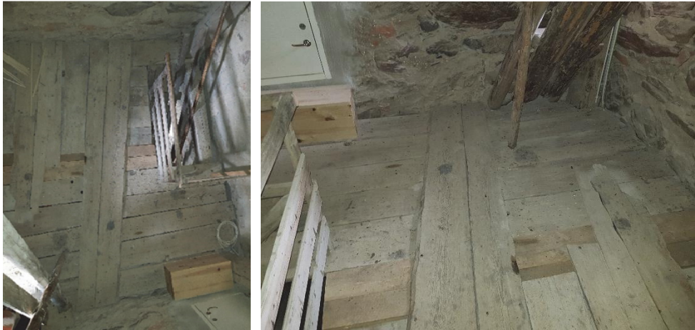
Figur 154. Golv plan 3 åtgärdat.
