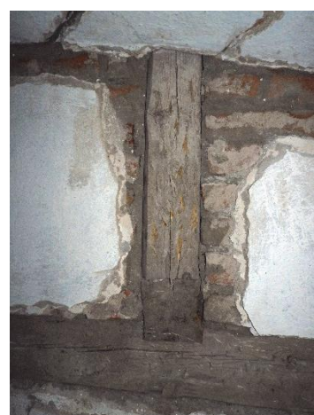
Figur 40. Norra korsarmen, östra väggen. I knutpunkten mellan horisontell och vertikal bjälke syns ändträet av den bjälke som tycks vara inmurad in i murverket.
