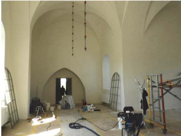
Figur 33. Valv och väggar färdigstruktura i väster.
