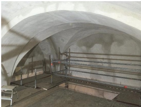
Figur 23. Putsläggningar i västra långhustravén, sett mot sydväst.
