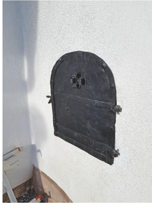
Figur 163. Lucka till gravkor. Södra fasaden vid södra vapenhuset.
