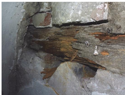
Figur 43. Norra korsarmen västra väggen. I denna båge finns endast vertikala stolpar. Man har dock samma lösning där man ser ändträet från en bjälke som murats in i muren.
