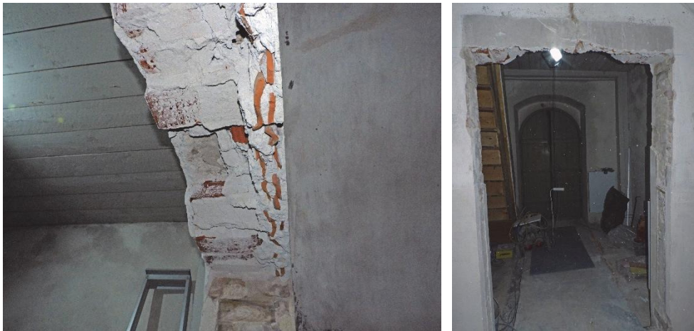
Figur 97. Befintlig dörröppning tillkom på 1950-talet och består av olika typer av tegel.
