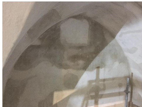
Figur 26. Västra långhustravén, södra väggen. Lagningar av puts vid inmurat virke.
