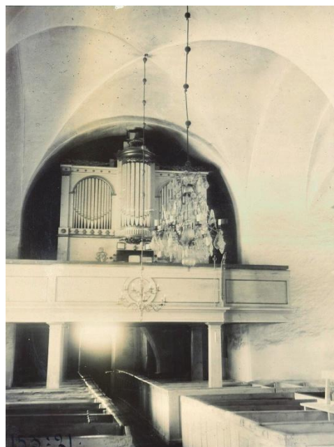
Figur 4. Kyrkorummet mot väster före renoveringen 1906–1907 med en läktare i kyrkans västra del och till synes öppet i valvet mellan vapenhus och långhus.
