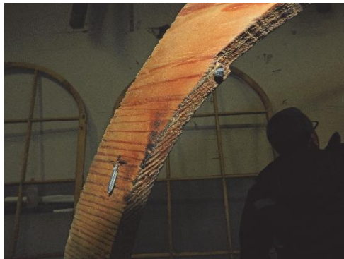
Figur 57. Innerbåge till södra korfönstret, övre delen var sedan tidigare sprucken och lagad med en spik.
