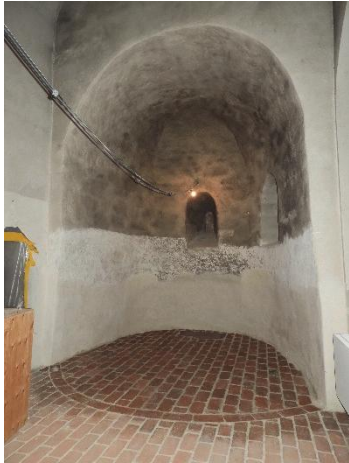
Figur 78. Koret med nyinlagt tegelgolv.
