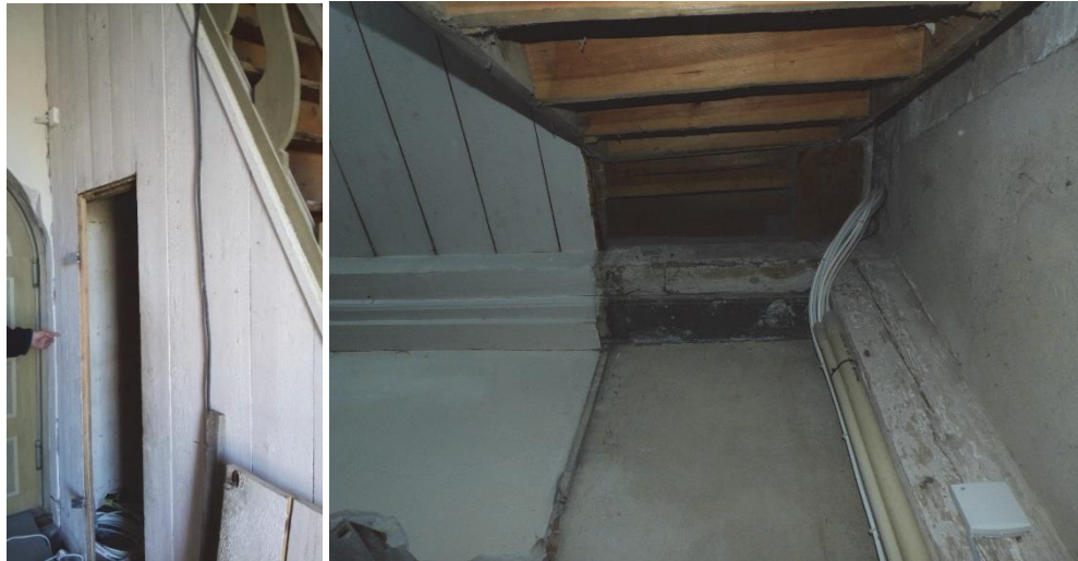
Figur 107. Vapenbuset med befintlig trappunderbyggnad. Figur 108. Trappunderbyggnaden är borttagen.
