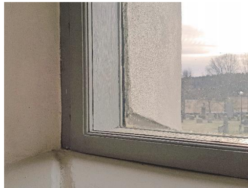
Figur 59. Befintliga hål för infästning av innerbågen mot karmen.
