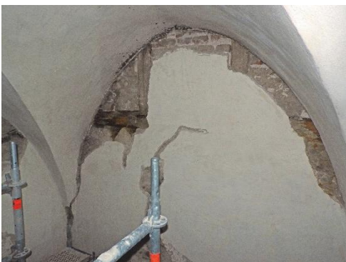
Figur 44. Långhuset, västra travén norra väggen.
