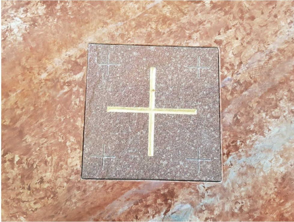
Figur 145. Infälld lokal röd mälarsandsten i altarskivans centrum med förgyllt kors.
