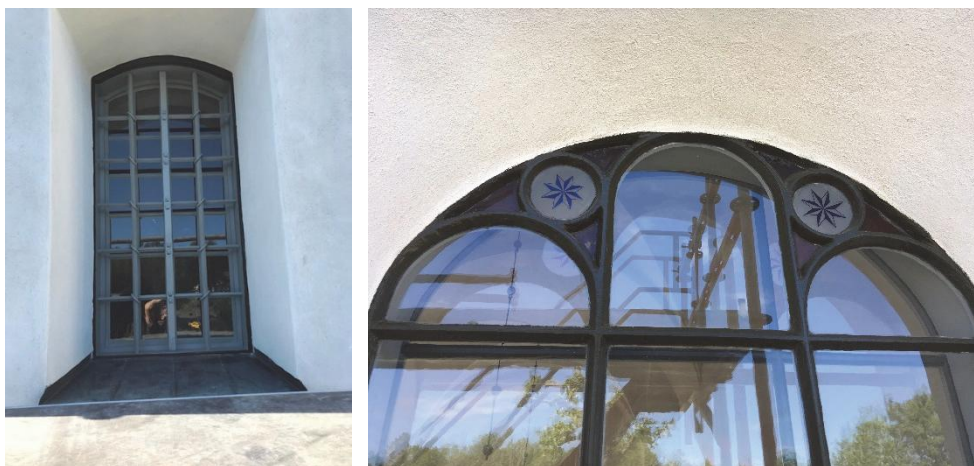
Figur 72. Galler och innerkarm åtgärdad på sakristians fönster.
