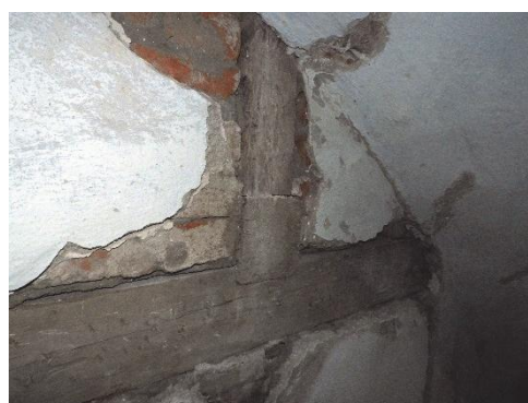
Figur 36. I Sala sockenkyrka ans de inmurade bjälkarna då det medeltida måleriet där ersatts med monokrom puts, sannolikt på grund av att rörelserna mellan murverk och trä lett till skador i putsen.
