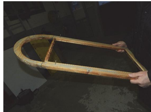
Figur 57. Innerbåge till södra korfönstret, övre delen var sedan tidigare sprucken och lagad med en spik.
