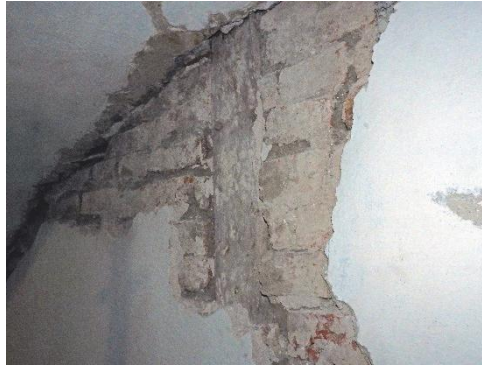
Figur 41. Norra korsarmen västra väggen. Endast vertikala stolpar.
