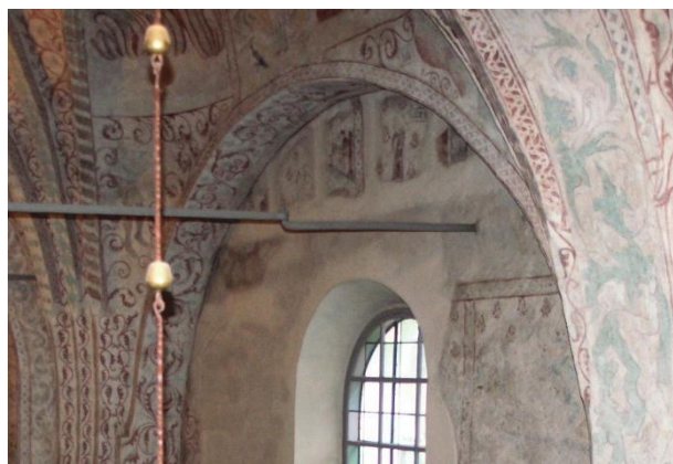
Figur 35. En liknande konstruktion med inmurade bjälkar är dokumenterad i Sala sockenkyrka, Västmanland. Dokumentation i Sveriges kyrkors arkiv, ATA.
