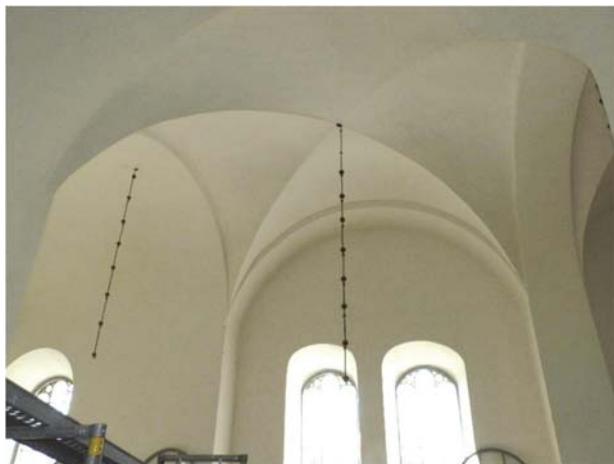
Figur 31. Valv och väggar färdigstrukt, norra korsarmen.
