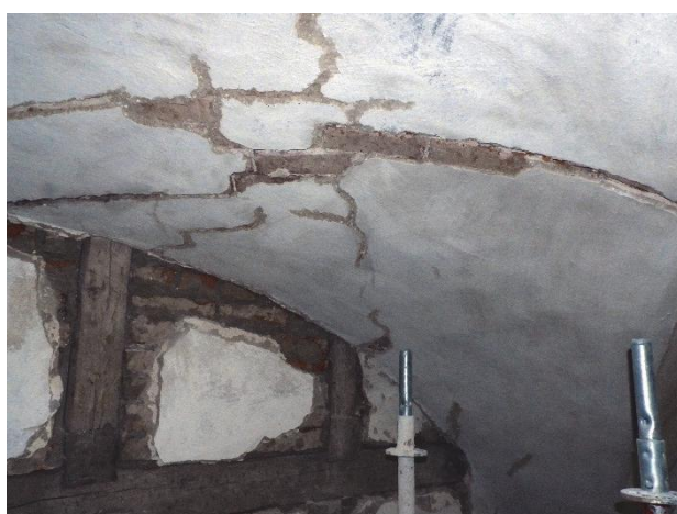
Figur 39. Norra korsarmen, östra väggen.
