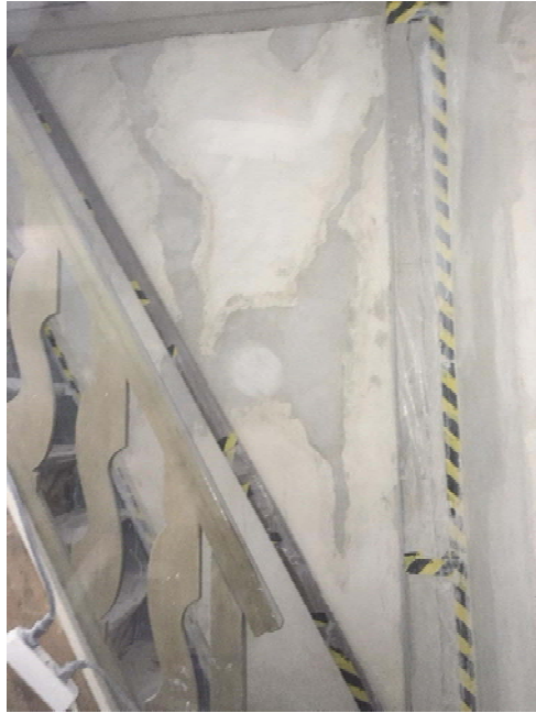
Figur 27. Lagningar vapenbusets södra vägg.
