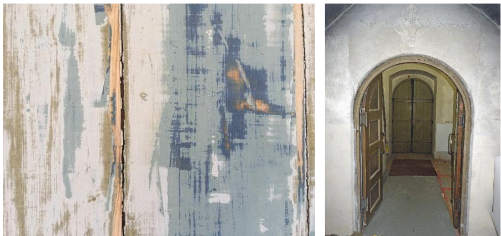
Figur 111. Tidigare kulörer på västportens insida. Figur 112. Blick från långbus mot vapenbus före åtgärder.
