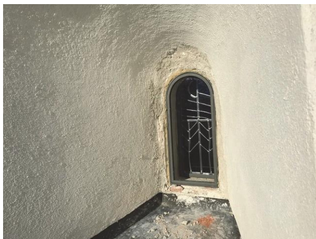
Figur 92. Nytt fönster sett utifrån innan putslagning.
