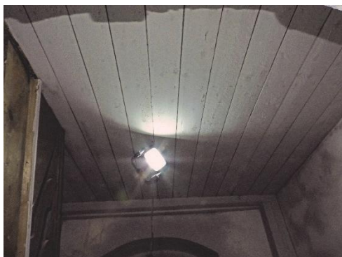
Figur 105. Takets befintliga panelbräder med spår efter cirkelsågning.
