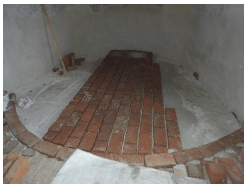
Figur 76. De äldre stenarna har rengjorts och en fris har lagts mot befintligt tegelgolv från 1950-talet. Under tegelgolvet ligger ett lager kalkbetong.
