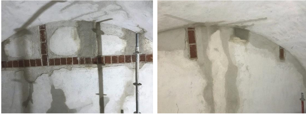
Figur 51. Norra korsarmen östra väggen. Foto: Göran Berglund.
