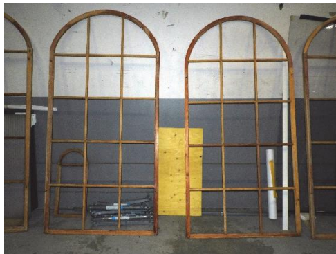
Figur 55. Rengjorda och grundoljade innerbågar.
