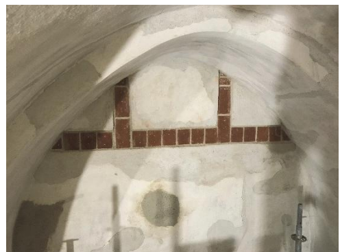
Figur 48. Långhuset, västra travén, södra väggen. Det inmurade virket har rötskador där det går in bakom valvanfanget.
