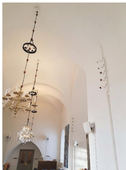
Figur 134. Ljuskronorna har försetts med extra kransar med belysning.
