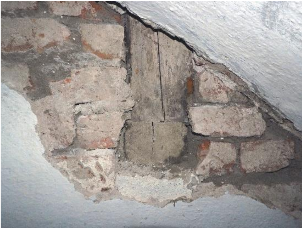
Figur 43. Norra korsarmen västra väggen. I denna båge finns endast vertikala stolpar. Man har dock samma lösning där man ser ändträet från en bjälke som murats in i muren.
