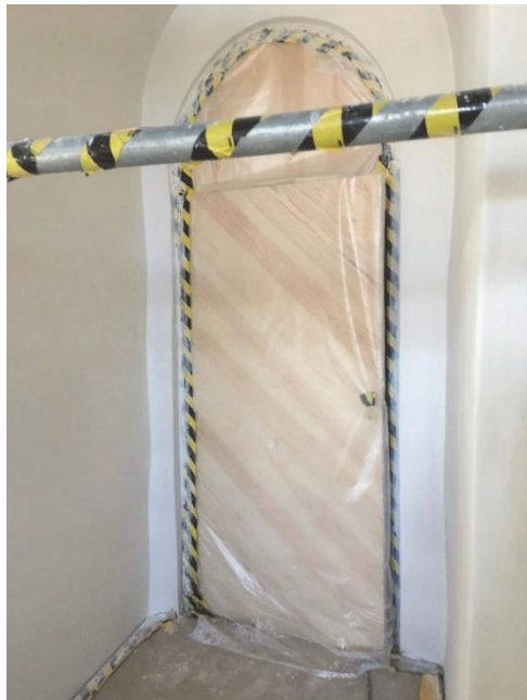
Figur 119. Ny dörr tillverkad i furu med fast övre parti.
