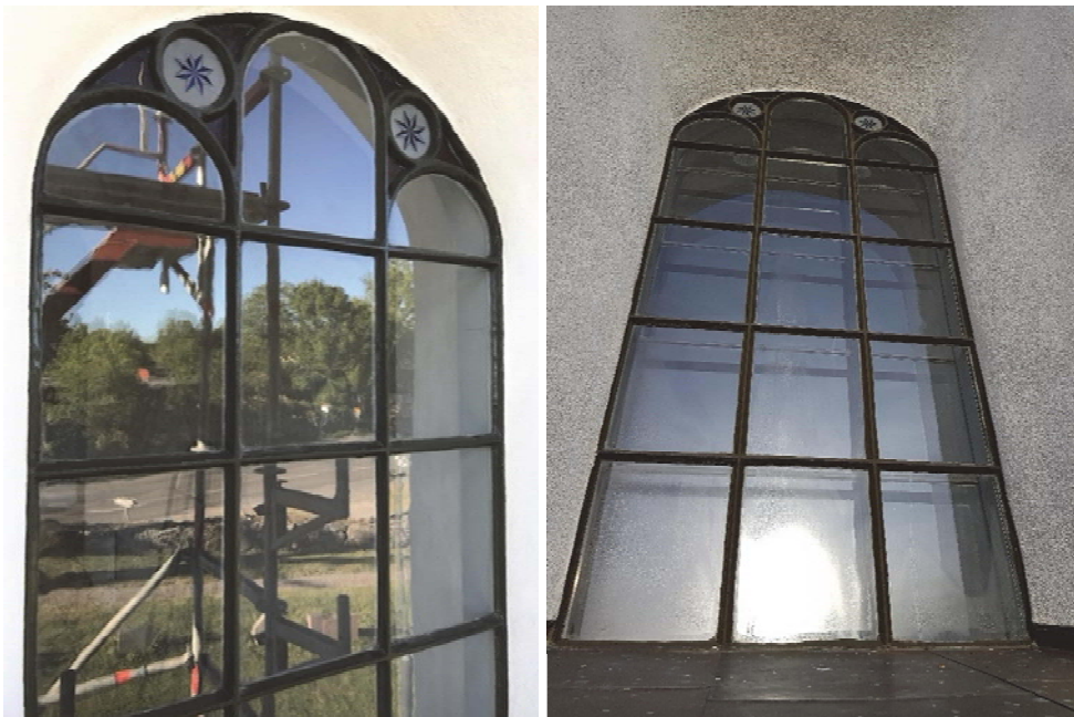
Figur 70. Färdigställt fönster. Foto: Göran Berglund.
