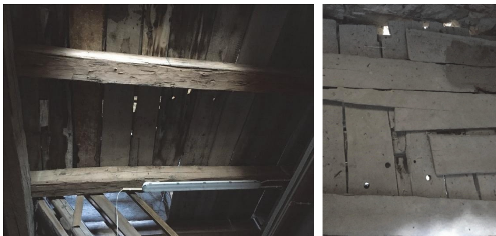
Figur 152. Bjälklaget på plan tre i tornet före åtgärder sett underifrån.
