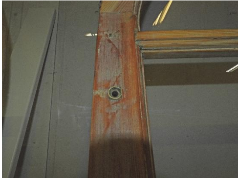
Figur 59. Befintliga hål för infästning av innerbågen mot karmen.
