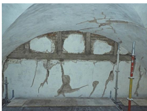
Figur 37. Norra korsarmen, östra väggen.
