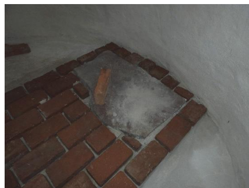
Figur 76. De äldre stenarna har rengjorts och en fris har lagts mot befintligt tegelgolv från 1950-talet. Under tegelgolvet ligger ett lager kalkbetong.
