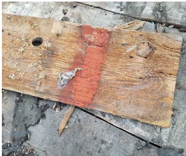
Figur 17. Spår av rödfärg på undertaksbräda. Foto: Stefan Ilhammar.
