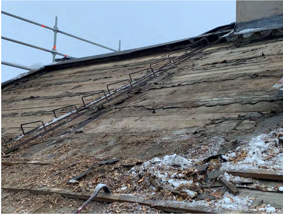
Figur 13. Befintlig takstege i järn.
