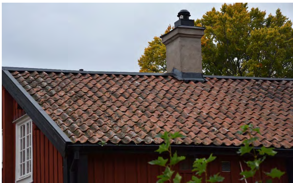
Figur 8. Taket sett från nordöst före åtgärder.
