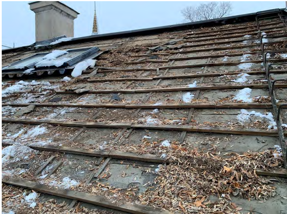
Figur 12. Södra takfallet. Tunn ströläkt under bärläkten.
