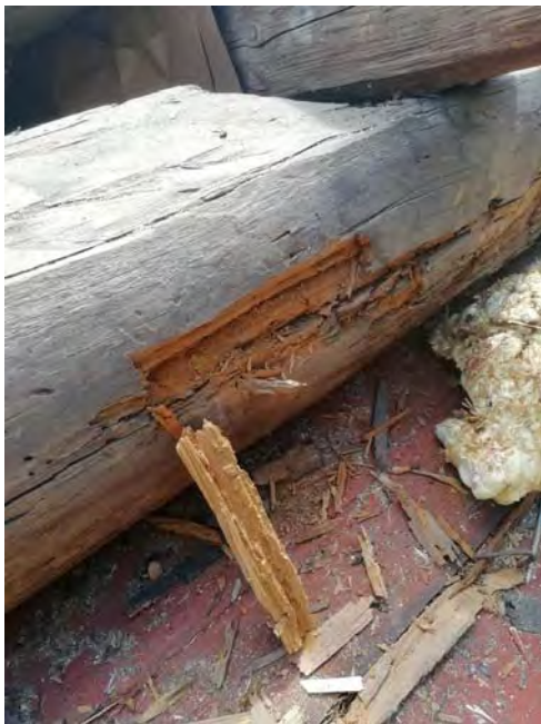
Figur 23. Norra sidan, sidoås med rötskador. Foto: TGA.
