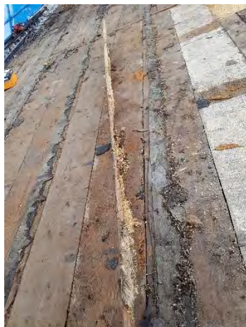
Figur 19. Takbrädan har i angripits från undersidan av insekter. Foto: Stefan Ilhammar.
