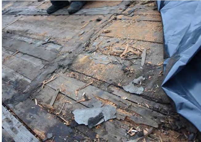
Figur 15. Insektsangripet undertak. Norra sidan.
