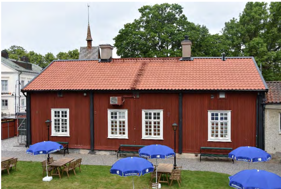
Figur 34. Omlagt tak och ny taksäkerhet.
