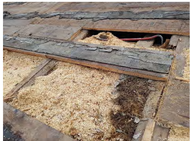
Figur 19. Takbrädan har i angripits från undersidan av insekter. Foto: Stefan Ilhammar.
