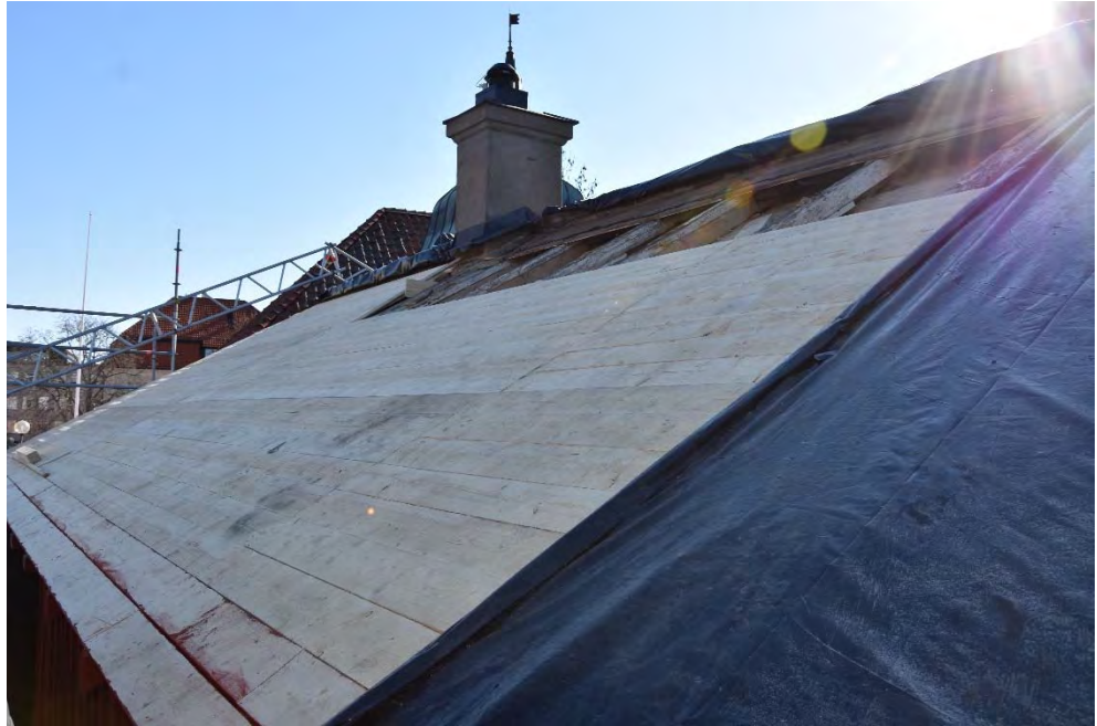
Figur 27. Omtäckning av norra takfallet.
