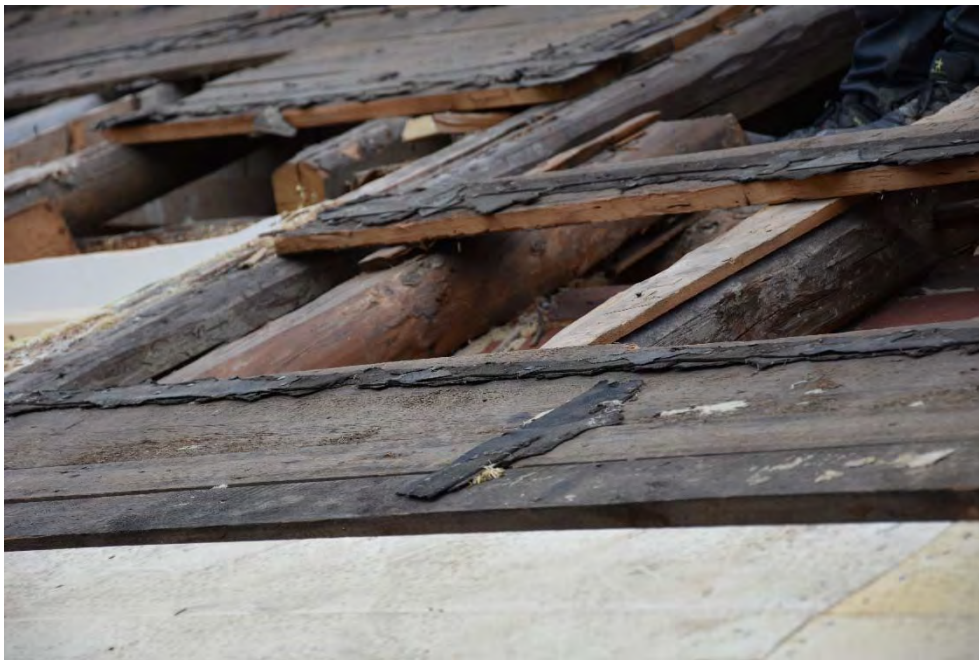
Figur 30. Södra takfallet underliggande takstolskonstruktion.
