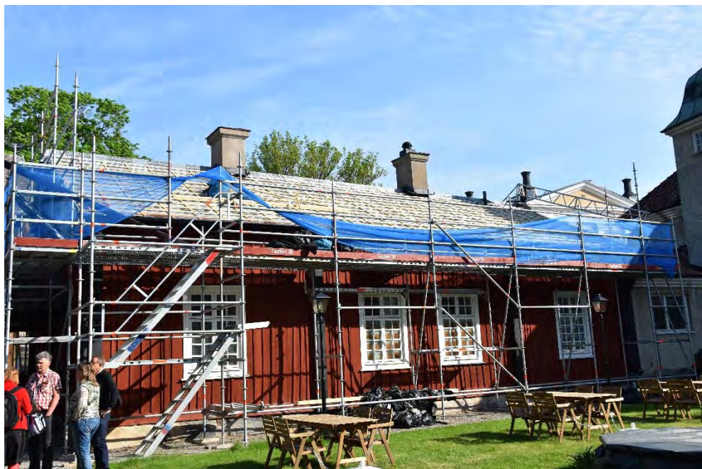
Figur 32. Omläktat tak på södra takfallet.
