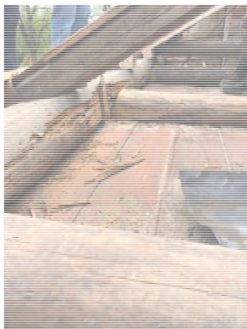
Figur 25. Rötskadad sidoås på södra sidan Foto: TGA.
