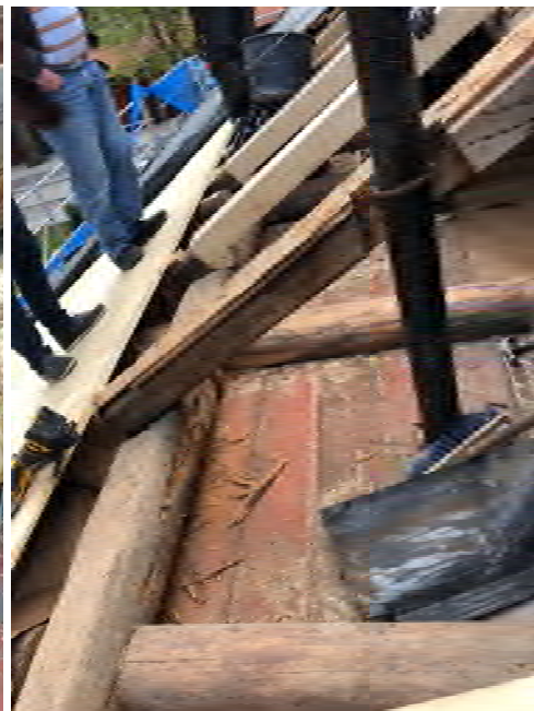
Figur 24. Södra sidan sidoås med rötskador. Skarvade högben. Foto: TGA.
