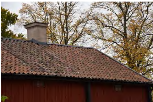
Figur 10. Norra takfallets västra del före åtgärder.
