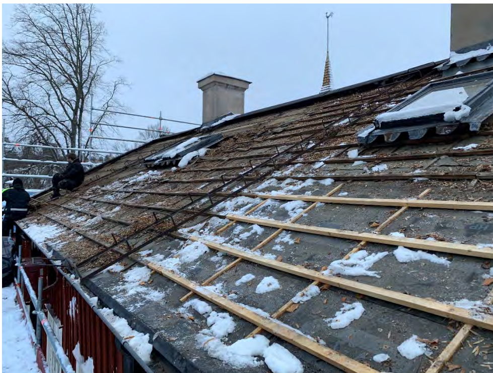
Figur 14. Försök gjordes att behålla undertaket och endast läkta om delar. Så småningom täcktes dock hela taket om.
