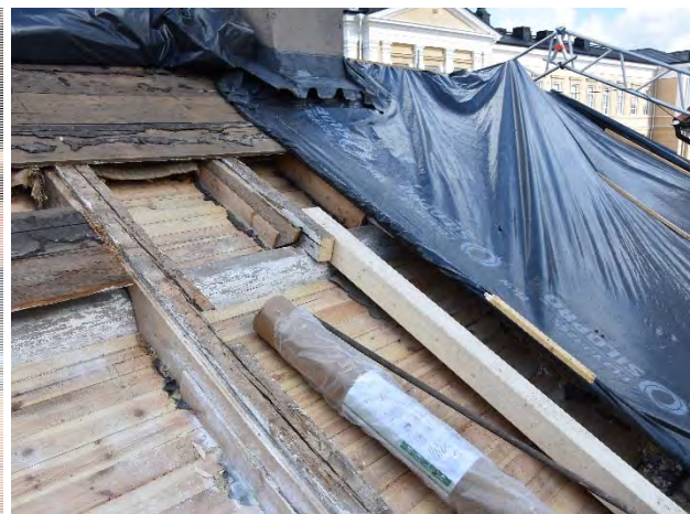
Figur 25. Rötskadad sidoås på södra sidan Foto: TGA.
