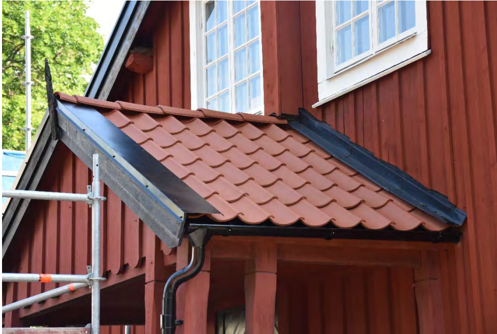
Figur 33. Ny takavvattning och taktäckning på verandan i väster.
