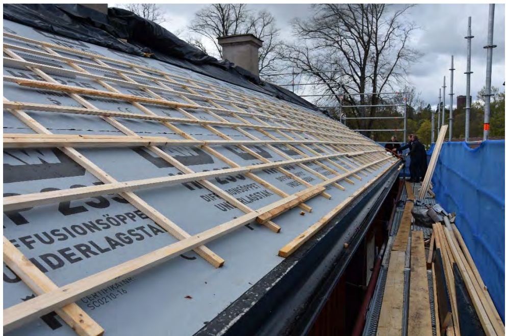
Figur 28. Diffusionsöppen underlagspapp och ny läkt på norra takfallet.
