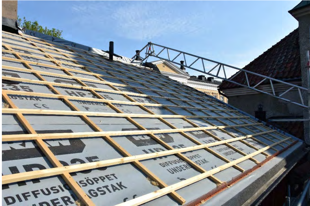
Figur 31. Ny läkt och diffusionsöppen papp.
