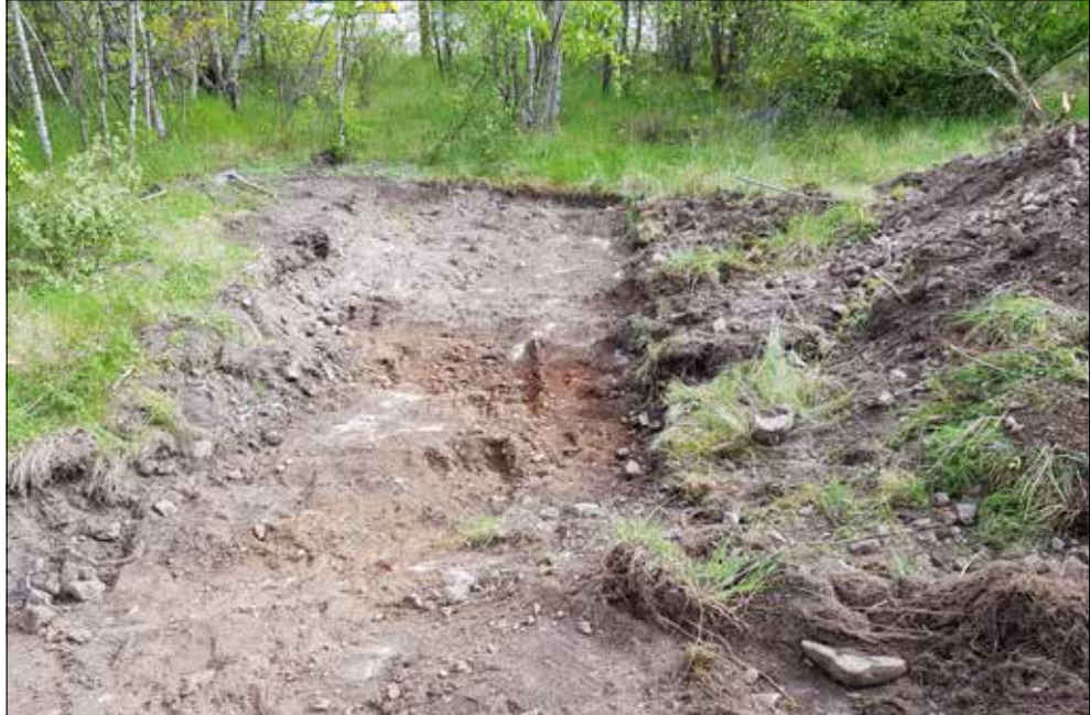
Figur 5. Schakt 1082, östra delen. Foto från sydväst.
