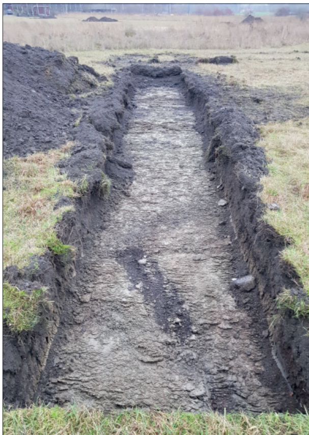
Figur 3. Schakt 1000 från nordnordöst.
